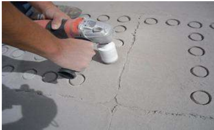
Ilustración 61. Perforación de las losas para la prueba de adherencia. Fuente: (Bernabé Reyes, 2015)
