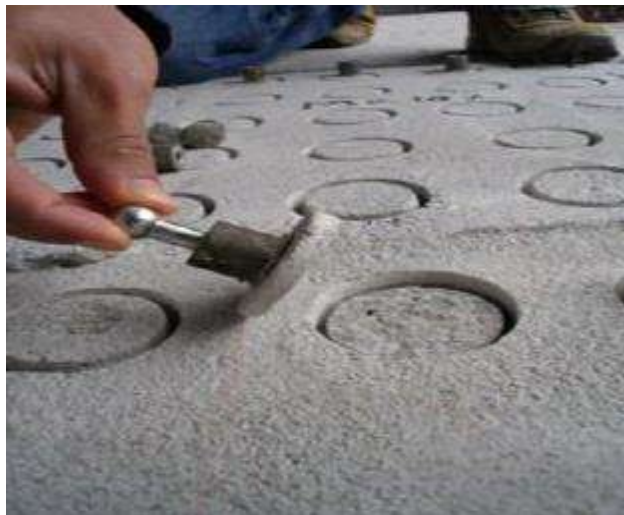
Ilustración 69. Falla entre revestimiento y el estrato. Tipo (3). Material MK. Fuente: (Bernabé Reyes, 2015)
