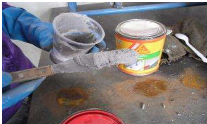
Ilustración 62. Elaboración de la mezcla del epóxico. Fuente: (Bernabé Reyes, 2015)
