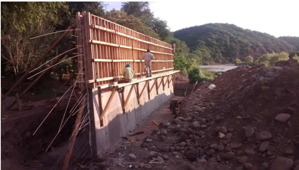
IMAGEN XIX (CIMBRADO DE LA SIGUIENTE PARTE DEL MURO)
