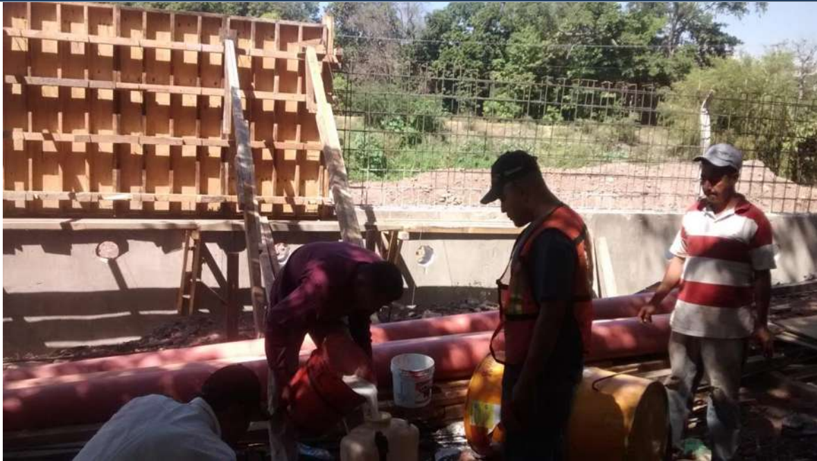
IMAGEN XXIII (VACIADO DEL CURACRETO)
