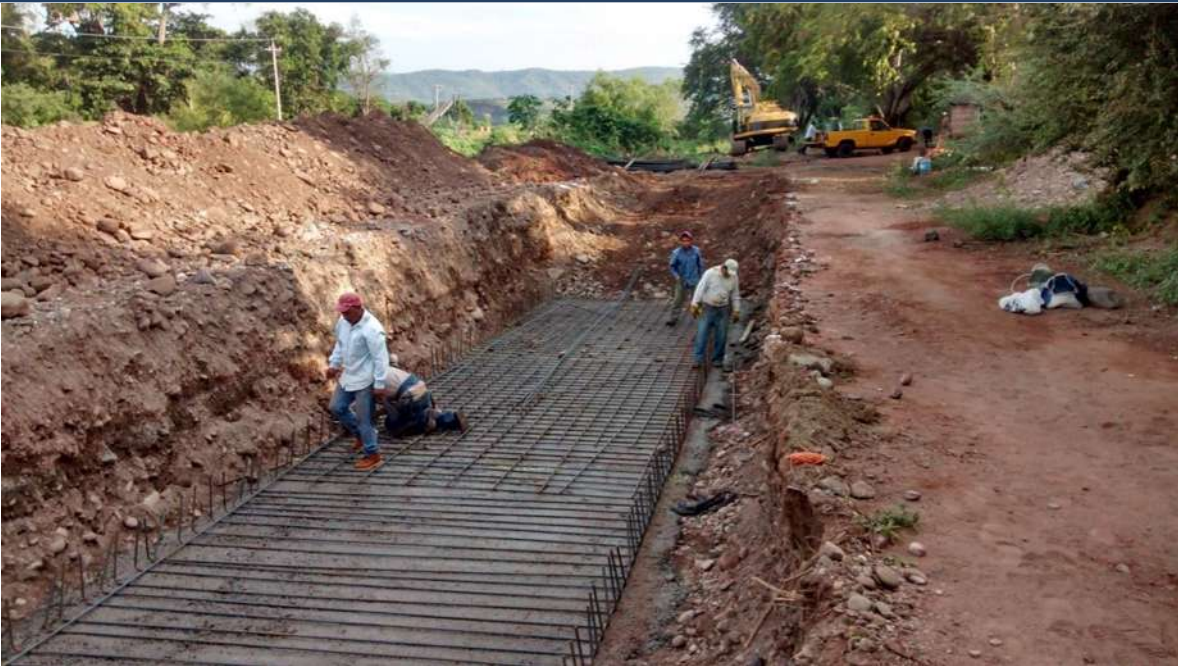
IMAGEN V (ARMADO DE LOSA DE CIMENTACION SOBRE LA CAPA DE CONCRETO POBRE)
