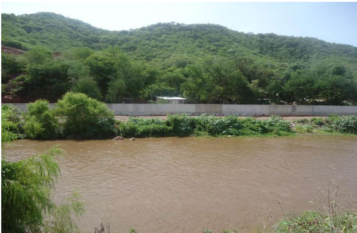
IMAGEN XXVI (MURO DE CONCRETO TERMINADO)
