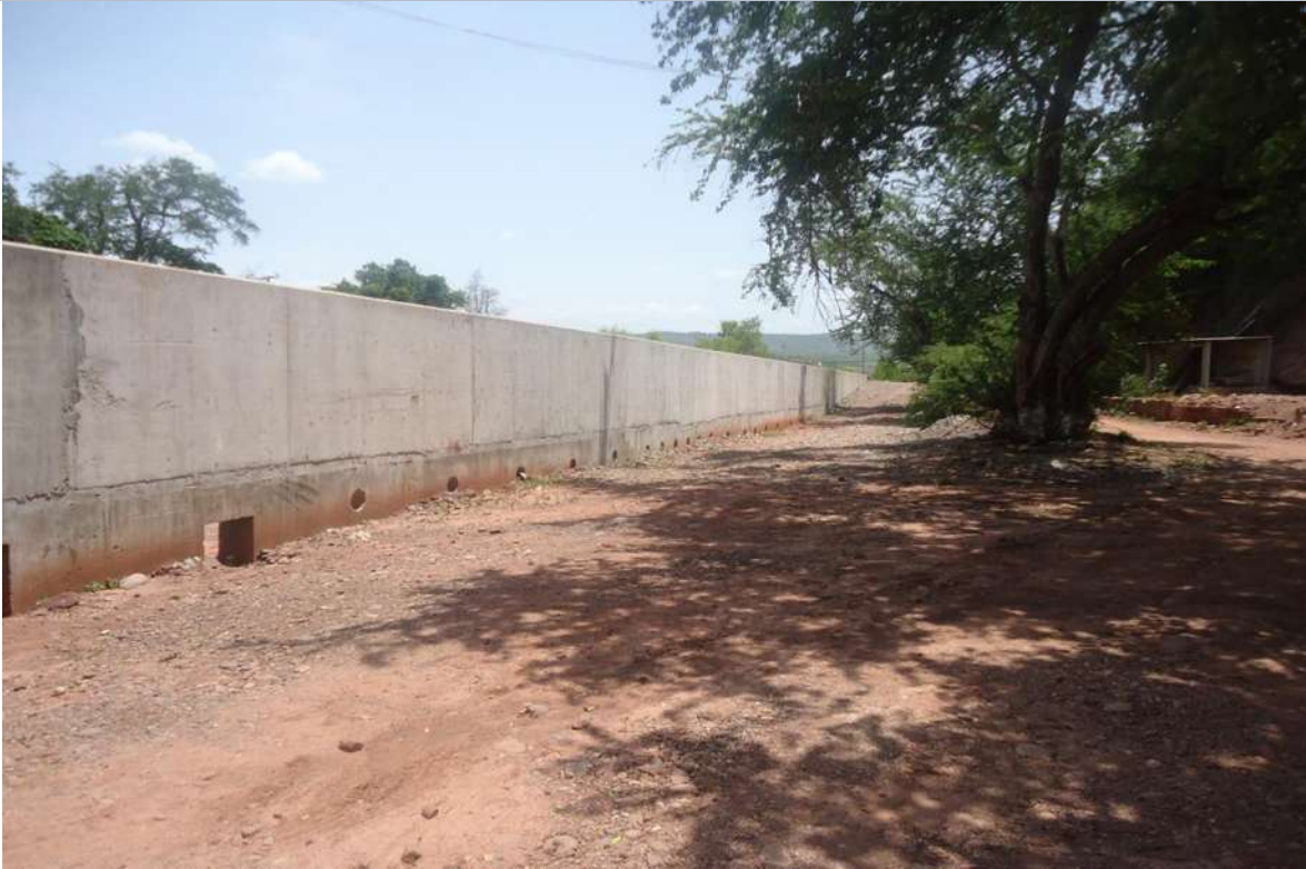
IMAGEN XXVII (MURO DE CONCRETO TERMINADO)
