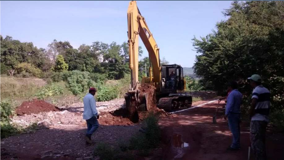
IMAGEN II (TRAZO Y NIVELACION DEL TERRENO)
