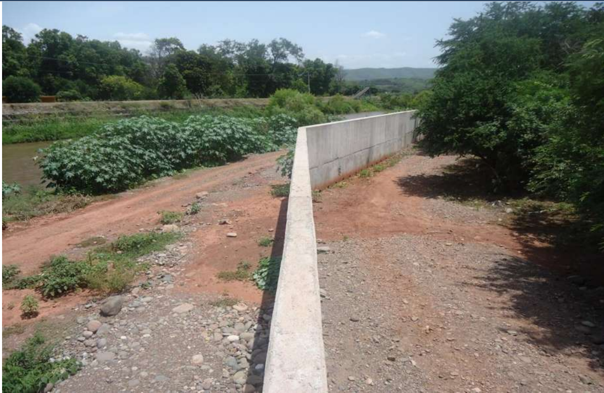
IMAGEN XXIX (MURO DE CONCRETO TERMINADO)
