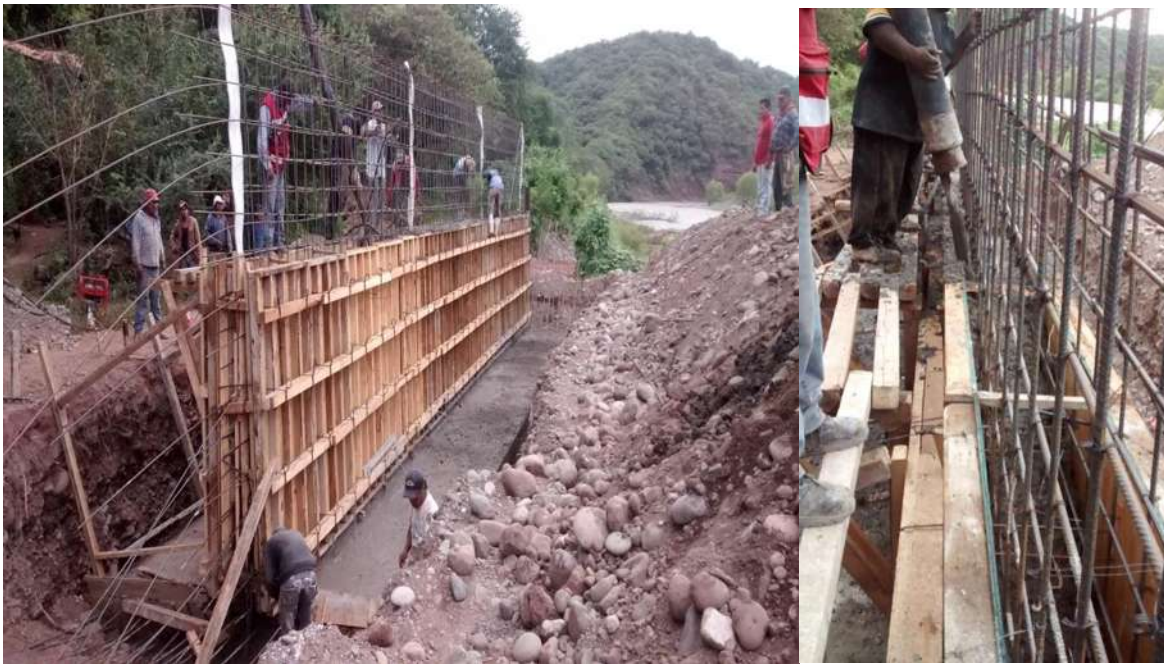
IMAGEN XIII (COLADO DEL MURO)
