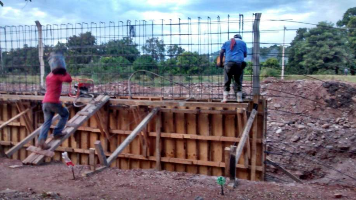
IMAGEN XIV (VIBRADO DEL CONCRETO)
