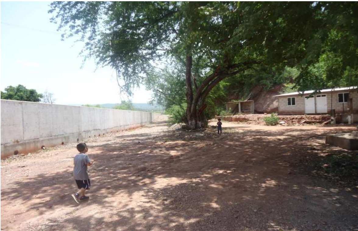
IMAGEN XXXII (MURO DE CONCRETO TERMINADO)
