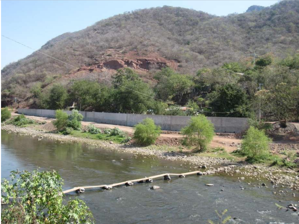
IMAGEN XXXIII (MURO DE CONCRETO TERMINADO)
