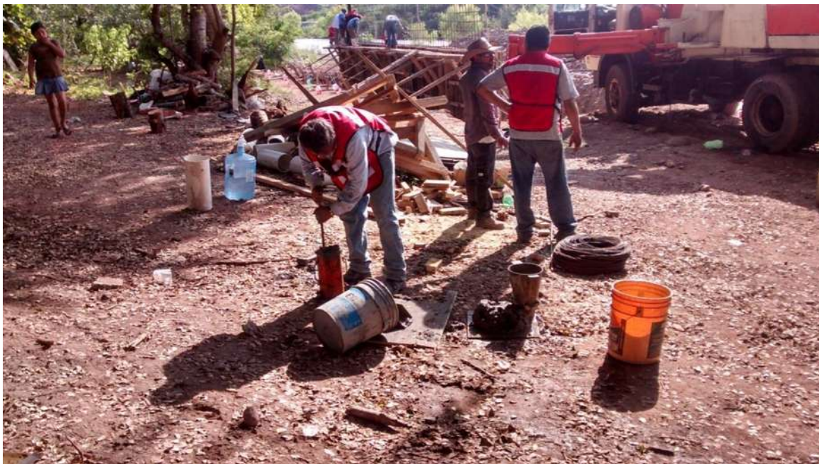
IMAGEN VI – LLENADO DEL MOLDE Y COMPACTACION POR VARILLADO
