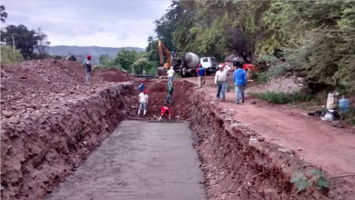
IMAGEN IV (PLANTILA DE CONCRETO POBRE)
