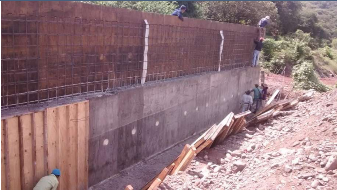
IMAGEN XVIII (DESCIMBRADO DE LA MITAD DEL MURO)
