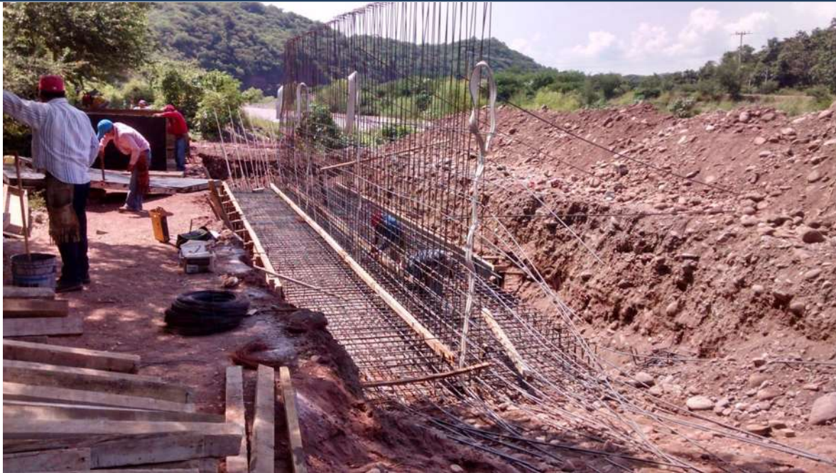
IMAGEN IX (CIMBRADO Y COLADO DE LA ZAPATA DEL MURO)
