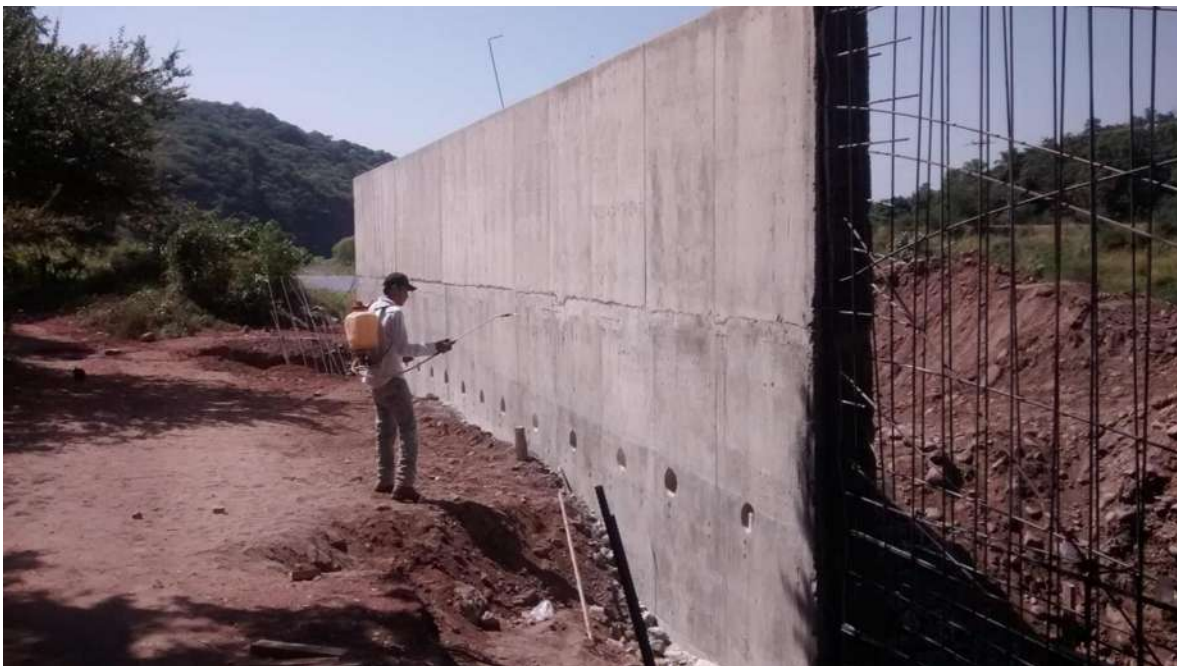
IMAGEN XXIV (IMPREGNACION DEL CURACRETO SOBRE EL MURO DE CONCRETO)
