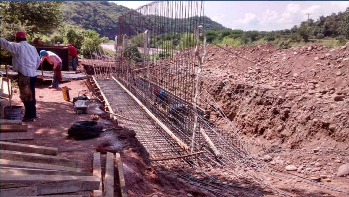
IMAGEN VII (ARMADO FINAL, LISTO PARA CIMBRAR – PRIMERA PARTE DEL MURO)
