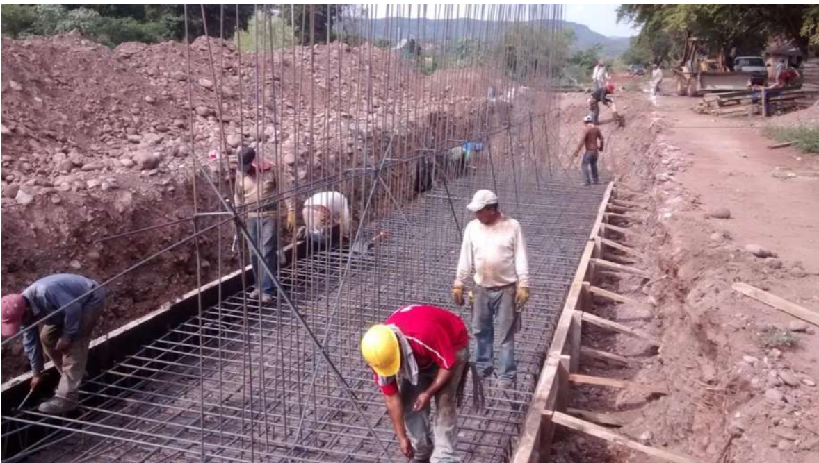
IMAGEN VI (ARMADO DE LA ZAPATA DEL MURO Y PILAR DEL MURO)
