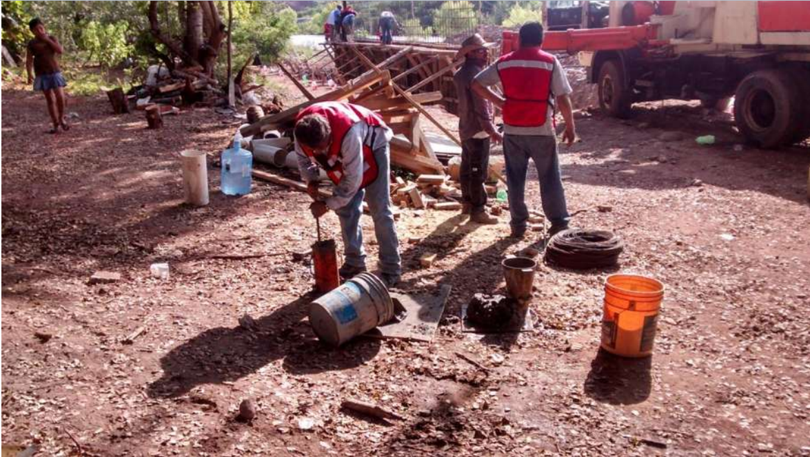
IMAGEN XVII (ELABORACION DE CILINDROS TESTIGOS DE CONCRETO HIDRAULICO)
