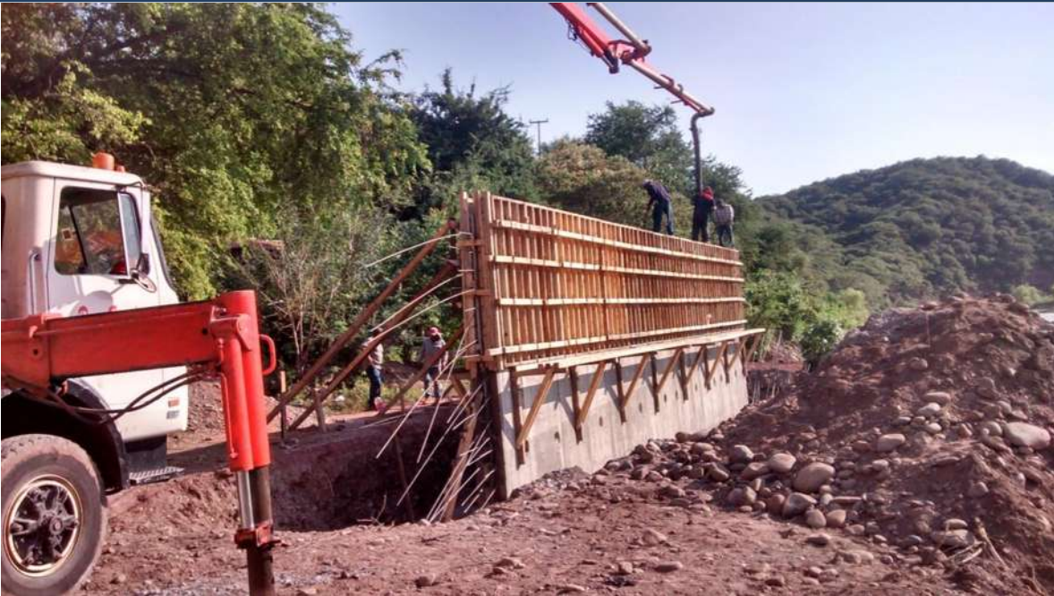
IMAGEN XX (COLADO DE LA OTRA MEDIA PARTE DEL MURO)
