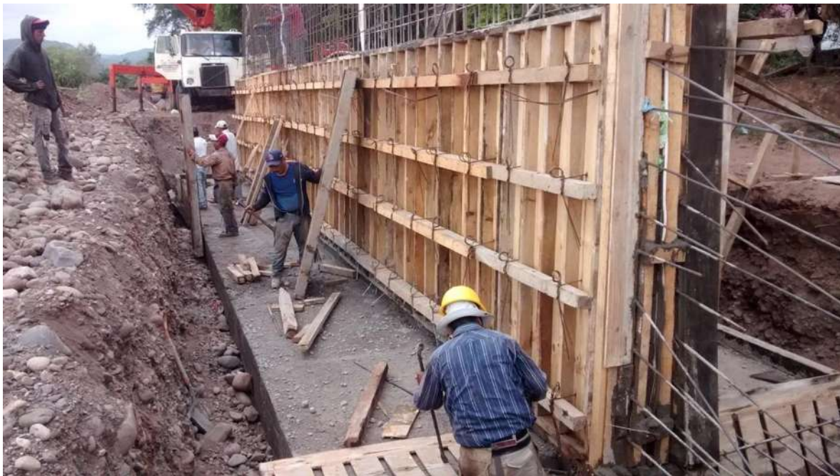
IMAGEN XI (CIMBRADO DE MEDIA PARTE DE LA ALTURA TOTAL DEL MURO)
