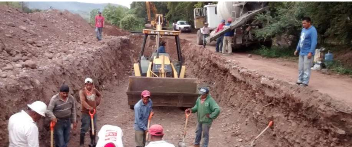
IMAGEN III (EXCAVACION A CIELO ABIERTO)
