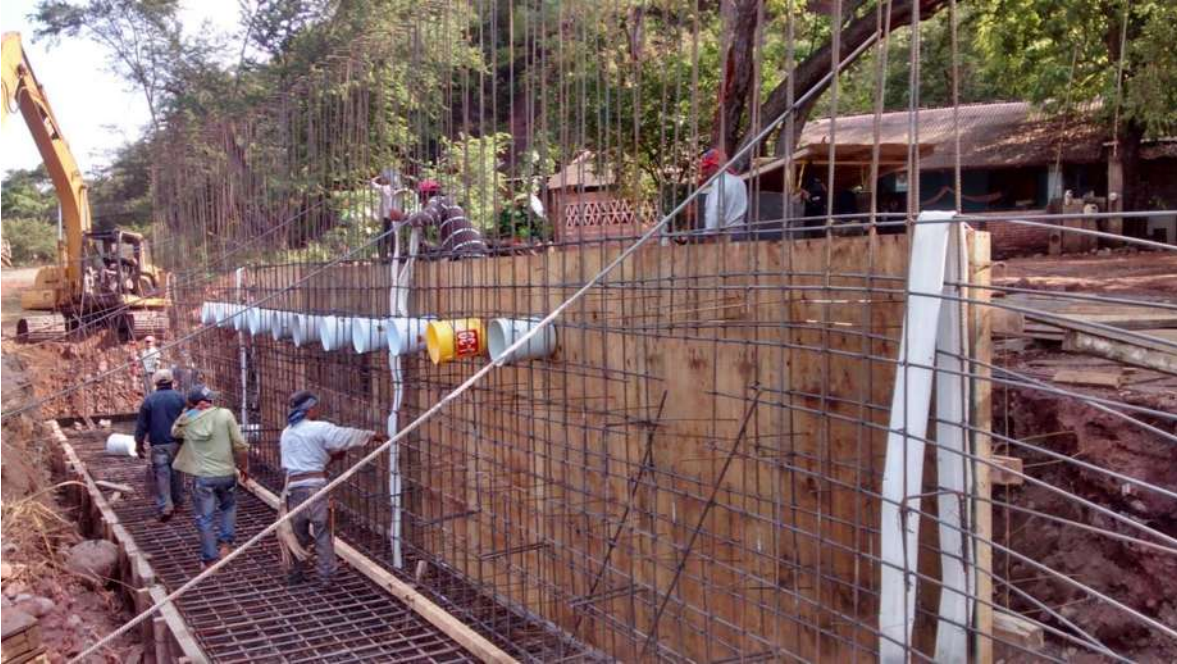
IMAGEN VIII (COLOCACION DE OJILLOS DE 30 CM CON BOTES DE PLASTICO Y COLOCACION DE BANDA DE PVC)
