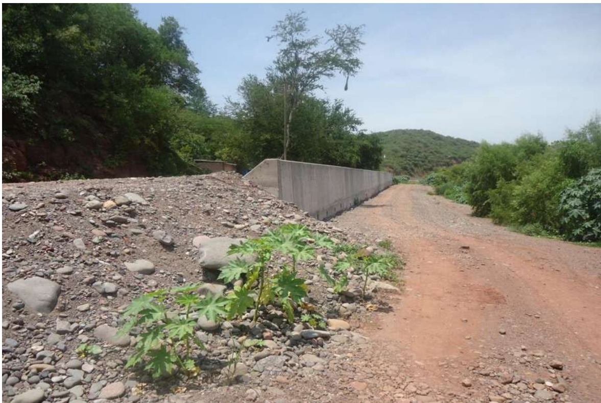
IMAGEN XXX (MURO DE CONCRETO TERMINADO)
