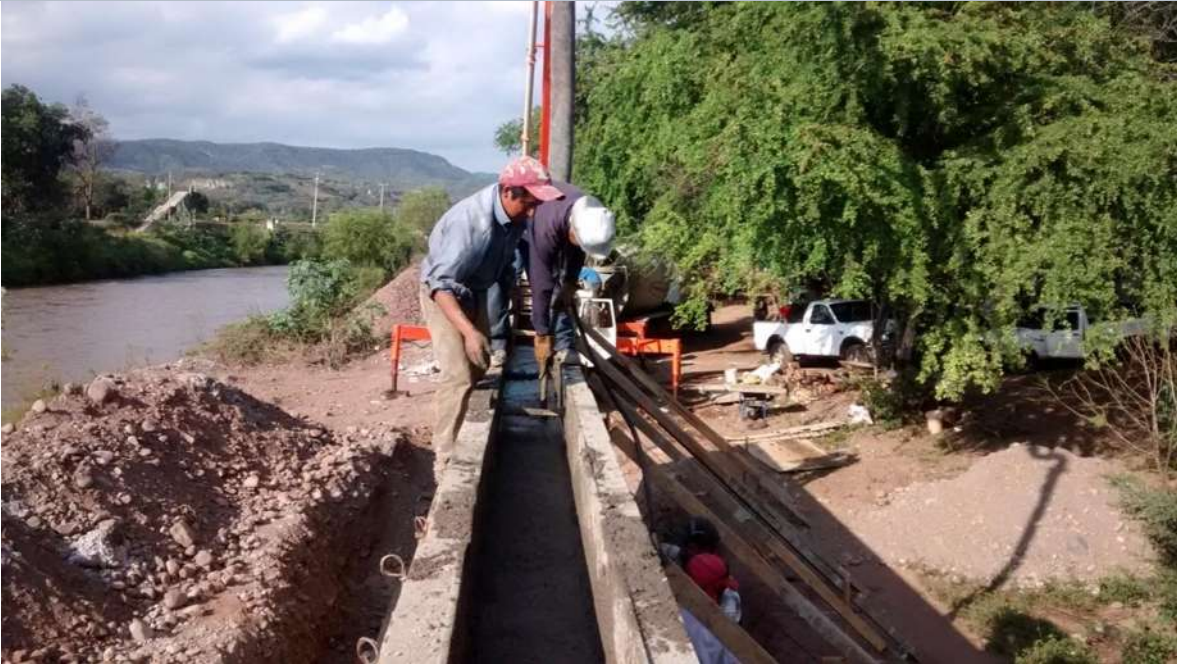
IMAGEN XXII (VIBRADO DEL CONCRETO)
