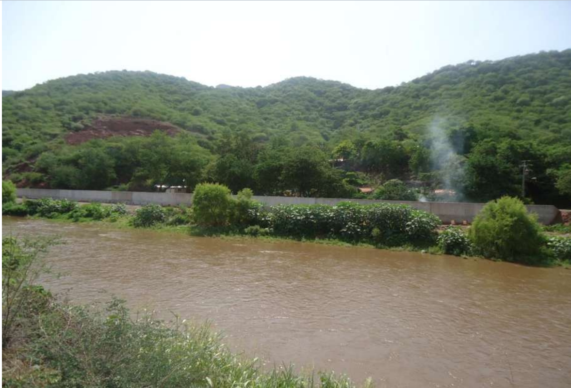
IMAGEN XXV (MURO DE CONCRETO TERMINADO)
