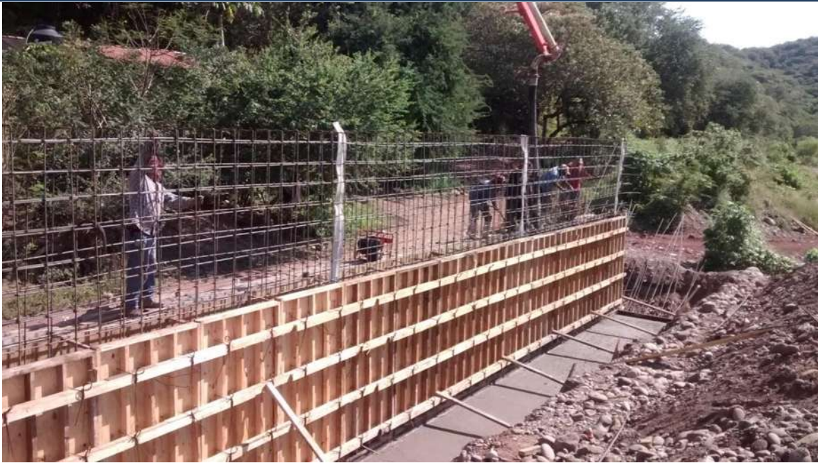
IMAGEN XII (COLADO DEL MURO)
