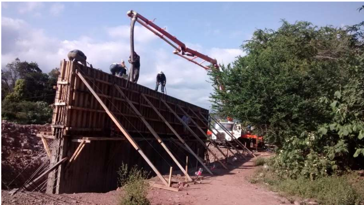
IMAGEN XXI (COLADO DE LA OTRA MEDIA PARTE DEL MURO DESDE OTRA PERSPECTIVA)
