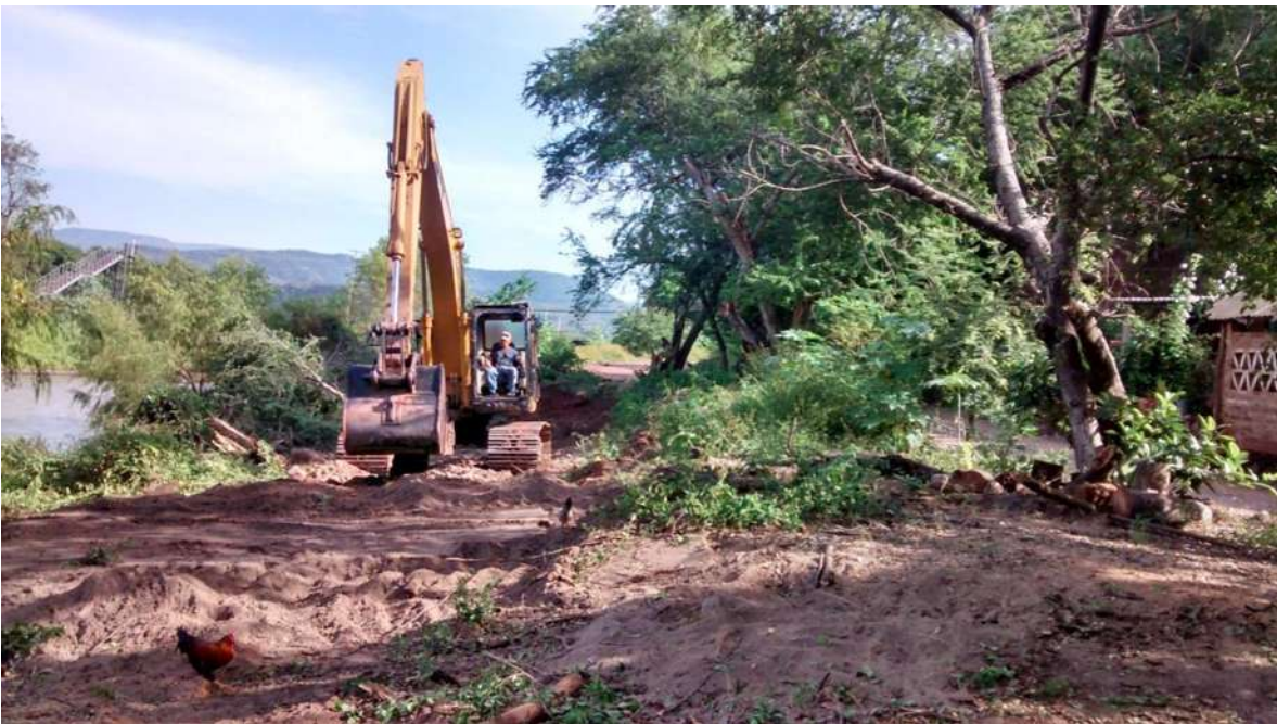
IMAGEN I (LIMPIA DEL TERRENO)
