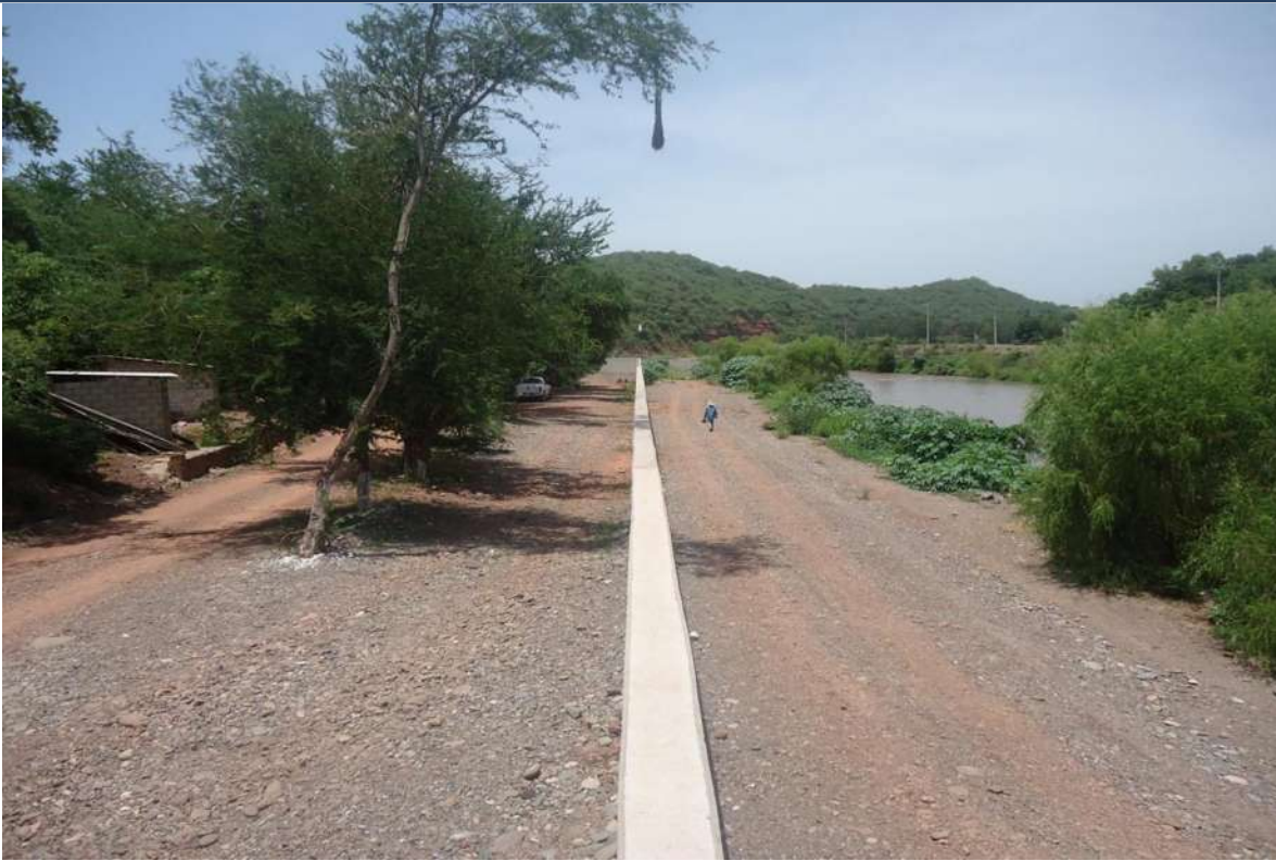
IMAGEN XXXI (MURO DE CONCRETO TERMINADO)
