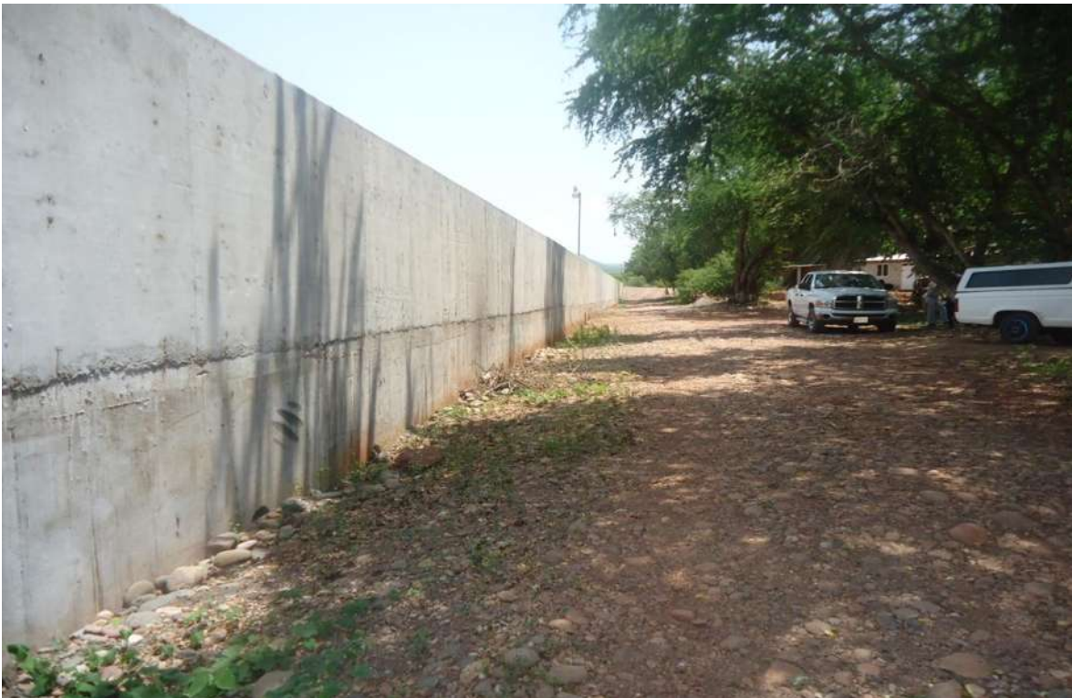
IMAGEN XXVIII (MURO DE CONCRETO TERMINADO)
