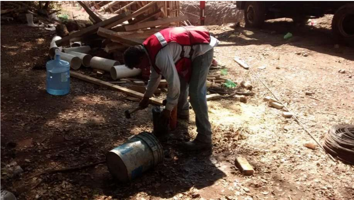
IMAGEN VII – GOLPETEO LATERAL CON MAZO DE HULE PARA CERRAR VACIOS
