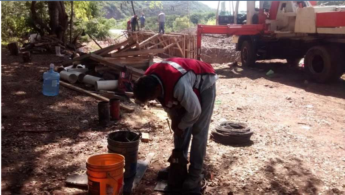
IMAGEN XV (REALIZACION DE LA PRUEBA DE REVENIMIENTO)
