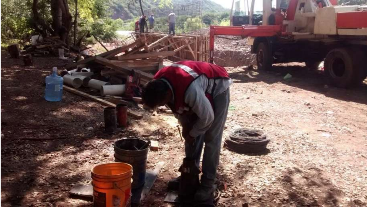
IMAGEN II – PROCEDIMIENTO DE LA DETERMINACION DEL REVENIMIENTO EN EL CONCRETO FRESCO
