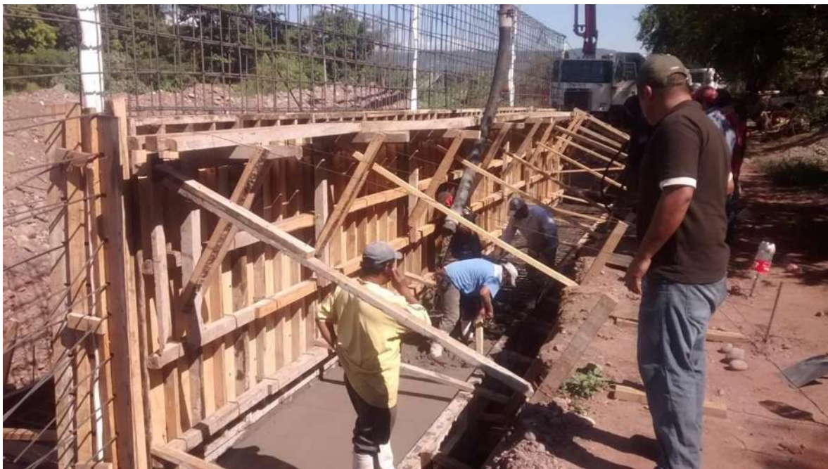
IMAGEN X (CIMBRADO Y COLADO DE LA ZAPATA DEL MURO)
