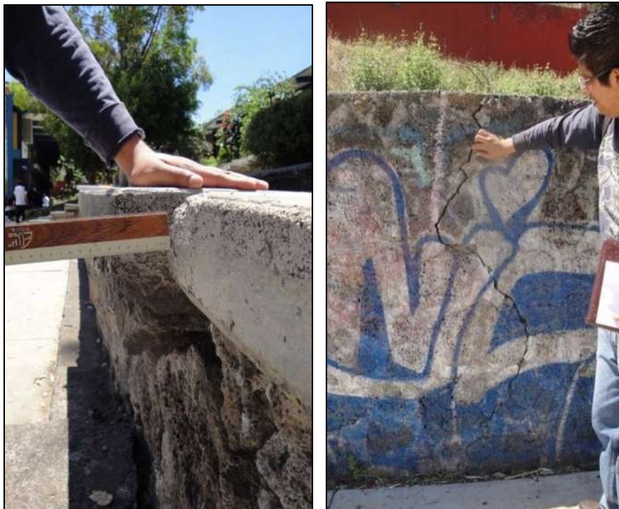
Figuras 3.2.29. a.) Muro movido por el empuje de material en el segundo nivel del terreno. b.) Muro agrietado también por el empuje de material deslizado en el tercer nivel de terreno.
