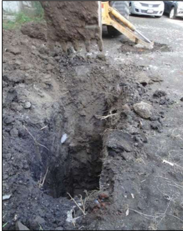
Figura 5.2.4. Primer estrato del PCA-2 a una profundidad de 1.70 metros.
