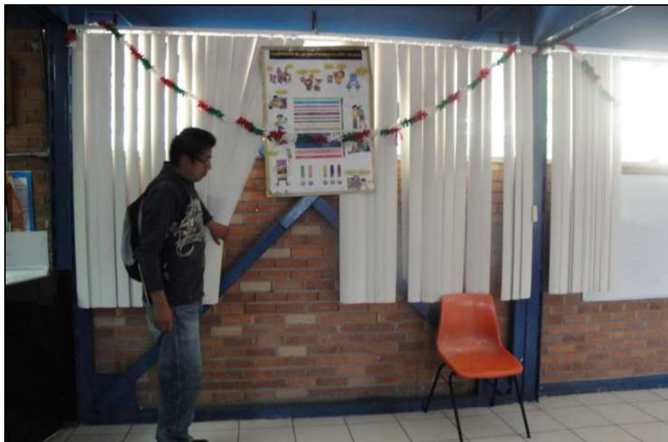
Figura 3.2.21. Colocación de arriostramiento en las columnas de acero para la prevención de inestabilidades del edificio donde se encuentra la biblioteca.
