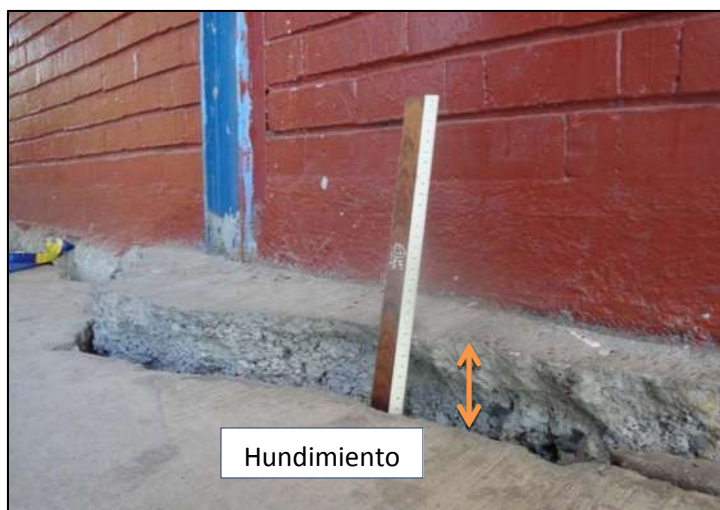
Figura3.2.14. Hundimiento de una parte de la banqueta.
