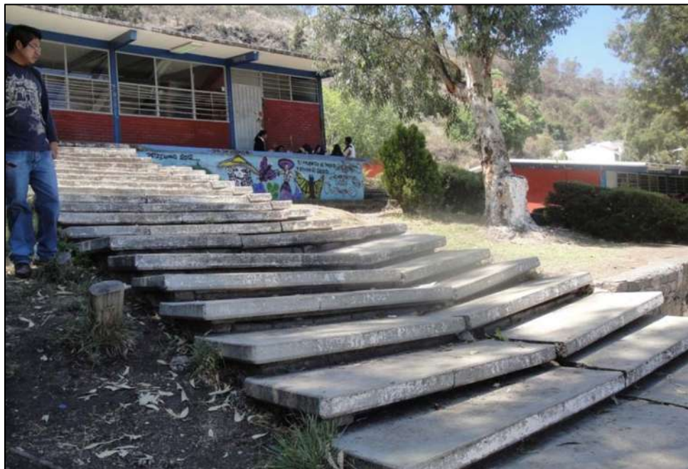
Figura 3.2.9 Fracturas y grietas en la tercera escalera de acceso al tercer nivel de terreno.
