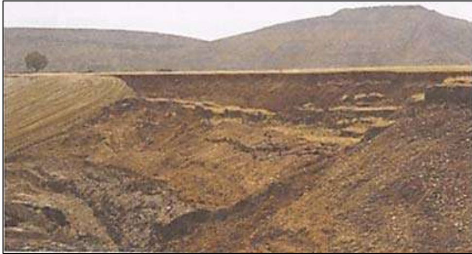
Figura 2.3.4.1. Rotura curva de un talud en suelos arcillosos y pizarras. Puertollano, Ciudad Real; se observa la grieta de tracción y el salto vertical de la cabecera del talud (González de Vallejo et al, 2004).
