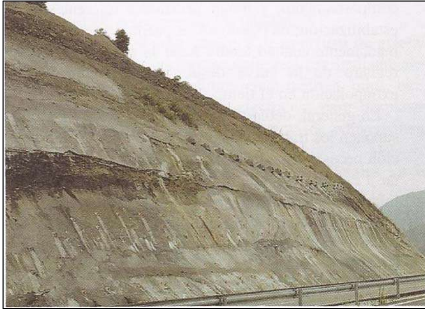
Figura 2.4.2.16. Talud de carretera cubierto de gunita (foto L. González de Vallejo).González de Vallejo et al, 2004.
