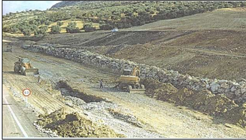
Figura 2.4.2.4. Medidas de estabilización en un talud de carretera de la autovía A-92: colocación de una escollera para reforzar el pie del talud, escalonamiento y retaluzado del ángulo general y en primer término zanja rellena de grava para drenar la zona de pie (Foto M. Ferrer). González de Vallejo et al, 2004.
