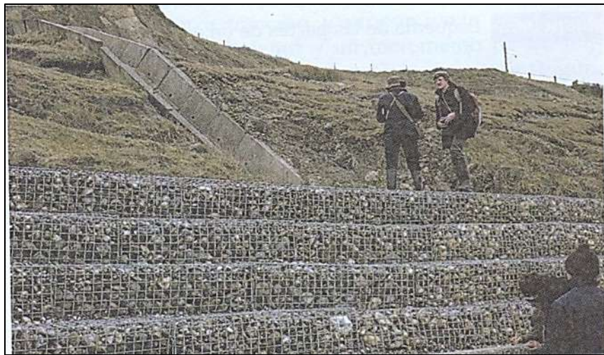
Figura 2.4.2.13. Muro de Gaviones a pie de talud y cuneta de drenaje (foto L. González de Vallejo).González de Vallejo et al, 2004.
