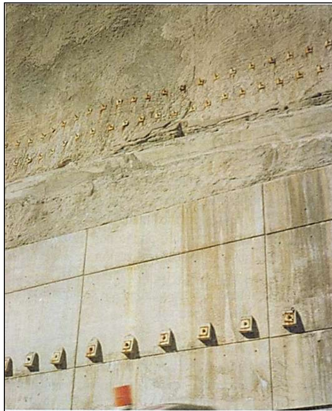
Figura 2.4.2.15. Medidas de estabilización en un talud de carretera: muro anclado en la parte inferior, gunita y bulones en la parte superior (foto M. Ferrer). González de Vallejo et al, 2004
