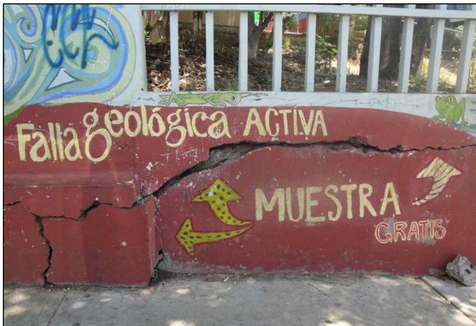
Figura 3.2.5. Grietas y fracturas presentes en las barda perimetral frontal de la Escuela Secundaria No. 77.
