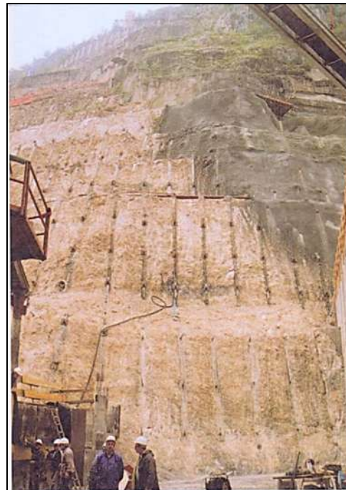
Figura 2.4.2.9. Excavación de un gran talud estabilizado mediante anclajes arriostrados, con la parte superior derecha protegida con gunita. Norte de Italia (foto M. Ferrer). González de Vallejo et al, 2004.
