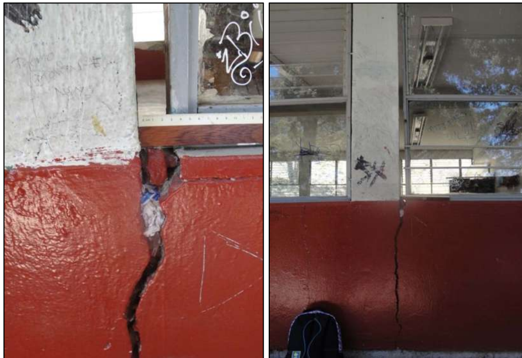
Figura 3.2.18. Abertura dispereja en el muro de uno de los salones de la edificación 6 al sureste de la escuela.
