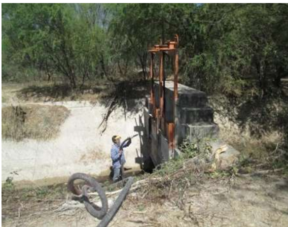
Imágenes IV.16 y IV.17: Limpieza con sand-blas y aplicación de pintura en compuerta.
