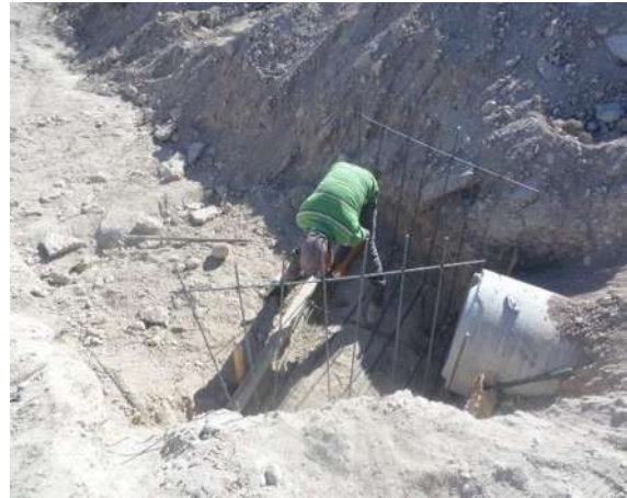
Imágenes IV.27 y IV.28: Colocación de acero en paso superior y en toma directa.
