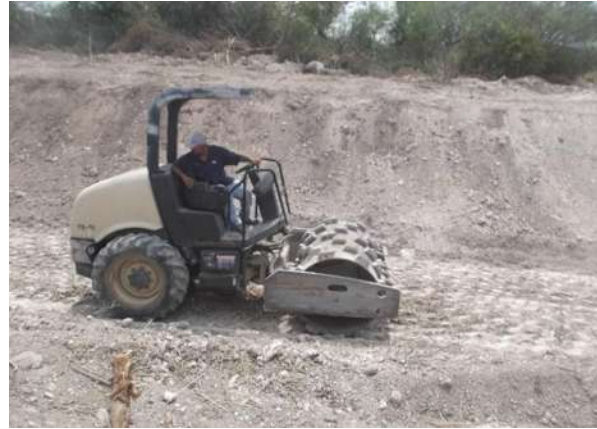
Imágenes IV.43 y IV.44: Aplicación de riego y compactación con rodillo pata de cabra.
