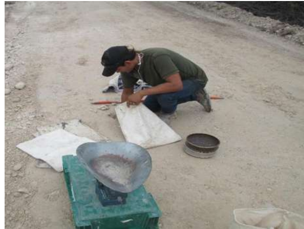
Imágenes IV.46 y IV.47: Tendido de material y realizando prueba de compactación.
