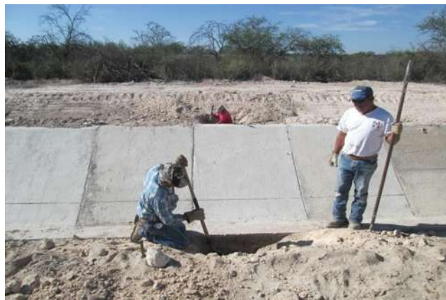
Imagen IV.57: Excavación para alojar estructuras.
