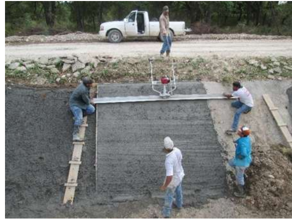
Imágenes IV.10 y IV.11: Colocación de concreto y uso de regla vibratoria.
