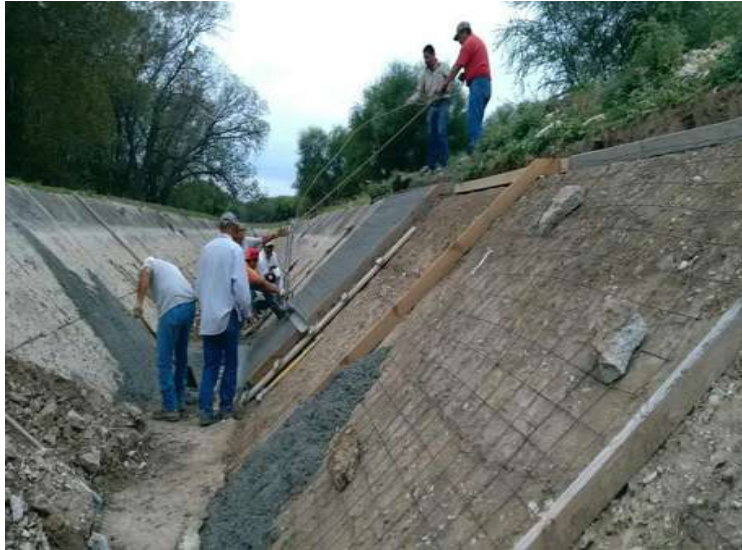
Imagen IV.9: Colocación de malla.
