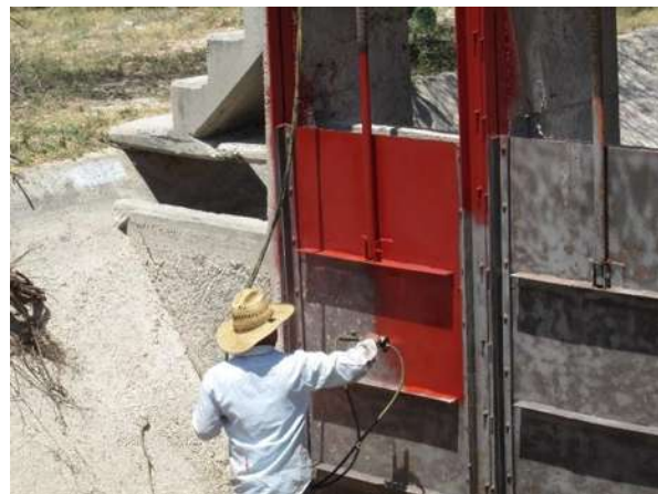
Imágenes IV.16 y IV.17: Limpieza con sand-blas y aplicación de pintura en compuerta.
