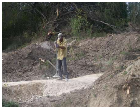
Imágenes IV.63 y IV.64: Acarreo de material para relleno y compactación con pisón.
