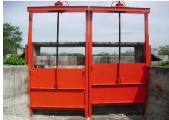
Imágenes IV.32 y IV.33: Instalación de compuerta en desfogue y en represa.
