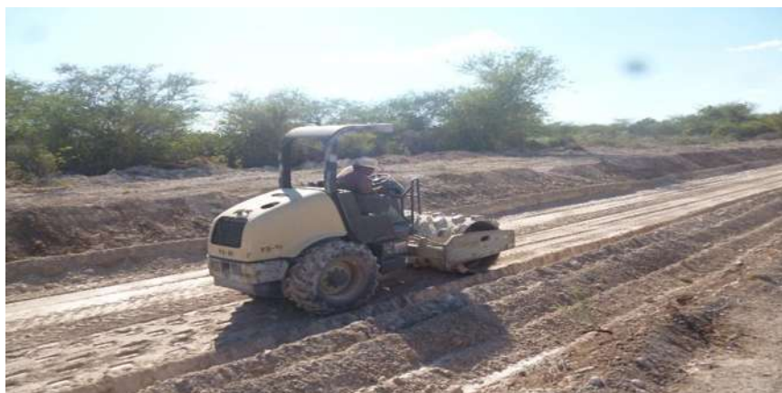
Imagen III.27: Relleno de la sección del canal existente.
