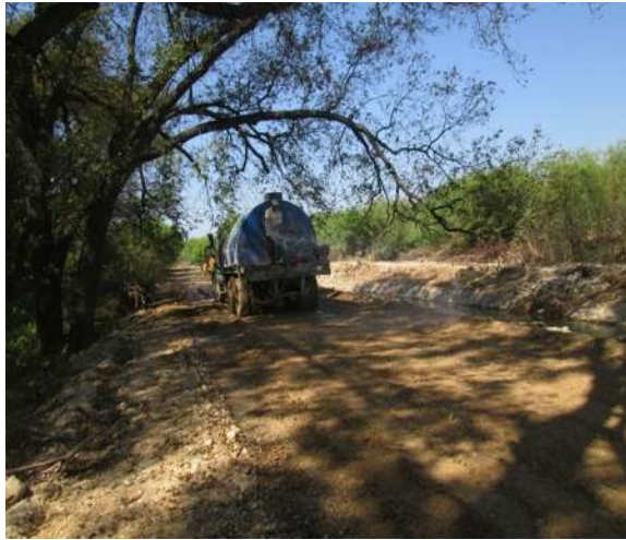
Imágenes IV.20 y IV.21: Homogenización y bandeo y riego al material tendido.
