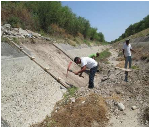
Imágenes IV.7 y IV.8: Afine a mano y colocación de suelo cemento.
