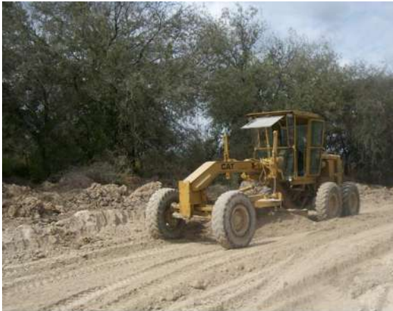
Imágenes IV.46 y IV.47: Tendido de material y realizando prueba de compactación.
