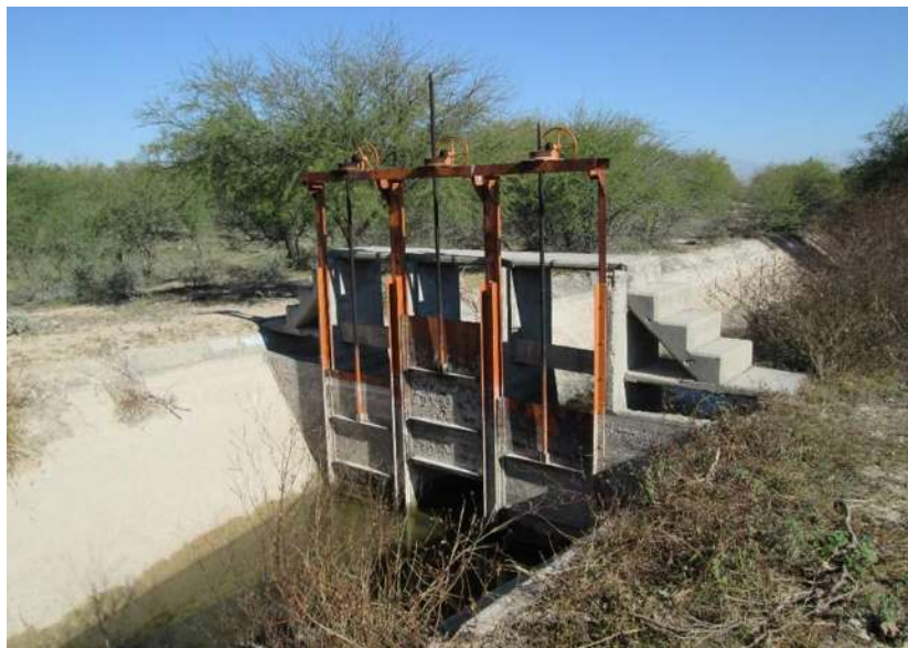
Imagen III.26: Represa en Km. 5+307.50 aplicación de pintura.
