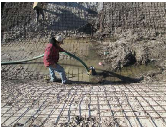
Imágenes IV.67 y IV.68: Achique con bomba de 4" y bomba de 6".
