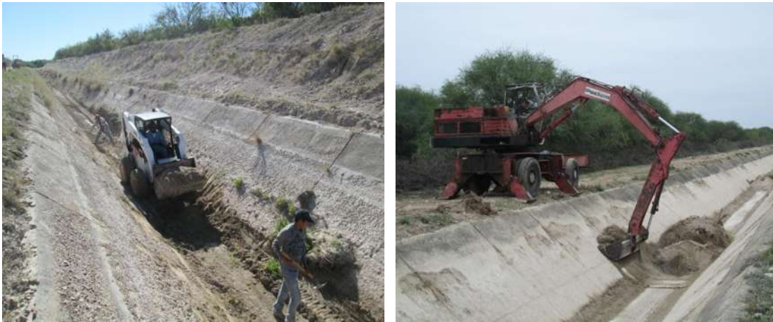
Imágenes IV.3 y IV.4: Desazolve con bobcat y retiro de azolve con excavadora.
