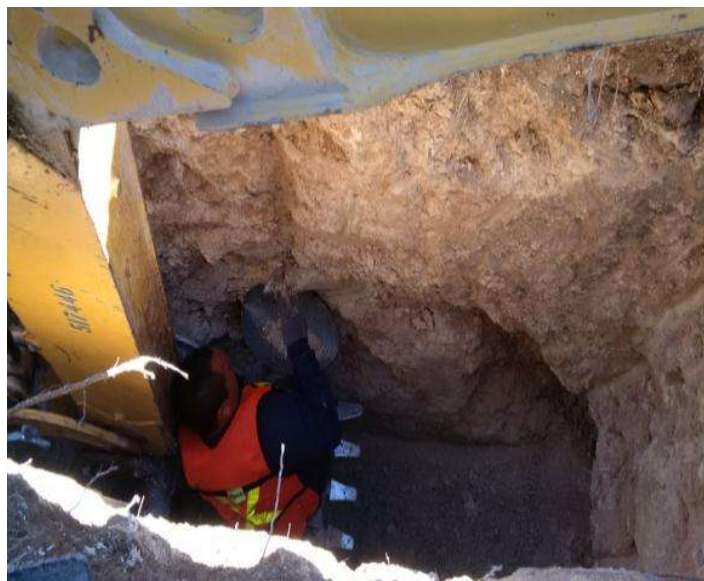
Imagen III.16: PCA 5 Canal Principal Norte.
