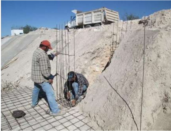
Imágenes IV.59 y IV.60: Suministro de acero en toma y acero en plantilla.
