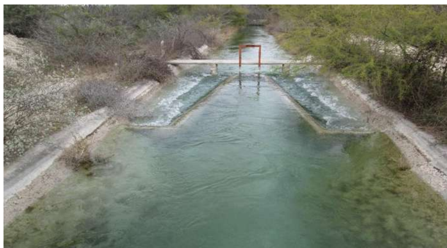
Imagen III.23: Represa “Pico de Pato”, estructura a demoler.
