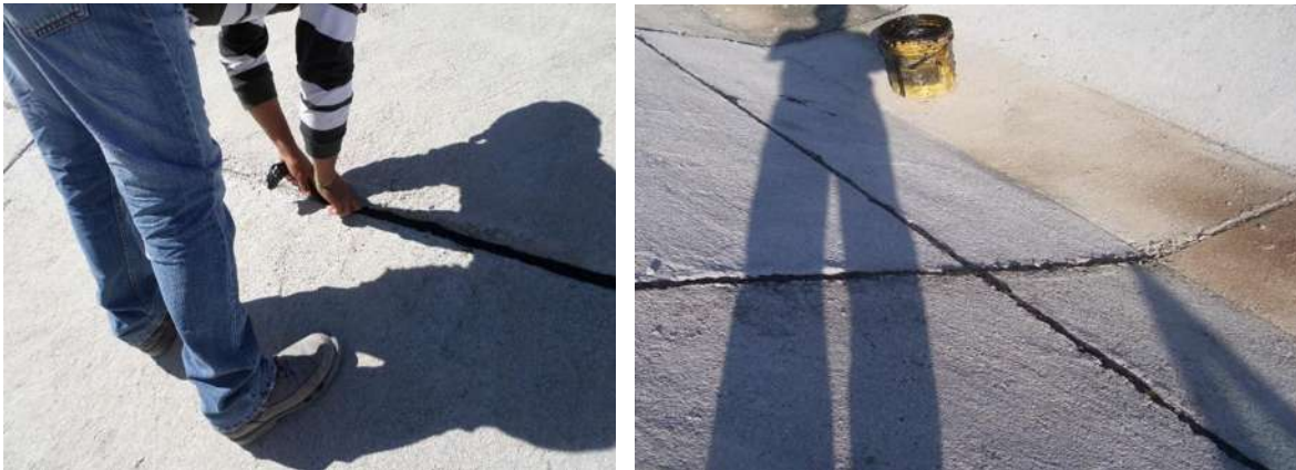
Imágenes IV.52 y IV.53: Colocación de sello y junta asfáltica en ranuras.
