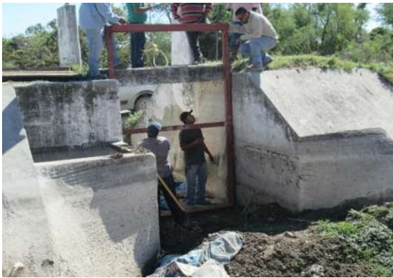
Imágenes IV.32 y IV.33: Instalación de compuerta en desfogue y en represa.
