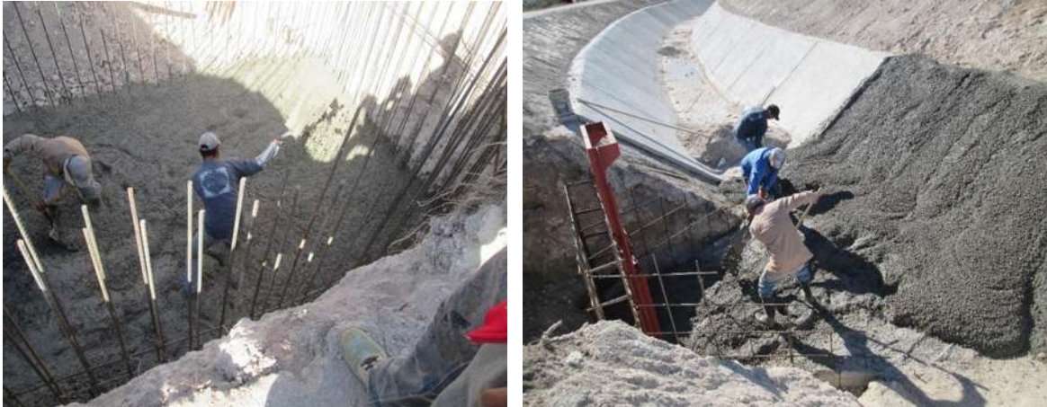
Imágenes IV.61 y IV.62: Suministro de acero en toma y acero en plantilla.
