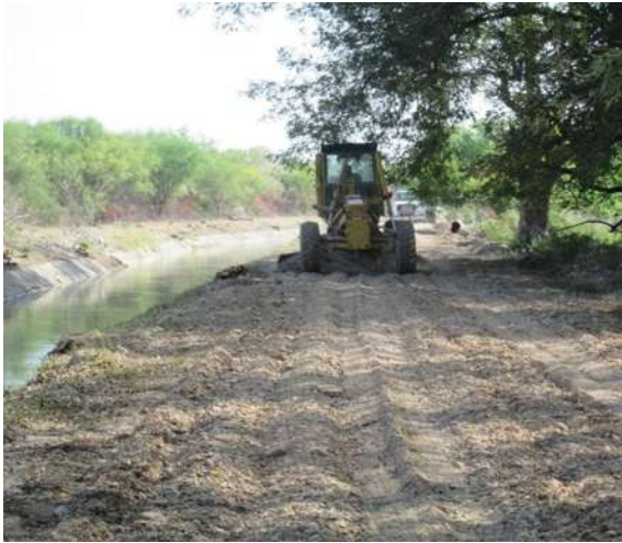
Imágenes IV.20 y IV.21: Homogenización y bandeo y riego al material tendido.
