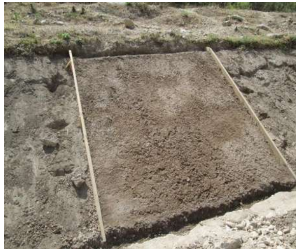
Imágenes IV.7 y IV.8: Afine a mano y colocación de suelo cemento.
