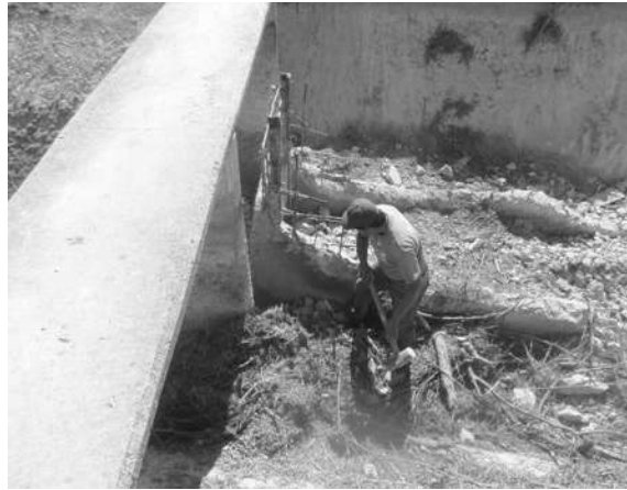
Imagen IV.31: Demolición de la estructura represa pico de pato.
