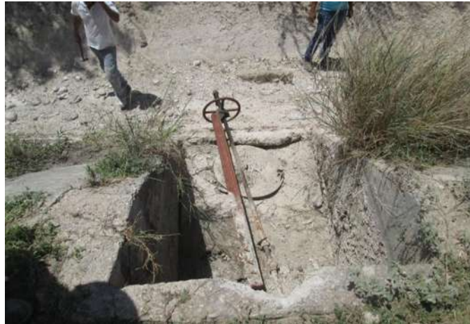
Imagen IV.56: Desinstalación de compuerta Miller.
