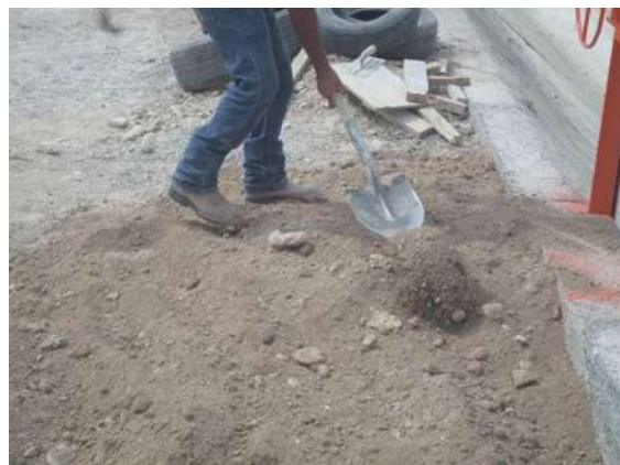
Imagen IV.35: Relleno de estructuras con material de excavaciones previas.
