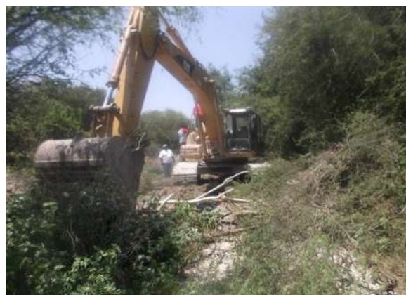
Imágenes IV.38 y IV.39: Desmonte en hombro derecho y desmonte en hombro izquierdo.
