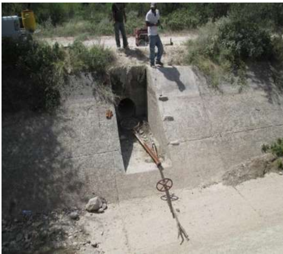
Imágenes IV.14 y IV.15: Desinstalación de compuertas Miller y desinstalación de compuertas deslizantes.
