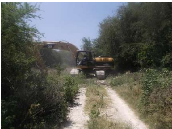
Imágenes IV.38 y IV.39: Desmonte en hombro derecho y desmonte en hombro izquierdo.
