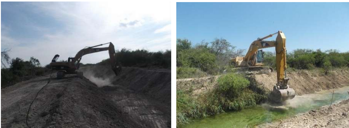
Imágenes IV.41 y IV.42: Excavación y remoción de material indeseable.
