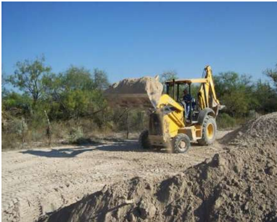
Imágenes IV.63 y IV.64: Acarreo de material para relleno y compactación con pisón.
