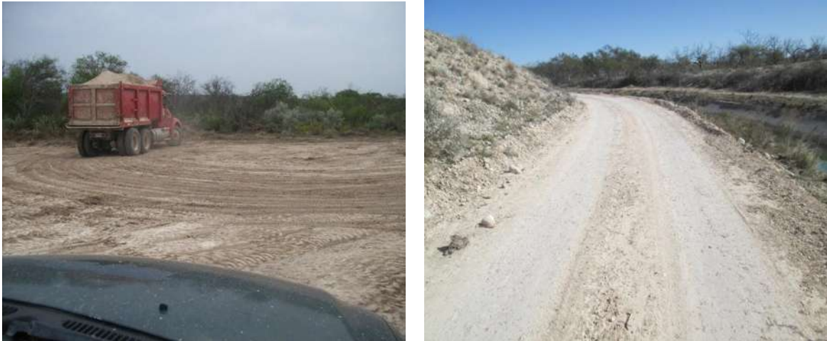
Imágenes IV.23 y IV.24: Acarreos de material y revestimiento de camino.
