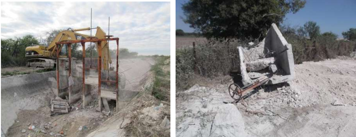
Imágenes IV.54 y IV.55: Demolición de represa y estructura de toma directa.
