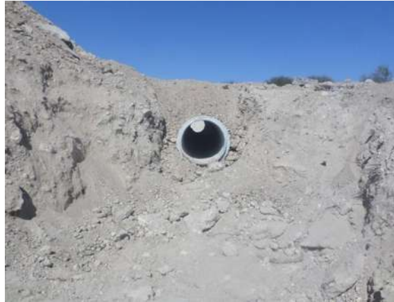
Imagen IV.58: Suministro de tubo de concreto.
