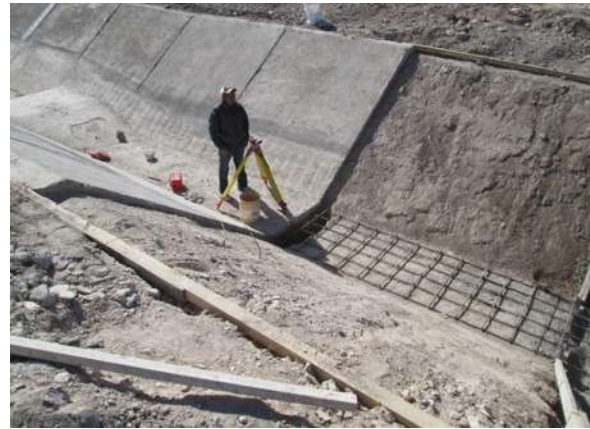
Imágenes IV.59 y IV.60: Suministro de acero en toma y acero en plantilla.
