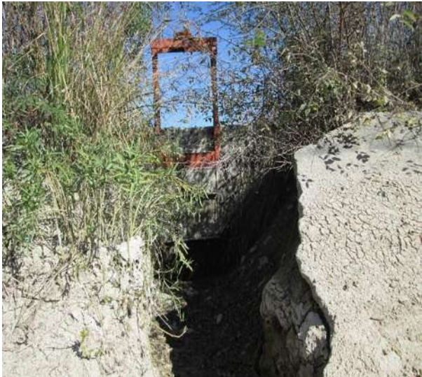
Imagen III.21: Transición de entrada, de toma Lat.
