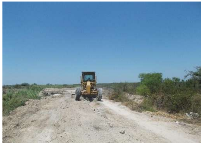
Imagen IV.40: Despalme dentro de la cubeta del canal.
