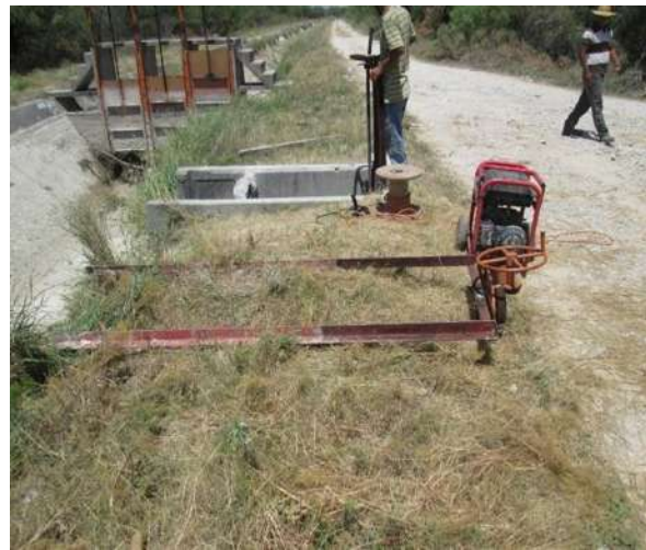
Imágenes IV.14 y IV.15: Desinstalación de compuertas Miller y desinstalación de compuertas deslizantes.
