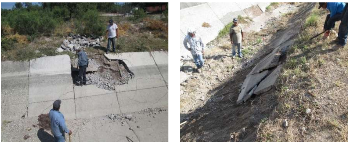
Imágenes IV.5 y IV.6: Demolición de losas y retiro de material.
