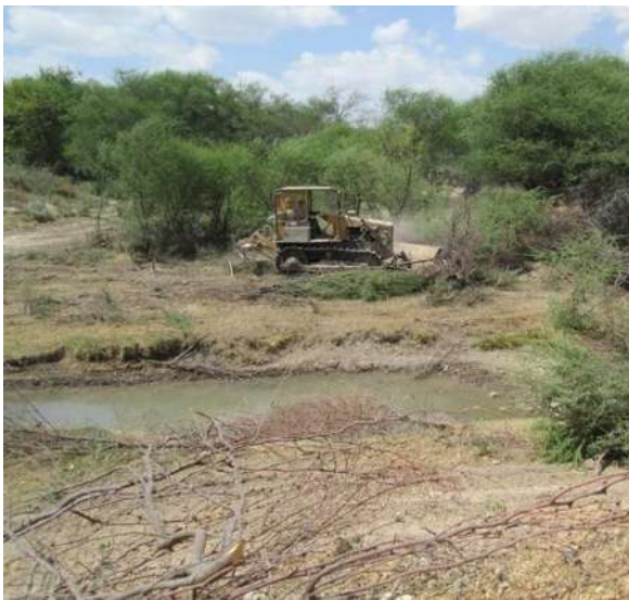
Imágenes IV.1 y IV.2: Desmonte y limpia del terreno y desmonte a mano.
