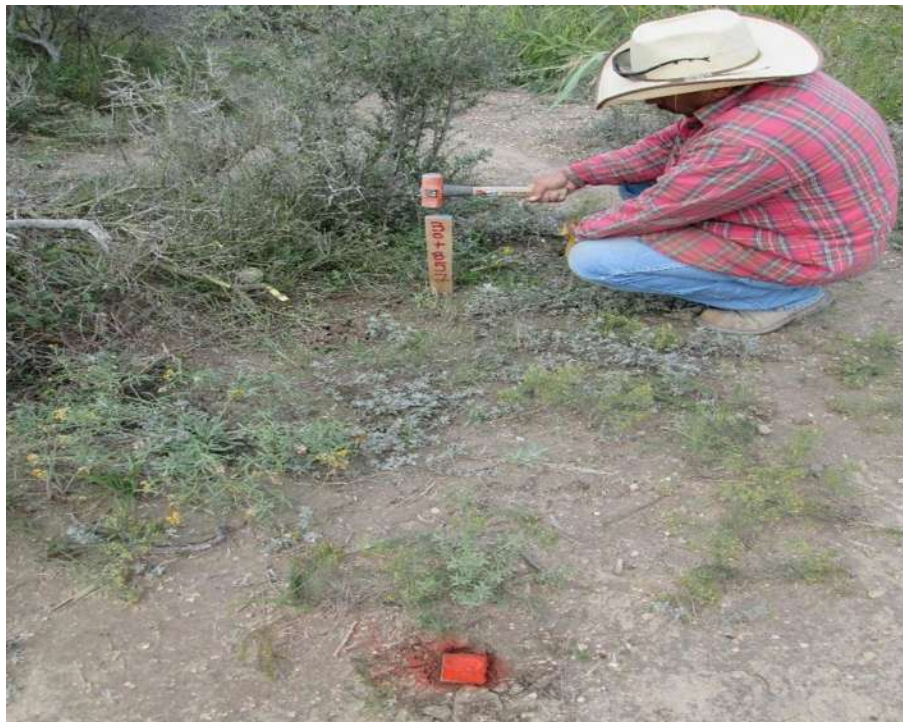
Imagen III.1: Trazo de la poligonal.
