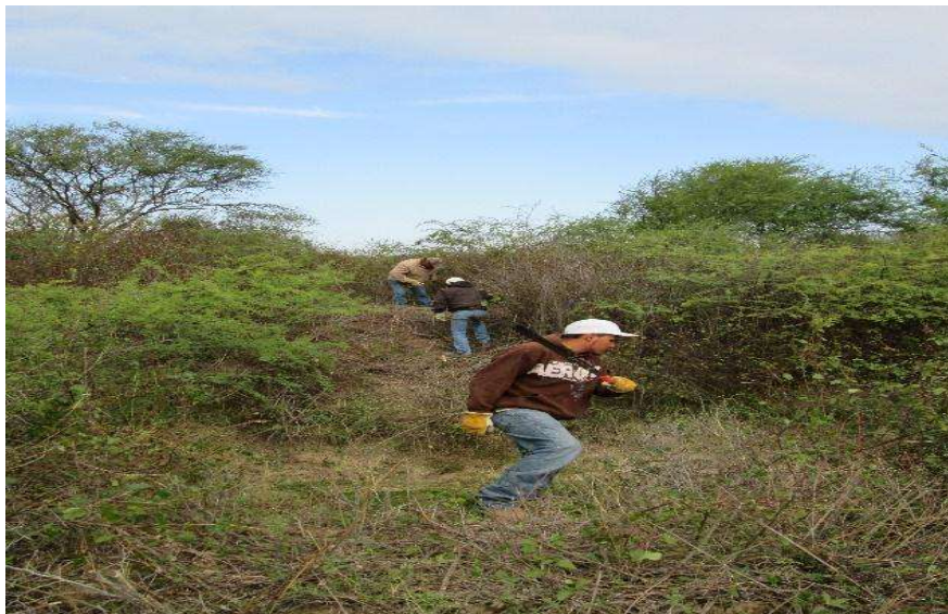
Imagen III.6: Apertura de picaduras en Canal Principal Norte.
