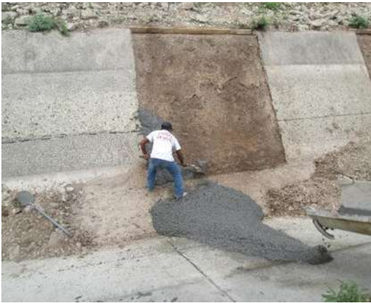
Imágenes IV.10 y IV.11: Colocación de concreto y uso de regla vibratoria.
