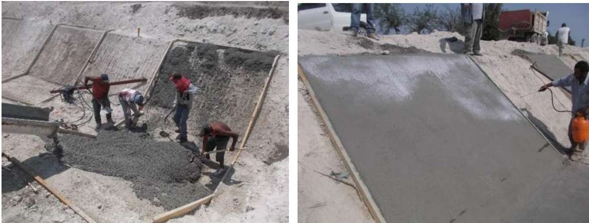
Imágenes IV.50 y IV.51: Colado de losas y aplicación de curacreto.
