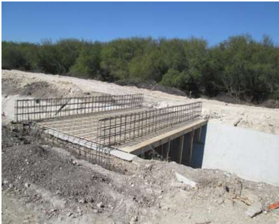
Imágenes IV.27 y IV.28: Colocación de acero en paso superior y en toma directa.
