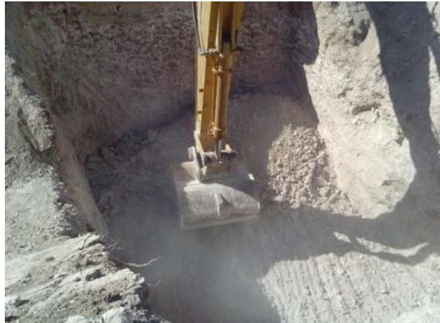
Imagen IV.45: Excavación en roca.
