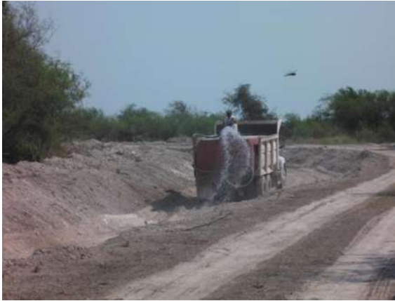
Imágenes IV.43 y IV.44: Aplicación de riego y compactación con rodillo pata de cabra.
