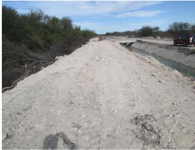
Imagen IV.22: Terraplén en la margen izquierda.
