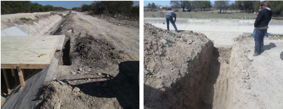
Imágenes IV.25 y IV.26: Excavación en paso superior y excavación para alojar toma directa.
