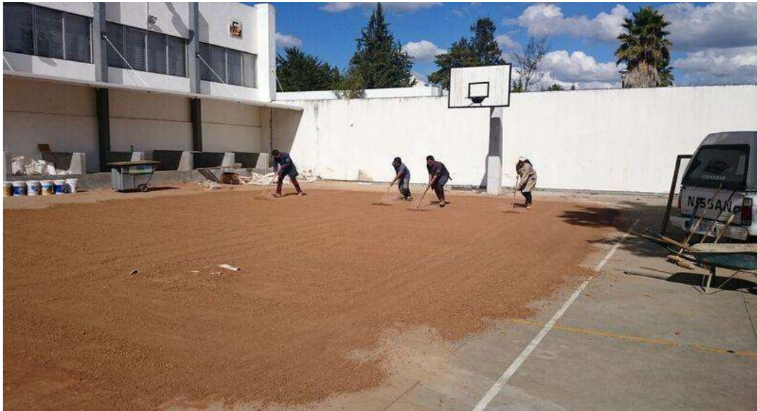
Ilustración 24: Disgregación del material (De Leon Ambrocio, 2016)
