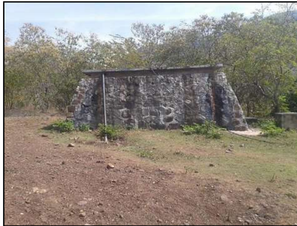
Figura: 5. 3. Tanque de almacenamiento de agua.
