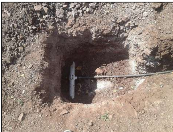
Figura: 4. 1. Conexión red a toma domiciliaria (agua potable).
