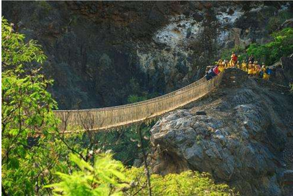
Figura 14. Puente construido en Perú por la cultura inca.
