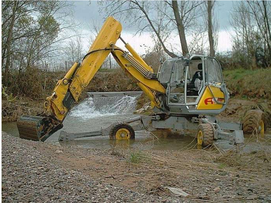
Figura 75. Retroaraña en terreno difícil de operar.
