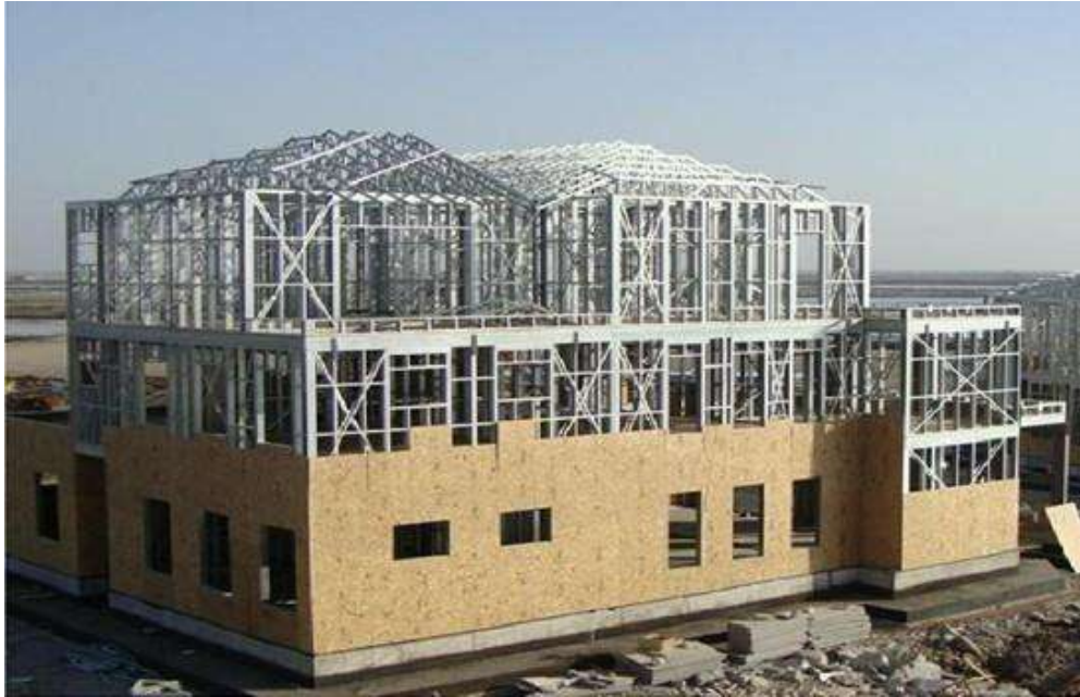
Figura 83. Edificación con estructura de acero.
