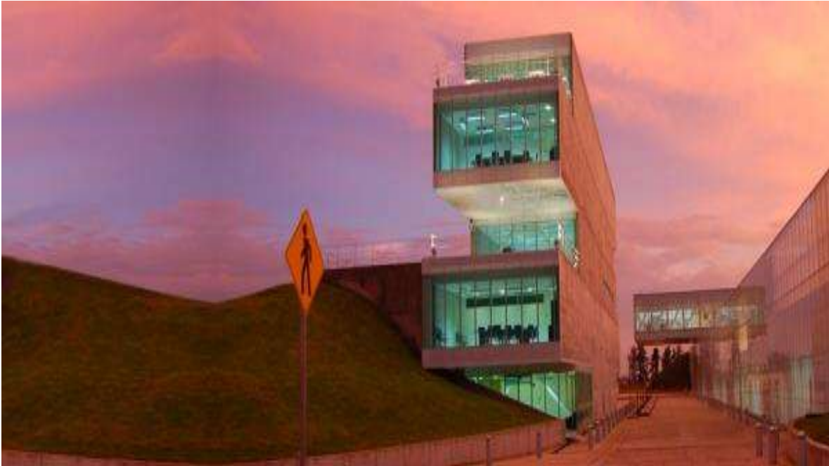
Figura 30. Edificio del centro de investigaciones LANGEBIO, en el Estado de Guanajuato.
