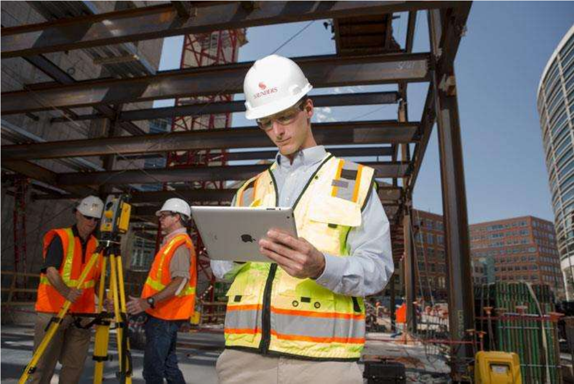
Figura 80. Ingenieros civiles utilizando estación total y captando datos en una tableta.
