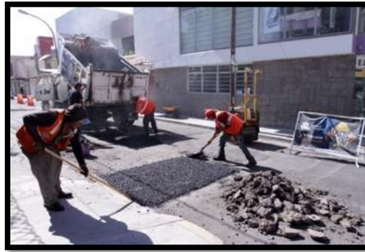
Figura 20. Obras de bacheo en la ciudad de Puebla, Puebla (Fuente: pueblacapital.gob.mx)
