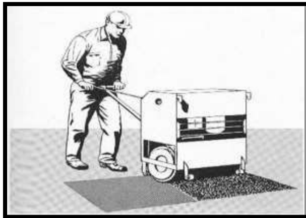
Figura 19. Compactación de la mezcla (SCT, 2014).
