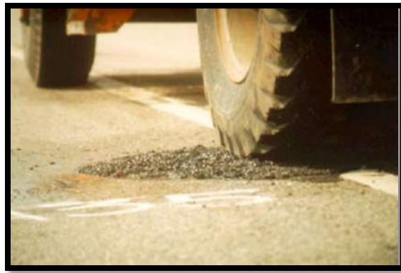
Figura 13.2. Técnica de bacheo Throw and roll (Caltrans, 2007).
