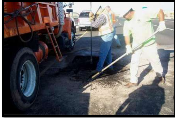
Figura 13.1. Técnica de bacheo Throw and roll (Caltrans, 2007).
