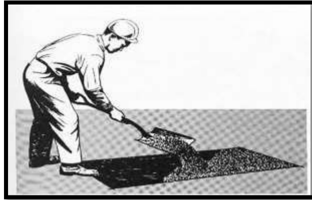
Figura 18. Colocación de la mezcla asfáltica (SCT, 2014).
