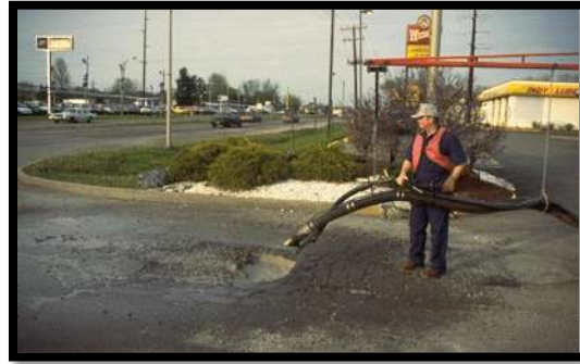
Figura 14.1. Bacheo por inyección (Caltrans, 2007).
