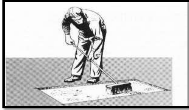
Figura 16. Limpieza de la zona (SCT, 2014).
