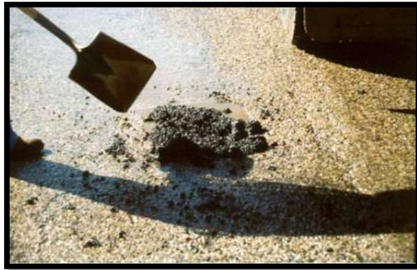
Figura 12. Técnica de bacheo Throw and go (Caltrans, 2007).
