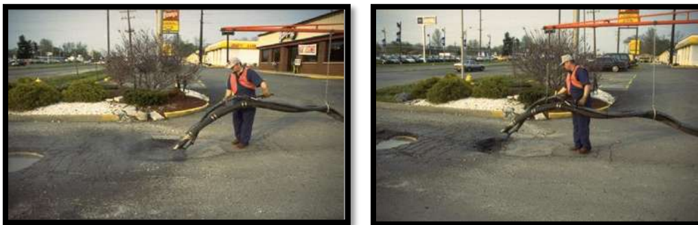
Figura 14.2 y 14.3. Bacheo por inyección (Caltrans, 2007).
