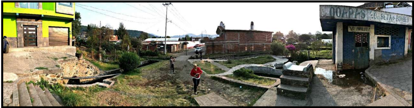
Ilustración 2.20 Vista panorámica a la caseta de bombeo de "El Papalote"
