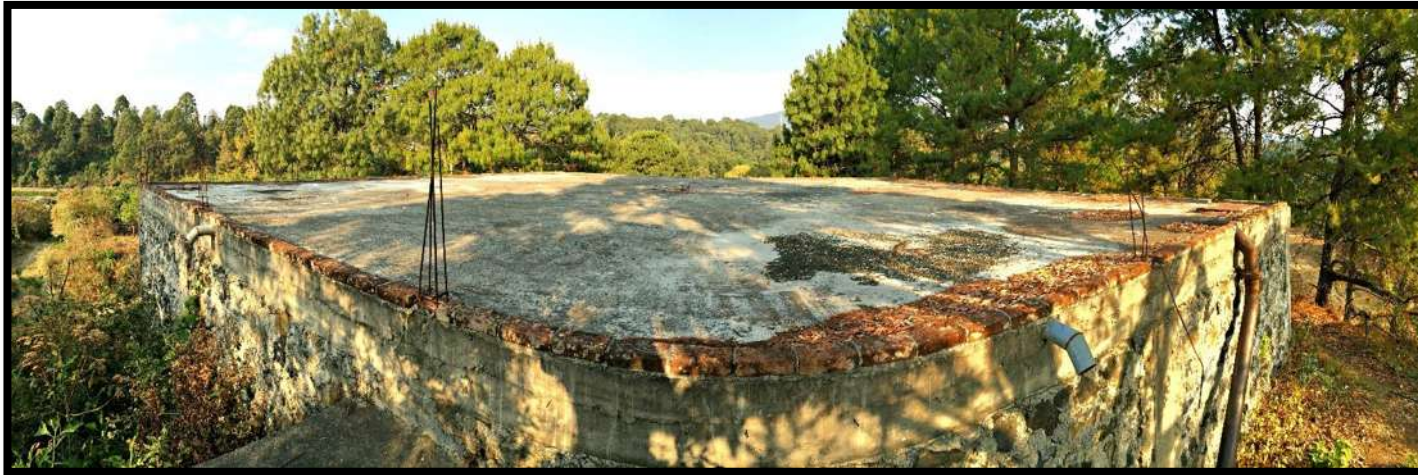
Ilustración 2.16 Vista panorámica del Tanque de regulación de la red "Altavista", ubicado en una de las partes altas de Nuevo San Juan Parangaricutiro, 2017.
