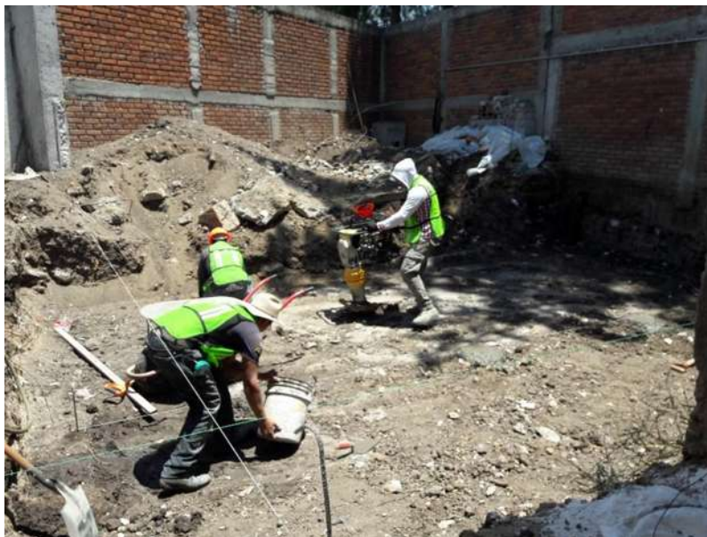
Fotografía 8 Colocación de plantilla de concreto
