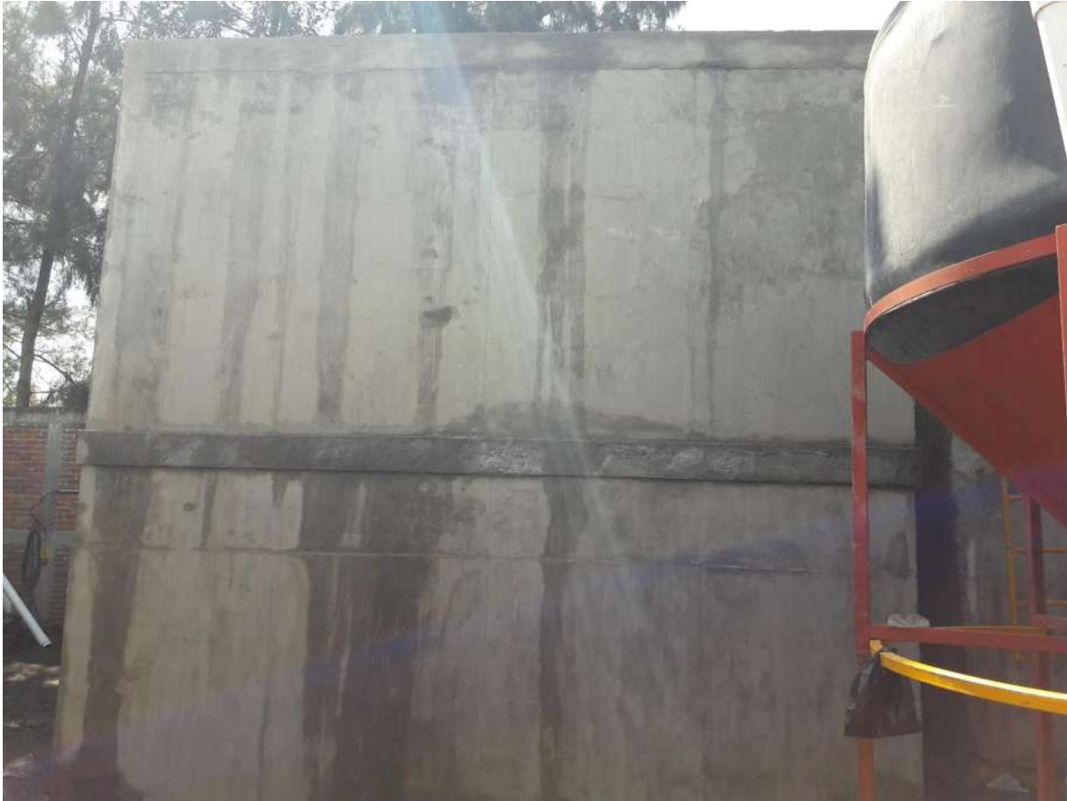
Fotografía 31 Curado de Concreto
