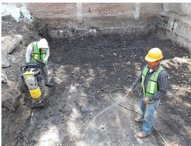
Fotografía 6 Adición de agua para compactación óptima
