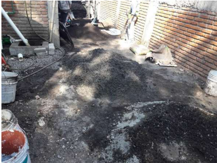
Fotografía 7 Preparación de concreto in situ
