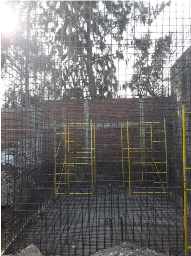
Fotografía 11 Habilidadado de Acero de refuerzo
