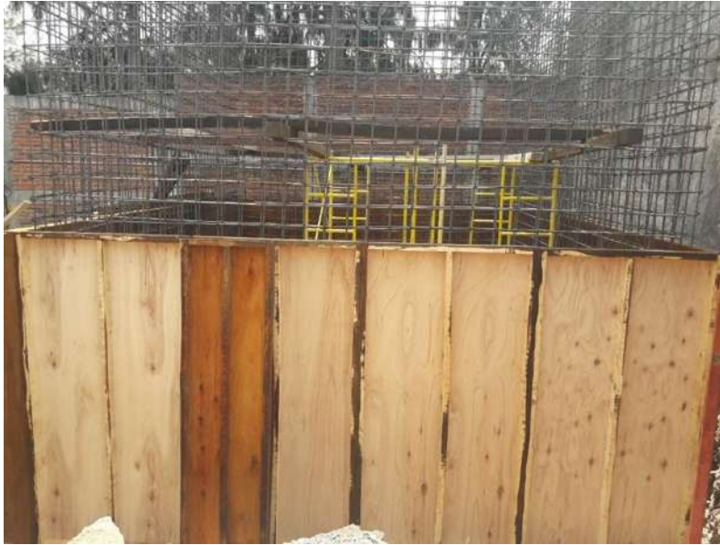
Fotografía 13 Tableros en Cimbra Aparente
