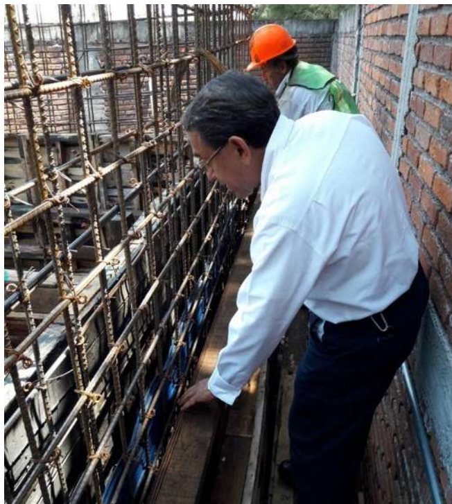
Fotografía 21 Verificación de la Banda de PVC
