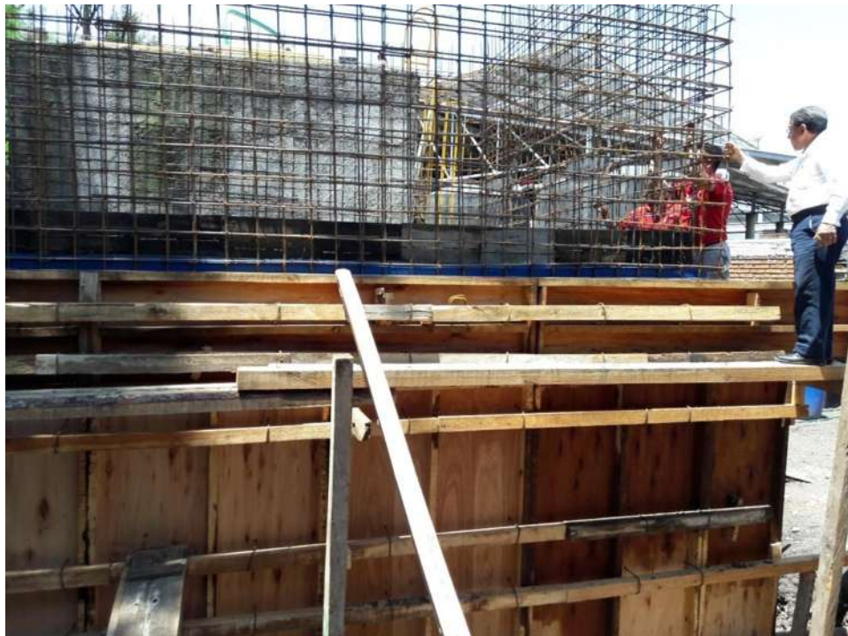
Fotografía 23 Verificación previa al colado
