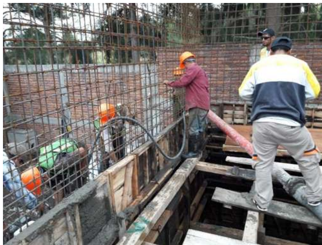
Fotografía 24 Inicio del colado de concreto premezclado
