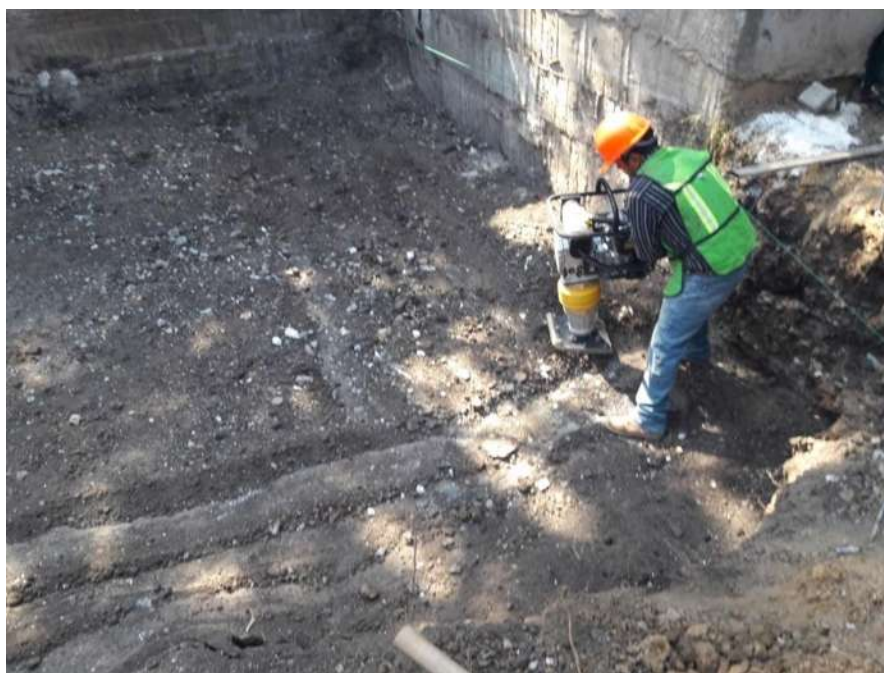
Fotografía 4 Compactación y nivelación
