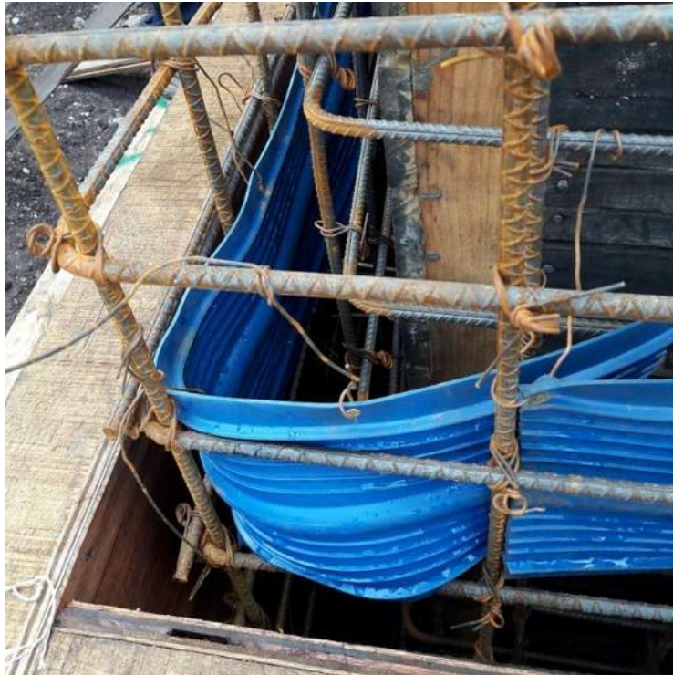
Fotografía 20 Traslape de Banda de PVC
