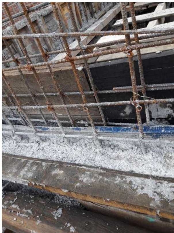
Fotografía 28 Concreto y banda de PVC
