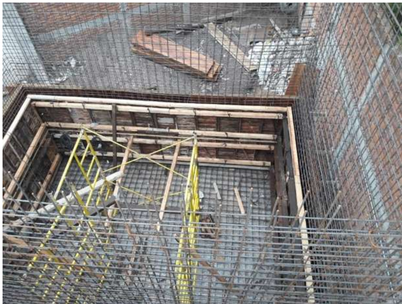
Fotografía 14 Cimbrado interior y exterior
