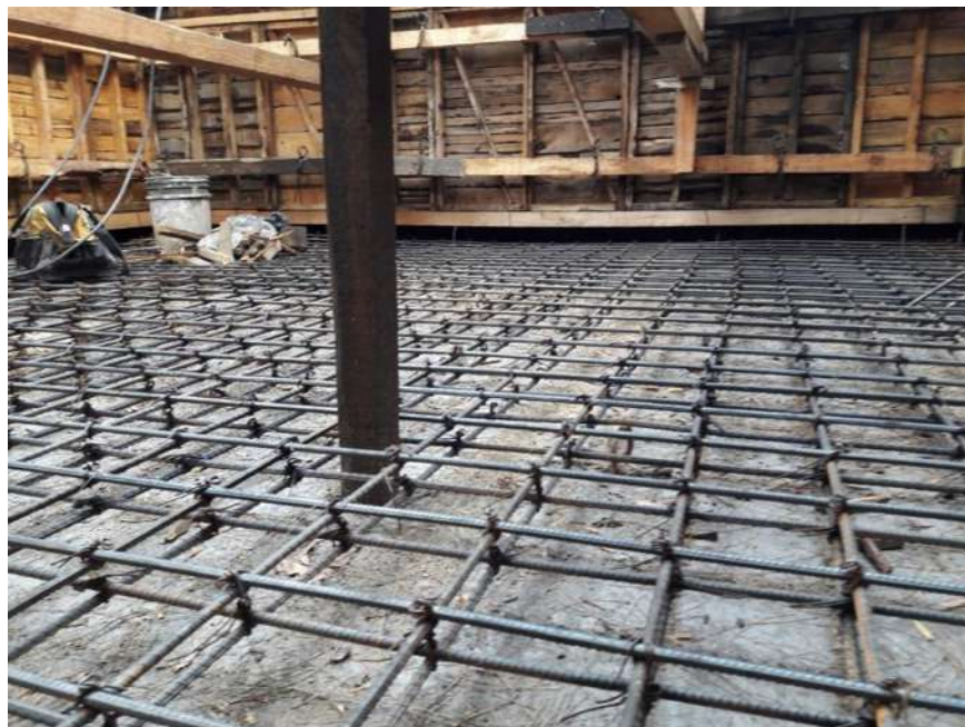
Fotografía 16 Armado de losa de piso
