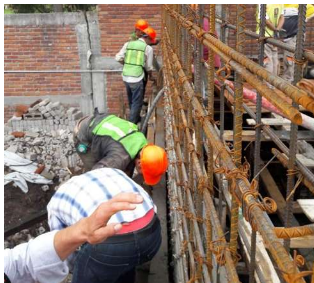
Fotografía 25 Colocación del concreto
