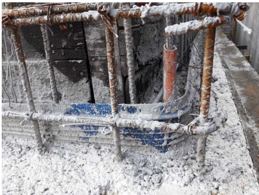
Fotografía 29 Concreto y Banda de PVC
