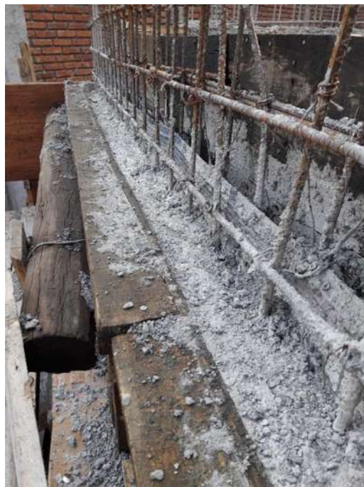
Fotografía 27 Colocación de concreto
