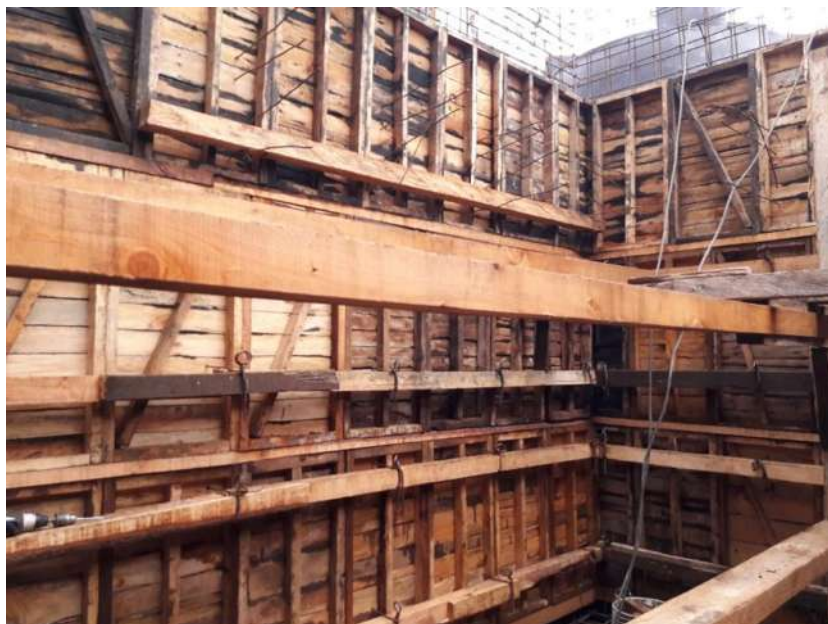
Fotografía 17 Cimbrado interior última etapa
