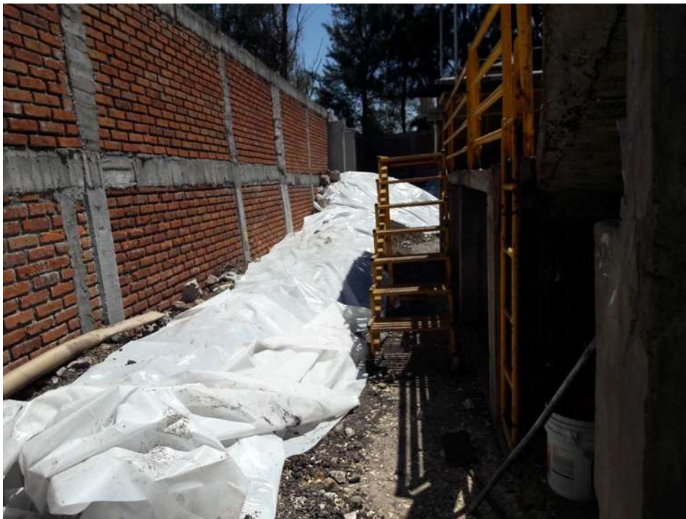
Fotografía 1 Área de la obra
