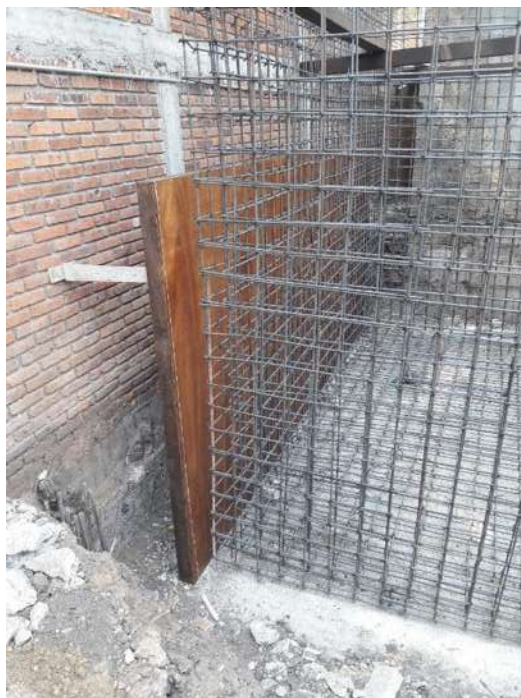
Fotografía 12 Colocación de Cimbra Aparente
