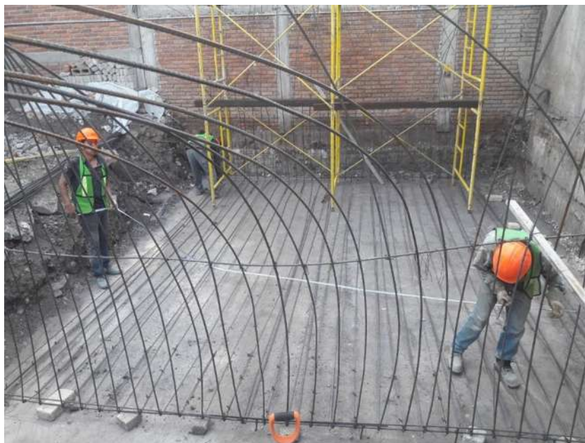
Fotografía 10 Habilitado de Acero de refuerzo
