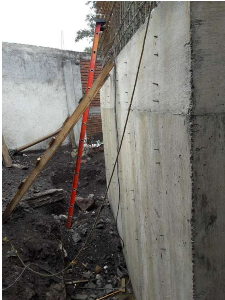
Fotografía 30 Acabado de concreto
