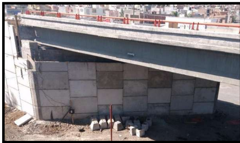
Figura 38 Estribos tipo cerrado
