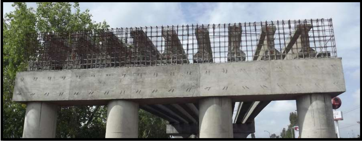
Figura 42 Vista frontal de las vigas
