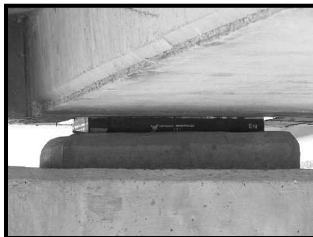
Figura 40 Apoyo de neopreno
