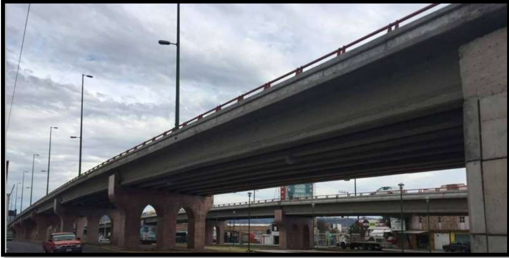
Figura 37 Puente simplemente apoyado, ubicado sobre el libramiento en la ciudad de Morelia
