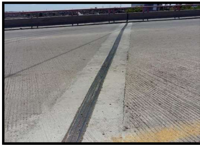
Figura 46 Junta de dilatación del puente de estudio
