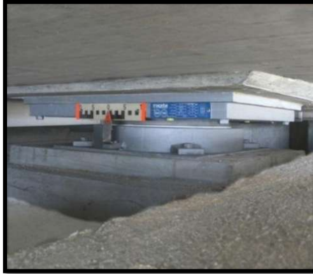
Figura 33 Aislador tipo deslizador plano
