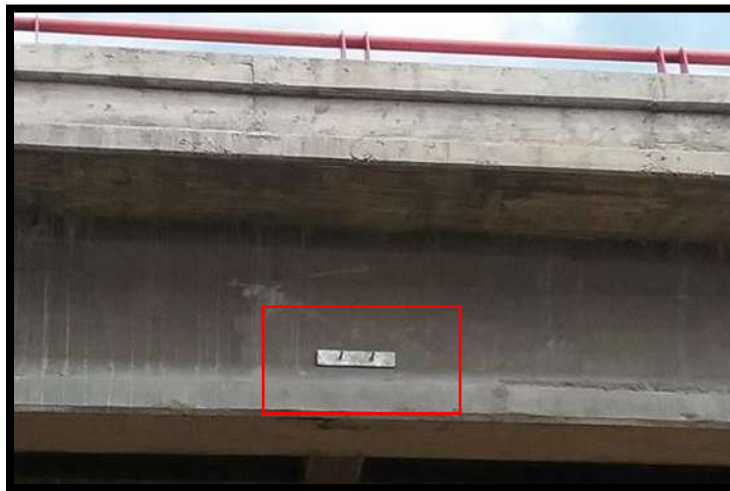
Figura 45 Anclaje utilizado para sostener los muros diafragma
