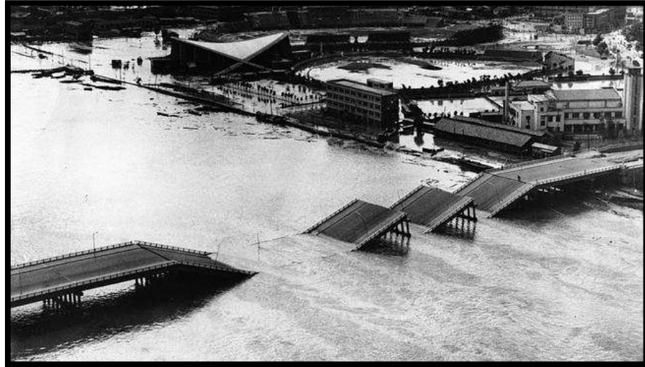
Figura 6 Colapso en puente Showa a causa de licuefacción (Sismo de Niigata 1964)
