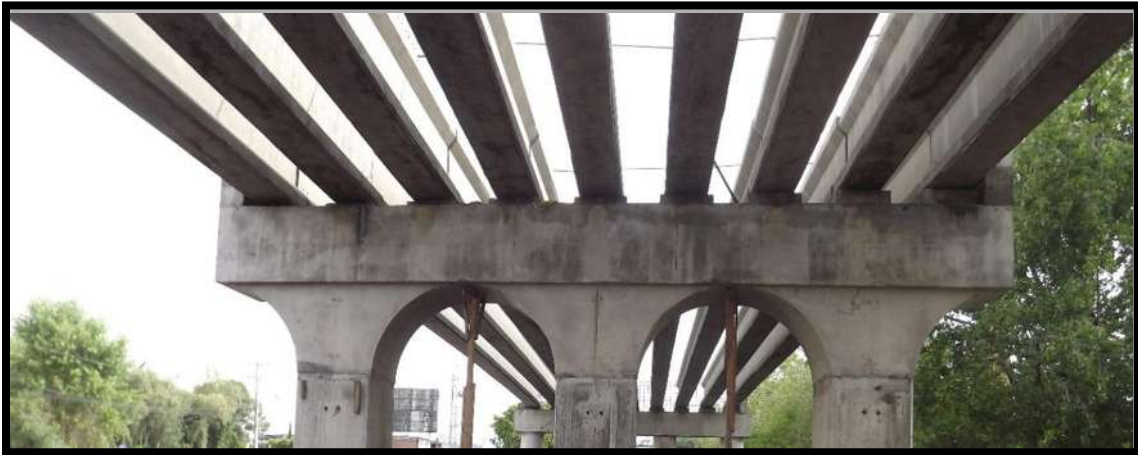
Figura 43 Las vigas descansan sobre apoyos de neopreno los cuales a su vez están sobre el cabezal
