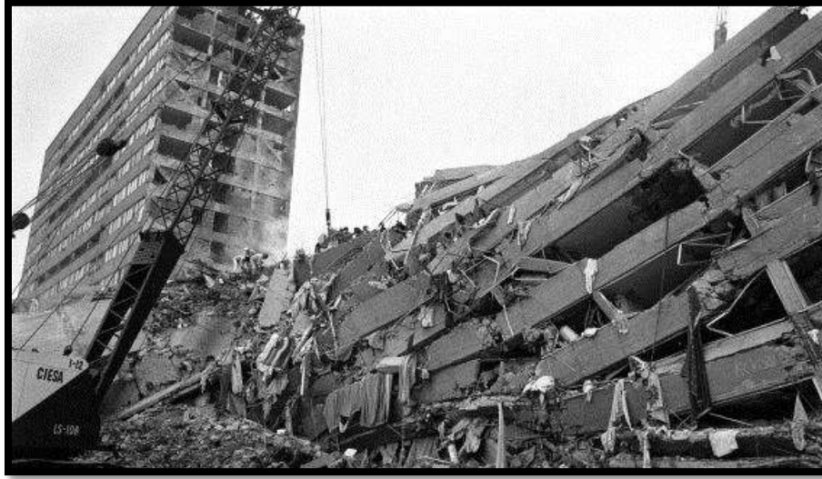
Figura 3 Daños en estructuras causados por el sismo del 19 de septiembre de 1985 en CDMX
