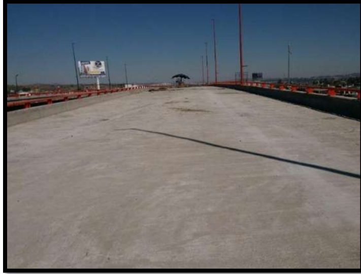
Figura 47 Tablero o losa del puente de estudio
