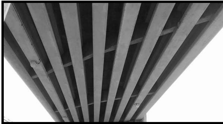
Figura 44 Visualización del muro diafragma que une a las vigas
