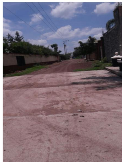
Figura 4.7 Calle sin pavimentar cerca de la secundaria.
