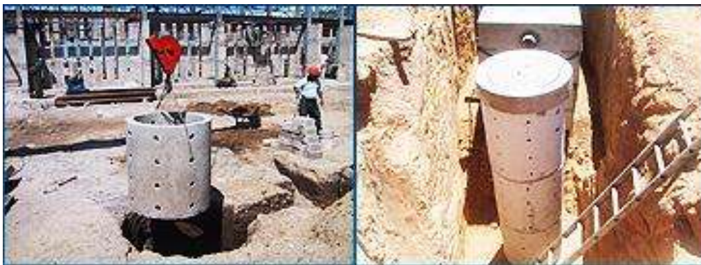
FIGURA 5.13 COLOCACIÓN DEL POZO DE ABSORCIÓN MARCA GUXVAL-BIO
