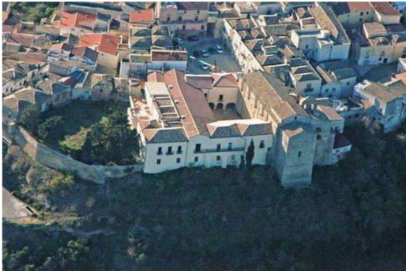
Figura 7. Vista aérea de la Iglesia del monasterio Franciscano.
