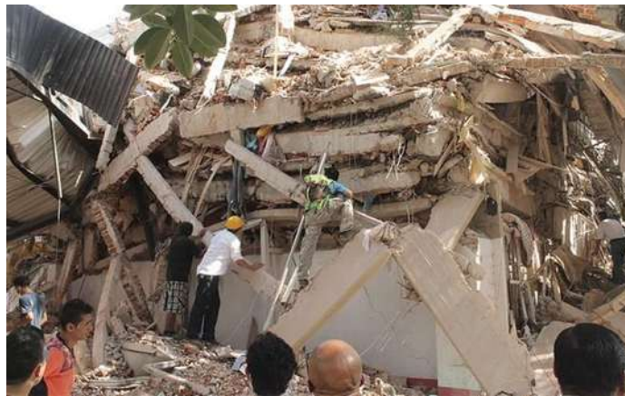
Figura 2. Escombros dejados por los derrumbes de los edificios. Terremoto del 19 de septiembre de 2017, México. (Foto: Omar Flores, El Sol de México).
