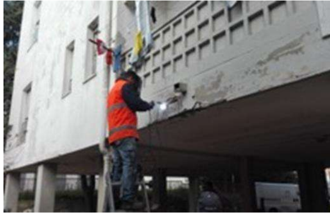
Figura 22. Extracción de acero (Corso Di Vittorio No. 23).
