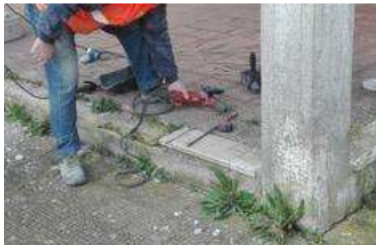
Figura 30. Barra de armadura extraída para la prueba de tensión. (Curso di Vittorio No. 23)
