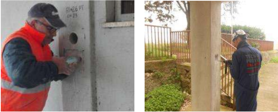
Figura 23. Prueba esclerométrica realizada en columnas (Corso di Vittorio No.23).
