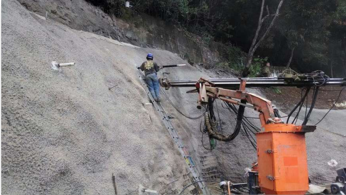
Figura 12.- Colocación de dren.
