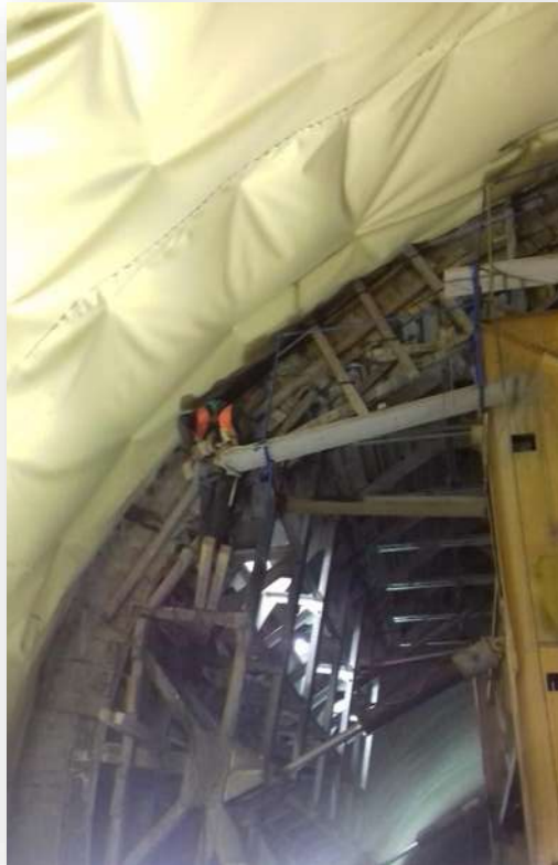
Figura 29.-Colocación de cimbra de madera en los extremos.
