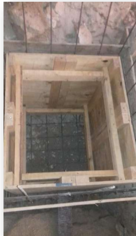
Figura 10.- Pozo de visitas interior de túnel.
