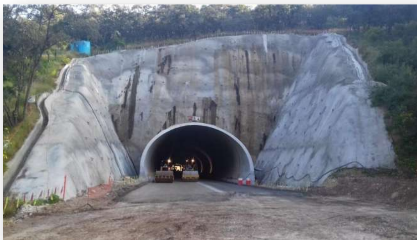
Figura 5. Compactacion con Rodillo vibratorio
