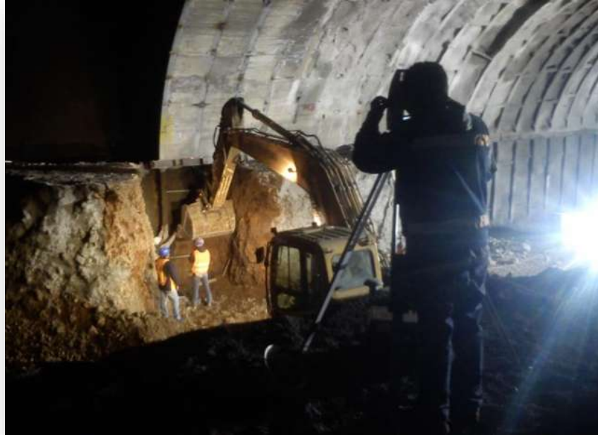
Figura 11.- Colocación de patas.
