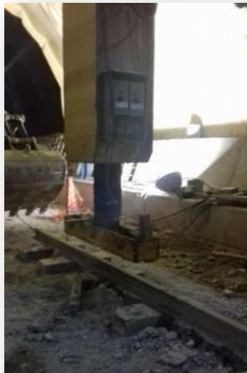
Figura 31.-Se levantan las patas hidráulicas de un extremo.
