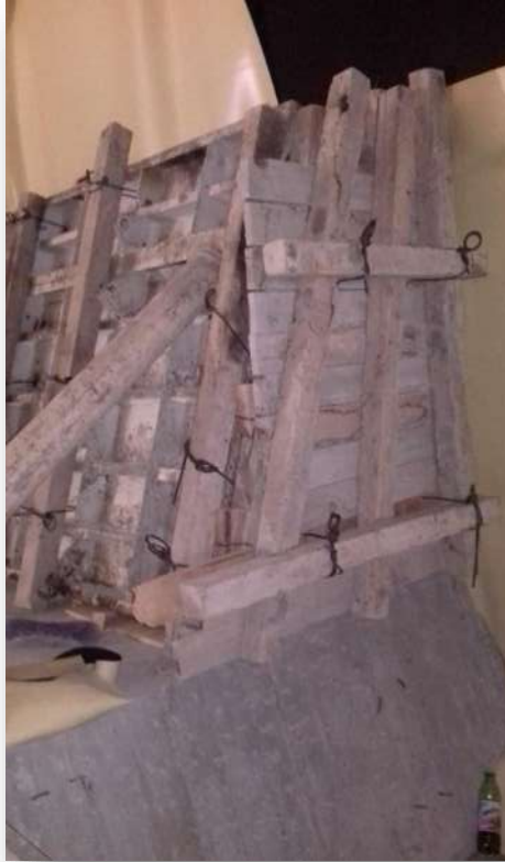
Figura 9.-Cimbrado de Guarnición con madera.
