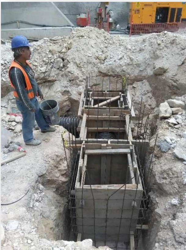
Figura 9.-Caja de captación y Pozo de visitas.
