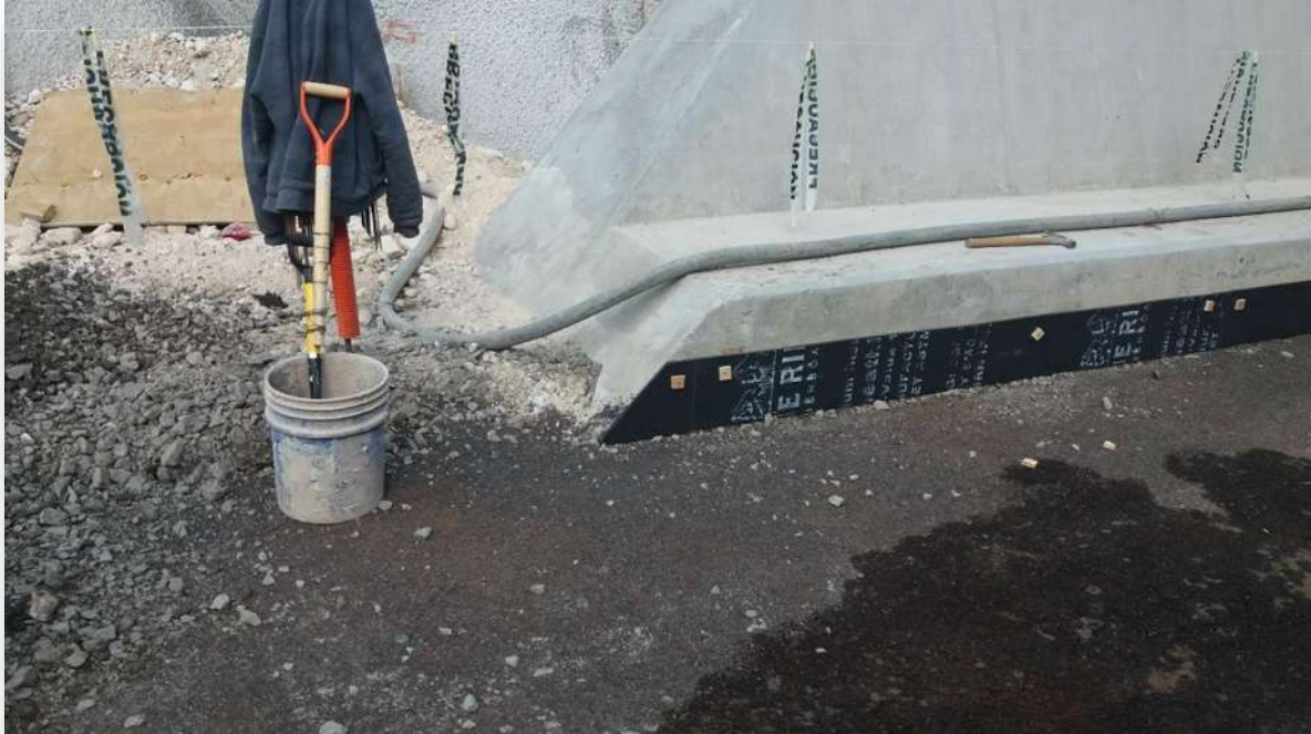
Figura 17.- Junta de aislamiento con Celotex.
