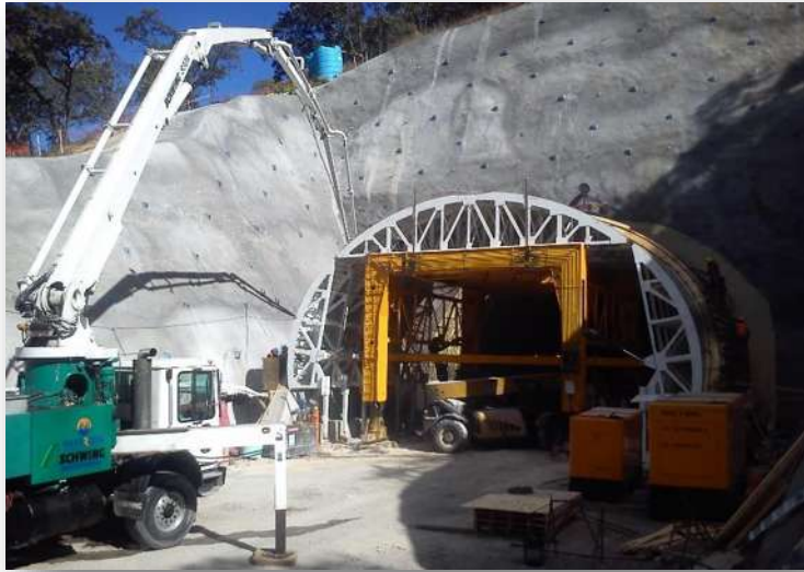
Figura 18. Colocación de bomba estacionaria.
