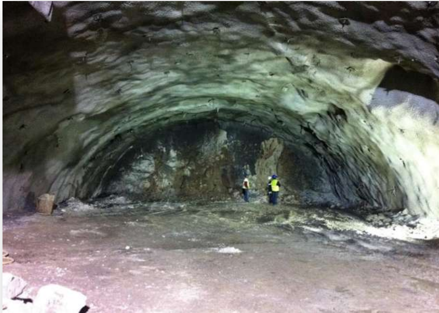
Figura 48.- Excavación de la media sección superior derecha
