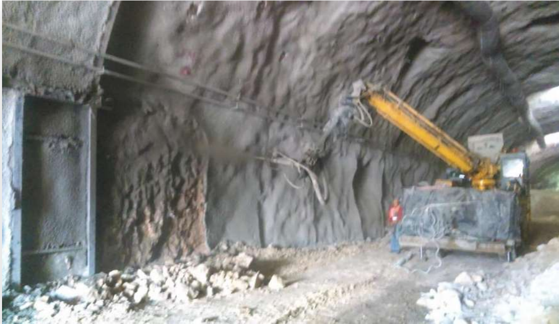
Figura 56.- Concreto lanzado con bomba de lanzado.
