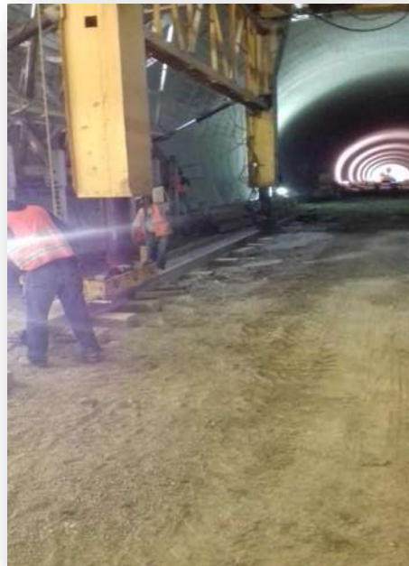
Figura 33.-Bajado de patas hidráulicas y acarreo de durmientes.
