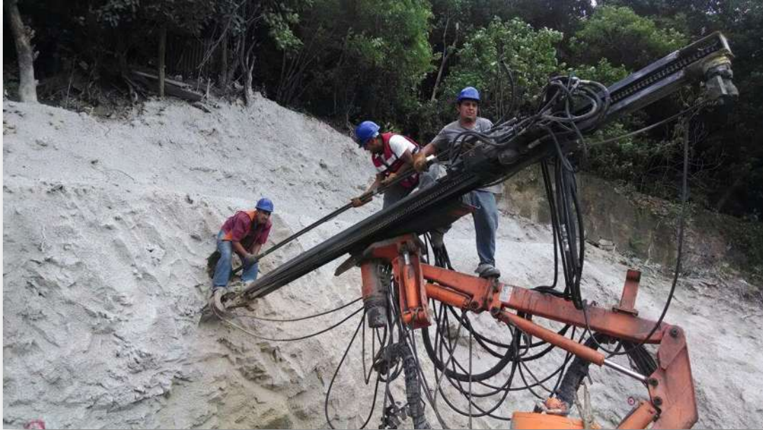
Figura.-10 Colocación de anclas de fricción.
