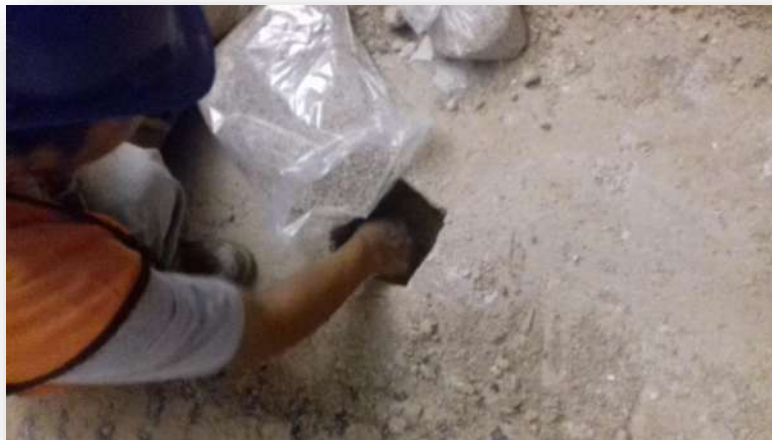
Figura 6.- Prueba de compactación.
