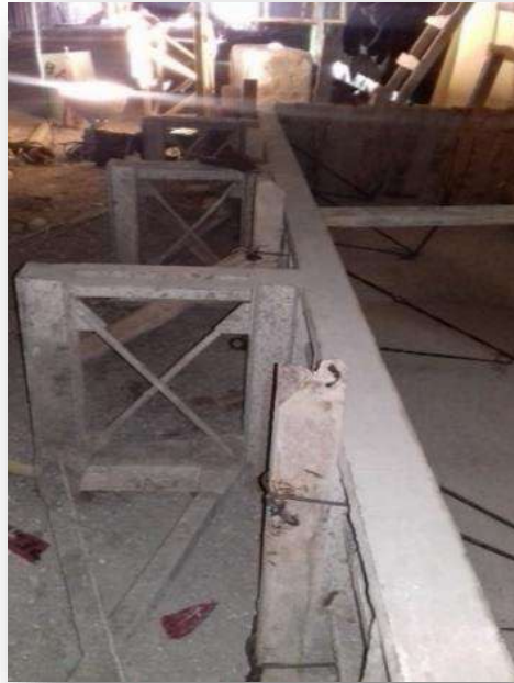
Figura 4. Cimbra de zona 1
