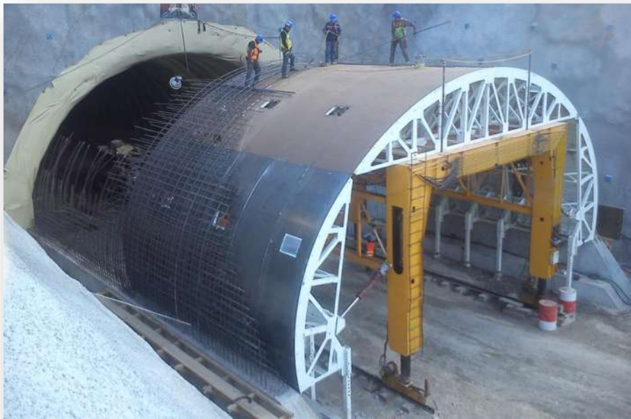
Figura 14.- Cimbra metálica nivelada para el armado.
