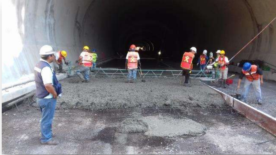
Figura 14.- Colado con Regla vibratoria sobre Guías y Montenes.
