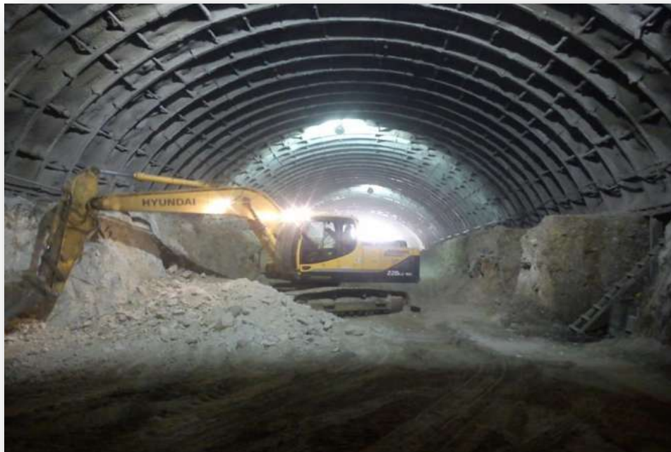
Figura 10.- Excavación de núcleos laterales
