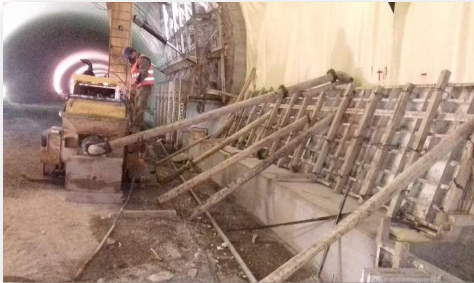
Figura 10.-Colocación de puntales y tubo de desfogue de concreto del compresor.
