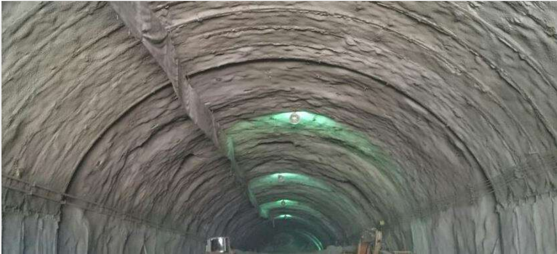
Figura 6.- Rellenado completo de concreto lanzado media Sección Superior.
