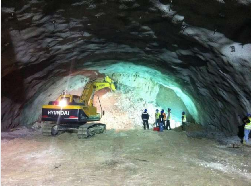
Figura 46.- Excavación de la media sección superior derecha.
