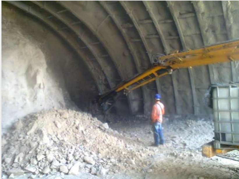
Figura 4.- Amacice de roca y colocación de capa de 5 cm de concreto lanzado y excavación completa en media sección superior.
