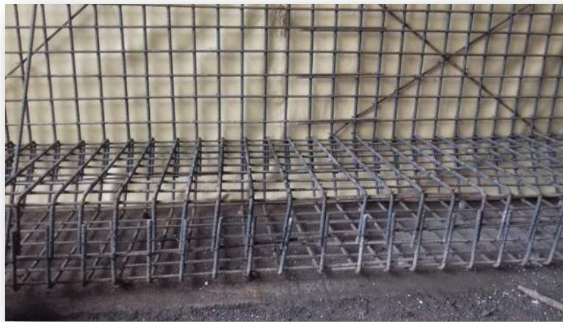
Figura 3.- Armado de acero en zona 1.
