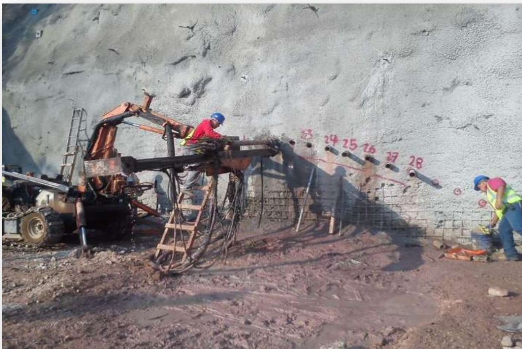
Figura 3.- Colocación de tubo de enfilaje.
