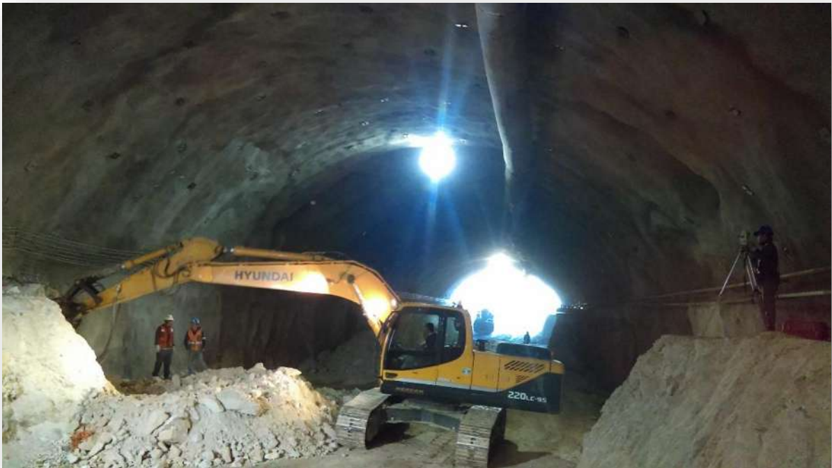
Figura 49.- Excavación del núcleo izquierdo en el banqueo.
