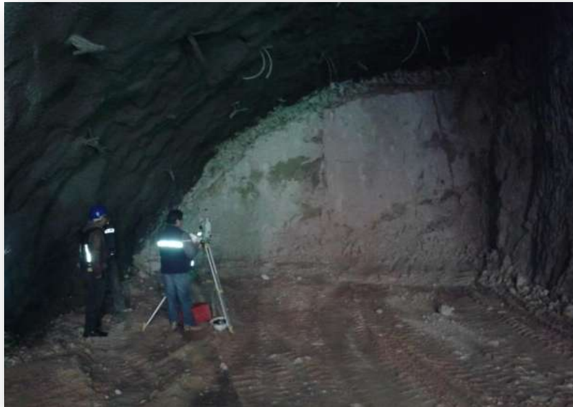
Figura 43.- Excavación de la media sección superior izquierda y lanzamiento de concreto.
