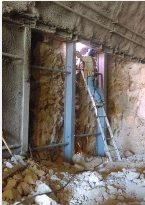
Figura 37.- Colocación de concreto y soldado de patas metálicas.
