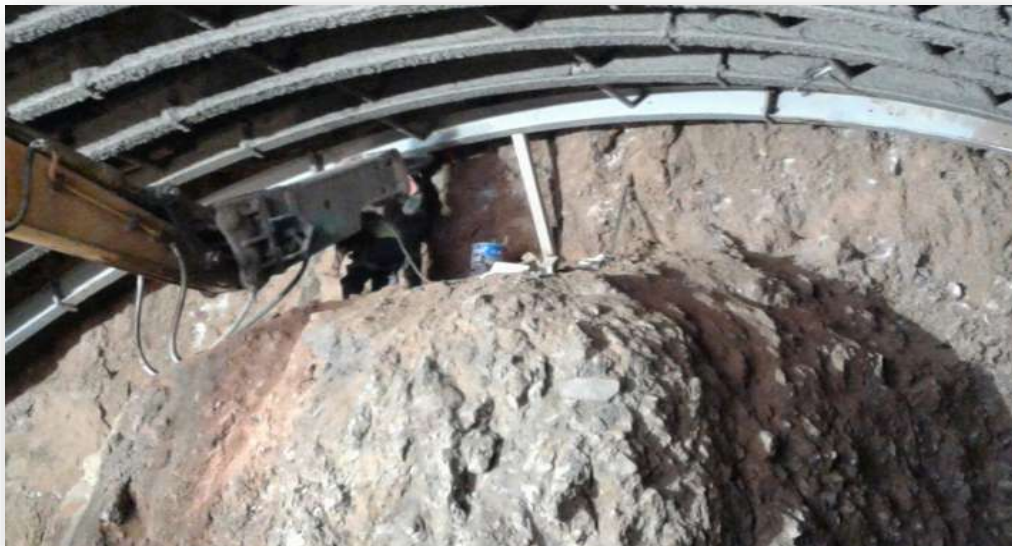
Figura 18.- Excavación y amacice de terreno. Fuente (Proyecto Ejecutivo).
