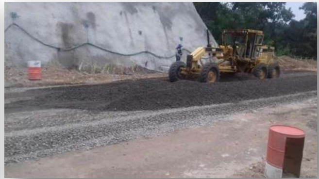
Figura 4.- Tendido de Base con Motoconformadora
