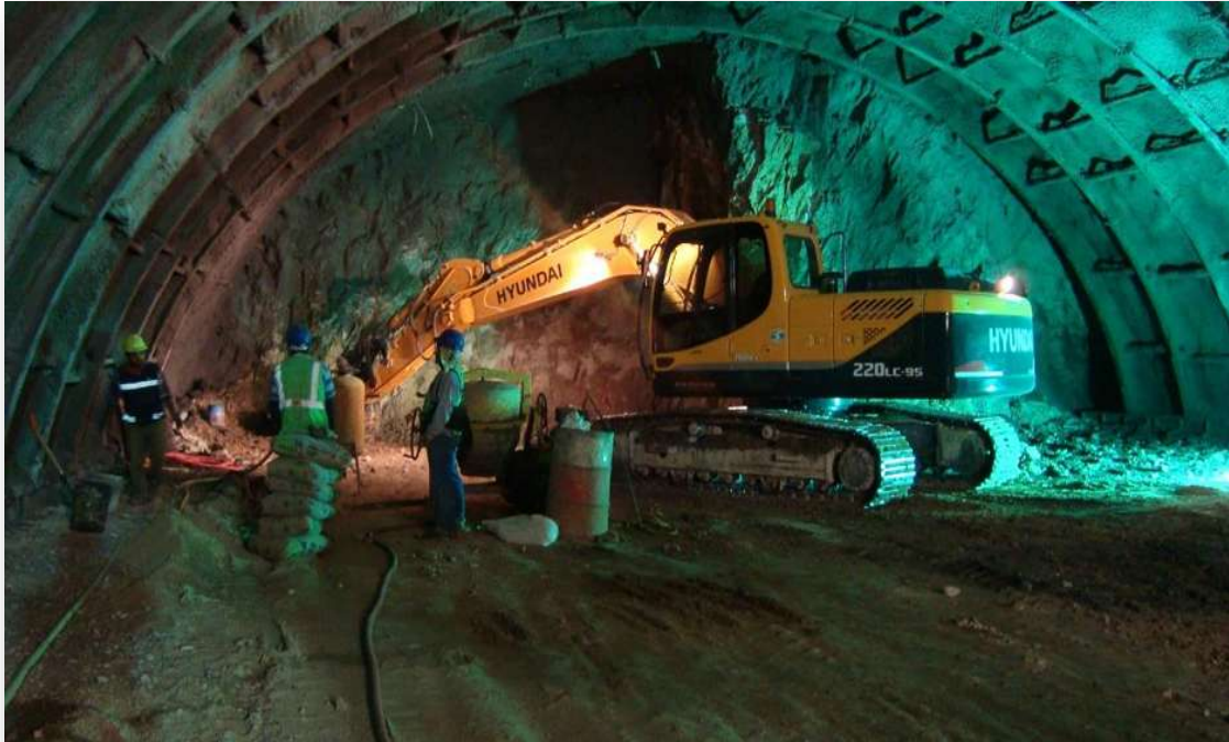
Figura 32.- Excavación media sección superior izquierda.
