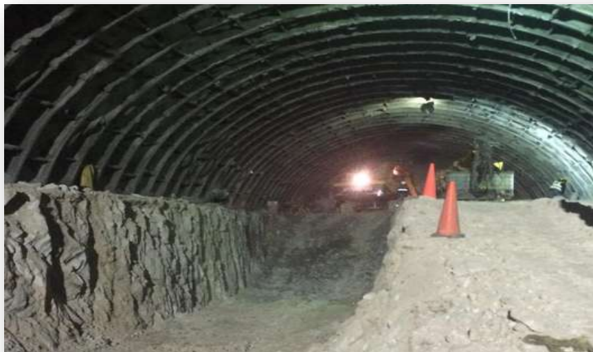
Figura 36.- Excavación núcleo izquierdo en banqueo.
