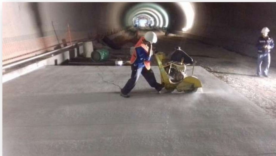
Figura 15.- Corte Transversal de Pavimento Hidráulico.
