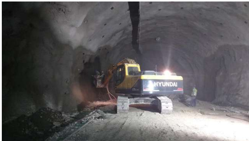
Figura 59.- Excavación de banqueo terminada y aplicación manual de concreto lanzado.
