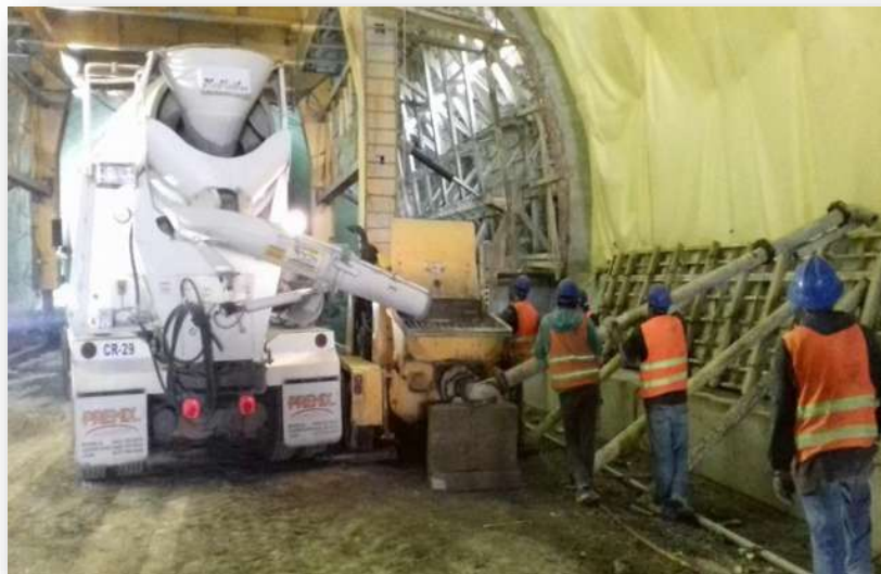
Figura 11.-Vertido de concreto en tolva para después colocarlo en guarnición.
