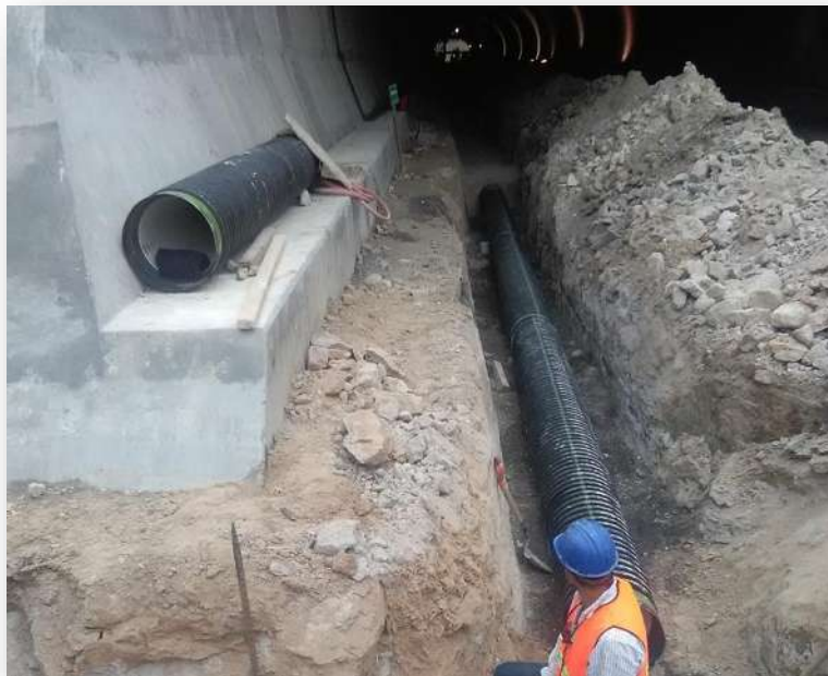
Figura 4.- Colocación de tubería de polietileno de 10 pulgadas
