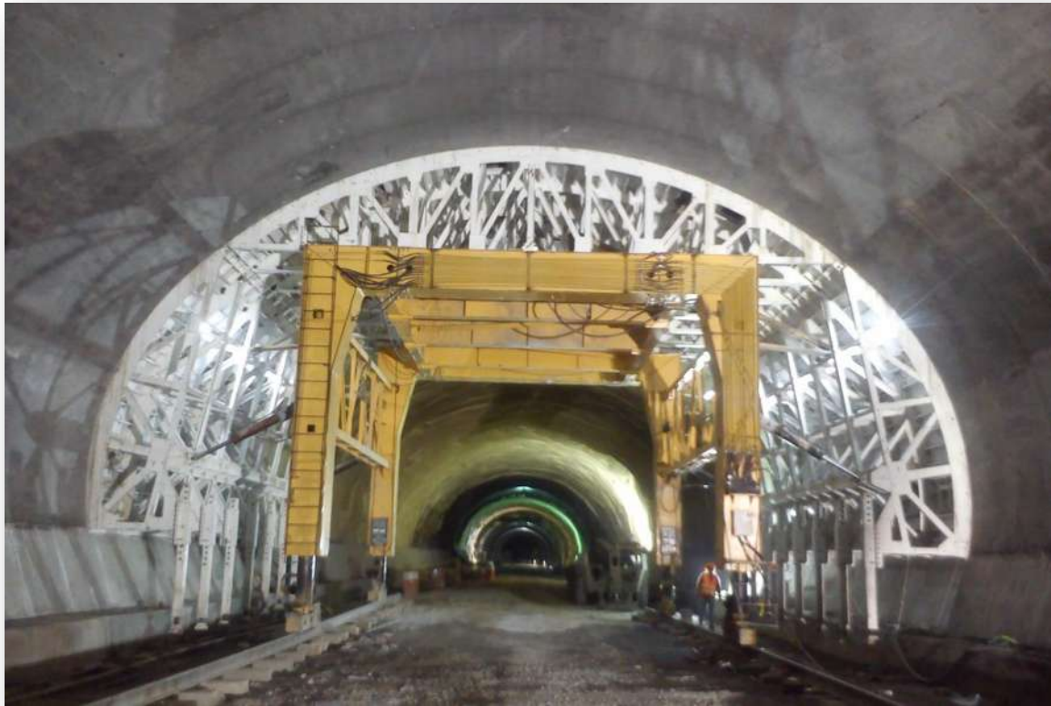
Figura 23.- Cimbra metálica nivelada.
