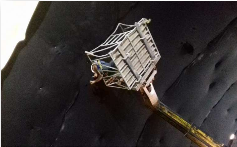
Figura 19.- .Colocación y restirado de Geotextil.
