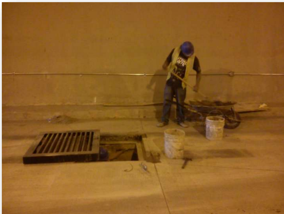
Figura 14.-colocación de tapa de Pozo de visitas.
