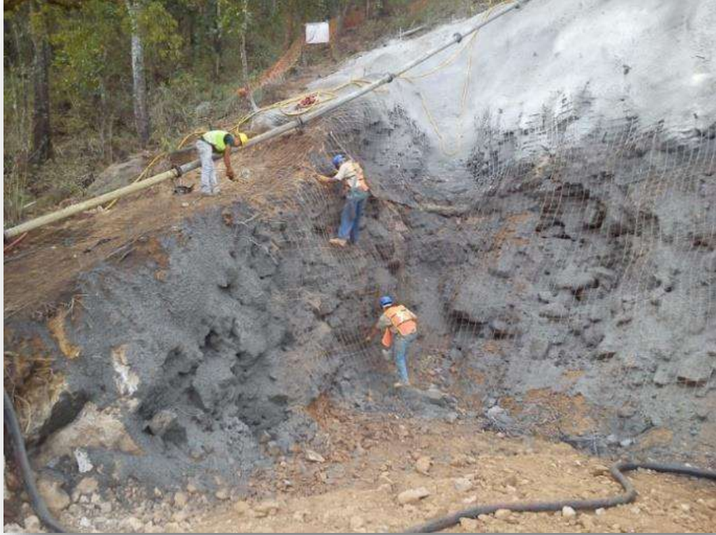
Figura 6.- Tendido y colocación de malla electrosoldada.
