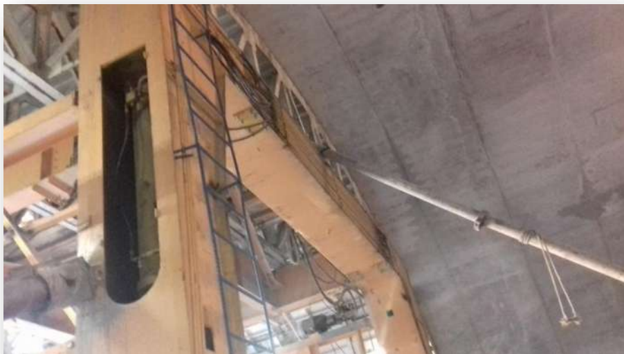
Figura 26.- Colocación de tubería.
