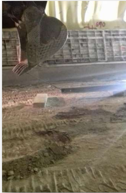
Figura 32.-Jalado de riel con bote de excavadora.
