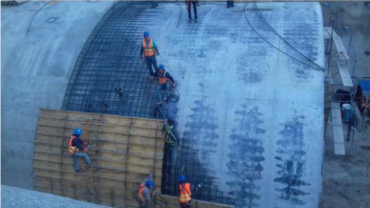
Figura 16.- Colocación de Contra Cimbra.
