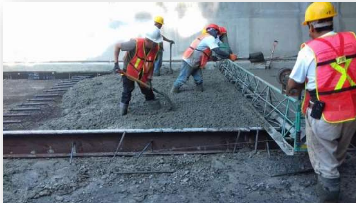
Figura 13.- Colocación de Pasajunta.
