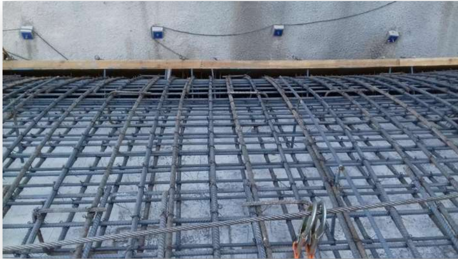
Figura 15.- Armado de acero en túnel falso,
