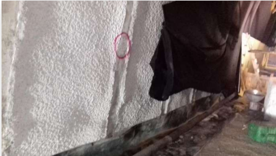
Figura 21. - colocación de subdrenes laterales de 4 pulgadas.
