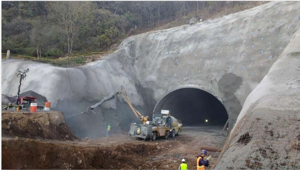
Figura 8.- Concreto lanzado aplicado con Cifa.
