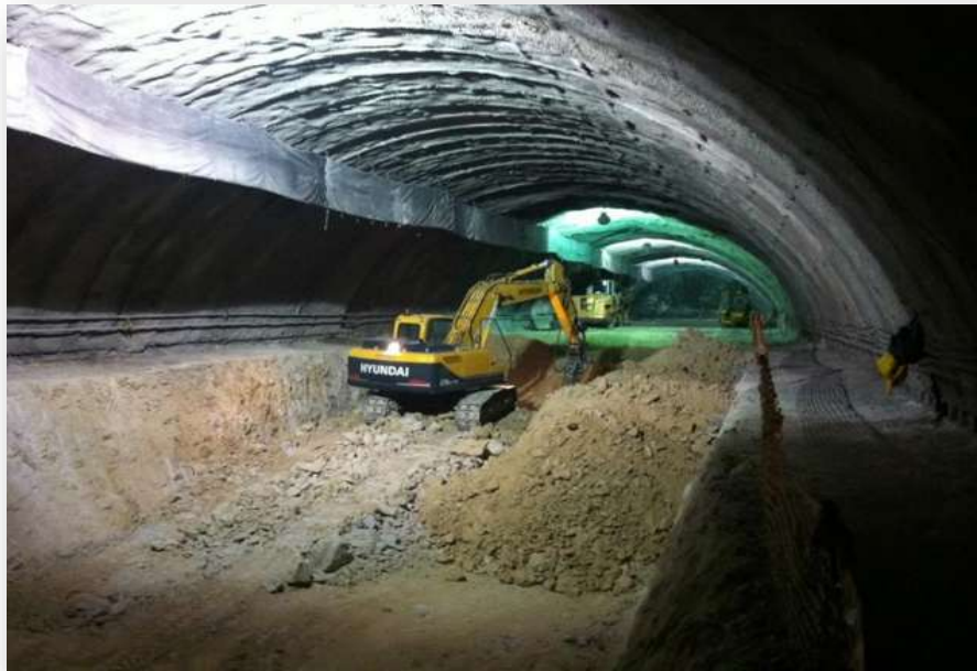
Figura 25.- Excavación Núcleo central, Banqueo. Fuente (Proyecto Ejecutivo).
