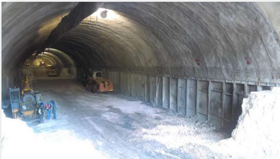
Figura 40.- Condición geotécnica D+ completamente terminada.
