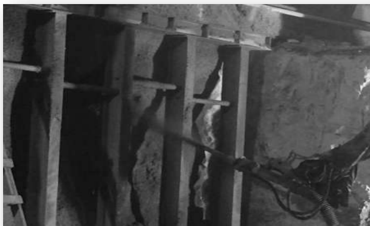
Figura 12.- Lanzado de concreto en patas.
