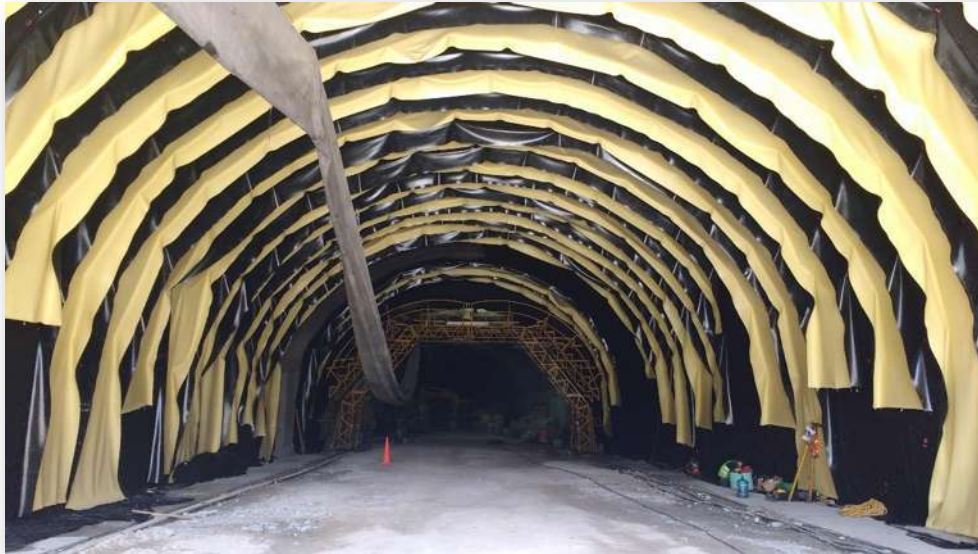
Figura 23.- Colocación de geomembrana a las arandelas
