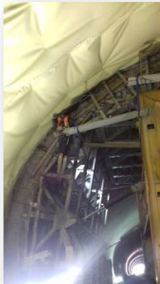
Figura 24.- Cimbrado de tapón con madera en bóveda.
