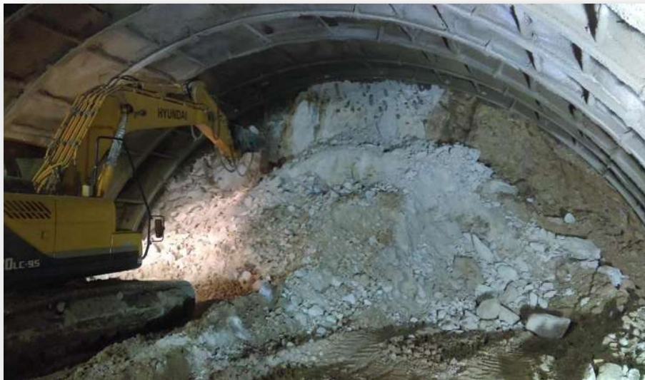
Figura 20.-Excavacion núcleo central media sección superior.
