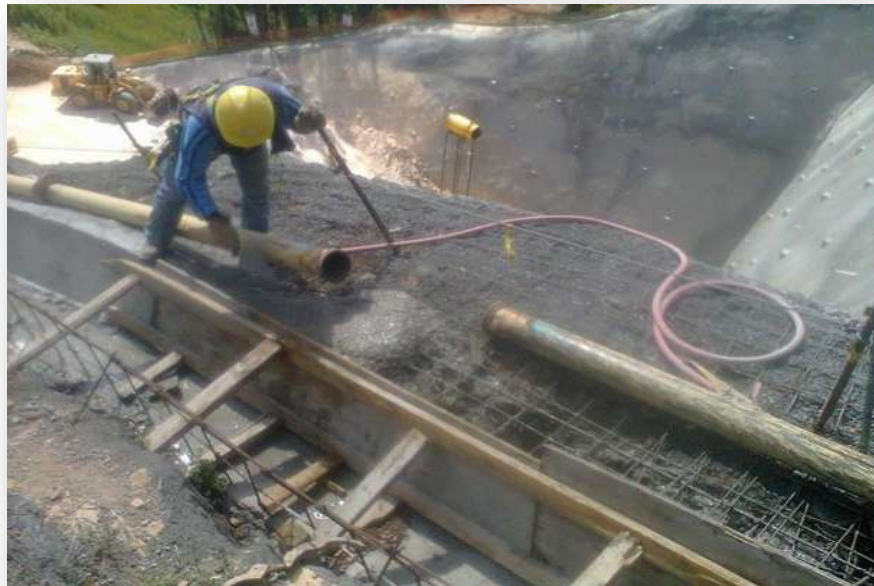
Figura 16.- Armado, cimbra y colado de Contracuneta.
