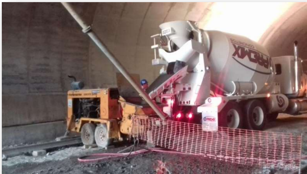
Figura 27.- Vertido de concreto en tolva.
