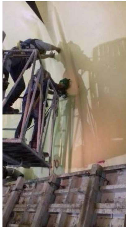
Figura 25.- Uniendo membrana con la Comet
