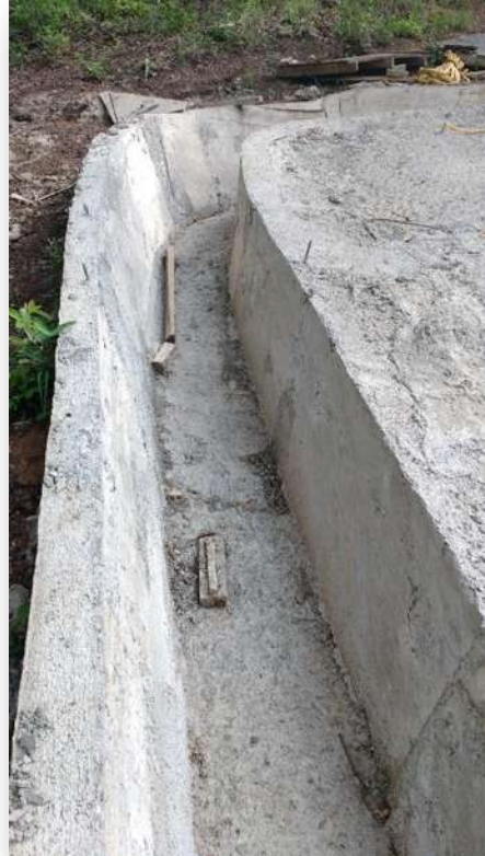
Figura 15.- Contracuneta Terminada.
