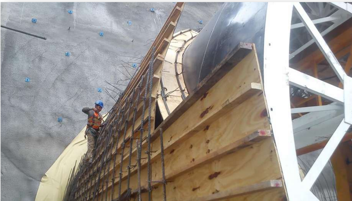
Figura 17.- Cimbrado con madera en bóveda.
