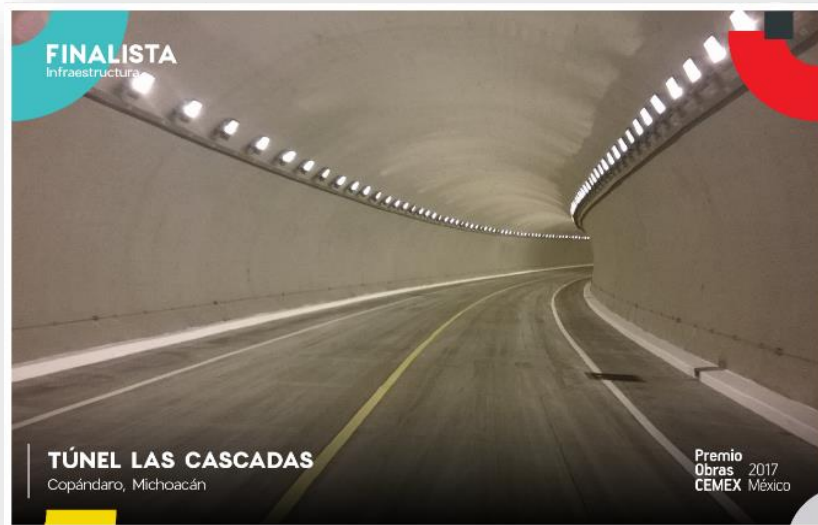
Imagen.6.- Túnel Las Cascadas. Fuente (Cemex México 2017).
