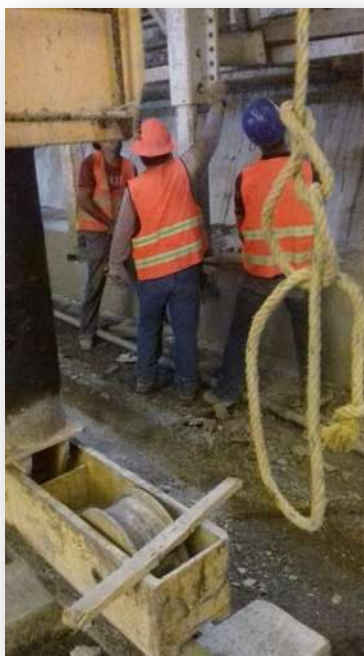
Figura 22.-Bajado de patas metálicas.
