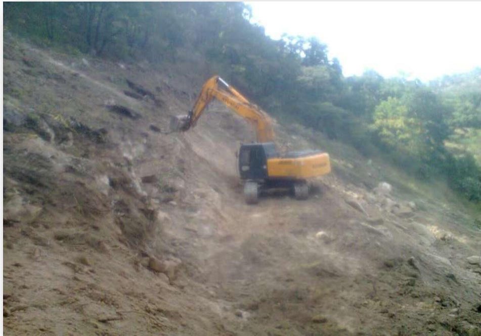
Figura 5.- Inicio de taludes de corte.
