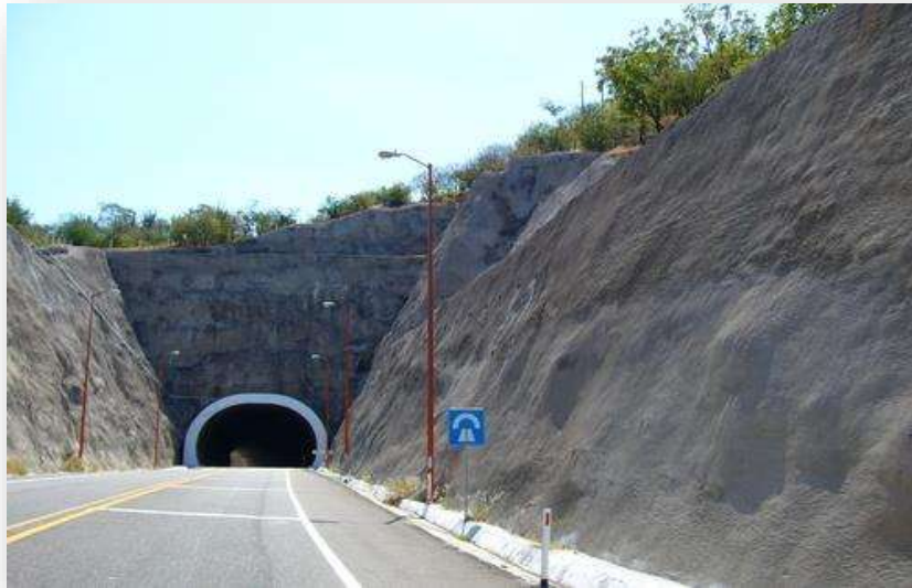
Imagen. 5.- Túnel el Tigre. Fuente ( www.panoramio.com/photo/21494663 )
