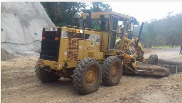
Figura 1.- Nivelación de Subrasante.
