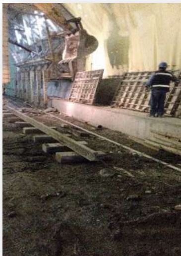
Figura 7. Colocación de tablonces de acero.
