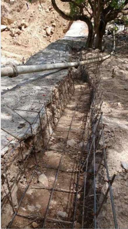
Figura 14.- Armado de Contracuneta
