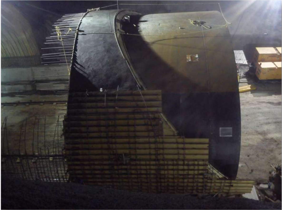
Figura 21.- Colado de bóveda en túnel falso.
