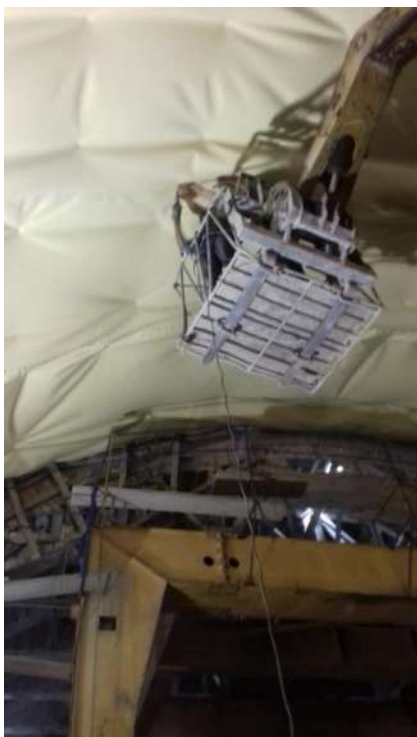
Figura 24.- Sellando lienzos por termofusión.
