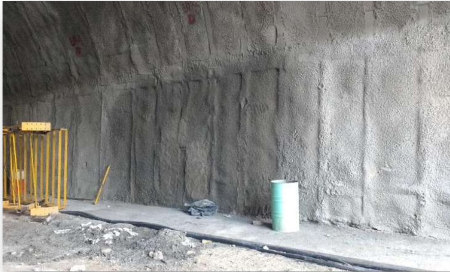
Figura 13.- Relleno completo de concreto lanzado en marcos y patas metálicas..
