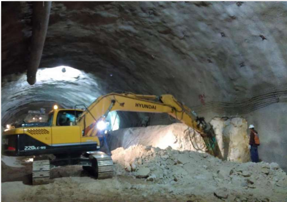
Figura 51.- Excavación del núcleo derecho en el banqueo.
