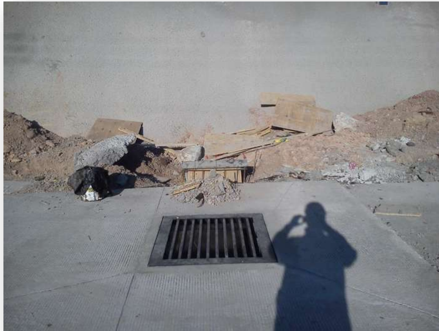
Figura 13.-colocación de tapa de Caja de captación.
