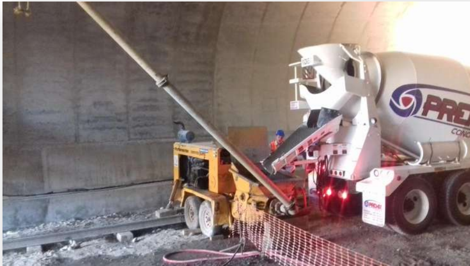
Figura 25. Colocación de compresor y tolva.
