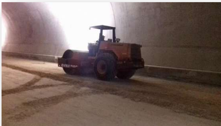
Figura 2.- Compactación de subrasante rodillo vibratorio
