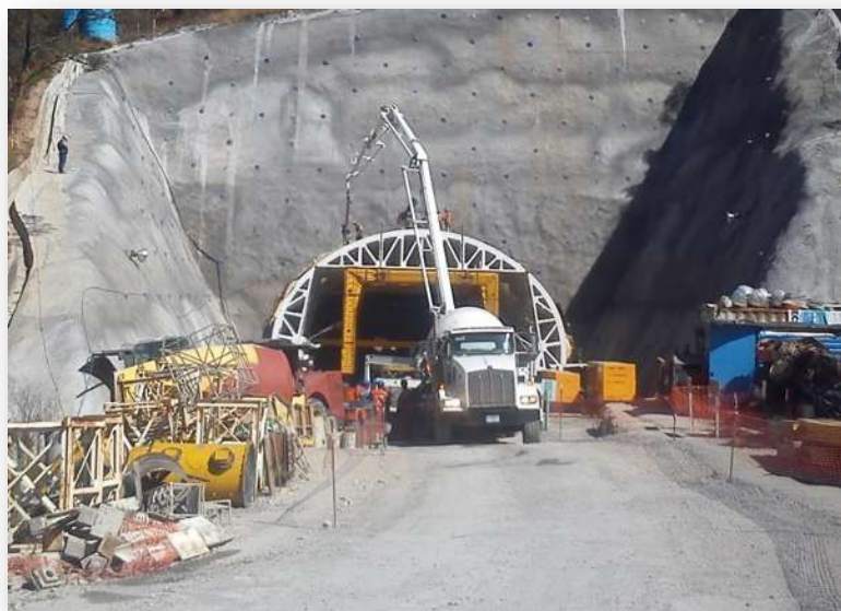
Figura 19.- vertido de concreto con olla de 14 m 3 .
