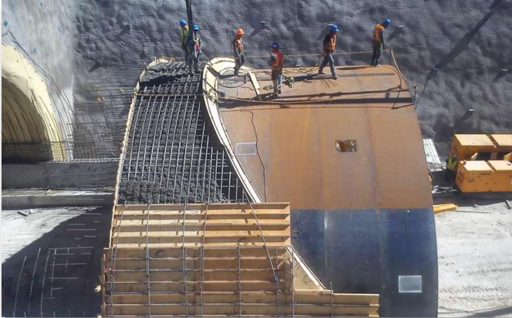
Figura 20.- Vertido de concreto en tolva.
