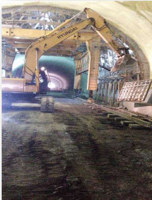
Figura 30.-Riel montado en los durmientes.
