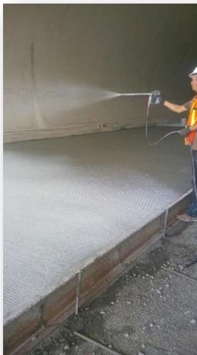
Figura 18.- Membrana de curado en Pavimento Hidráulico.
