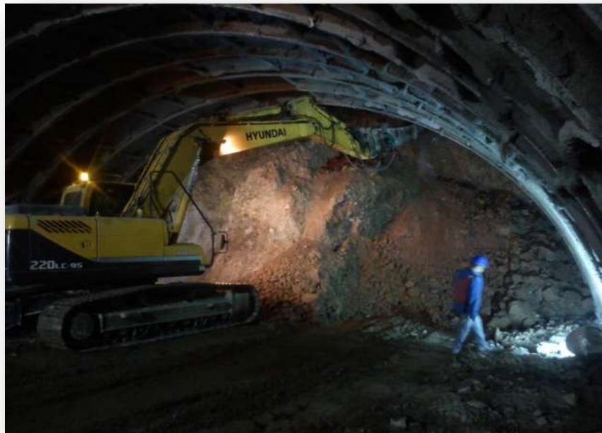
Figura 34.- Excavación media sección superior derecha y estabilización.
