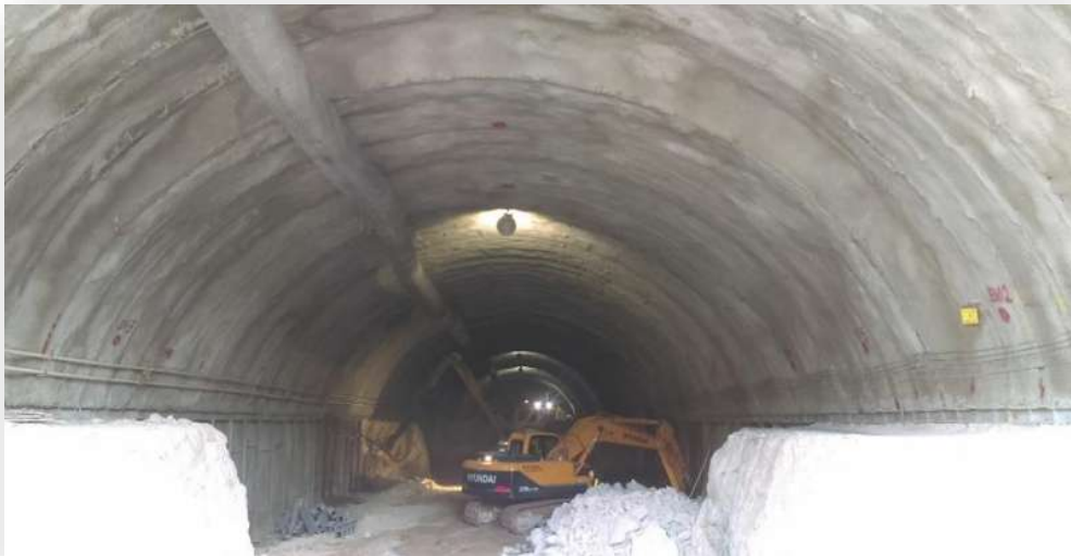
Figura 23.-Media sección superior terminada.
