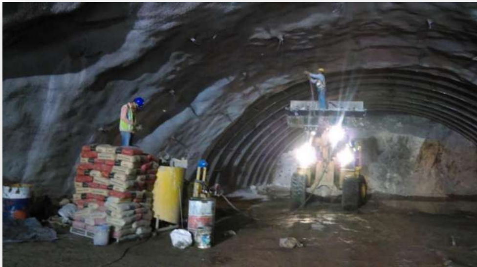
Figura 47- Inyección de anclas de fricción con Hany.
