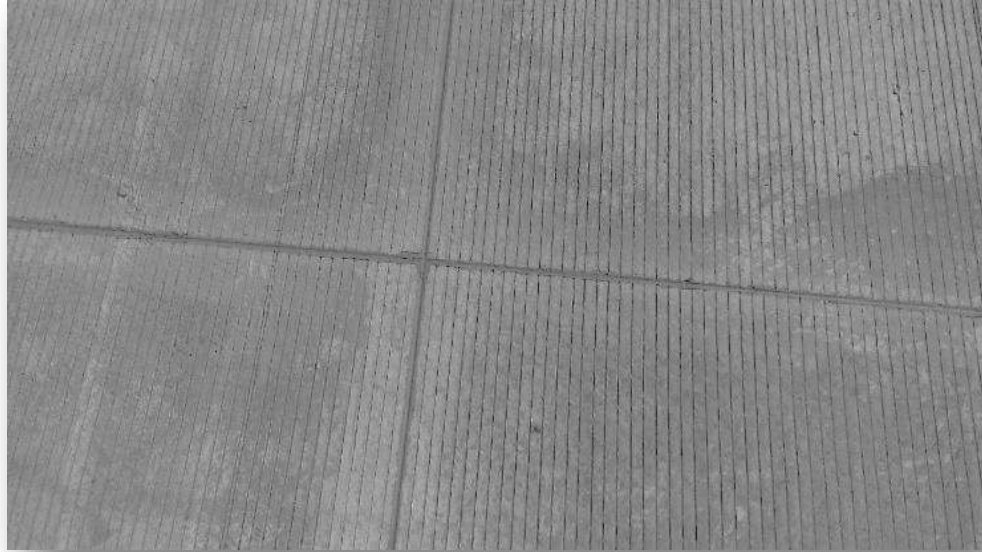
Figura 19.- Roquet rol y Pavimento Hidráulico Terminado
