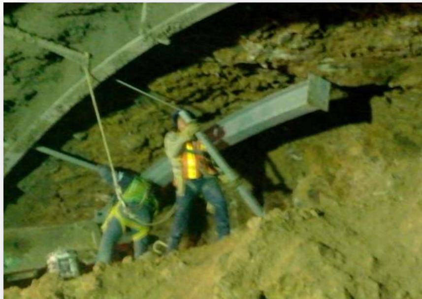
Figura 22.-Colocación de tubos separadores y tensores en marcos.
