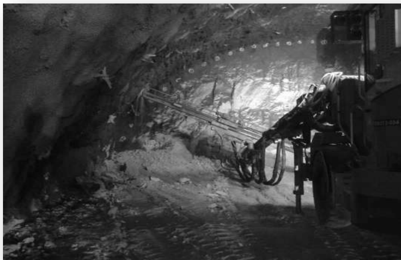
Figura 44.- Excavación de la media sección superior izquierda
