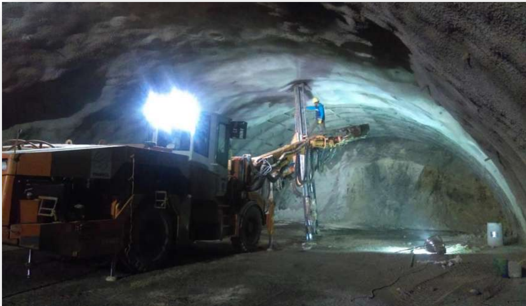
Figura 57.- Colocación de anclas de fricción.
