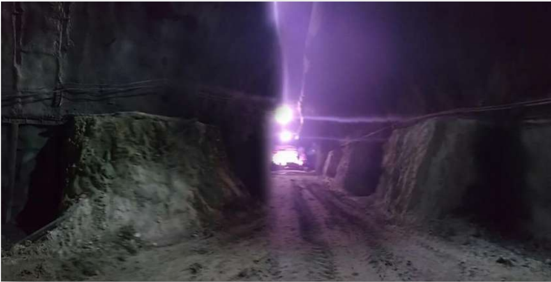
Figura 27.- Excavación de núcleos laterales Media Sección Inferior (banqueo).
