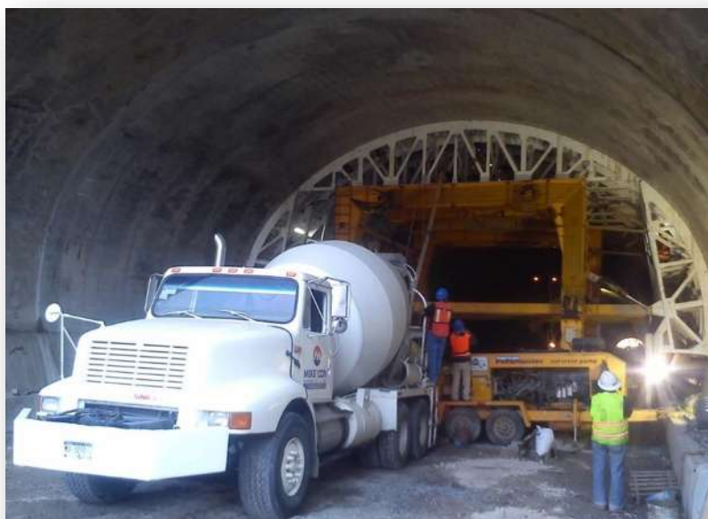
Figura 28.- Colado de bóveda por boquillas.
