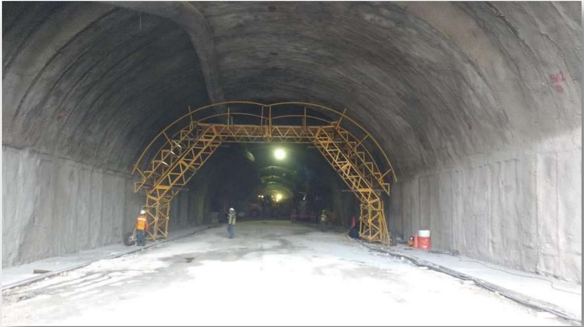
Figura 15.- Condición geotécnica E completamente terminada.
