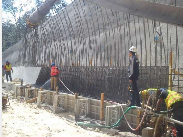
Figura 6.- Armado de guarnición.
