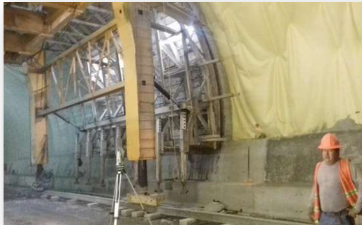
Figura 35.-Cabo verificando el cerrado de concha en cimbra metálica.
