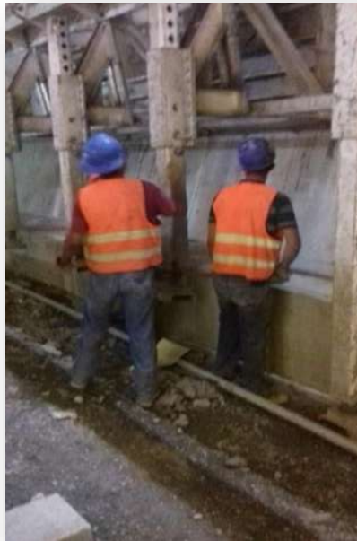
Figura 13.-Bajado de patas metálicas.
