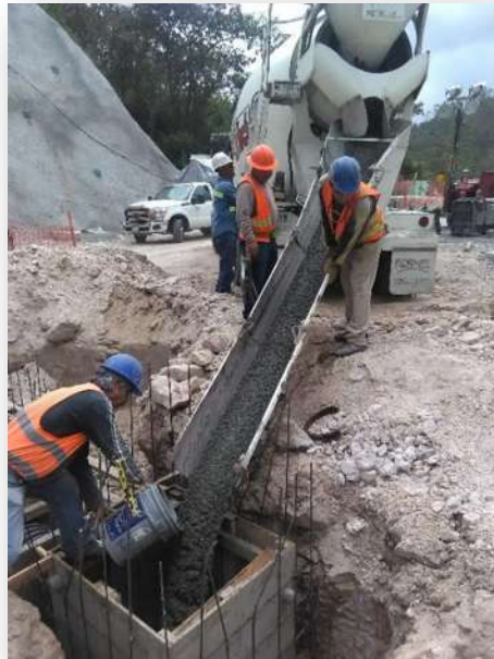
Figura 11.- Colado de caja de captación
