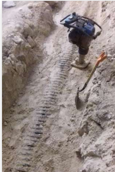
Figura 5.- Compactación por capas.
