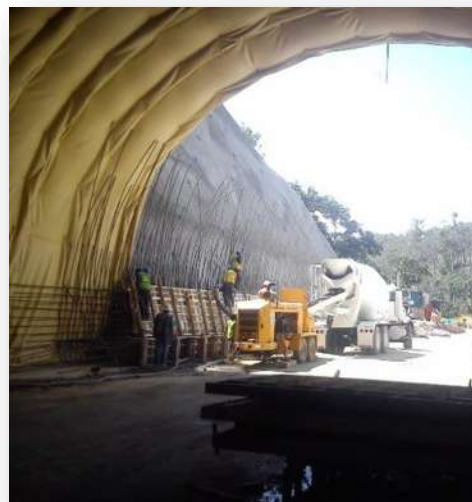
Figura 8.- Cimbra con tablonces en túnel falso.
