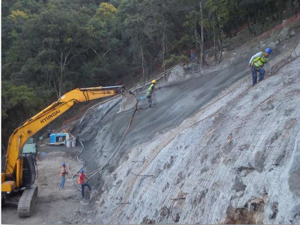
Figura 7.- Concreto lanzado aplicado manualmente.
