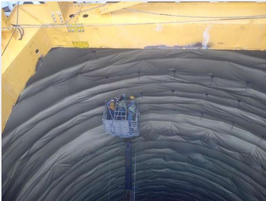
Figura 22.- colocación de arandelas.
