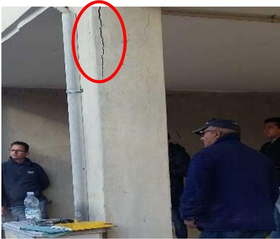
*Fig. 14 Muestra de Fisuras en la columna de la edificación (Caraza, 2017)*
