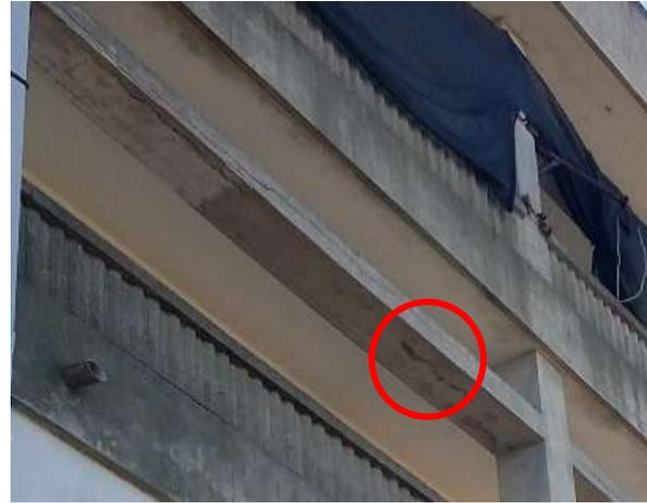
*Fig. 13 Muestra de Fisuras en la viga (Balcón) de la edificación (Caraza, 2017)*
