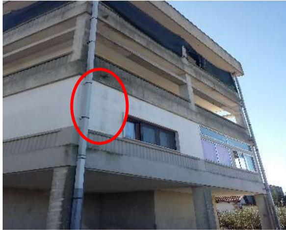
*Fig. 12 Muestra de Humedad en las paredes de la edificación
