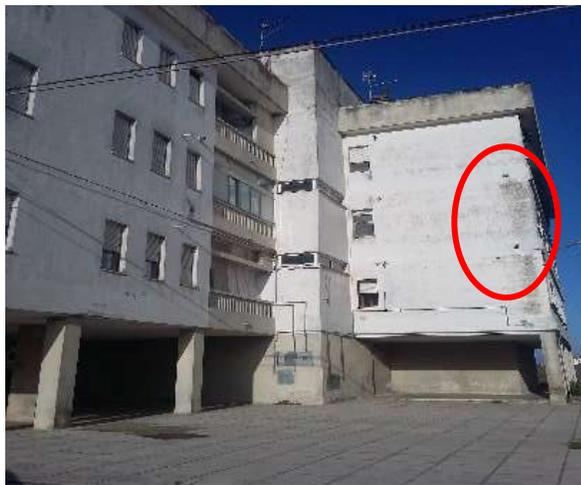
*Fig. 11 Muestra de Humedad en las paredes de la edificación
