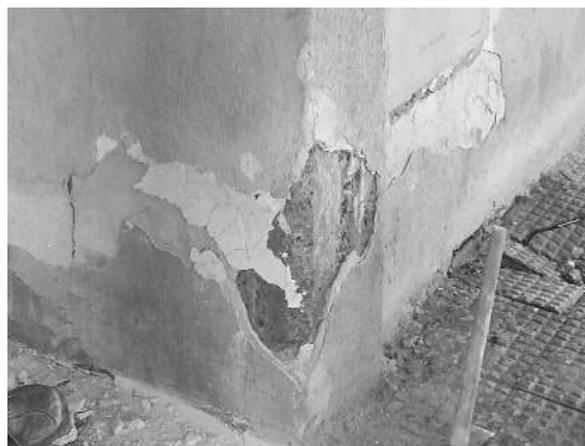
*Fig. 10 Muestra de Humedad en las paredes de la edificación
