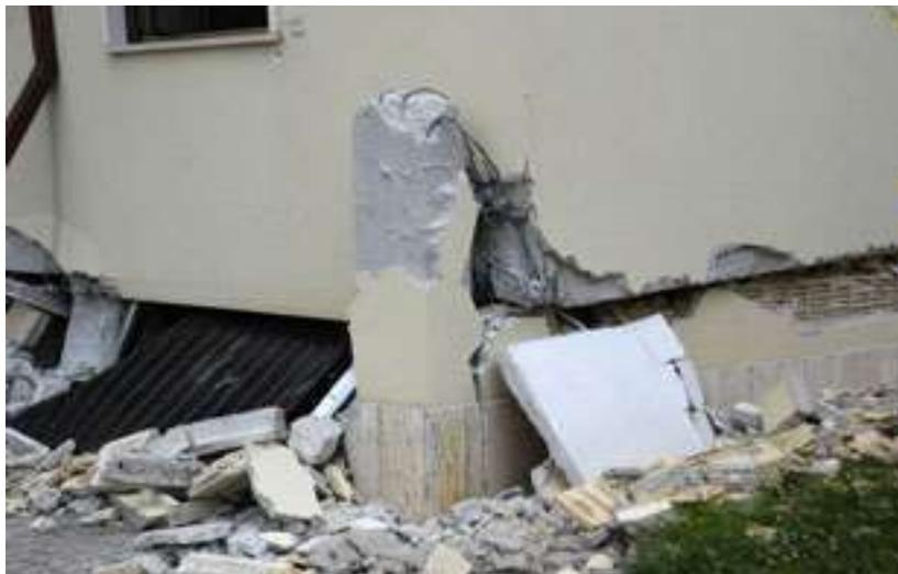
*Fig. 3 Colapso de planta baja débil (Italia, Consorzio Poroton)*
