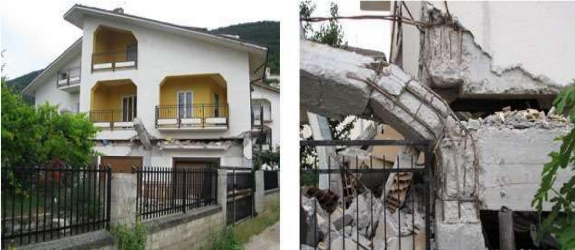
*Fig. 2 Falla en conexión vigas y columnas (Italia, Consorzio Poroton)*
