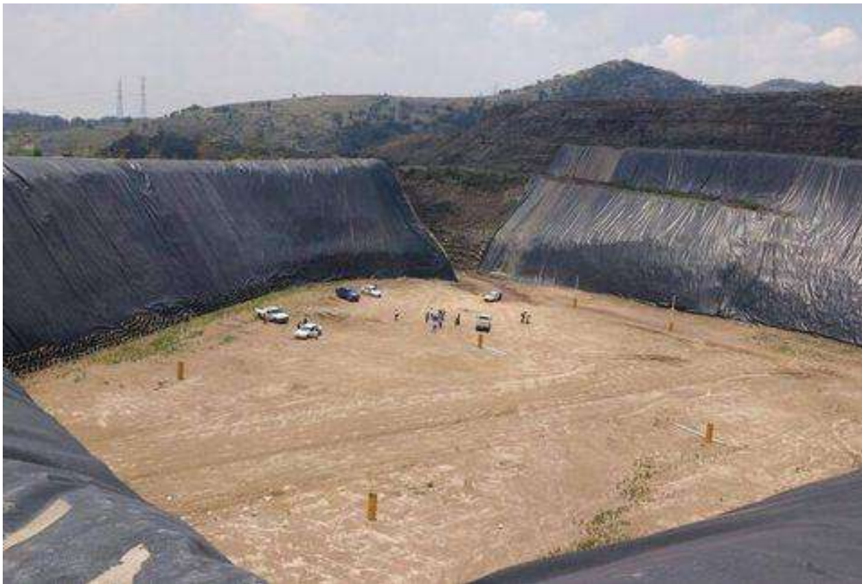
Figura 5.4. Método de zanja o trinchera, (Milenio, 2018.)
