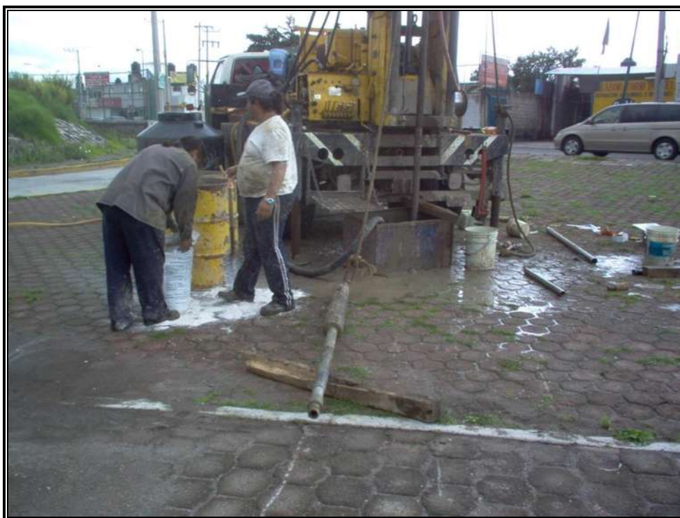
Otro aspecto de los trabajos de perforación en el sondeo No. 1.
