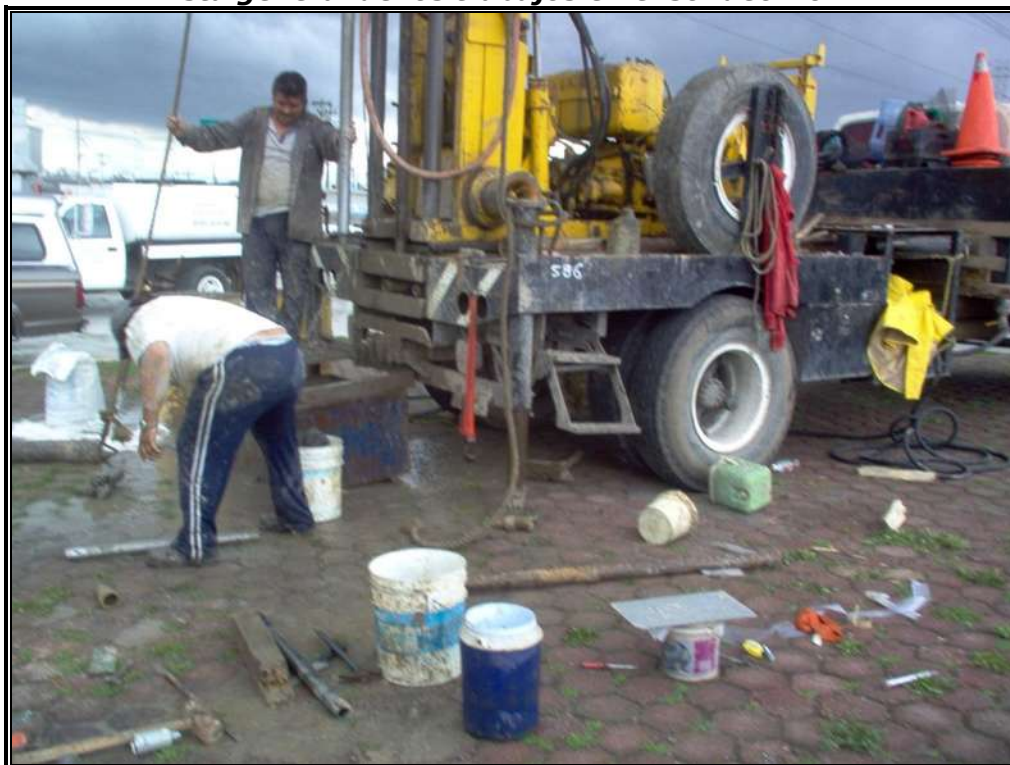
Hincado de tubo partido, durante los trabajos de exploración y muestreo del sondeo No. 1.
