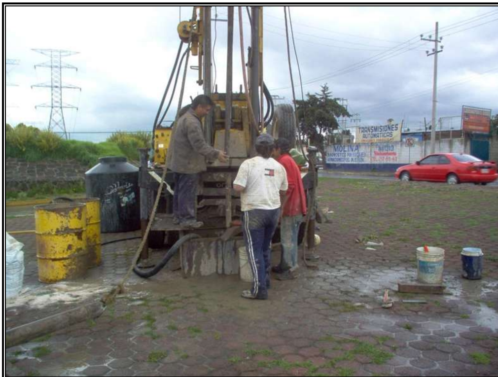
Vista general de los trabajos en el sondeo No. 1.
