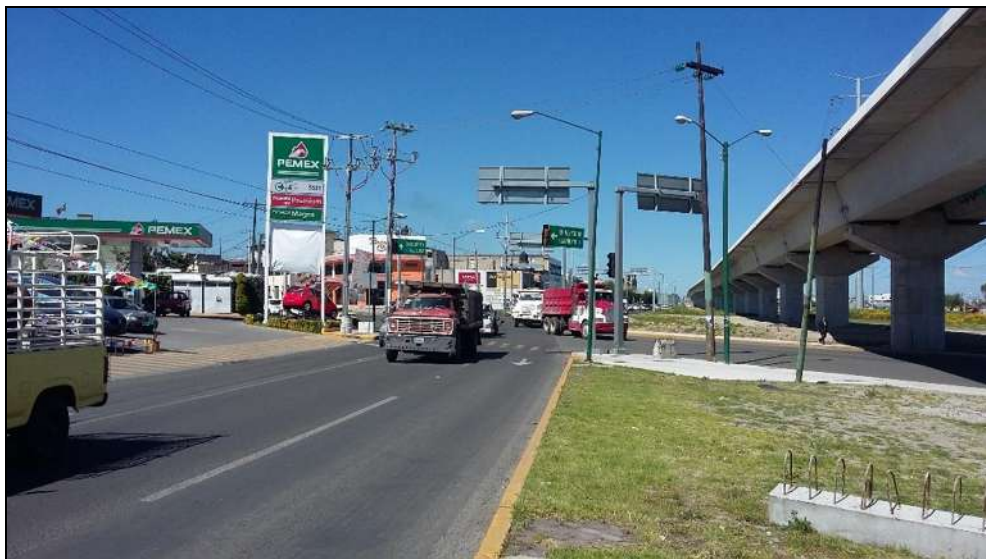
Intersección Av. Solidaridad Las Torres y Av. Gral. V. Carranza, vista este.
