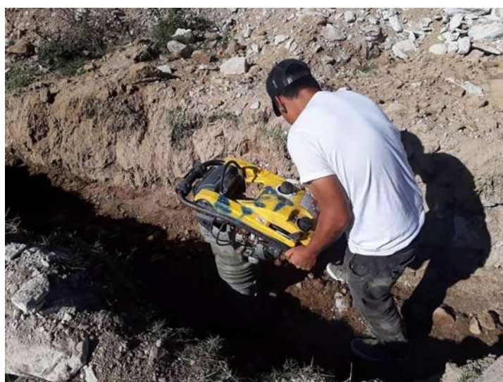
Figura 5.77. Relleno con material de banco (tepetate).
