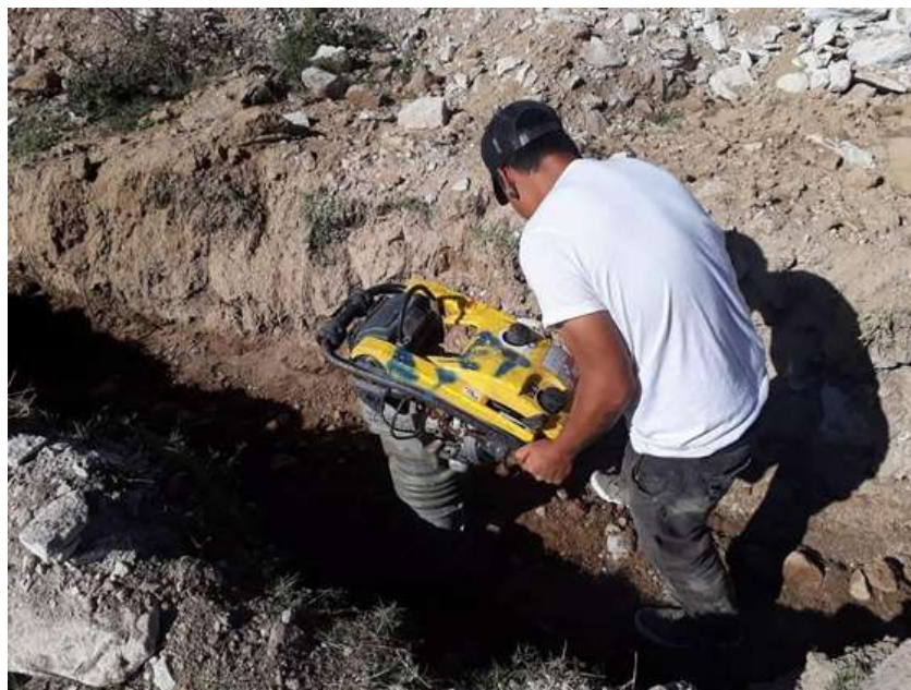
Figura 5.93. Relleno con materia de banco (tepetate) al 90% PROCTOR.
