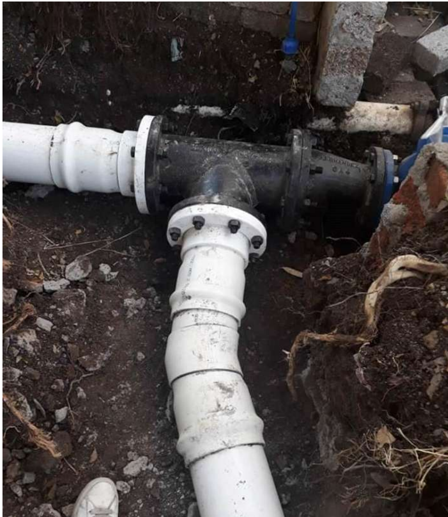
Figura 5.54. Tee bridada y reducción de 6" x 4".
