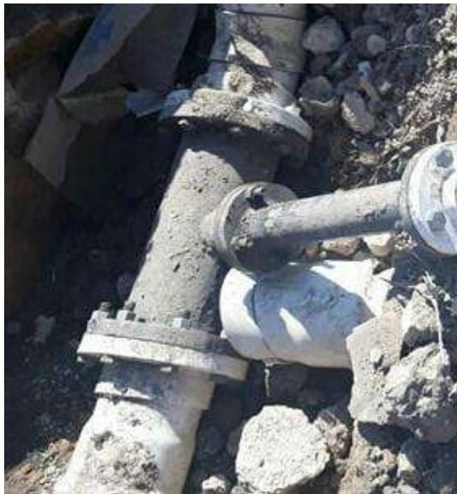
Figura 5.95. TEE de 6" x 2" de diámetro y carrete de 2" de diámetro.
