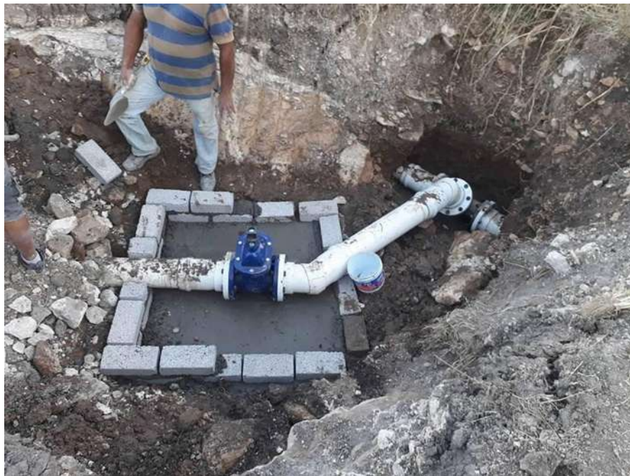
Figura 5.102. Interconexión al pozo superficial.
