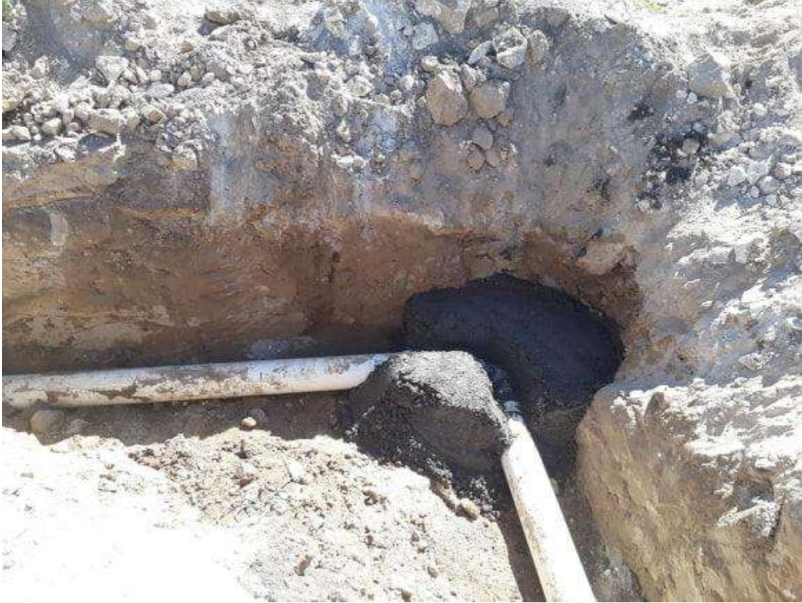
Figura 5.84. Atraques de concreto
