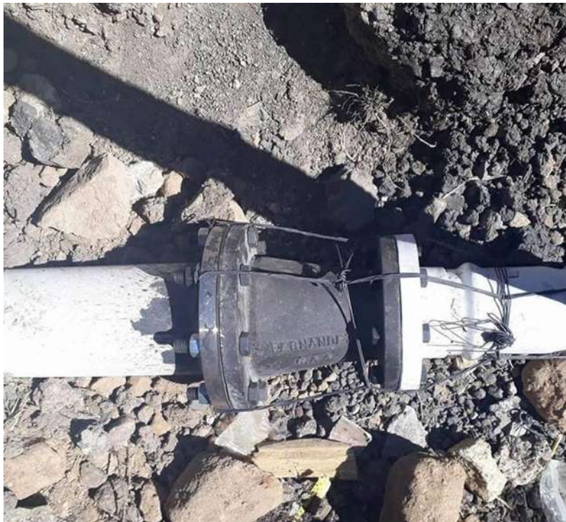
Figura 5.34. Reducción bridada de Fo.Fo. de 6" x 4"Ø
