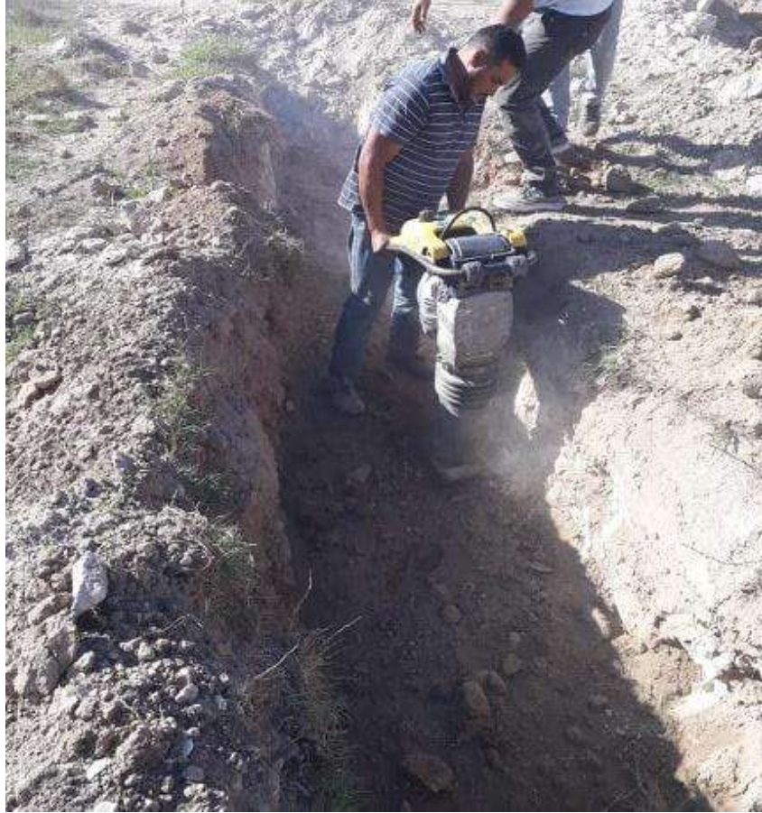
Figura 5.35. Relleno con material de banco (tepetate).
