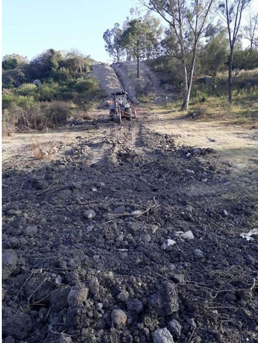
Figura 5.36. Relleno con material producto de la excavación.
