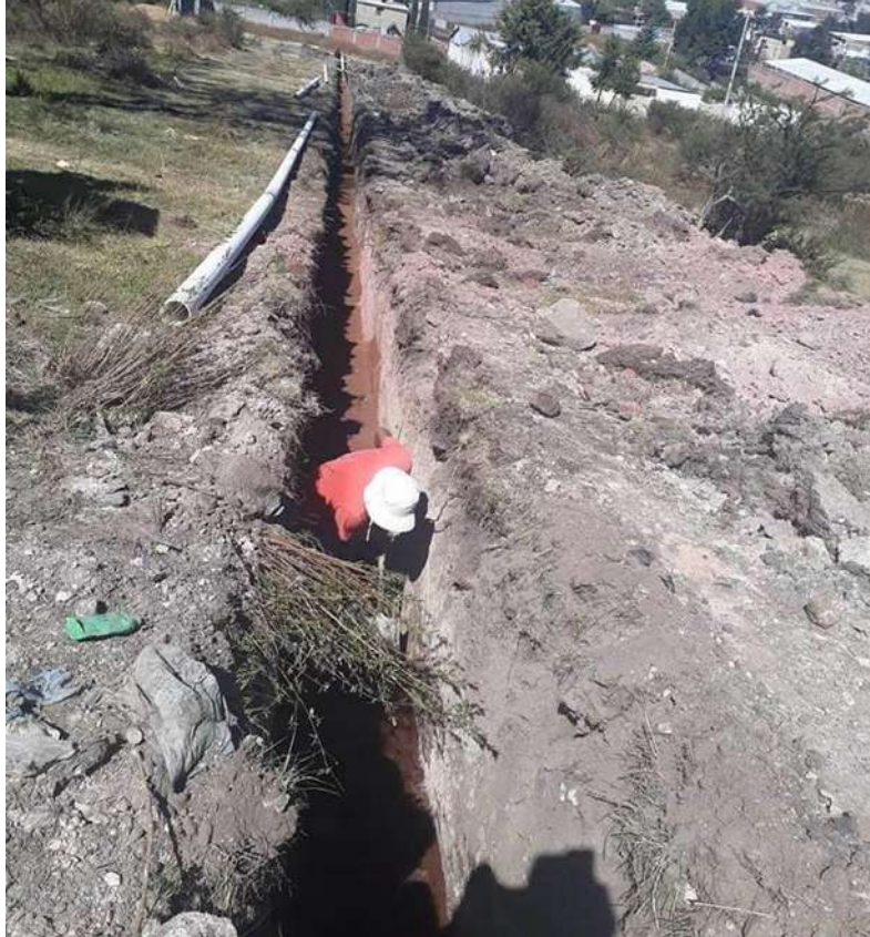
Figura 5.32. Excavación de zanja y colocación de plantilla de arena.
