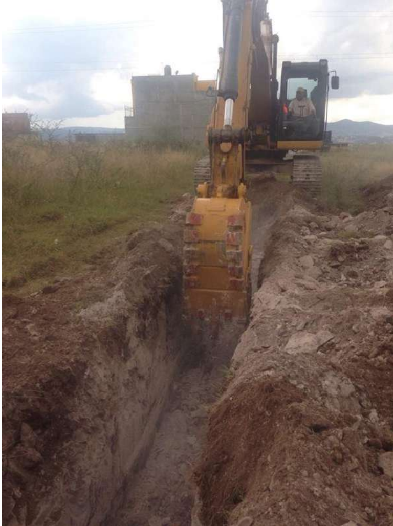
Figura 5.31. Excavación de zanja.
