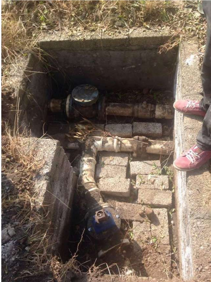
Figura 5.52. Conexión de tubería de 4" antes de sustituirla.
