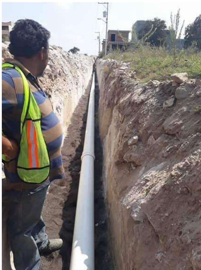
Figura 5.76. Colocación de tubería RD 26 de 6”.
