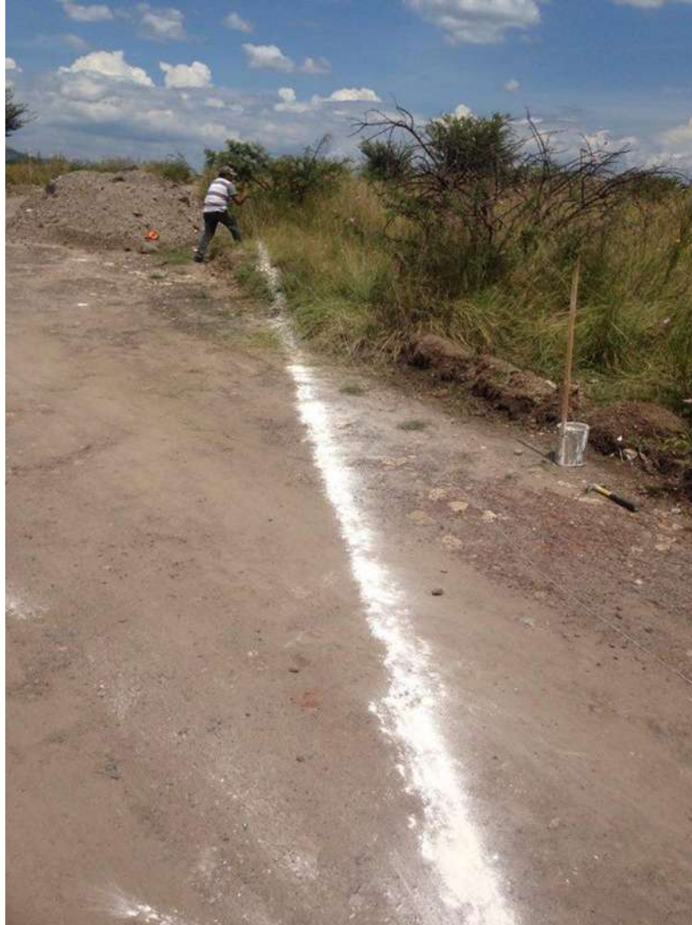
Figura 5.30. Trazo y nivelación de la tubería de acero de 6”.
