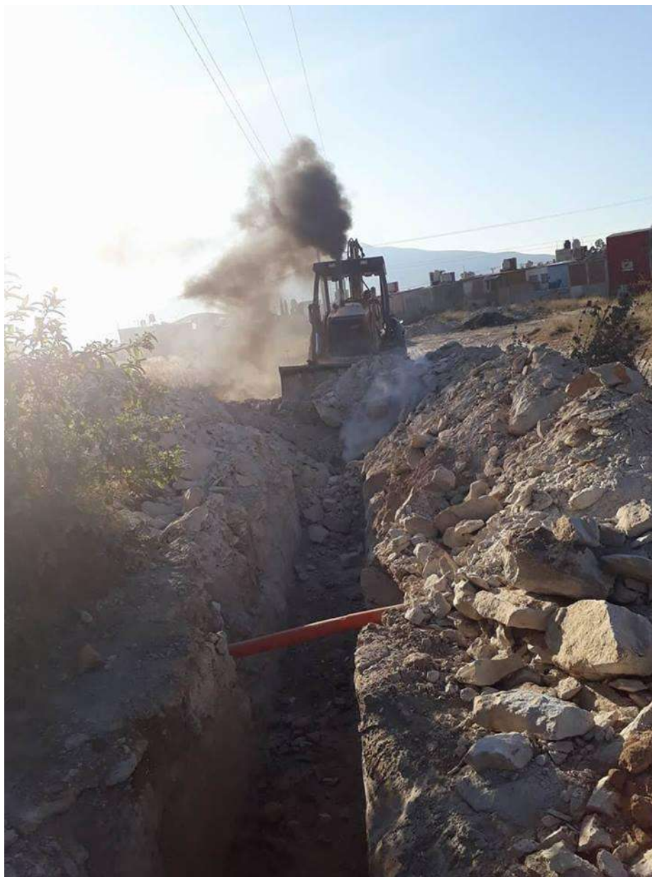
Figura 5.78. Relleno con material producto de la excavación.
