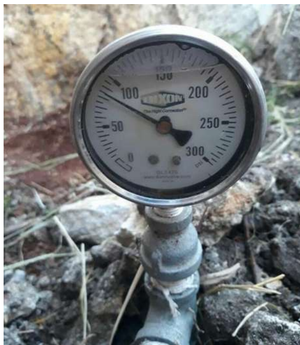
Figura 5.106 Prueba de la tubería de PVC.
