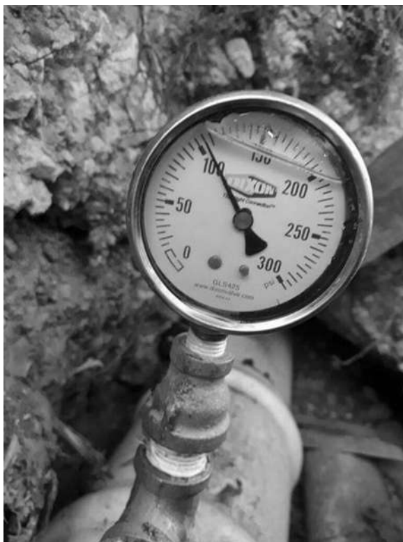
Figura 5.105 Prueba de la tubería de acero.
