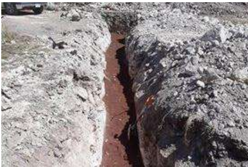
Figura 5.92. Plantilla con material de banco (arena).
