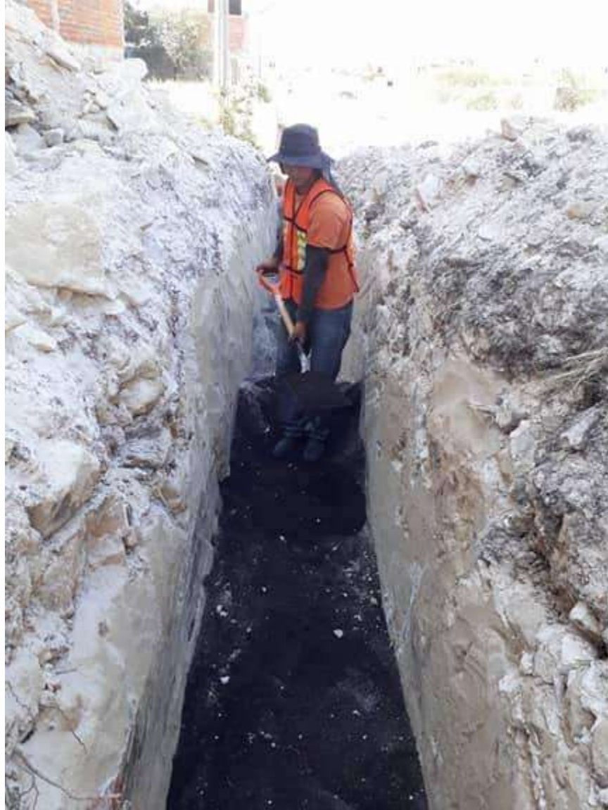
Figura 5.75 Plantilla con material de banco (arena).
