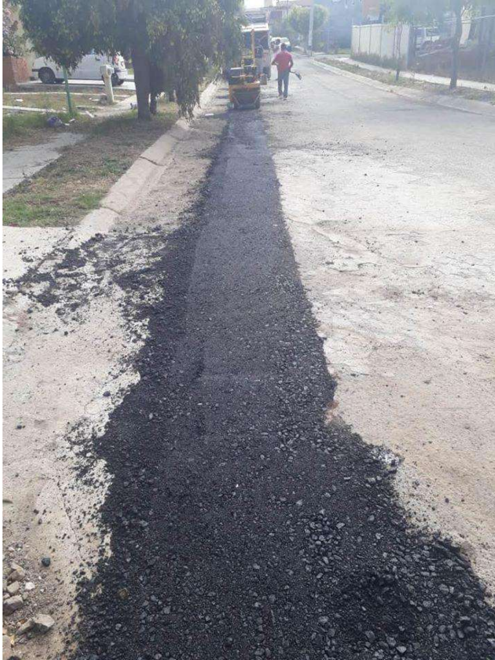
Figura 5.51. Reposición de carpeta asfáltica.
