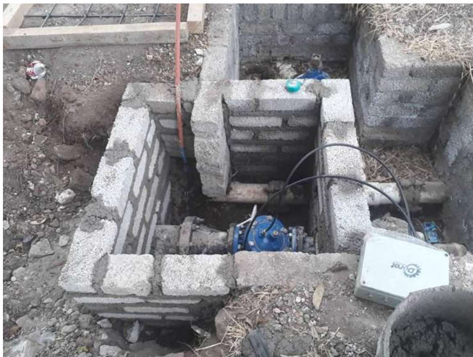
Figura 5.55 Válvula de control off/on.
