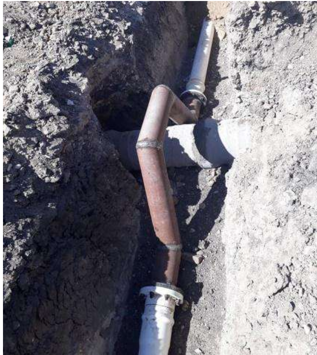
figura 5.85. BYPASS de acero.
