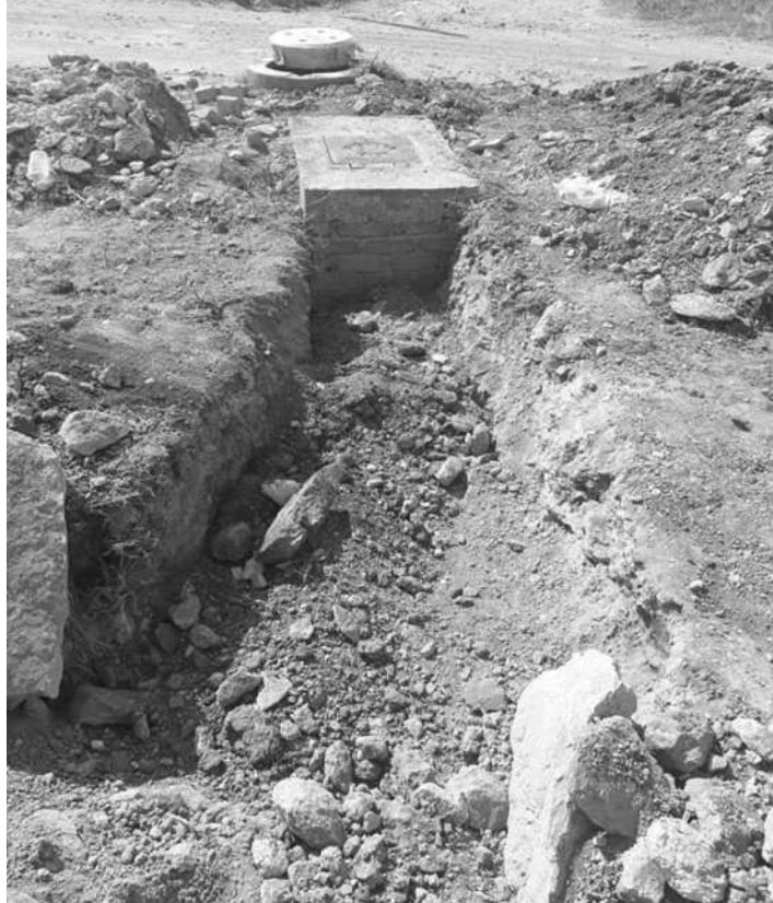
Figura 5.94. Relleno con material producto de la excavación.
