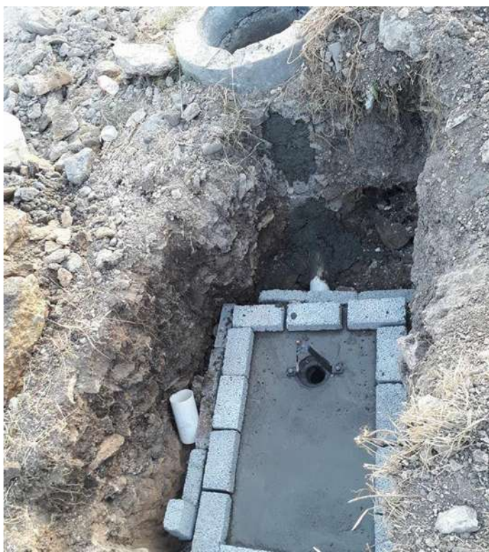
Figura 5.98. Interconexión a pozo de desfogue.
