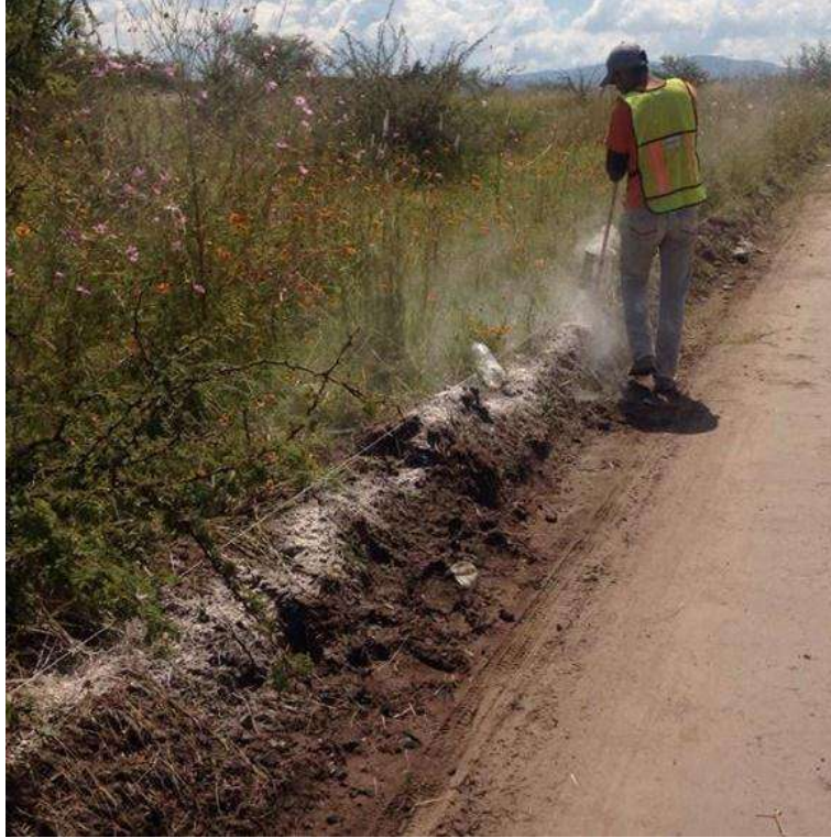
Figura 5.90. Limpieza, trazo y nivelación.
