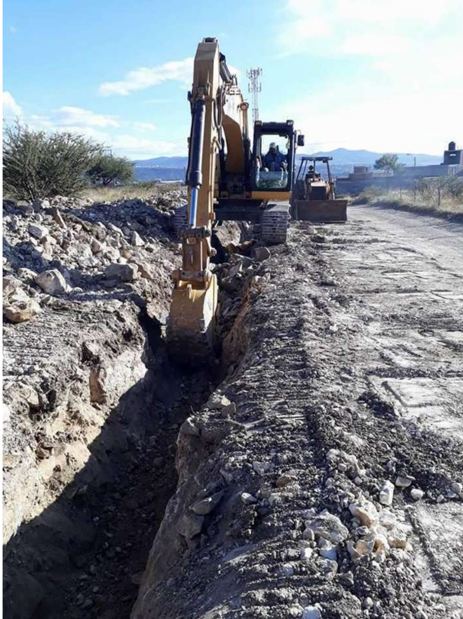
Figura 5.74 Excavación de zanja.
