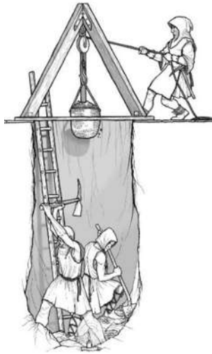
Figura 5.8. Pozo construido manualmente
