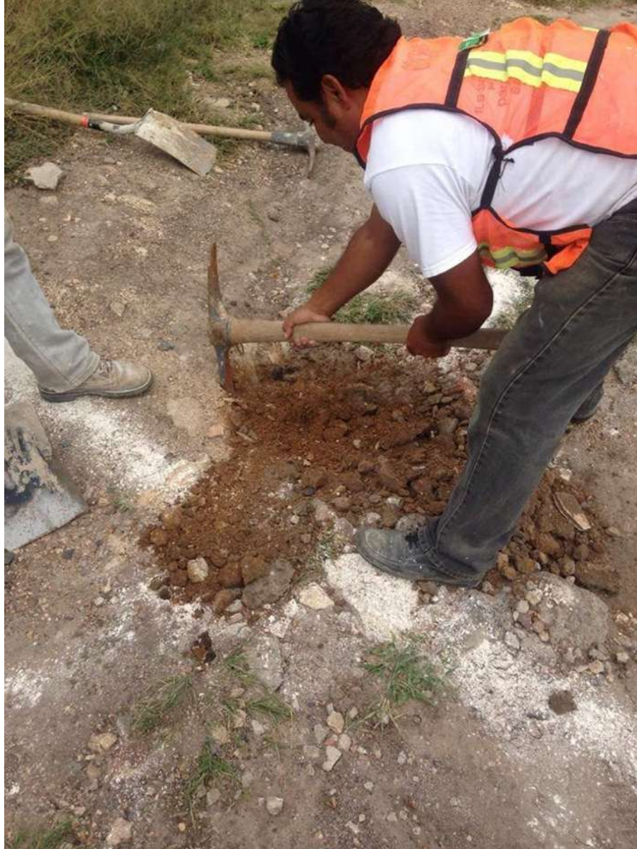
Figura 5.53 Excavación en área de tanques a mano.
