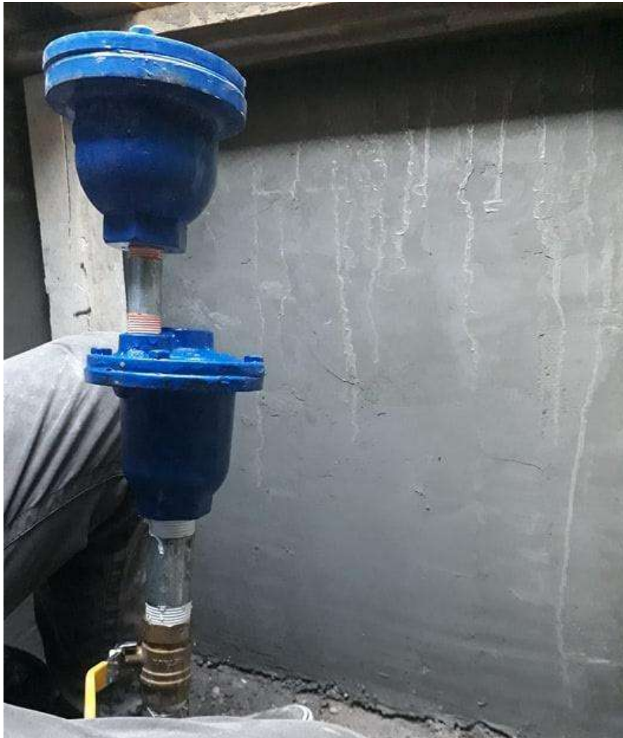
Figura 5.43. Válvula de admisión y expulsión de aire combinada.
