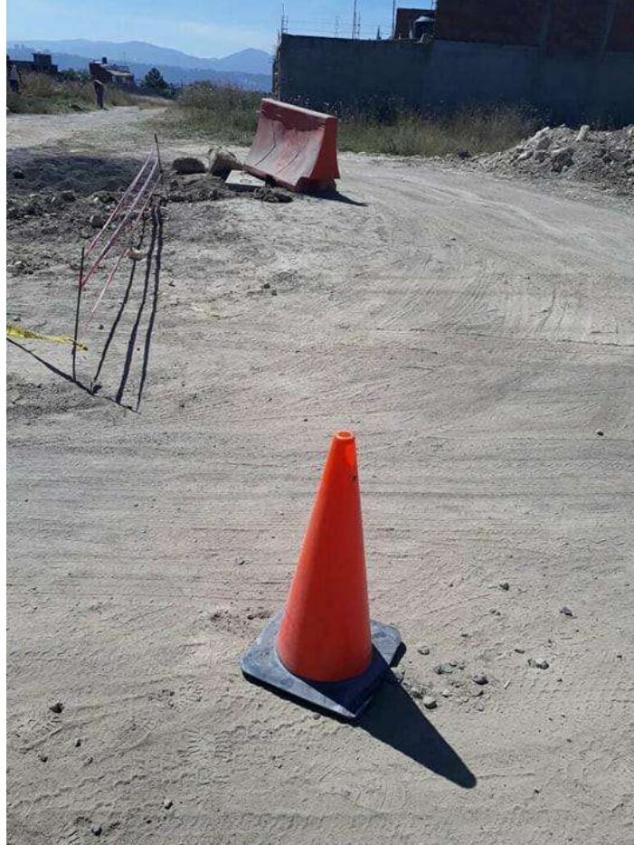
Figura 5.88. Señalamiento con conos y barreras de protección.
