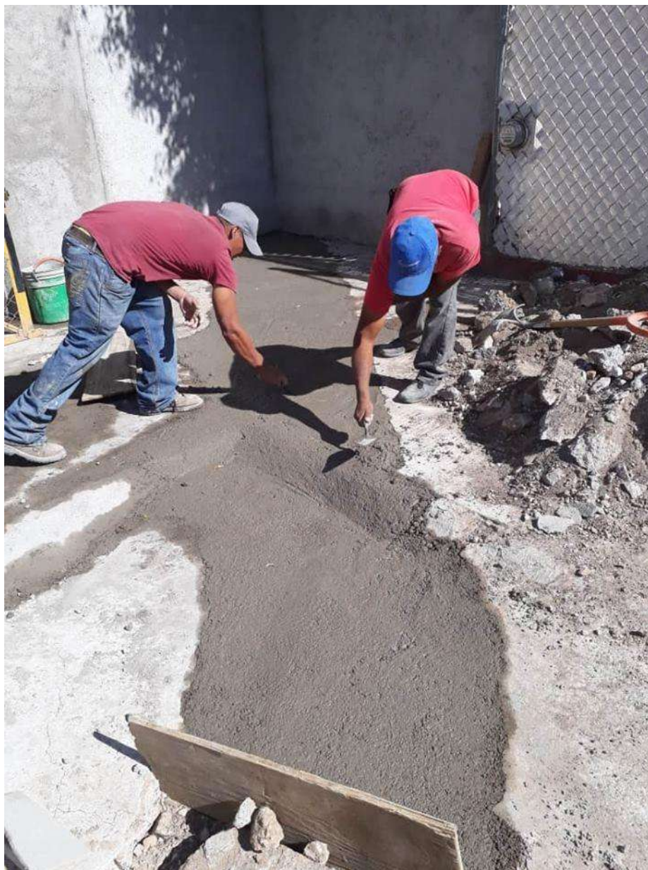
Figura 5.46. Reposición de banquetta.
