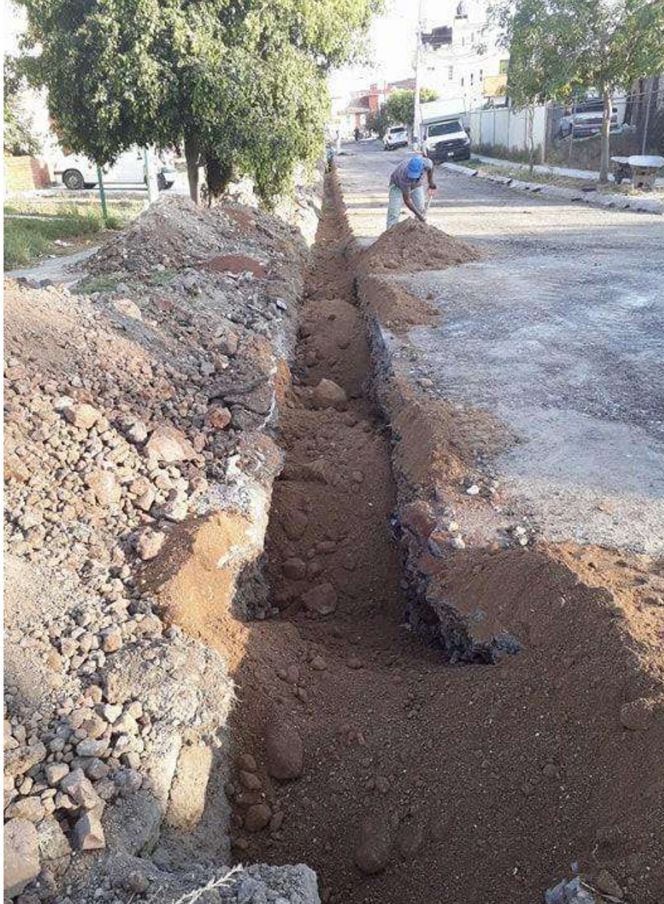
Figura 5.49. Relleno con material de banco (tepetate).
