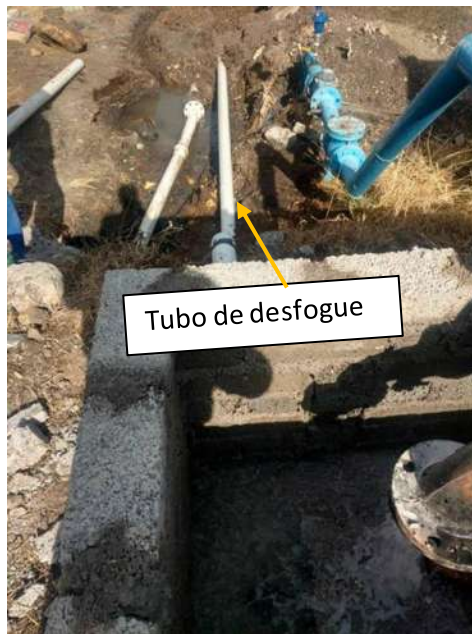
Figura 5.23. Tubo de desfogue sanitario serie - 25 de 4"
