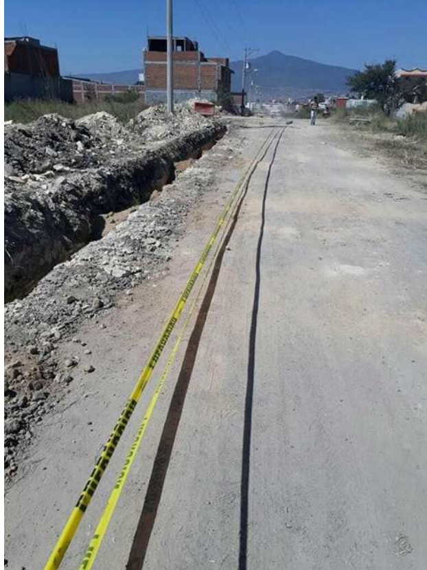
Figura 5.87. Señalamiento con cinta plástica.
