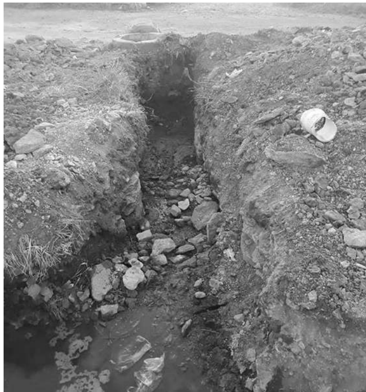
Figura 5.91. Excavación para pozo de desfogue.
