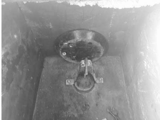
Figura 5.101. Bola CESPOL, plato quiebra chorro y bola contra peso.
