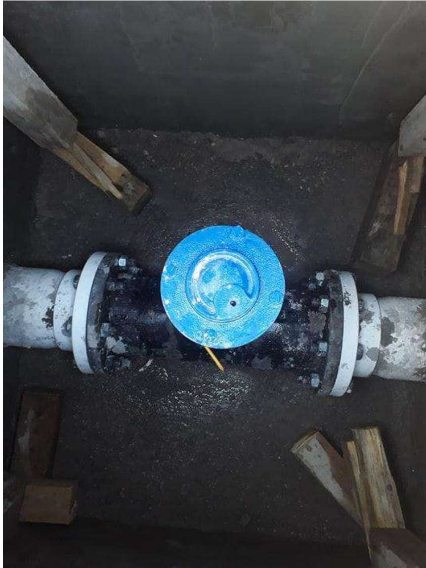
Figura 5.42. Válvula de admisión y expulsión de aire combinada
