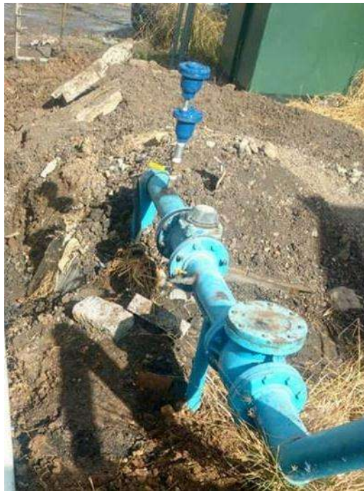
Figura 5.24. Válvula de admisión y expulsión de aire combinada.
