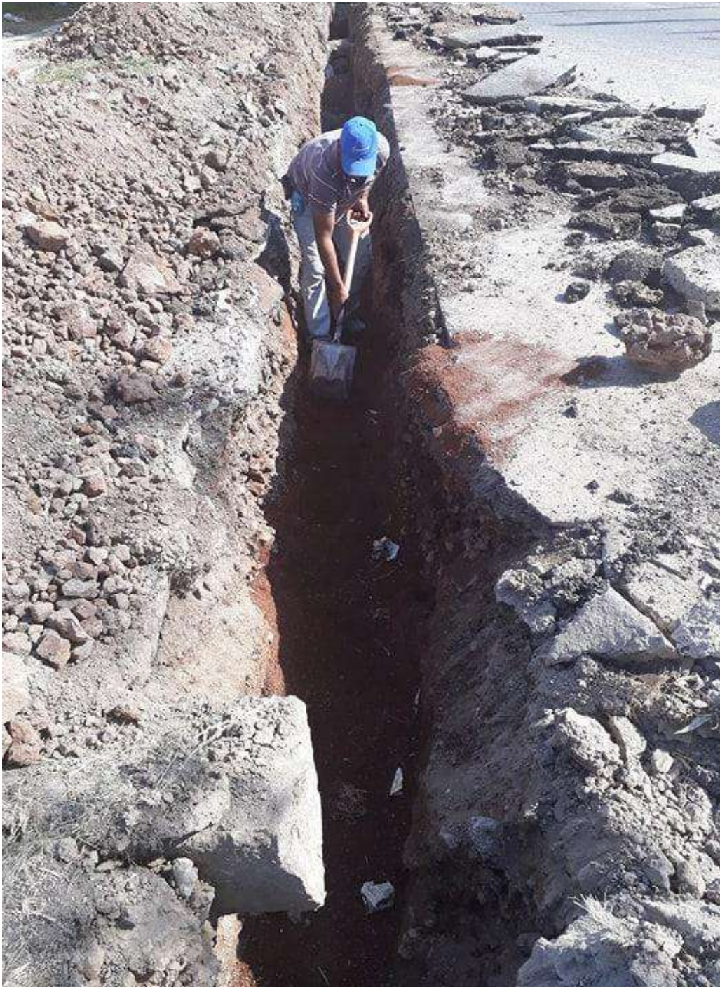
Figura 5.48. Plantilla con material de banco (arena).
