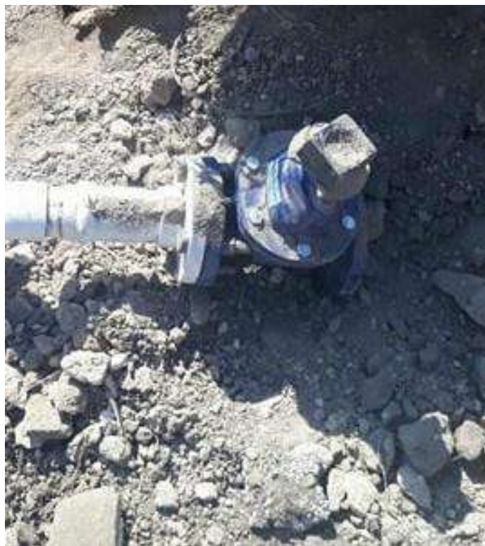
Figura 5.97. Válvula de vástago fijo de 2" de diámetro
