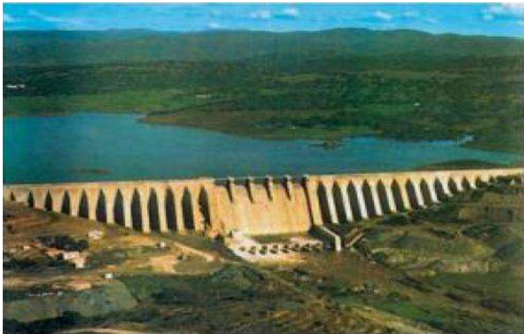
Figura 4.1.3 Presa Tipo contrafuertes (Vallejo)
