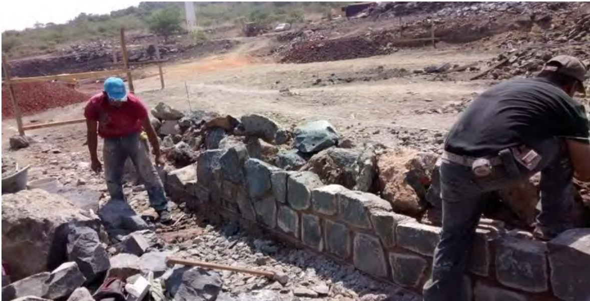
Muro de contención.
