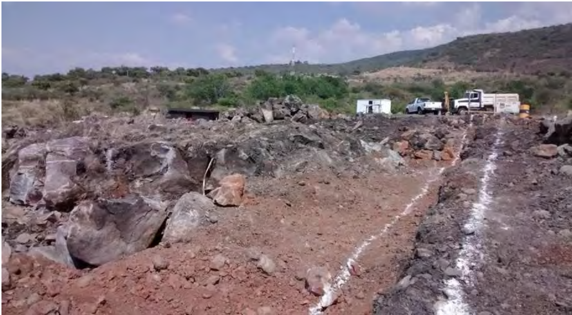
Marcado del área de excavación.
