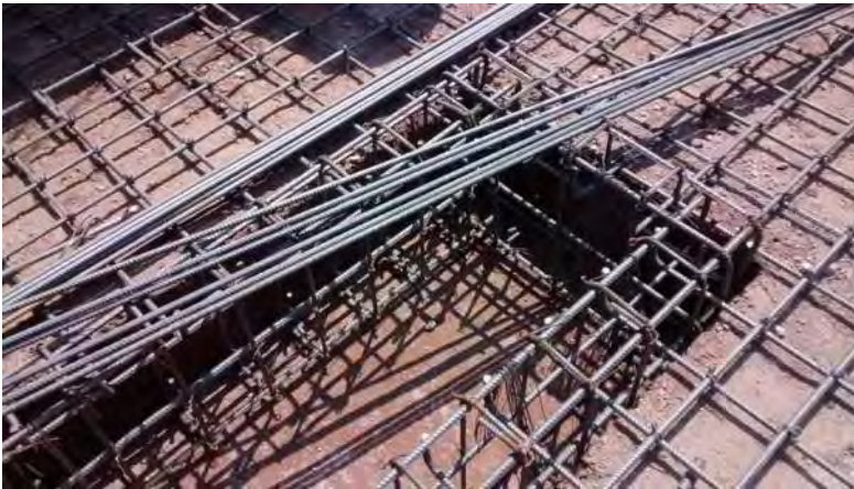
Cimbrado y armado de cimentación.
