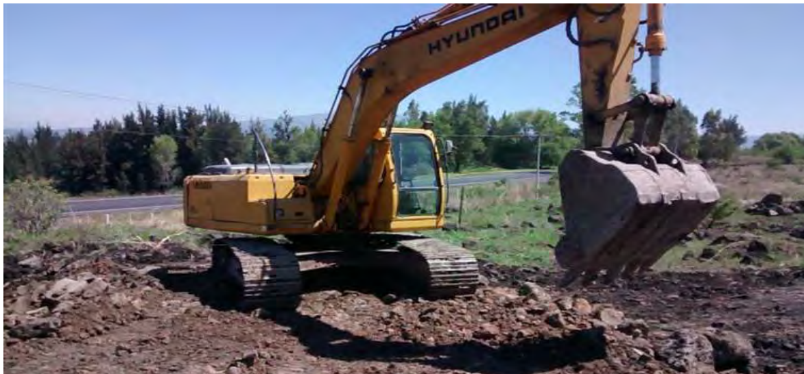
Excavación en terreno natural.
