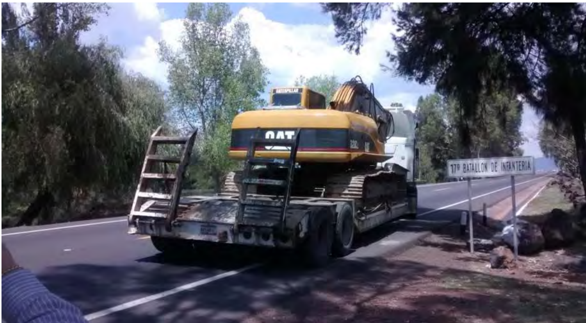
Inicia la llegada de equipo para los trabajos preliminares y excavación.
