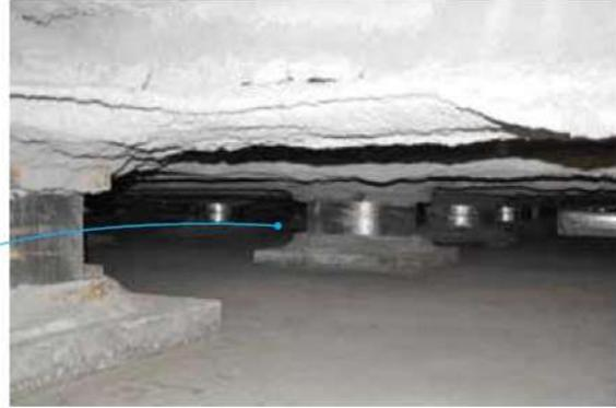
**Figura 7.** Implementación de aisladores sísmicos en municipio de San Francisco EEUU. (Nitsche, 2011)
