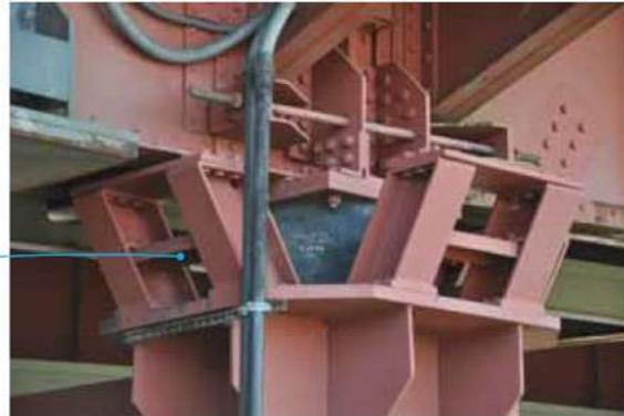
**Figura 8.** Implementación de aisladores sísmicos en puente golden gate en San Francisco. (Nitsche, 2011)
