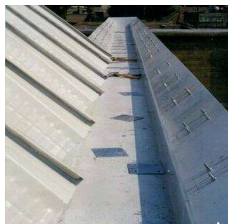
Imagen 6(h) Unión canalón-cubierta
