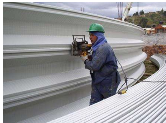
Imagen 6(d) Unión de arcos por medio de una engargoladora eléctrica
