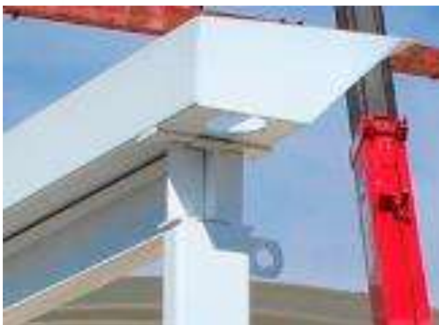
Imagen 6(g) Unión trabe-canalón
