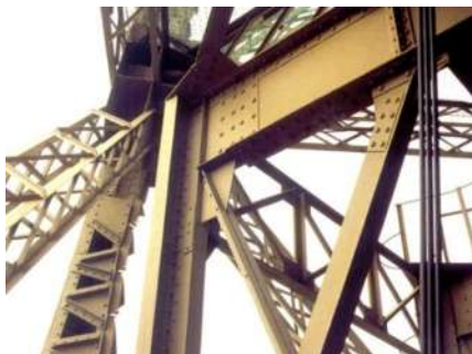
Figura 1. 2 Conexiones con remaches en la Torre Eiffel.
