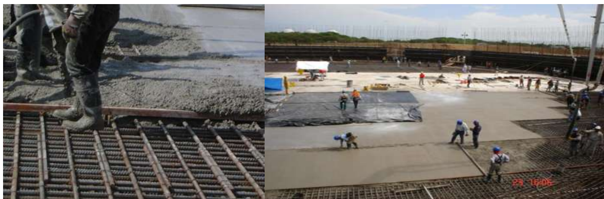
Fig. 4.5 Vaciado del concreto para la losa de cimentación.
