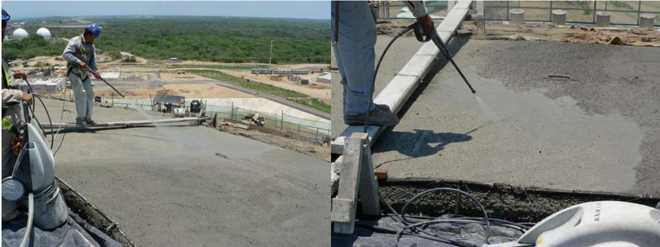
Fig. 9.14 Preparación del corte en verde en el concreto
