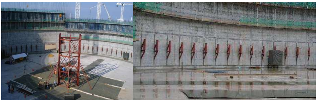
Fig. 9.2 Colocación de soportes perimetrales y central para sostener la cúpula.
