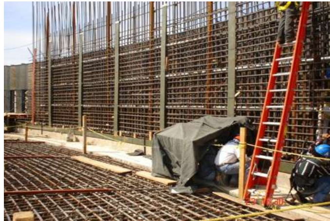
Fig. 5.2 Aplicación de soldadura para unir las placas en sentido horizontal y en sentido vertical.
