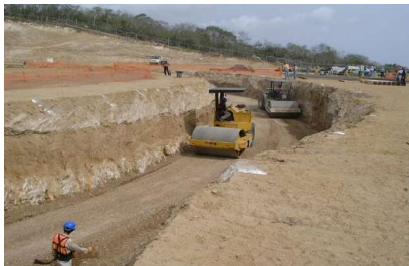
Fig. 2.10 Relleno y compactación del suelo para su mejora.
