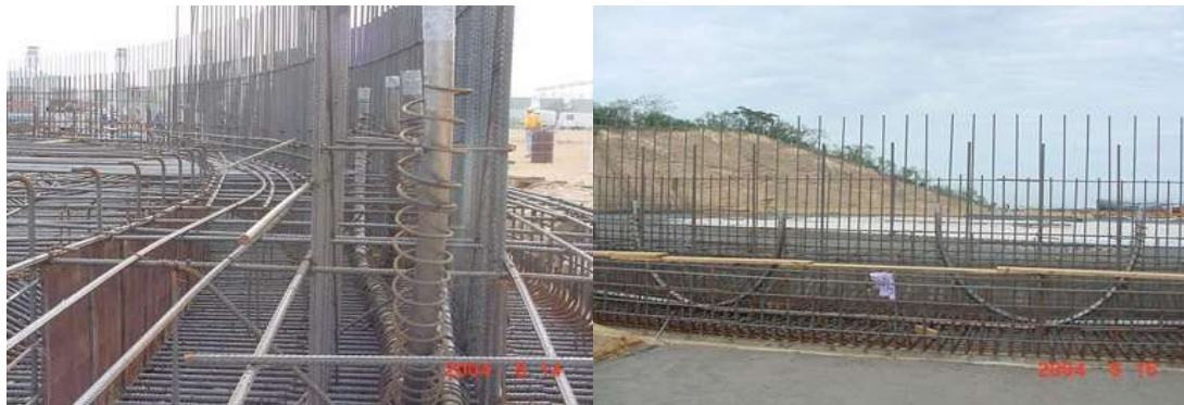
Fig. 3.15 Arreglo y colocación del acero de refuerzo de la tubería de presfuerzo.
