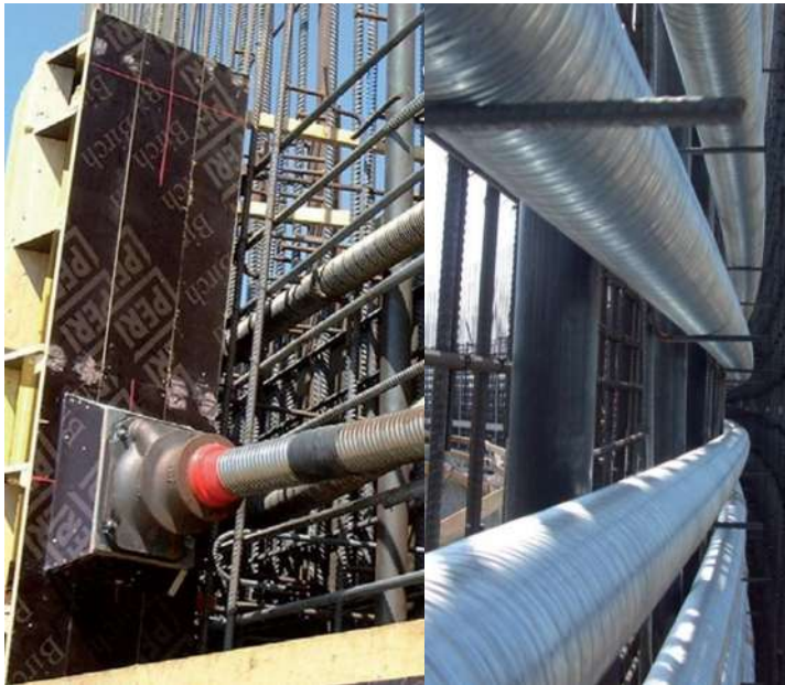
Fig. 5.1 Colocación de la tubería y tromplacas del presfuerzo.
