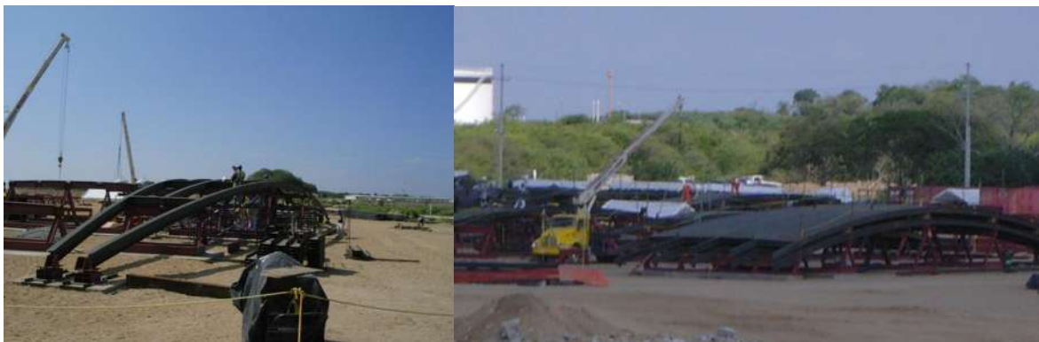
Fig. 9.1 Fabricación de las secciones metálicas para la cúpula.
