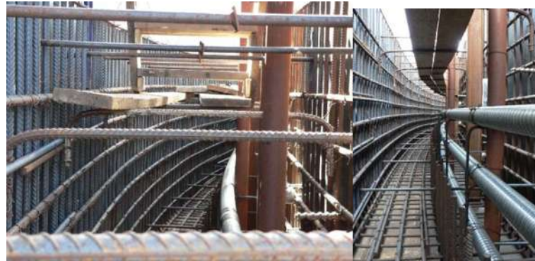
Fig. 6.5 Colocación y Armado de acero de refuerzo en la viga circular.
