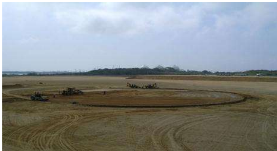
Fig.2.5 Excavación, nivelación y mejoramiento de suelo.
