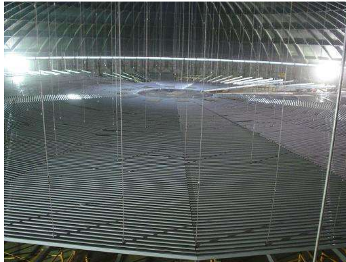
Fig. 7.10 Techo de láminas de aluminio suspendido.
