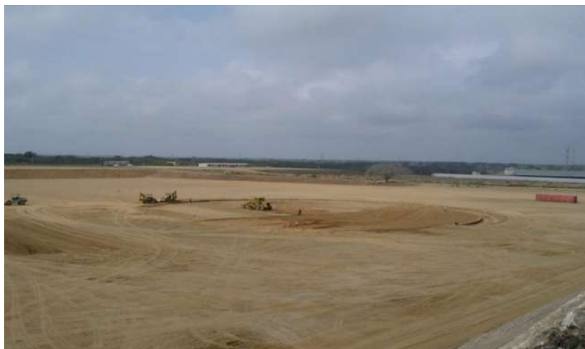
Fig. 2.4 Inicio de la excavación para el desplante de la cimentación de los tanques.
