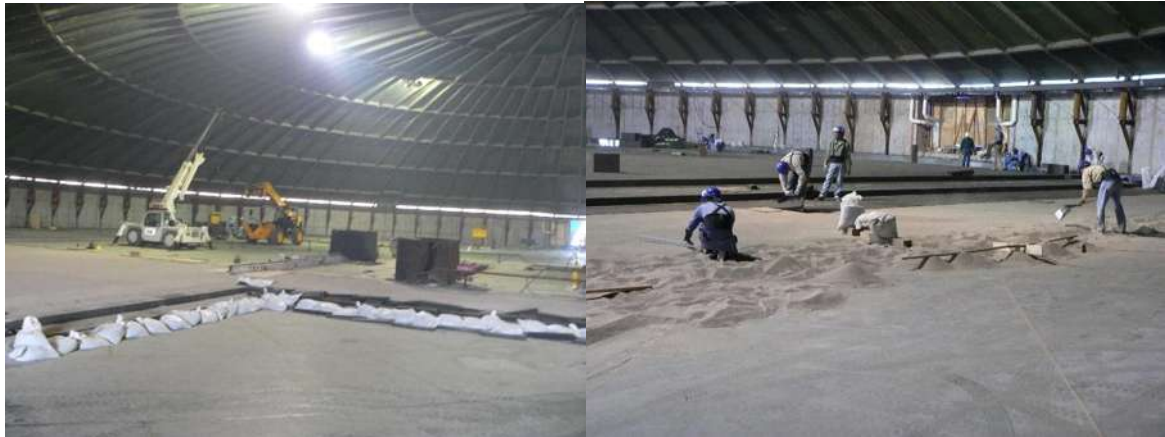
Fig. 7.8 Colocación del aislante en el piso.
