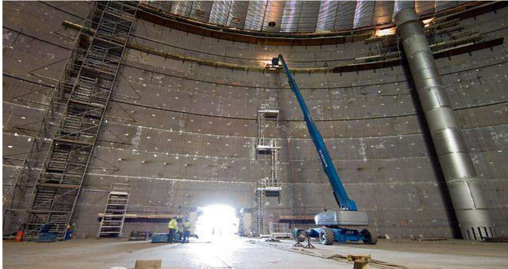
Fig. 7.4 Construcción de tanque interno y colocación de tuberías de suministro y emisión de GNL.
