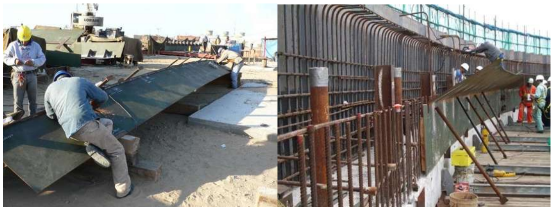
Fig. 6.4 Habilitado y colocación de los soportes y placas de la viga circular.
