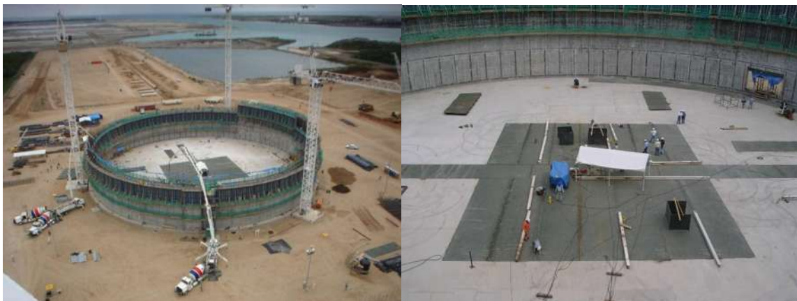
Fig. 7.1 Armado del fondo secundario con placas de acero de \frac{3}{4} \"
