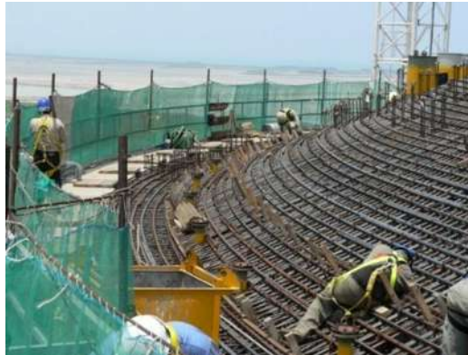
Fig. 9.11 Armado de acero en para revestir la cúpula del tanque.
