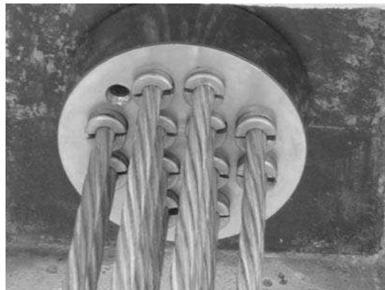
Fig. 8.10 Colocación de plato de anclaje con sus cuñas.
