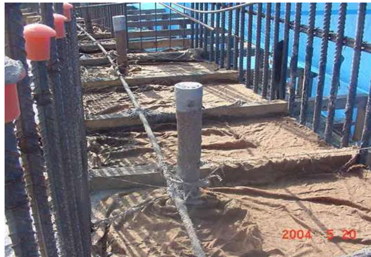
Fig. Sistema de curado con tela de arpillera húmeda.
