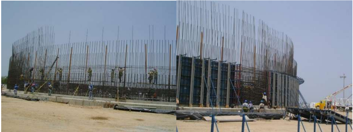
Fig. 5.1 Armado de acero de refuerzo para los muros del tanque del primer nivel.
