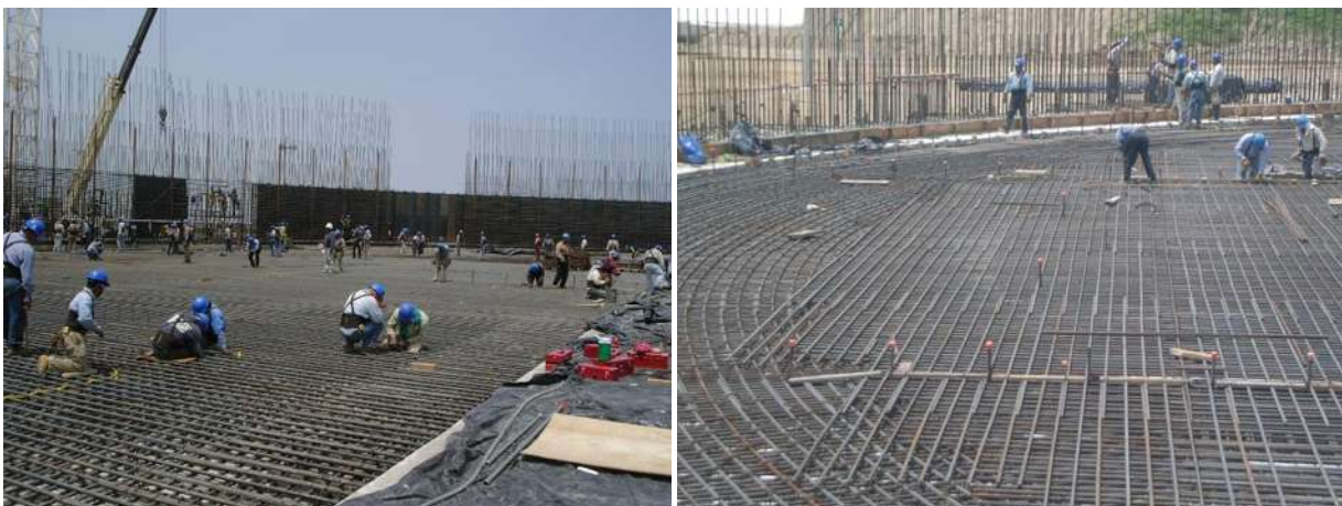
Fig. 4.2 Armado de acero de refuerzo.
