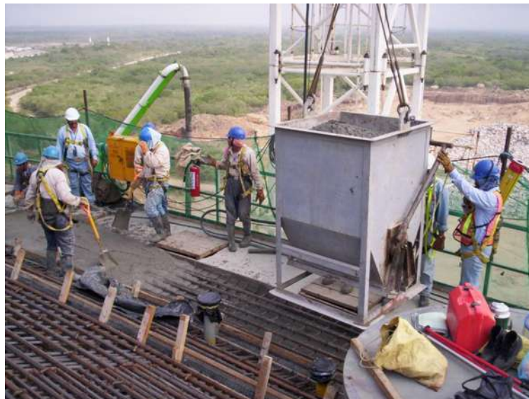
Fig. 9.13 Colado de la cúpula con bacha.
