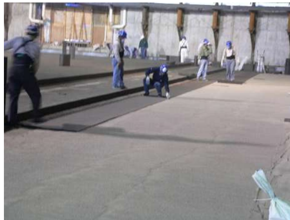
Fig. 7.6 Aplicación de membrada asfáltica.
