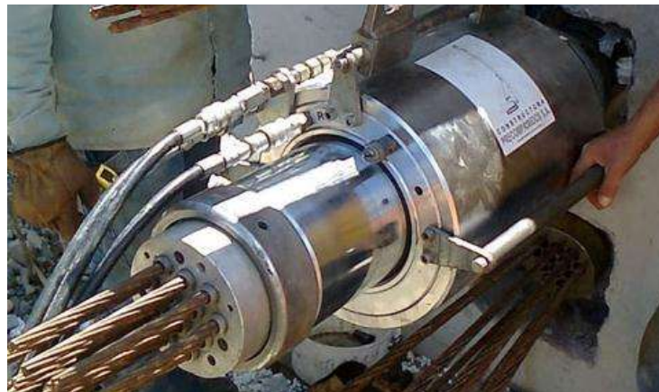
Fig. 8.10 Tensado de los cables de los tendones.
