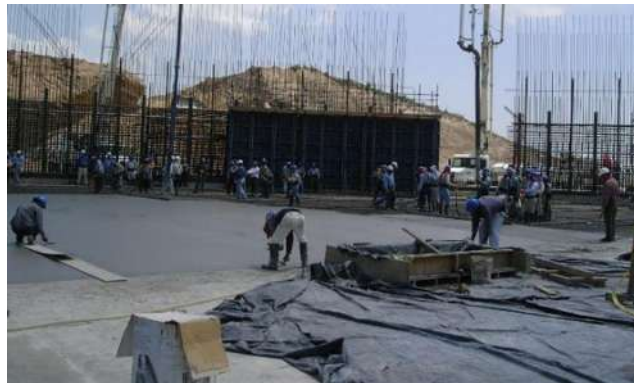
Fig. 4.7 Ejecución de curado del concreto.
