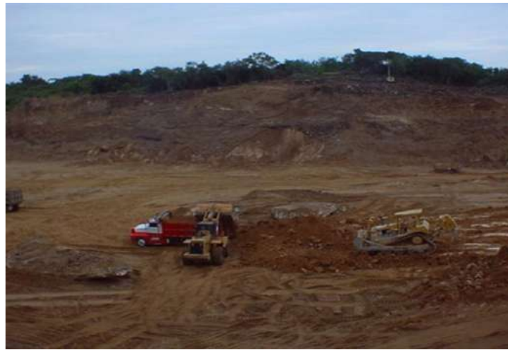
Fig. 2.1 Plataforma para despalme de la planta regasificadora.
