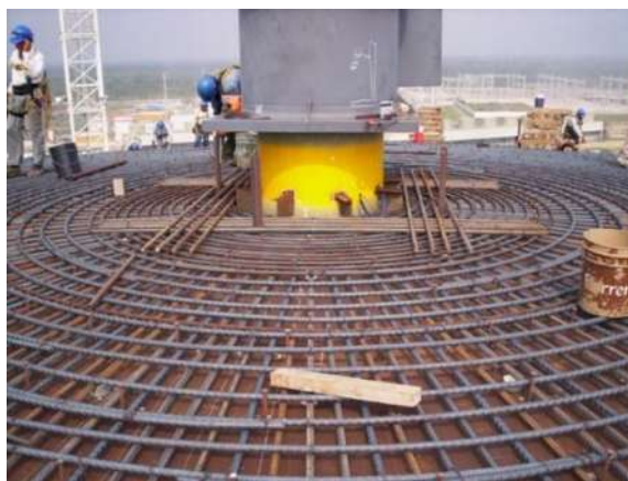
Fig. 9.12 Refuerzo de acero en el centro de la cúpula.
