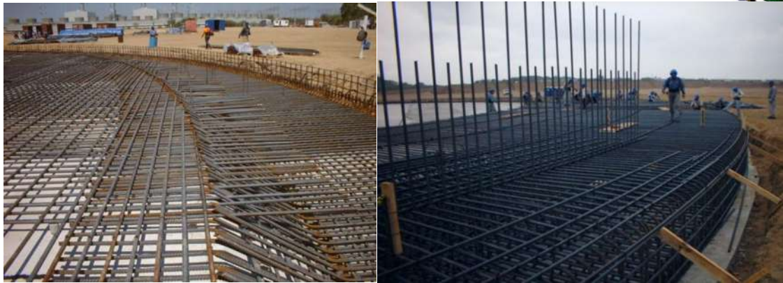
Fig. 3.11 Armado de acero para la cimentación externa del tanque.
