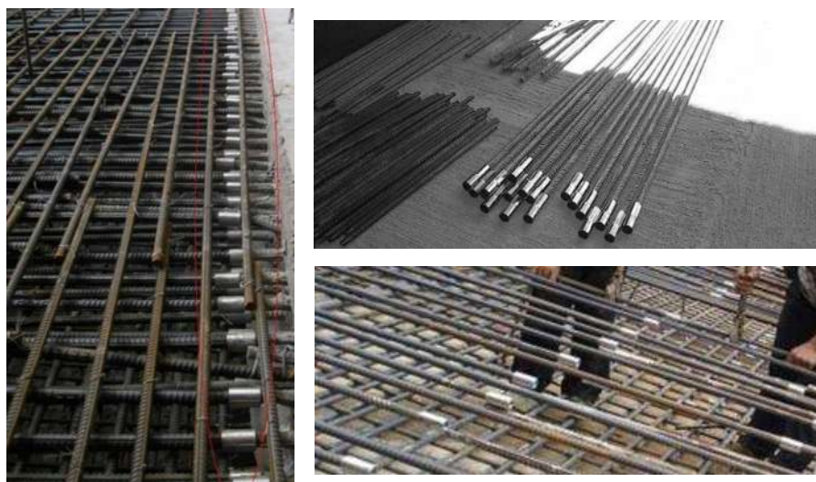
Fig. 9.10 Colocación de los conectores mecánicos.
