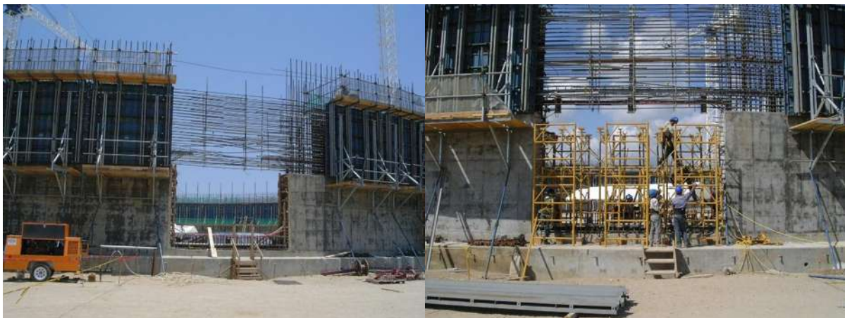
Fig. 5.13 Obra falsa para los opening temporales.
