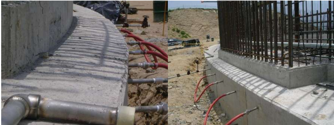
Fig. 4.3 Pruebas neumáticas al conducto calefactor.
