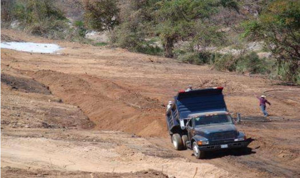
**Terraplenes:** Formación de terraplenes compactados, integrados con materiales procedentes de la excavación en corte, incluye el movimiento del material del corte al terraplén
