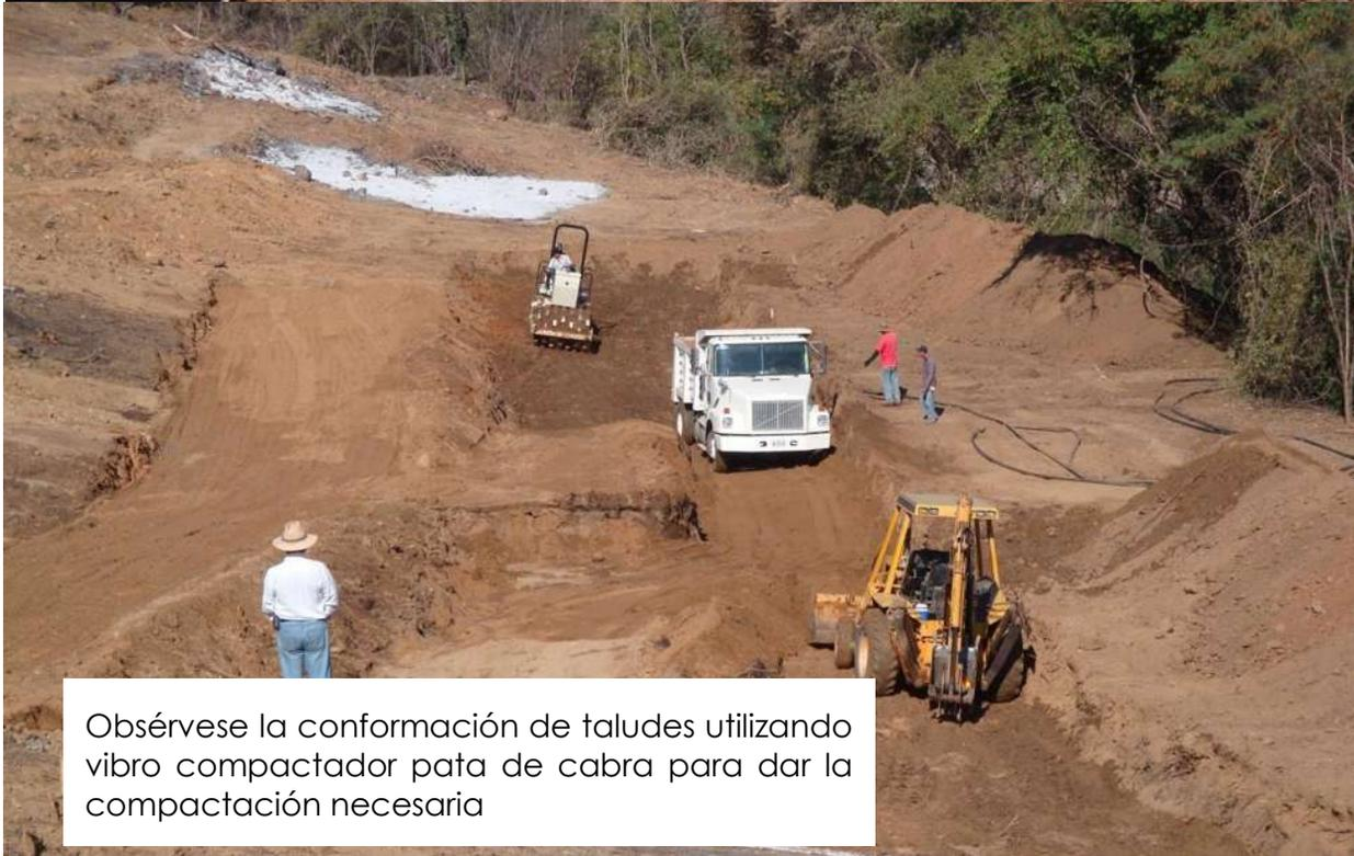
Obsérvese la conformación de taludes utilizando vibro compactador pata de cabra para dar la compactación necesaria
