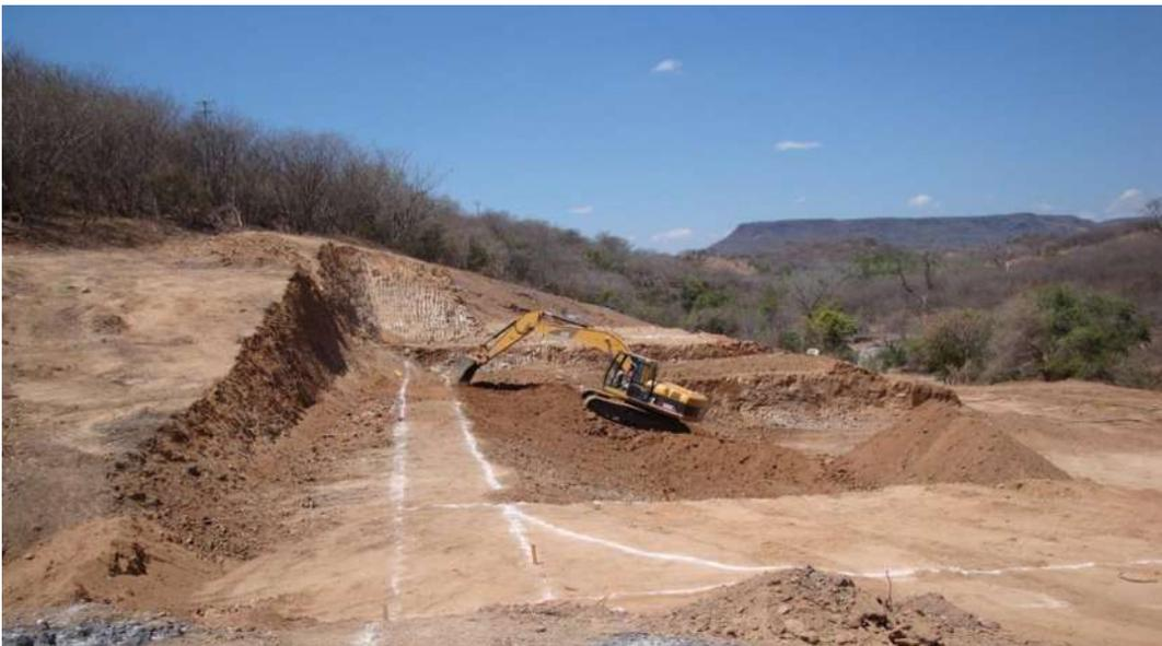
**Laguna de Maduración:** La laguna de maduración, diseñada para 10 lps tiene un área de 1,517 m<sup>2</sup> y una profundidad de 1.50 mts y un volumen de 2,275 m<sup>3</sup>.
