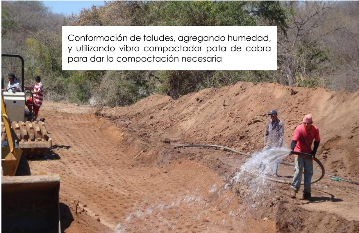
Conformación de taludes, agregando humedad, y utilizando vibro compactador pata de cabra para dar la compactación necesaria
