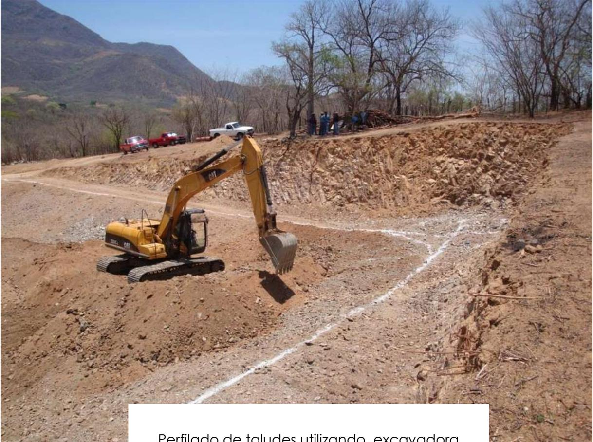
Perfilado de taludes utilizando, excavadora CATERPILLAR 320LC en material tipo III
