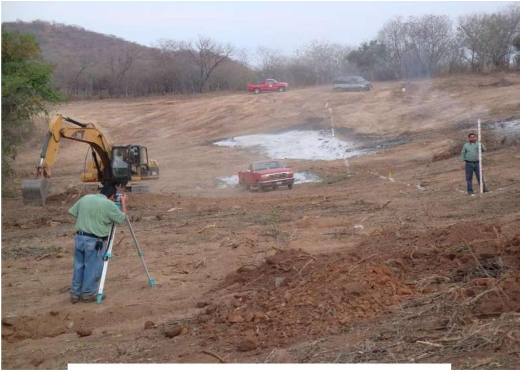
Se delimitará perfectamente el área de construcción con el apoyo de aparatos topográficos o instrumentos manuales.
