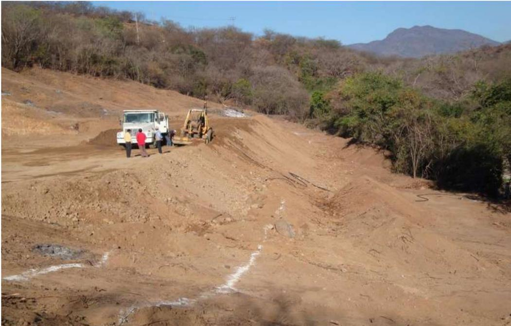
**Terraplenes:** Los terraplenes se construirán por capas horizontales, con espesor de 20 cm de material suelto, que se compactará hasta alcanzar el 95 % de la prueba proctor, y que en ningún caso debe dar un peso volumétrico seco, menor a  $15,7\text{kN/m}^3$  ( $1,6\text{ t/m}^3$ ).
