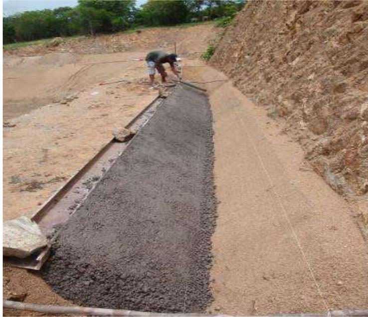
**15.3 OBRAS DE PROTECCION Canales:** El trabajo consiste, en la construcción de cuneta de concreto simple de  $f'c=150 \text{ kg/cm}^2$ , de 8 cm de espesor promedio. El concreto debe ser fabricado con revolvedora, el proporcionamiento de los agregados es responsabilidad del Contratista
