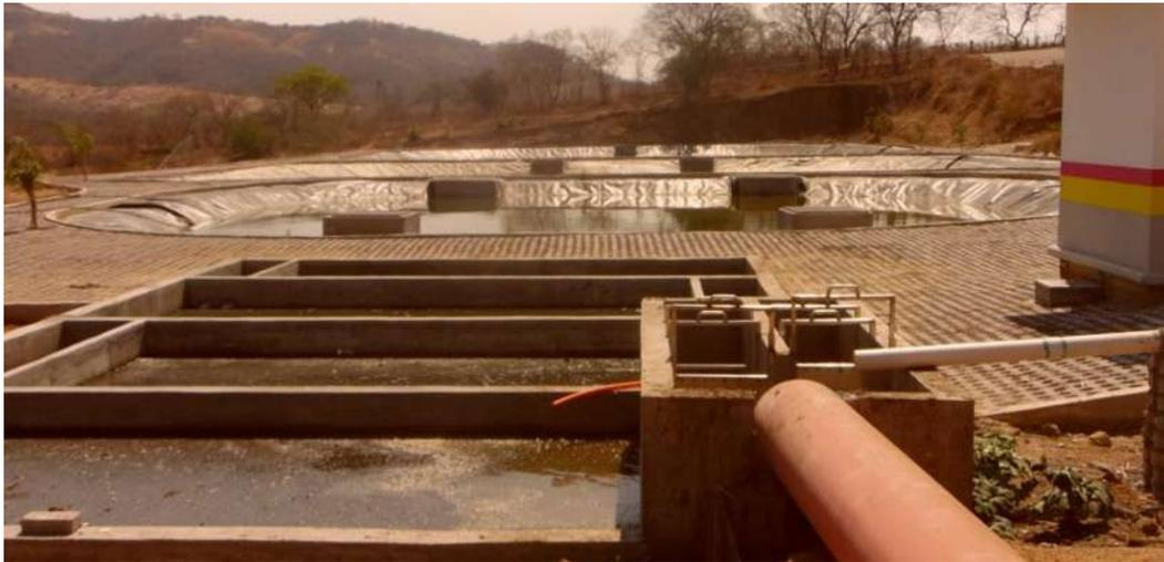
**Pretratamiento:** El emisor descarga en una caja de distribución de gastos hacia las unidades de rejilla y desarenador que forman el pretratamiento, éstos se tienen por duplicado y funcionan en paralelo, de tal forma que se utilizan unas en tanto se les da mantenimiento a las otras. Estas unidades se tienen en un canal rectangular de 0.60 m de ancho.
