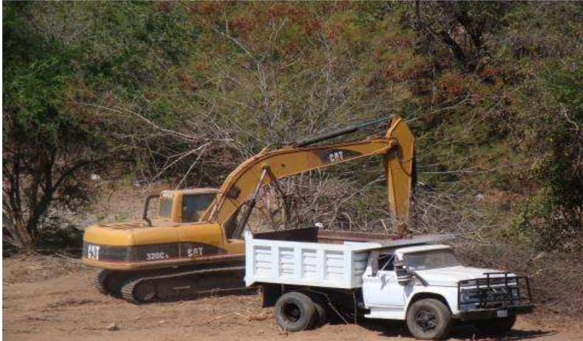
**15.1. PRETRATAMIENTO:** Las excavaciones se realizarán con maquinaria, en lo suficiente para que los trabajadores se muevan fácilmente para la colocación del acero y cimbra.
