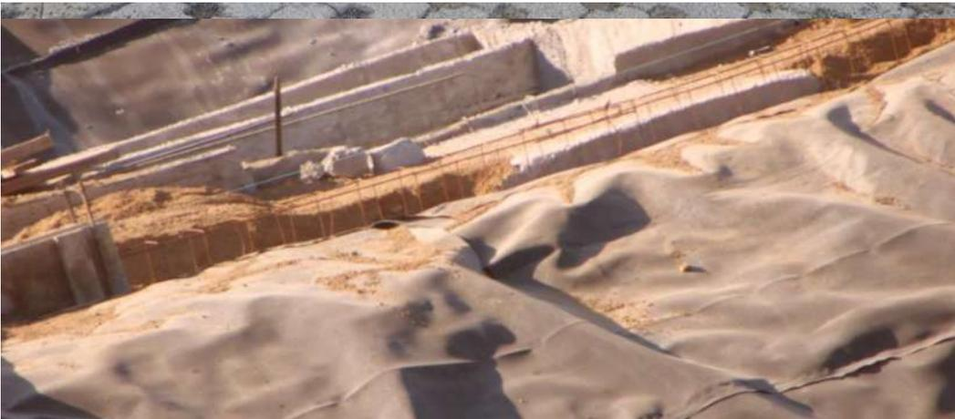
**Geomembrana:** Se procederá a su colocación en todas las partes interiores de las lagunas, teniendo mucho cuidado en su manejo para evitar desgarres durante su colocación, cuidando que los operarios estén adecuadamente equipados tanto en su vestuario como en su herramienta durante su colocación debemos de cuidar los dobleces adecuados en los hombros de las coronas de las lagunas.
