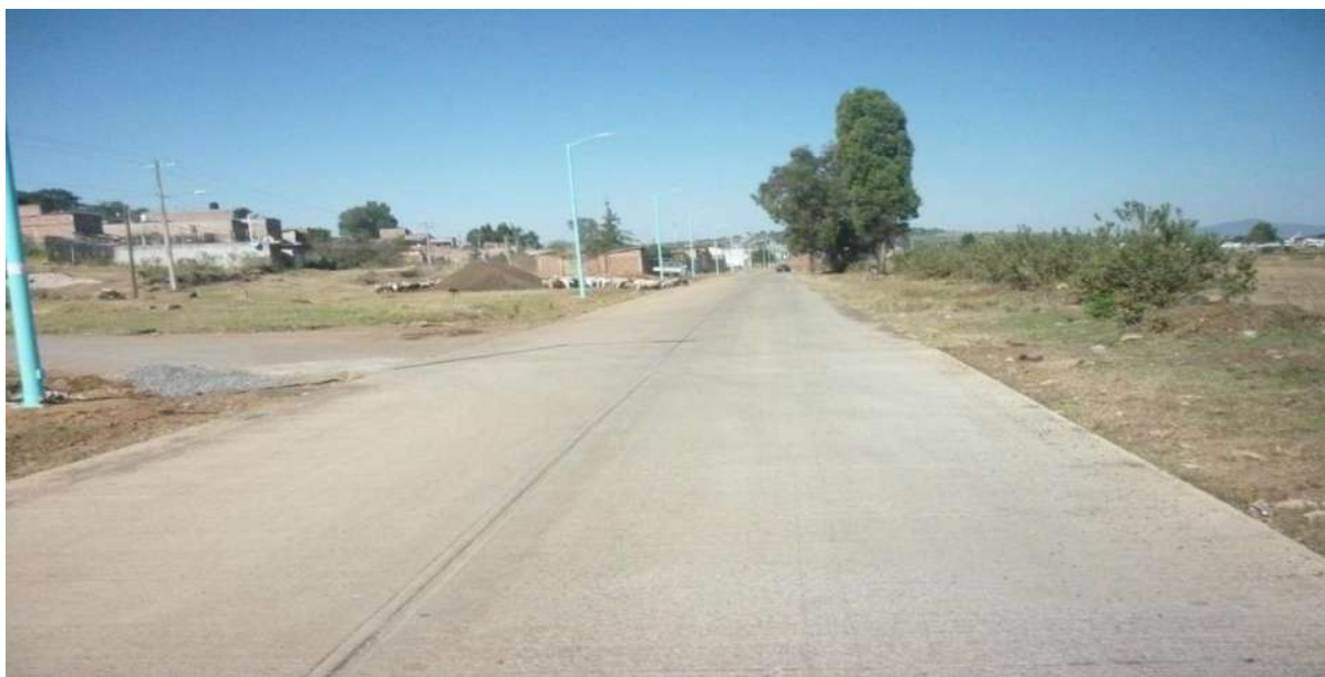
Fotografía V.2. Condición general de la obra
