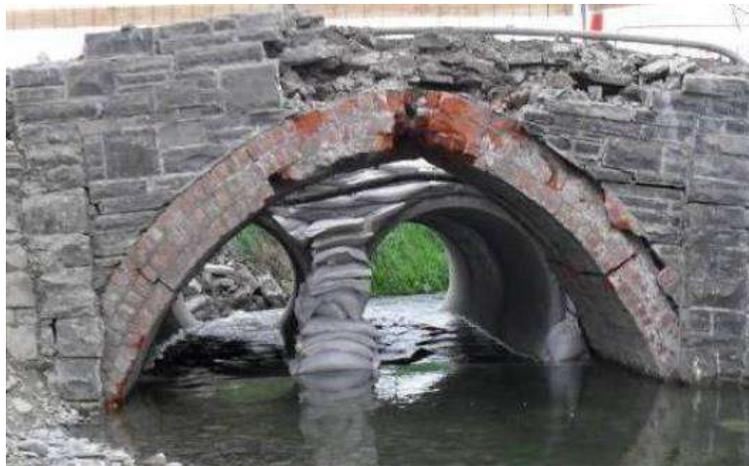
*Figura 5 Formación de articulaciones en el puente Saby's Road (Palermo et al., 2010)*
