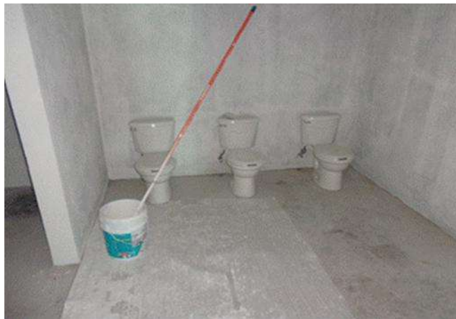
Colocación de inodoro blanco, marca "ideal standard; modelo zafiro, incluye tanque bajo y accesorios.
