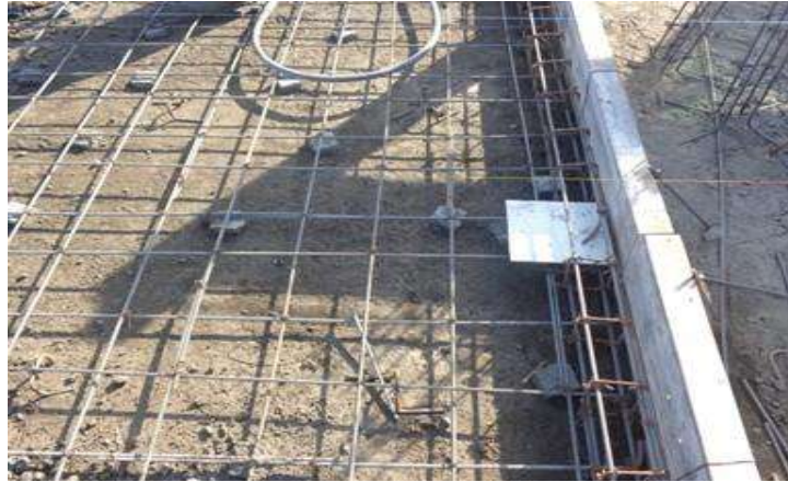
Armado de dala de 25x15 cm con cuatro varillas del #3 y estribos del #2 a @20 cm.
