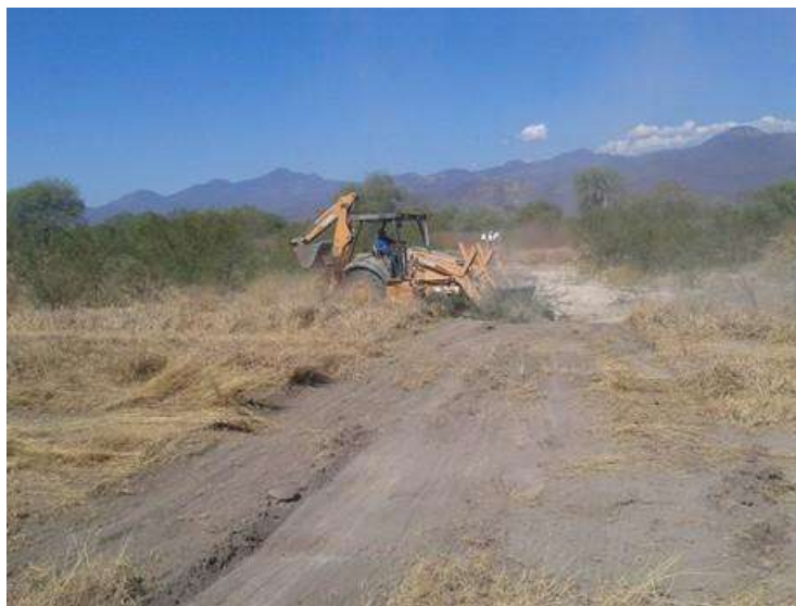
Despalme de 20 cm de material tipo B y material capa vegetal.
