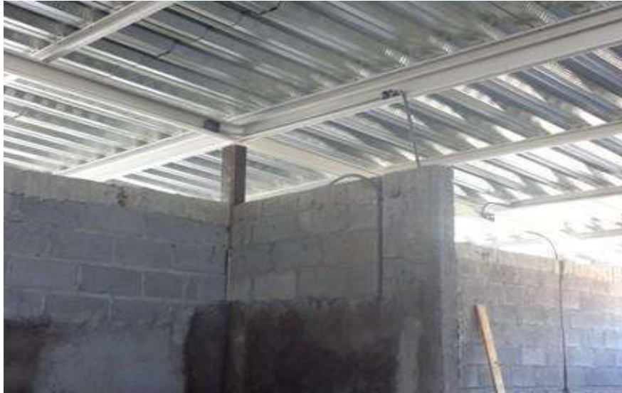
Colocación de lámina galvanizada calibre 22 de 6 m de largo.
