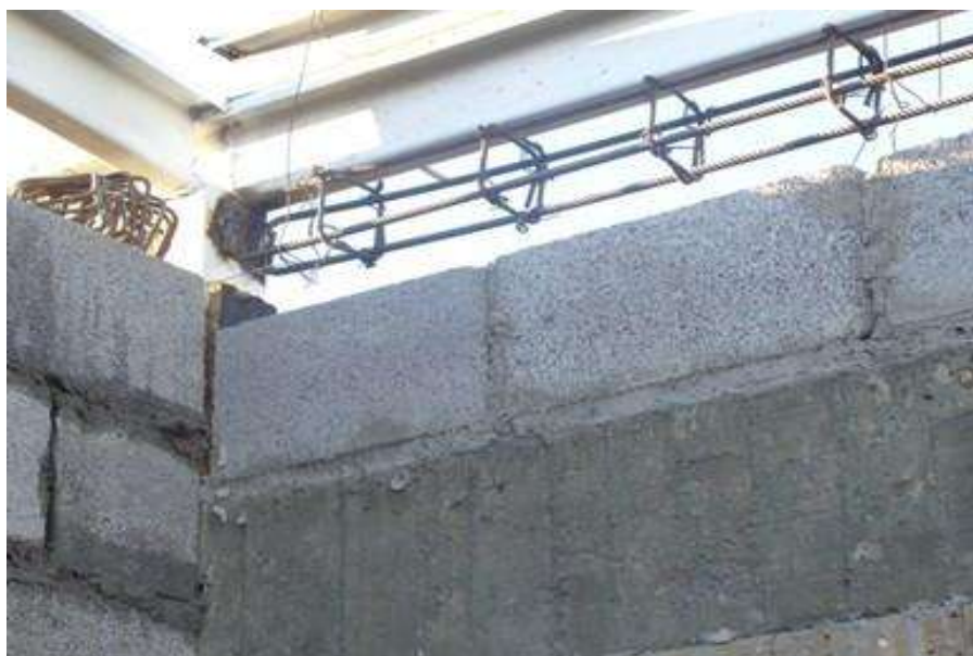
Trabes de cerramiento de 4 varillas del #3 y estribos del #2 @20 cm.
