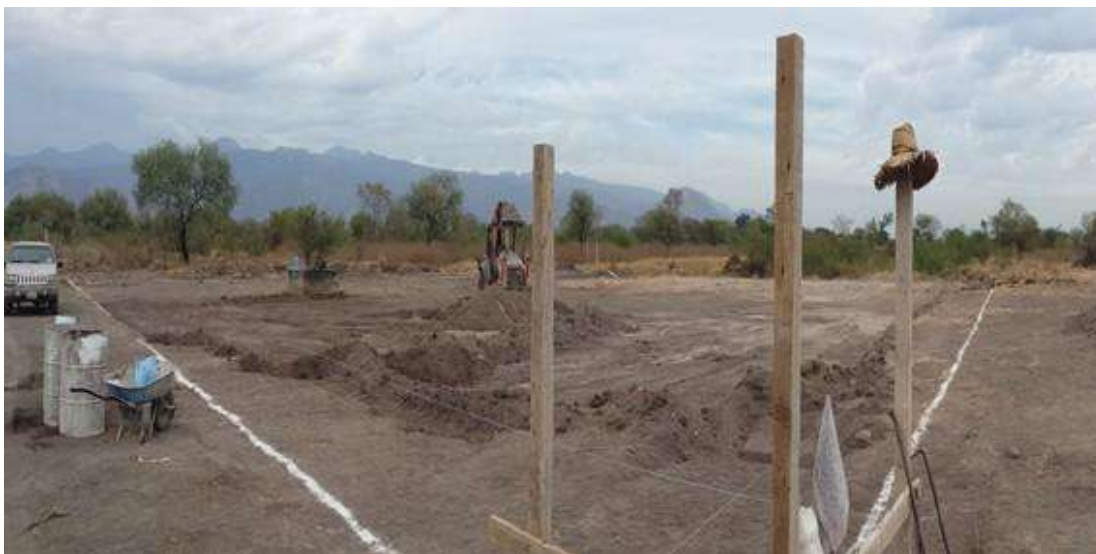
Trazo y nivelación del terreno.
