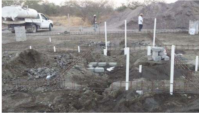
Colocación de tubo de PVC de diferentes diámetros para instalación sanitaria.
