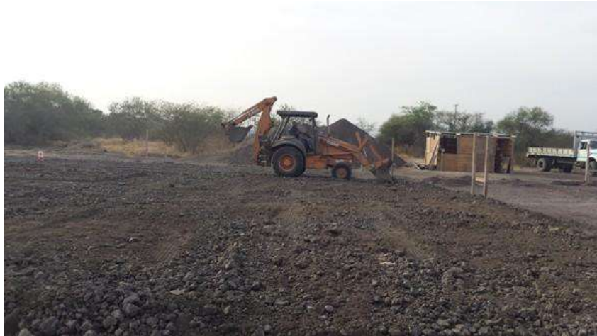
Mejoramiento de terreno con material filtro en una capa de 61 cm de espesor.
