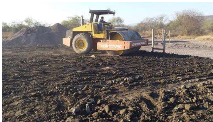
Compactación de material al 90 %.
