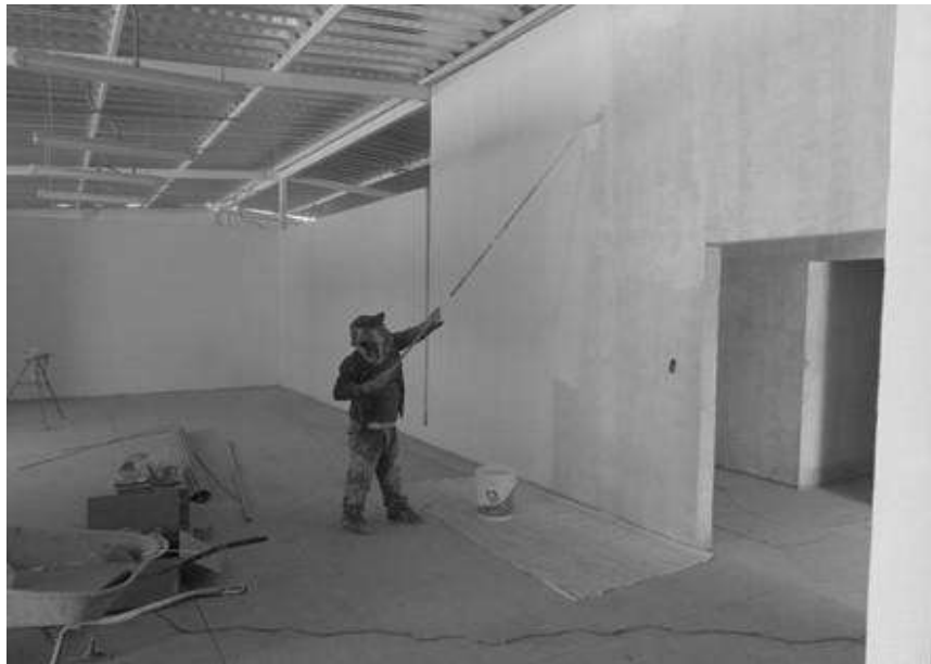
Colocación de pintura vinílica vinimex de comex en muros y plafones.
