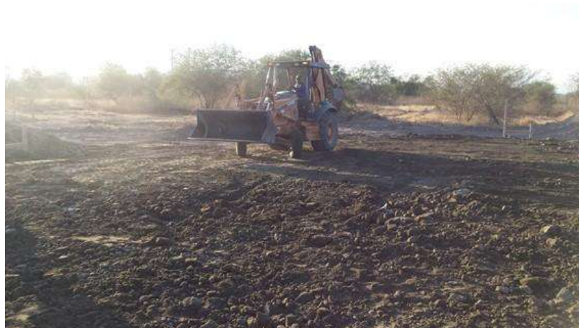
Mejoramiento de terreno con material cementante en capas de 20 cm de espesor.
