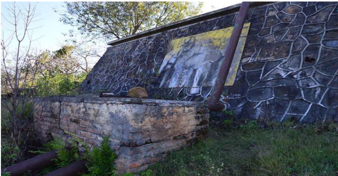
Fig. 4.4 Tanque semi enterrado de la población. Fuente: Marisa Anguiano. 2017
