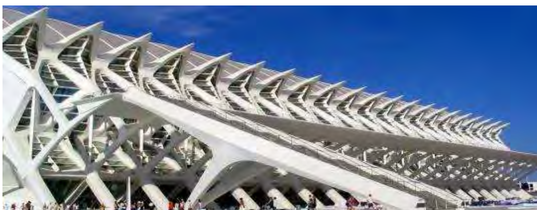
FIGURA. 2. 22. Construcción aplicando cemento blanco, otorga a cualquier proyecto un carácter exclusivo y diferenciador, una gran obra de hormigón vistosa, o en acabados superficiales y pequeños detalles.
