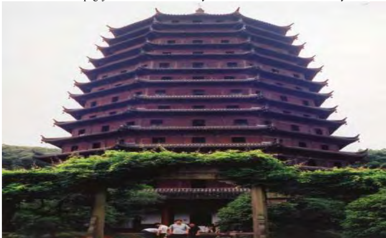
FIGURA. 2. 10. Pagoda Liuhe, o pagoda de las Seis Armonías, en Hangzhou, de 60 m de altura, erigida en 1156 y terminada en 1165. Fuente:
