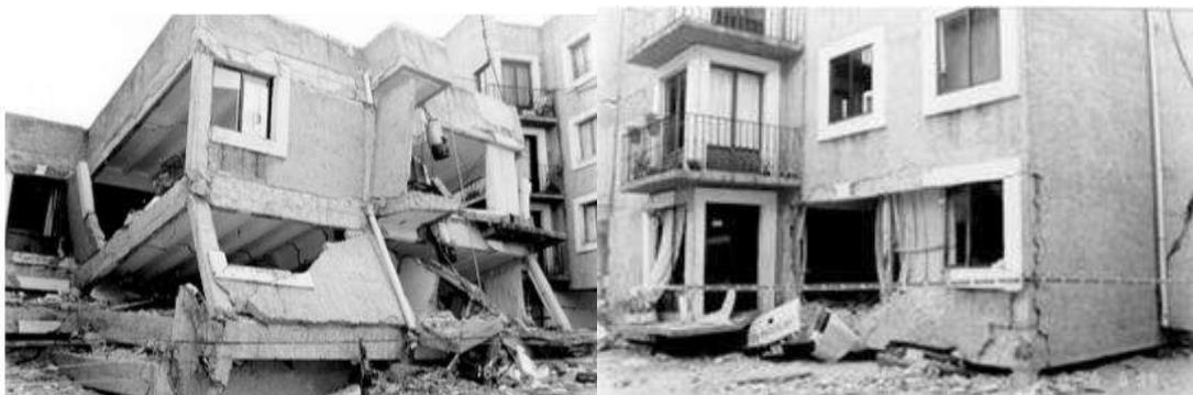
Figura 1.2 Edificios colapsados a consecuencia del sismo de Tehuacán del 15 de junio de 1999 (tomado de: Alcocer *et al.*, 1999).
