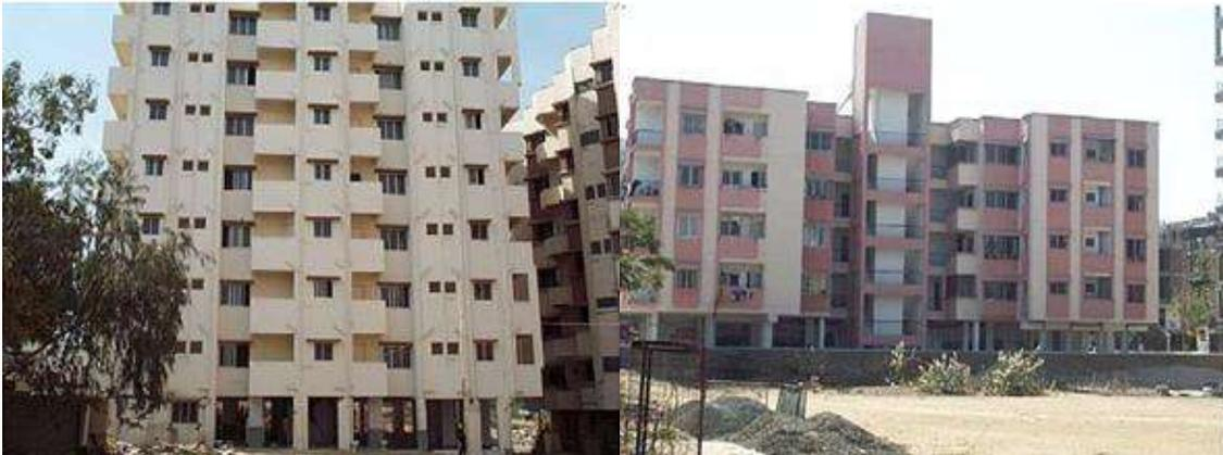
Figura 1.1 Ejemplos de edificios que cuentan con *planta baja débil* (tomado de: Miranda, 2005).
