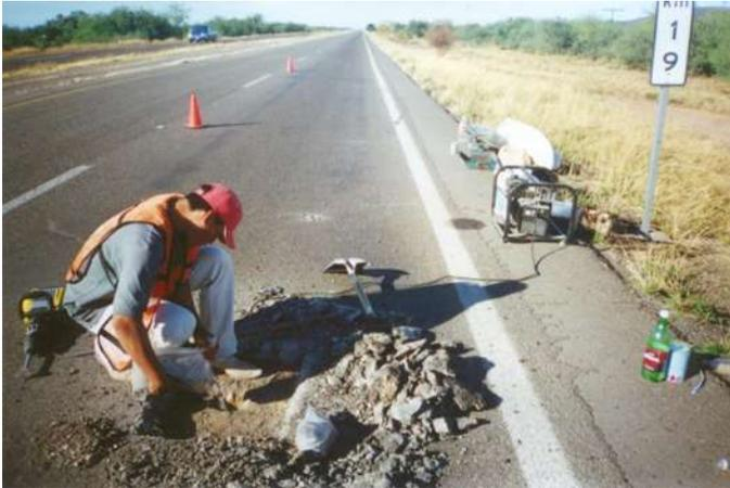
EN LA FOTOGRAFÍA SE OBSERVA LA EXPLORACION DE LA ESTRUCTURA DEL PAVIMENTO EN CUERPO "B" KM. 19+000 DE LA CARRETERA LIBRAMIENTO GUAYMAS.
