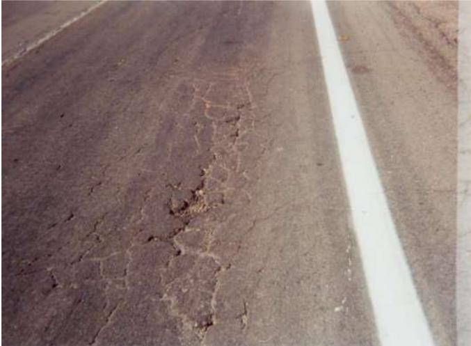
EN LA FOTOGRAFÍA SE OBSERVAN GRIETAS LONGITUDINALES Y PIEL DE COCODRILO EN EL KM 20+260 EN EL CARRIL DE BAJA VELOCIDAD.
