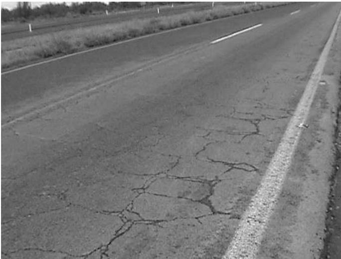
EN LA FOTOGRAFÍA SE OBSERVA LA FALLA TIPO PIEL DE COCODRILLO CON GRIETAS LONGITUDINALES Y TRANSVERSALES EN CUERPO "B" KM. 11+950 DE LA CARRETERA LIBRAMIENTO GUAYMAS.
