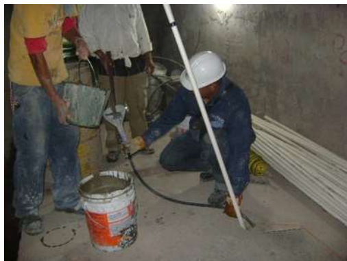
Foto 11. IV.3.3 Colocación de del relleno de lechada.
