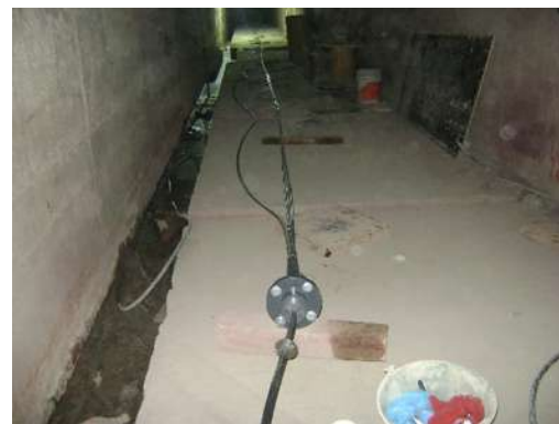
Foto 2. IV.3.2 Vista del extensómetro armado.
