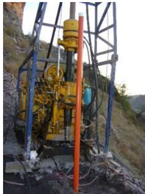
Foto 5. IV.3.5 Vista de la tubería colocada.
