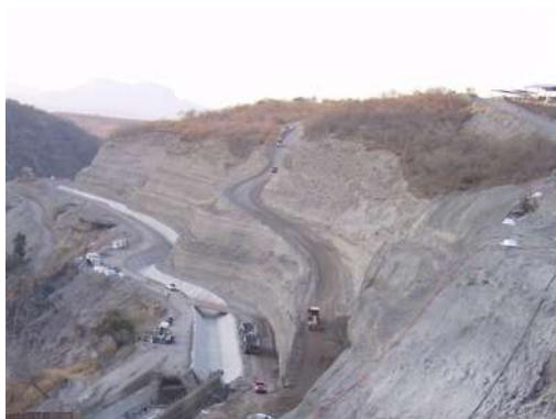
Foto 35. IV.2 Vista de los avances en la construcción del canal.
