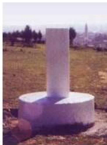
Foto 1. III.3.3.1.2.1 Tipo de monumento de centraje forzoso y bases y tapas.
