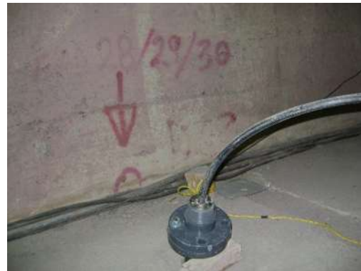
Foto 6. IV.3.2 Extensómetro preparado para su colocación.
