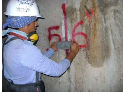
Foto 1 y 2. IV.3.4 Trabajos de colocación de los anclajes y de la placa para el medidor de juntas triortogonal.
