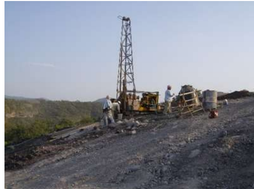
Foto 16. IV.2 Trabajos de perforación en la cortina de materiales graduados.
