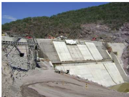
Foto 11 y 12. IV.2 Vista de los procesos de construcción de la cortina.
