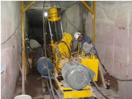
Foto 3. IV.3.2 Trabajos de perforación.
