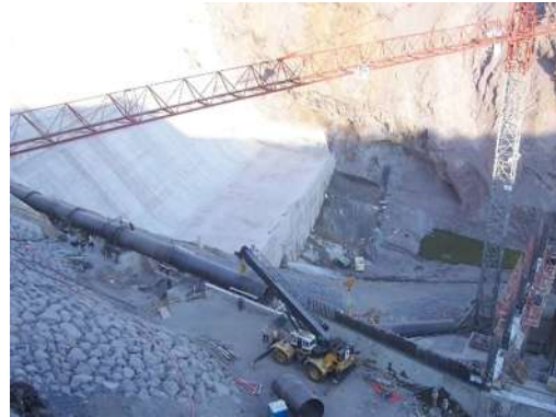
Foto 27 y 28. IV.2 Trabajos de colocación de la tubería en la margen derecha.
