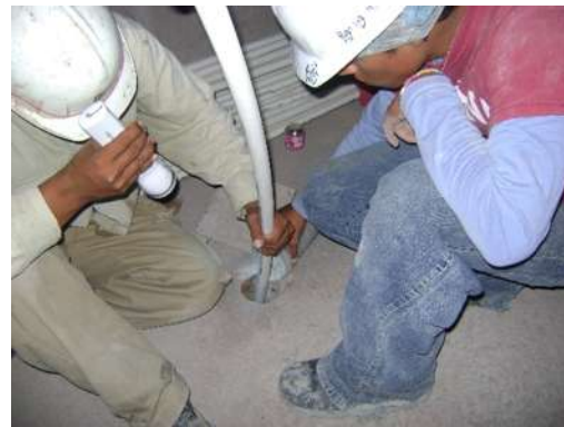
Foto 10. IV.3.3 Vista del piezómetro colocado y vaciado de las bolitas de bentonita.
