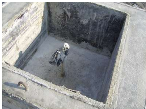
Foto 11. IV.3.6 Vista del registro colocado para la protección del piezómetro.
