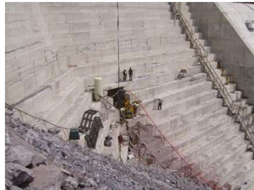
Foto 1 y 2. IV.3.3 Vista de la maniobra para colocar la perforadora en la entrada de la galería.
