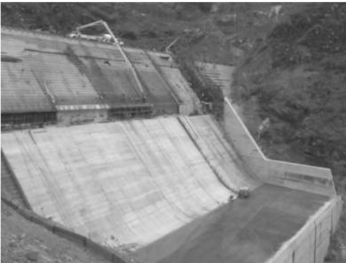
Foto 23 y 24. IV.2 Vista de los avances en la construcción del vertedor.
