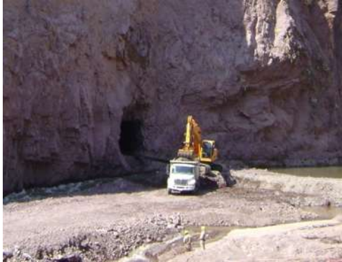
Foto 1. IV.2 Trabajos de excavación para el túnel de desvío.
