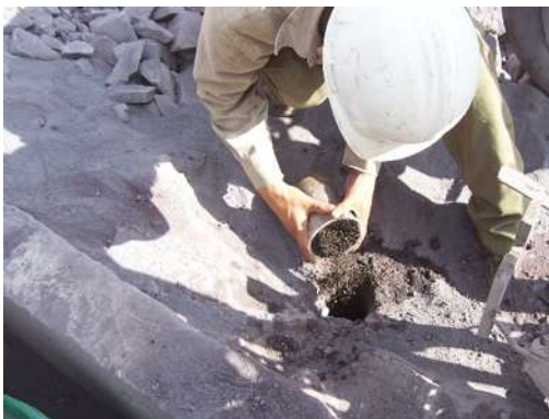
Foto 6. IV.3.6 Vaciado de la cama de arena para la instalación del piezómetro.
