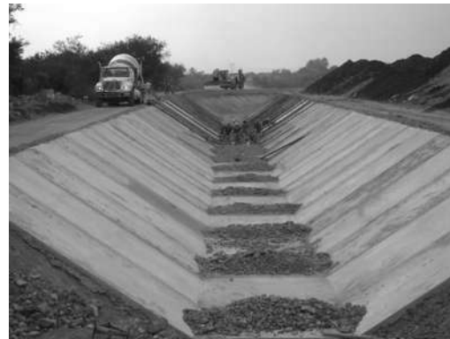
Foto 34. IV.2 Trabajos de colado en el canal.
