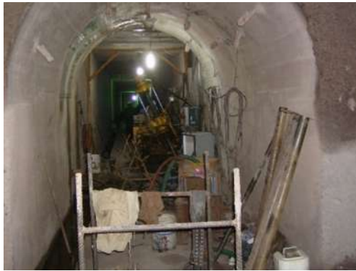
Foto 15. IV.2 Trabajos de perforación en la galería de drenaje.
