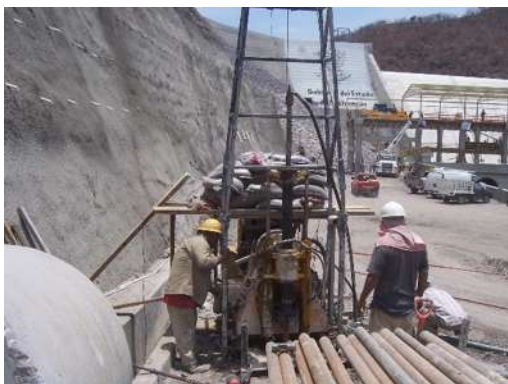
Foto 2 y 3. IV.3.6 Trabajos de perforación en la margen derecha e izquierda.
