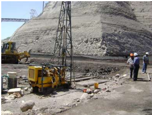
Foto 1. IV.3.6 Trabajos de perforación en la cortina de materiales graduados.
