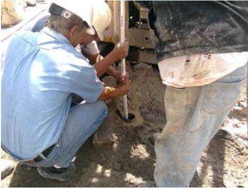
Foto 8. IV.3.6 Trabajos de Colocación de la arena.
