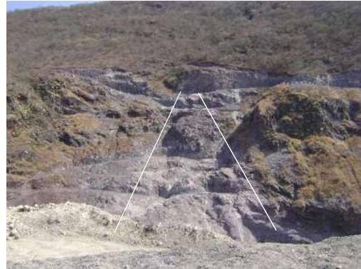
Foto 7 y 8. IV.2 Vista de los trazos realizados para el eje de la cortina.
