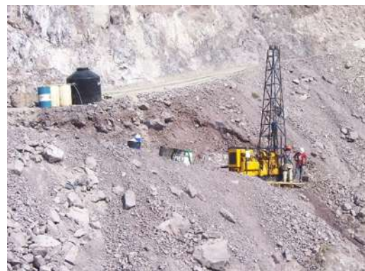
Foto 2 y 3. IV.3.6 Trabajos de perforación en la margen derecha e izquierda.
