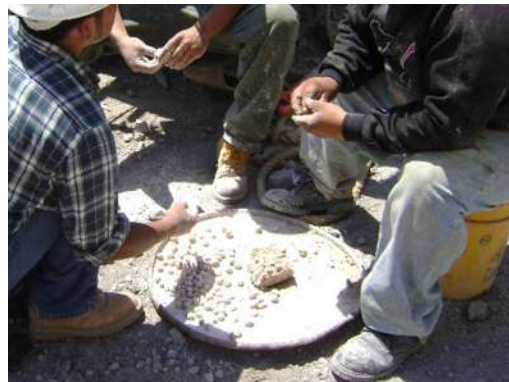
Foto 9. IV.3.6 Elaboración de las volitas de bentonita.
