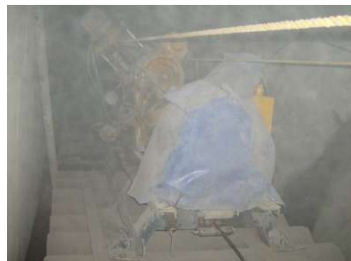
Foto 5 y 6. IV.3.3 Vista de los trabajos para bajar la perforadora a la galería 2.
