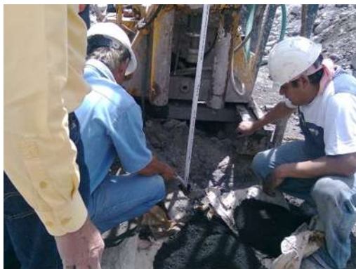
Foto 10. IV.3.6 Colocación de la lechada de cemento, arena y bentonita.
