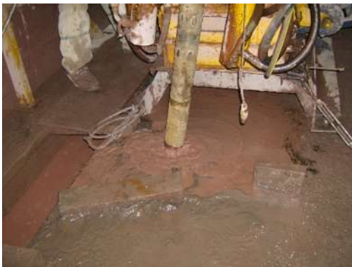
Foto 9. IV.3.3 Vista de los trabajos de perforación.
