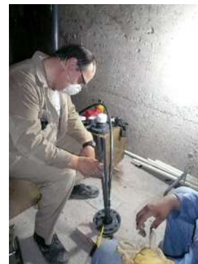
Foto 7. IV.3.2 Trabajos de colocación del extensómetro.
