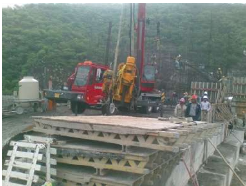
Foto 1 y 2. IV.3.3 Vista de la maniobra para colocar la perforadora en la entrada de la galería.
