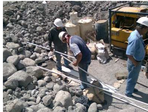
Foto 5. IV.3.6 Trabajos de pegado de la tubería.
