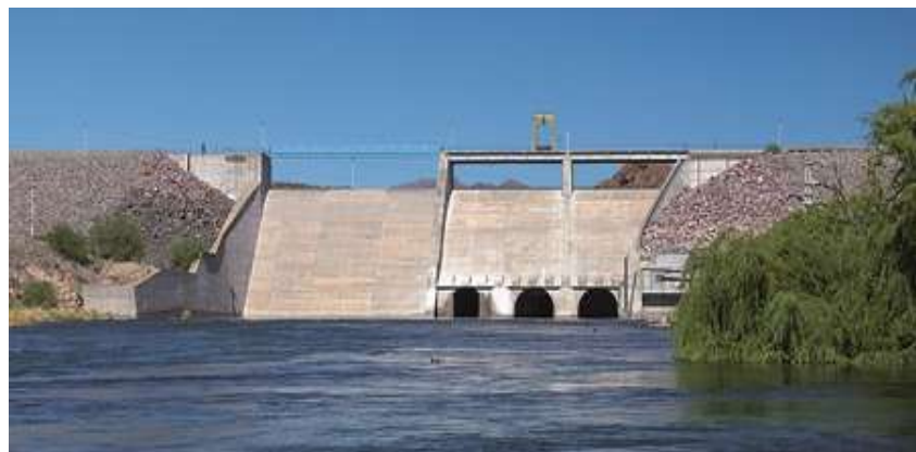
Foto 2. III.1.1.3 Presa de Materiales graduados a los lados y de hormigón de gravedad en el vertedero.
