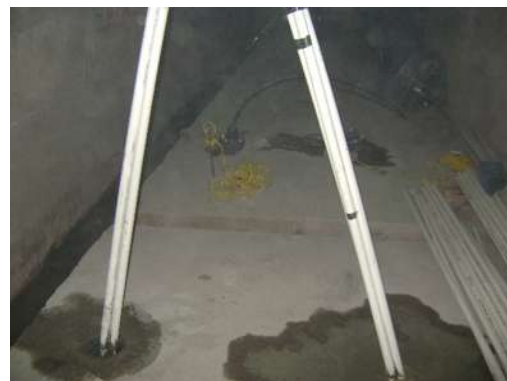
Foto 12. IV.3.3 Vista de los piezómetro colocados.
