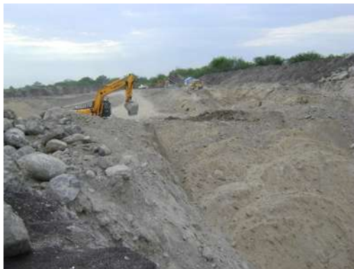
Foto 33. IV.2 Trabajos de excavación para el canal de riego.
