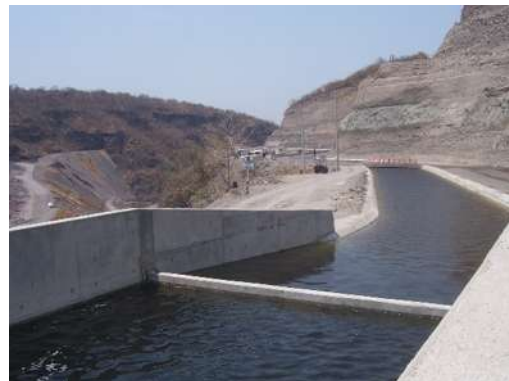
Foto 36. IV.2 Vista del canal en funcionamiento.
