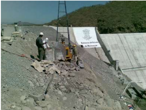
Foto 1. IV.3.5 Trabajos de perforación para la instalación de los inclinómetros.
