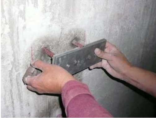
Foto 1 y 2. IV.3.4 Trabajos de colocación de los anclajes y de la placa para el medidor de juntas triortogonal.
