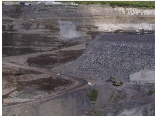
Foto 37. IV.2 Vista del inicio de los trabajos de construcción para la casa de máquinas.
