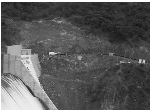
Foto 31 y 32. IV.2 Vista de la tubería colocada en la margen izquierda.
