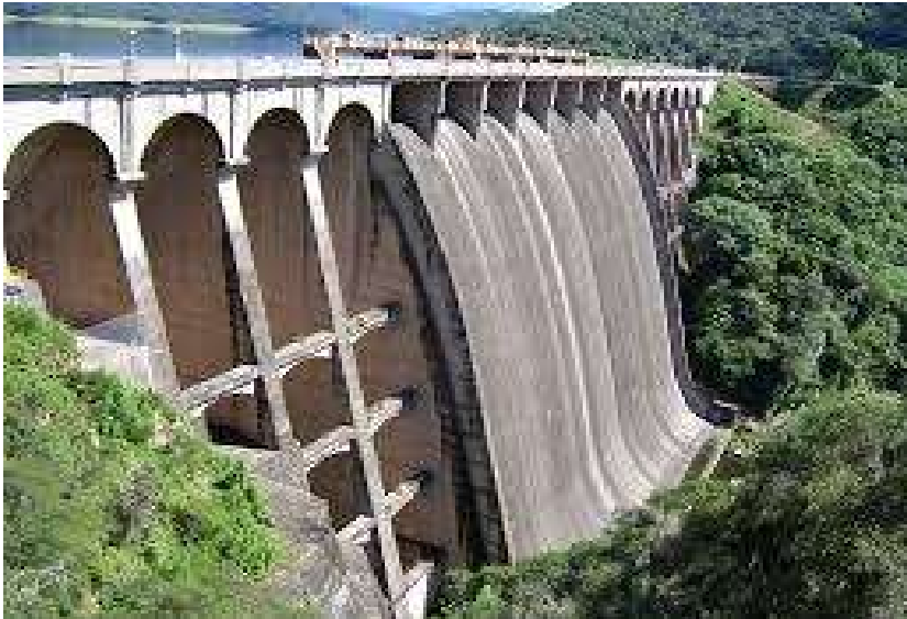
Foto 1. III.1.1.3 Presa contrafuerte y vertedor de hormigón de gravedad en el vertedero.
