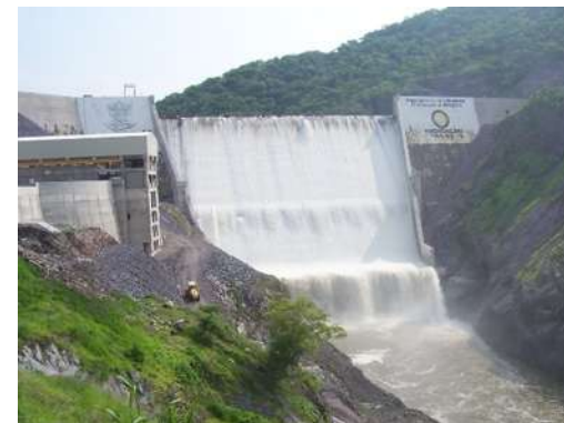
Foto 25 y 26. IV.2 Vista del vertedor terminado y del funcionamiento.
