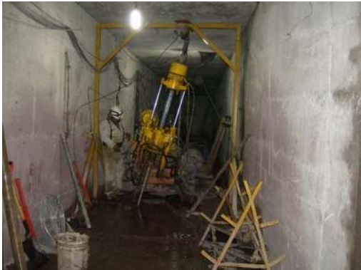
Foto 3. IV.3.3 Trabajos de perforación en la galería 1.
