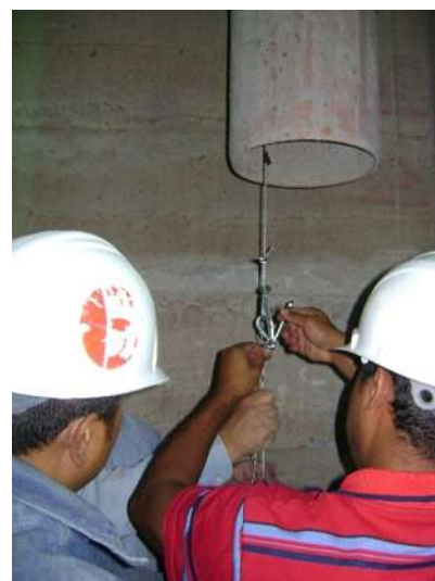
Foto 1 y 2. IV.3.1 Vista de los trabajos de colocación del péndulo directo.
