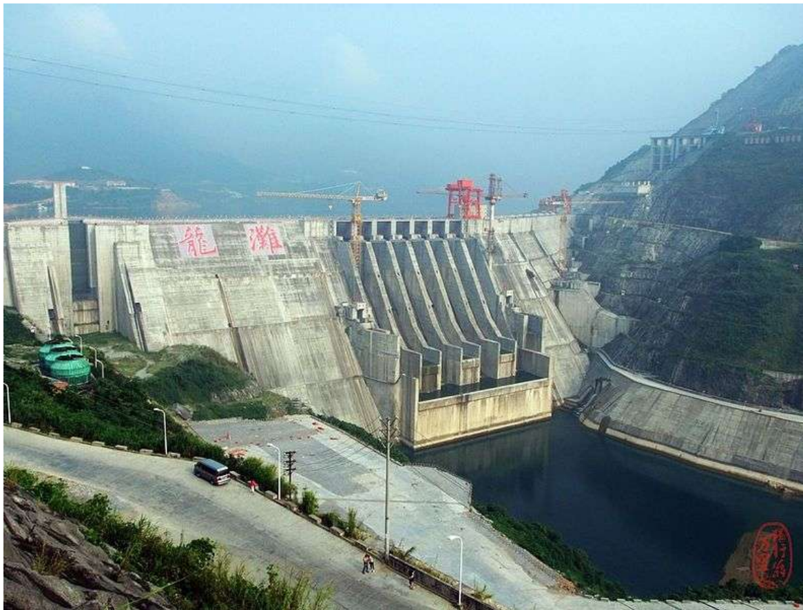
Foto 1. III.1.1.2.5 Presa Longtan ubicada en el río Hongshui en China, altura de 216.5 m, longitud de 849 m y un volumen de 7.67 millones de m 3 .
