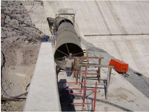
Foto 27 y 28. IV.2 Trabajos de colocación de la tubería en la margen derecha.
