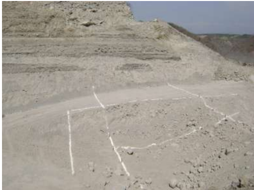
Foto 7 y 8. IV.2 Vista de los trazos realizados para el eje de la cortina.
