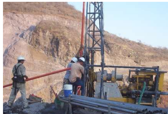
Foto 3 y 4. IV.3.5 Trabajos de instalación de la tubería.
