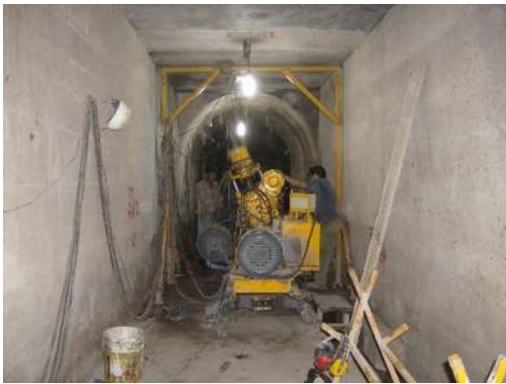
Foto 7 y 8. IV.3.3 Vista de los trabajos de perforación en la galería 2.
