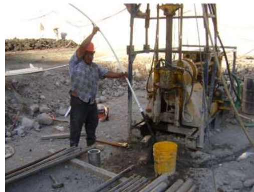
Foto 7. IV.3.6 Vista de la colocación del piezómetro.
