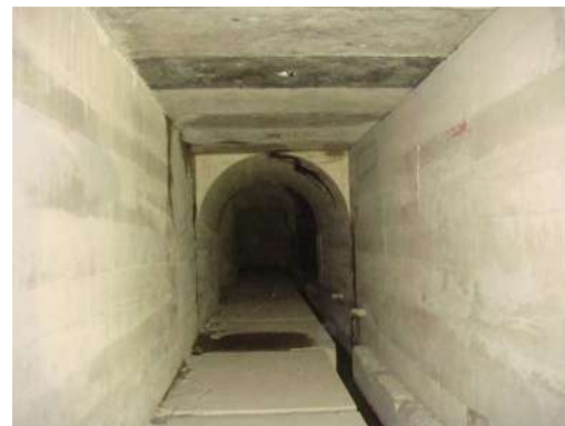
Foto 13 y 14. IV.2 Vista en el interior de la galería de drenaje.
