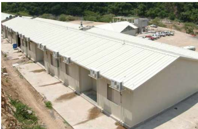
Figura: Instalaciones provisionales (Oficina construcción-administración)
