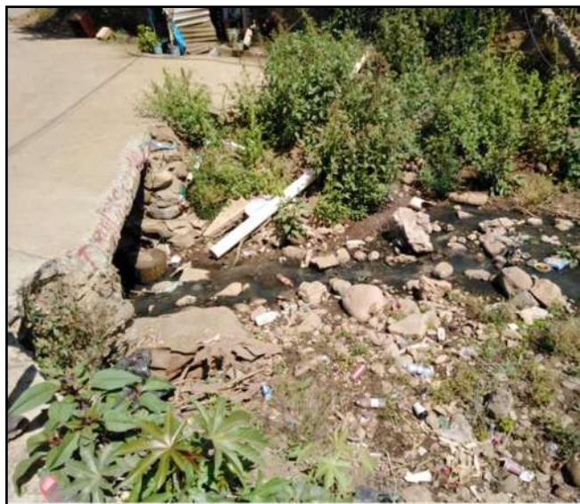
FIGURA 4-9 FOTOGRAFÍA REAL, SECCIÓN TRANSVERSAL DEL PUENTE #2 DESPUÉS DE LA INUNDACIÓN.
