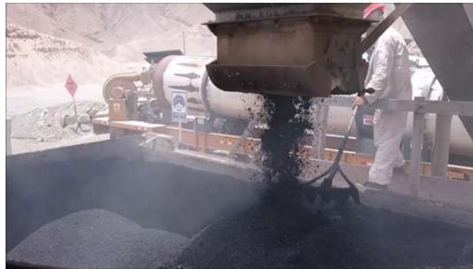
FIGURA 4.- ELABORACIÓN DE MEZCLAS ASFÁLTICAS EN CALIENTE (GUTIÉRREZ, 2018) [10/07/2019]
