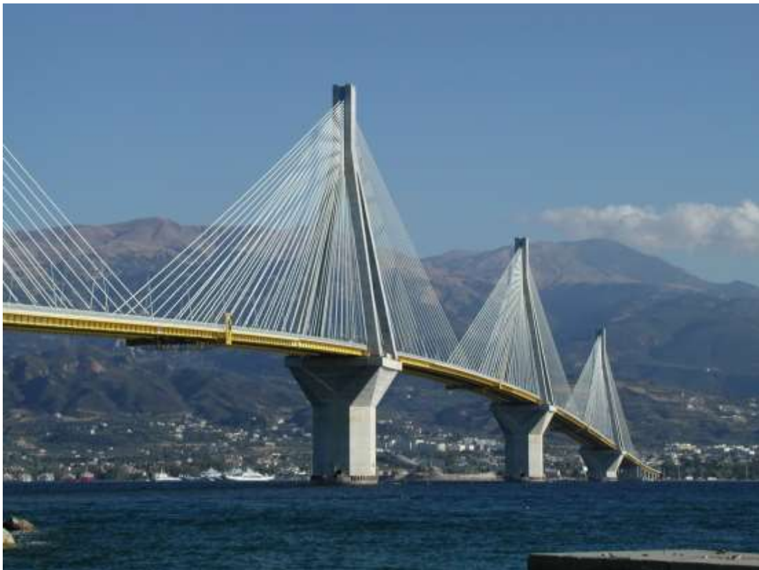
Figura 73: Puente Rion Antirion (Fuente: FIP INDUSTRIALE 2004)
