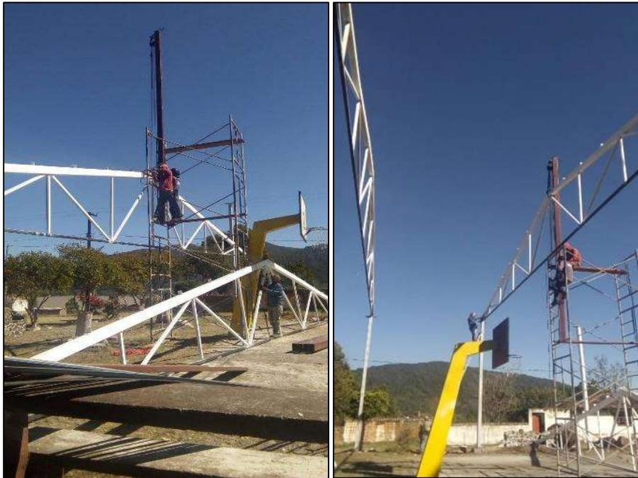
**Figura 18.** Levantamiento e instalación de las armaduras.
