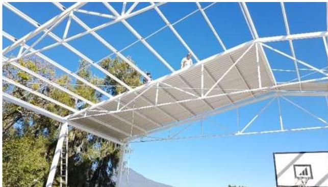
**Figura 24.** Se colocan la lámina monóticamente partiendo de un costado.
