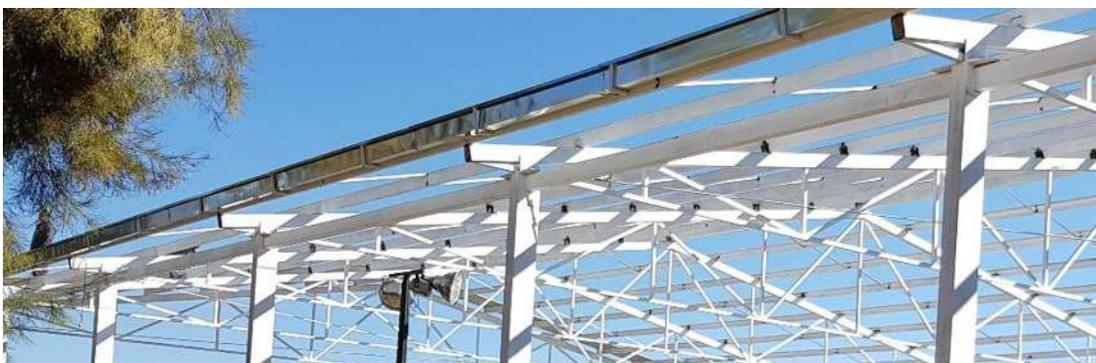
**Figura 25.** Canaleta galvanizada, instalada en armadura a la dirección de los largueros.
