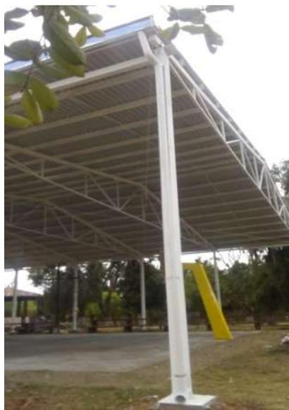
**Figura 26.** Cuatro bajadas de PVC 4" con 3 codos de 90°.
