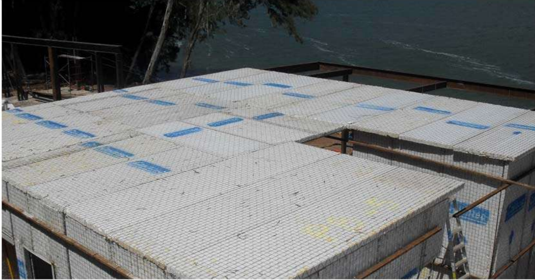
Figura 30- PRENSAMBLADO DE LA LOSA CON PANEL MG ®
