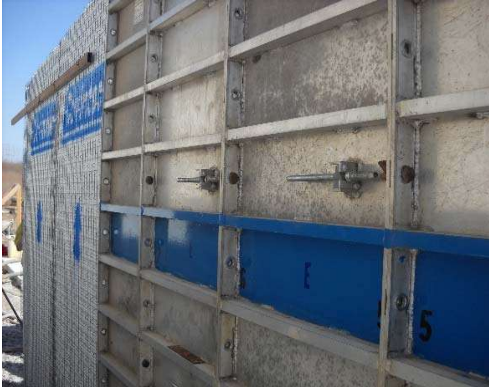
Figura 15- SIMBRADO DE MOLDES
