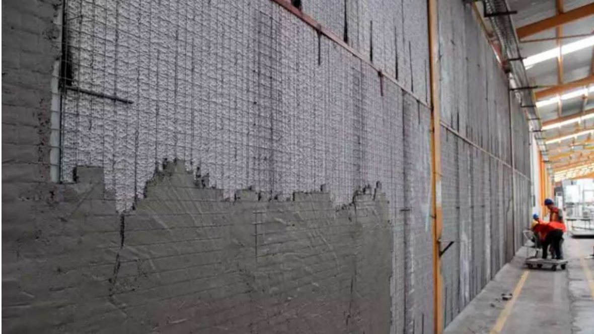
Figura 36- MORTERO EN LECHO INFERIOR DE LA LOSA
