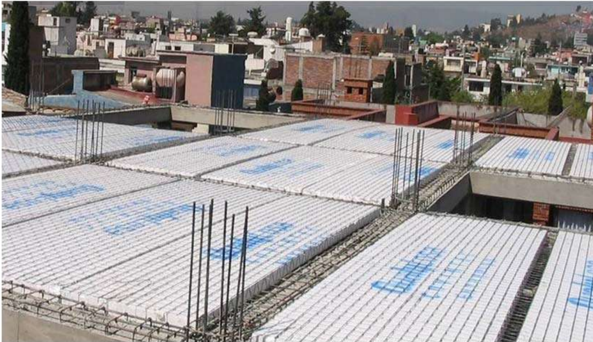
Figura 31- ARMADO DE LA LOSA.
