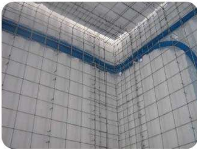
Con tubería flexible
