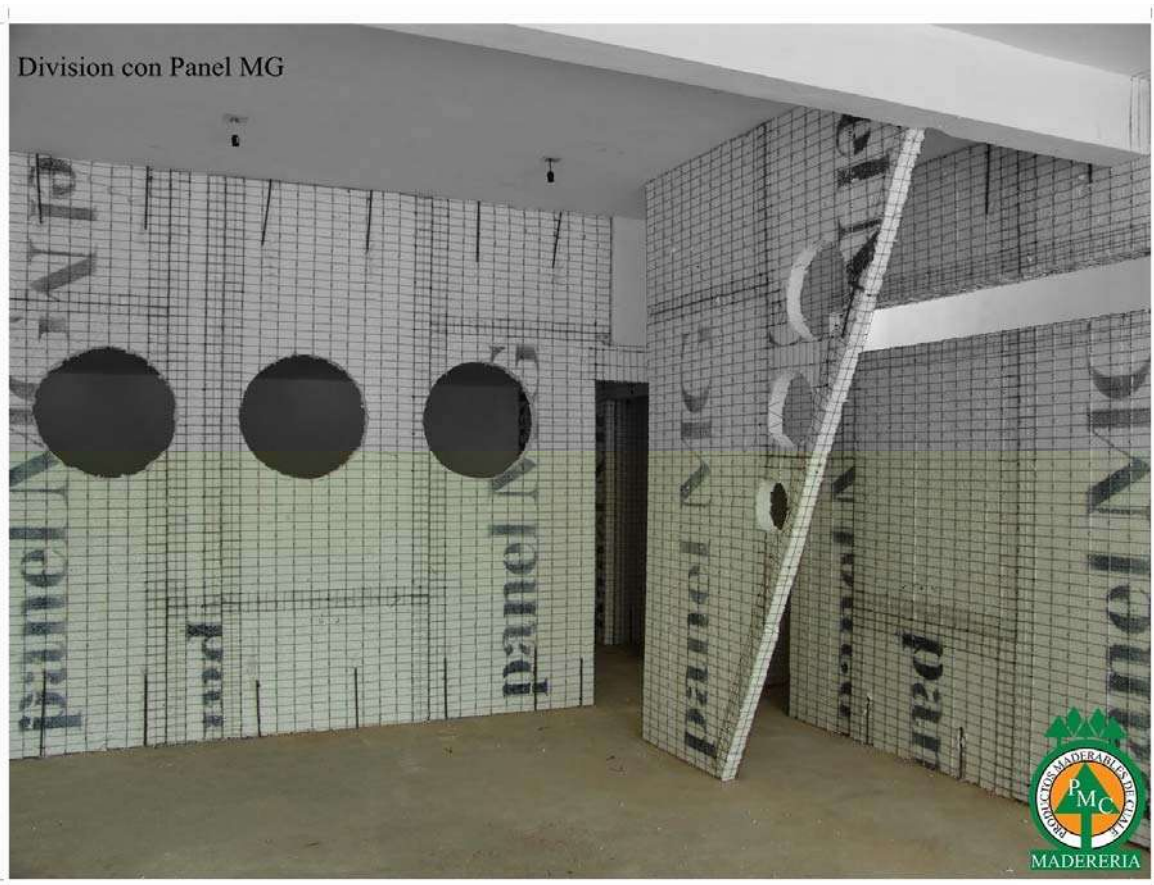
Figura 27- ENSAMBLE DE MUROS
