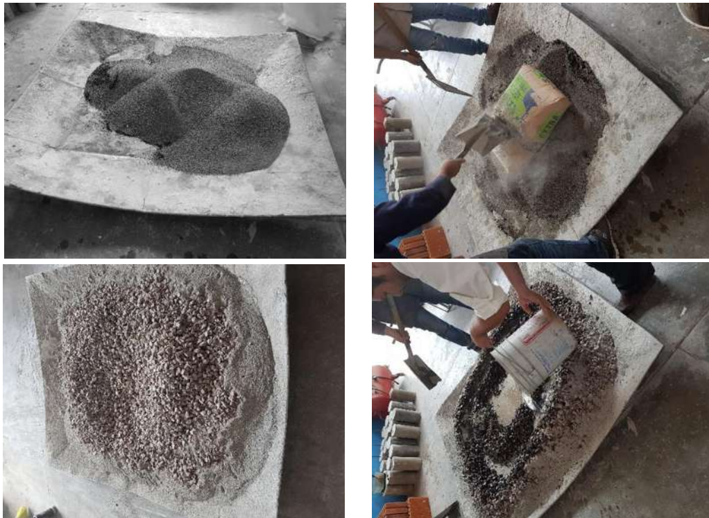
Ilustración 54. Elaboración del concreto
