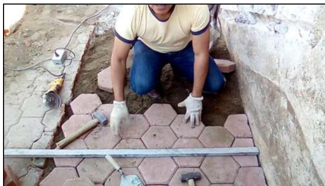
FIG. 18 Colocación de adocreto hexagonal.
