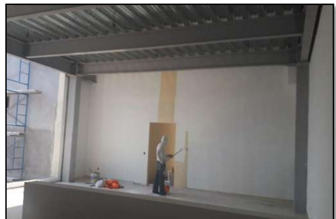
FIG. 23 Pintura en muros
