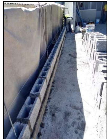
FIG. 12 Muro de block de concreto
