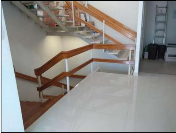
FIG. 21 Pasamanos de escalera de madera.
