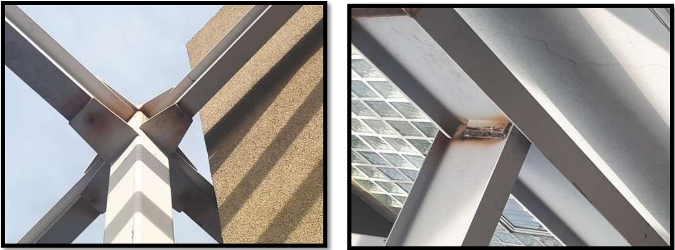
FIG. 16 Placas de conexiones de acero estructural.
