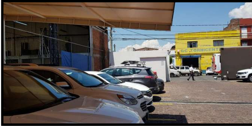
FIG. 3 Toldo de estacionamiento
