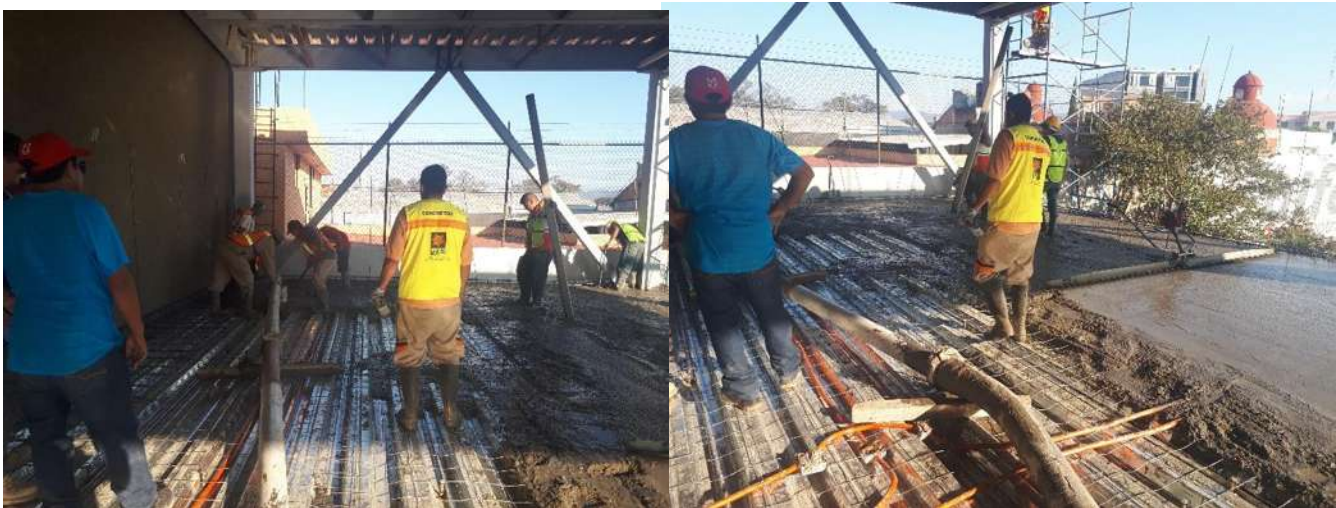
FIG. 15 Colado del entrepiso de losacero.
