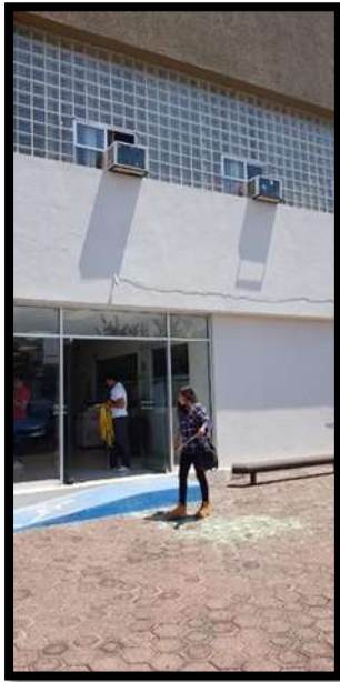
FIG. 2 Desmantelamiento de cancelería.
