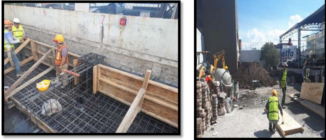
FIG. 7 Cimbra y descimbra, de zapatas, contratrabes y dados de cimentación.
