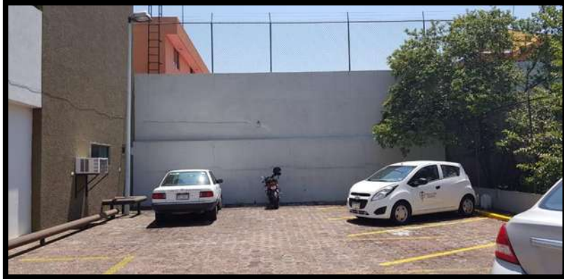
FIG. 1 Desmantelamiento del área de estacionamiento
