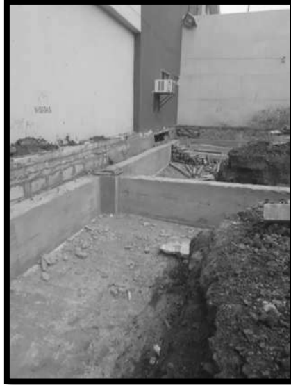
FIG. 11 Cadena de desplante de concreto
