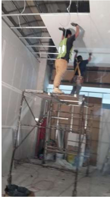
FIG. 20 Instalación de Plafones
