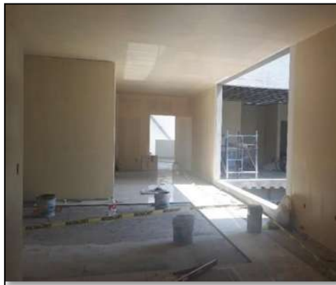
FIG. 19 Colocación de piso de loseta cerámica.
