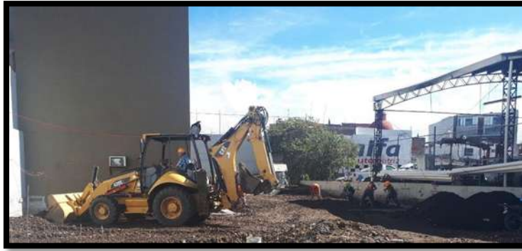
FIG. 5 Excavación en cepas en material tipo II
