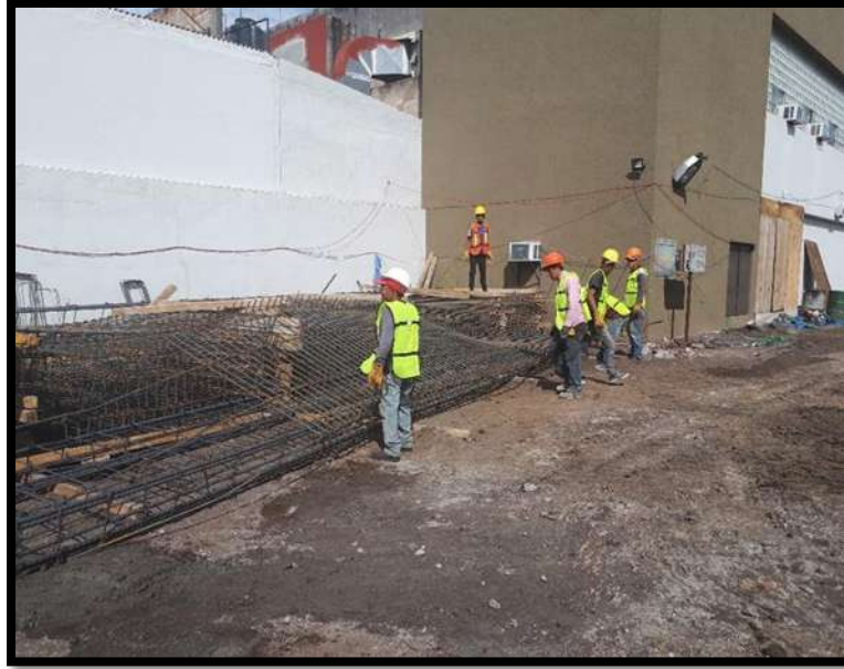
FIG. 8 Acero de refuerzo f'y = 4200 \text{ kg/cm}^2
