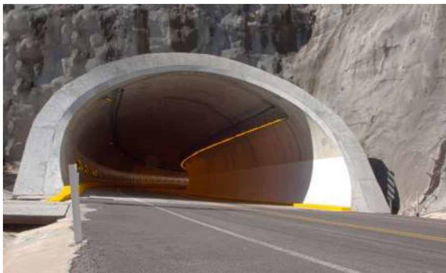
Figura 2. Túnel carretero de la autopista Durango-Mazatlán (Cortesía grupo OMEGA)
