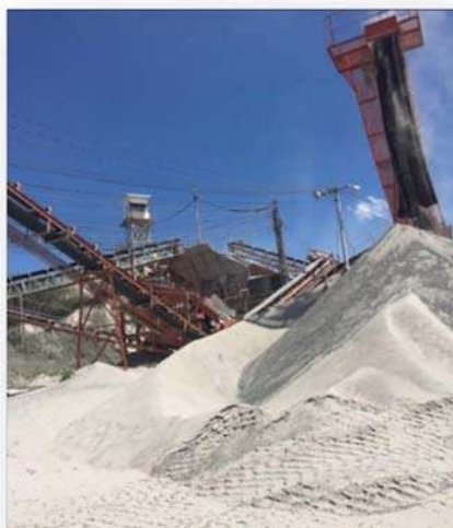
Figura 5.4.2 Banco de material triturado. Fuente: Elaboración propia
