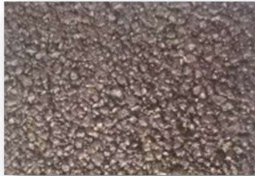
Figura 3.3.3 Mezcla asfáltica tipo SMA puesta en un pavimento.
