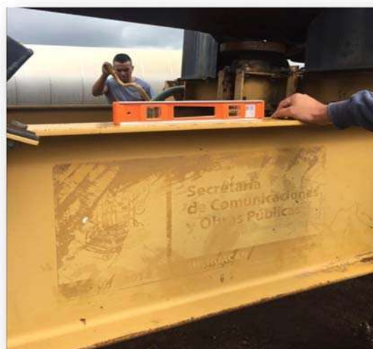
Figura 5.3.3.7 Nivelación de la base de los equipos. Fuente: Elaboración propia
