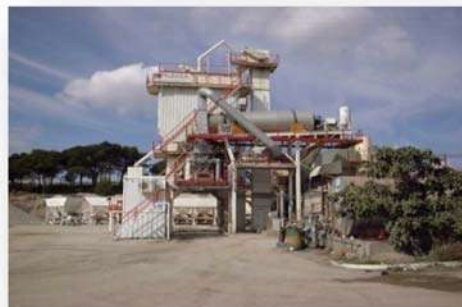
Figura 4.3.1.5 Planta discontinua con doble tambor secador para calentamiento del RAP de la empresa PABASA.
