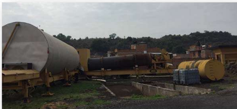
Figura 5.1.10 Fosa de lodos en la planta asfáltica. Fuente: Elaboración propia.
