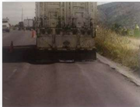
Figura 2.1.3 Falla por roderas. Fuente: Manuel Tinoco Zamudio, Historia y evolución de las mezclas asfálticas en las carreteras de México.
