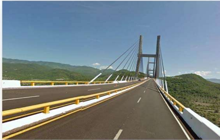
Figura 1.4 Carretera del Sol. Fuente: www.rafaelprietoc.wordpress.com
