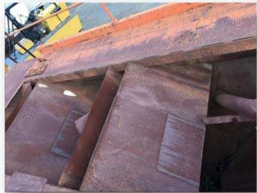
Figura 4.3.7 Tolva sub dividida. Fuente: Elaboración propia
