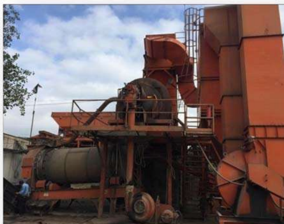
Figura 4.3.31 Planta asfáltica con dos barriles. Fuente: Elaboración propia
