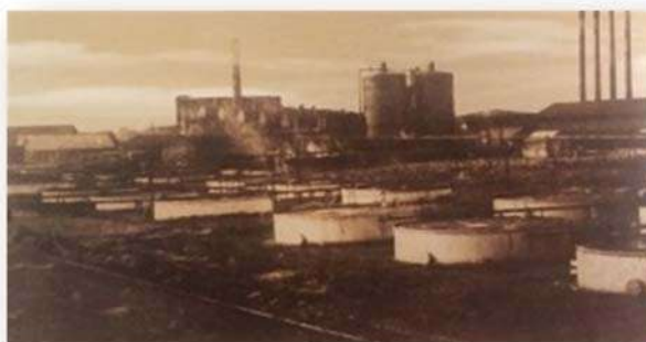
Figura 3.1.2 Refinería "El Águila" en Ciudad Madero, Tamaulipas, elaboradora del primer producto asfáltico en México.
