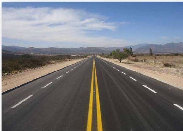
Figura 1.5 Carretera México - Nogales. Fuente: www.obrasweb.mx/construcción
