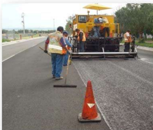
Figura 3.3.5 Colocación de una capa con microaglomerado. Fuente: www.amaac.org.mx
