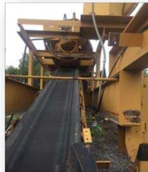
Figura 5.1.4 Banda transportadora de agregado. Fuente: Elaboración propia
