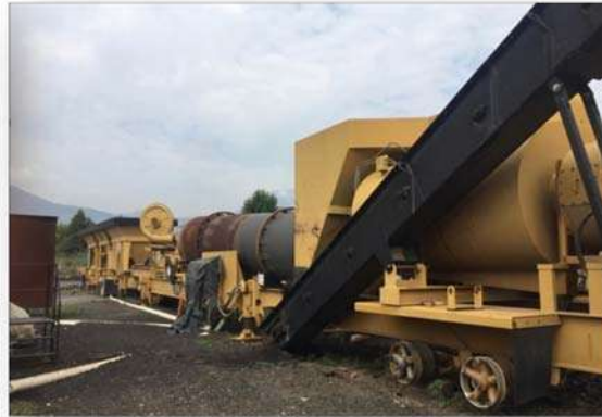
Figura 5.1.2 Planta asfáltica en estudio. Fuente: Elaboración propia
