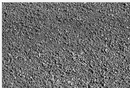
Figura 3.3.2 Mezcla asfáltica de granulometría abierta puesta en un pavimento.
