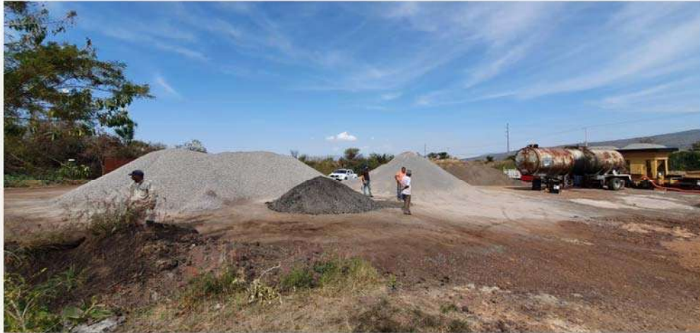
Figura 5.4.4 Acopio de agregados petreos dentro de la zona de la planta asfáltica. Fuente: Elaboración propia
