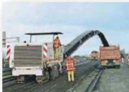
Figura 4.3.1.1 Fresadora obteniendo RAP de un pavimento envejecido.
