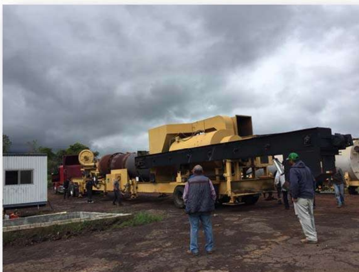
Figura 5.3.3.8 Colocación del tambor secador. Fuente: Elaboración propia
