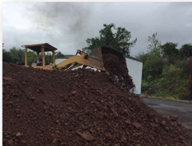
Figura 5.3.3.4 Elaboración de la rampa alimentadora. Fuente: Elaboración propia
