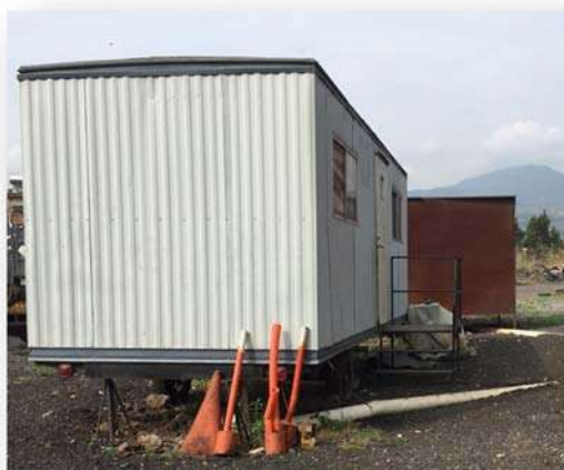
Figura 5.1.14 Cabina de control. Fuente: Elaboración propia.
