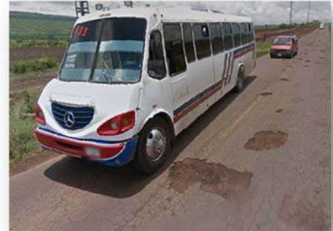
Figura 2.1.2 Baches generados por fatiga. Fuente: www.googlemaps.com
