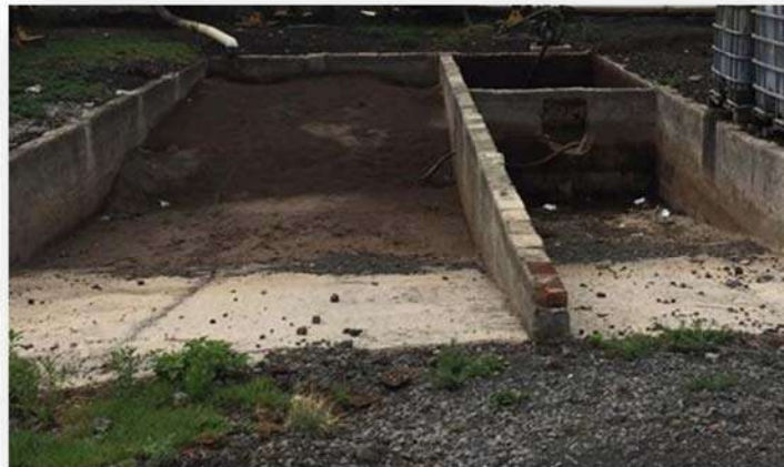
Figura 4.1.5 Fosa de lodos, vista delantera. Fuente: Elaboración propia.
