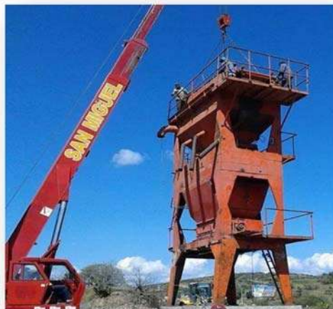
Figura 4.3.5 Colocación de la planta dosificadora. Fuente: Pavimentos Asfálticos Tres Marías S.A de C.V.
