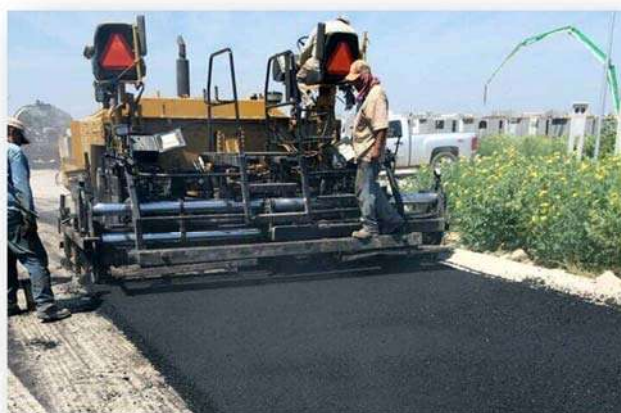
Figura 3.3.6 Colocación de carpeta. Fuente: www.aguayo.com.do
