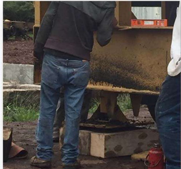
Figura 5.3.3.6 Colocación de durmientes para calzar el chasis de la planta. Fuente: Elaboración propia
