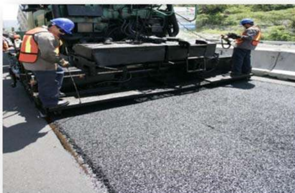
Figura 3.3.4 Colocación de mezcla tipo CASAA. Fuente: www.amaac.org.mx
