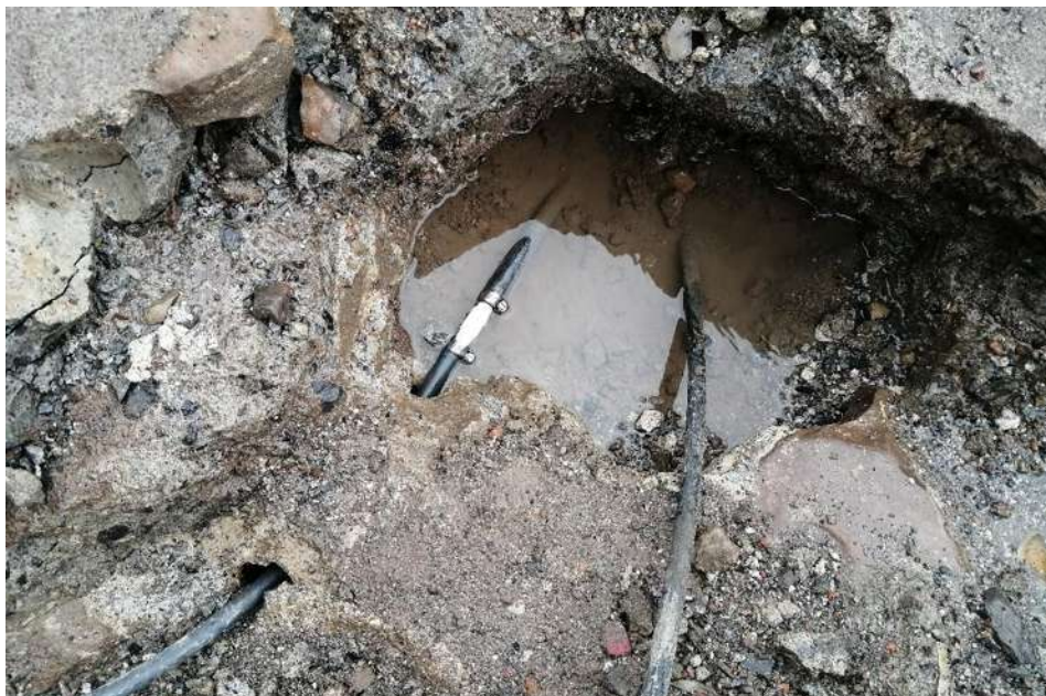
Figura: 4. 1. Conexión red a toma domiciliaria (agua potable) en el municipio de Zurumbeneo.
