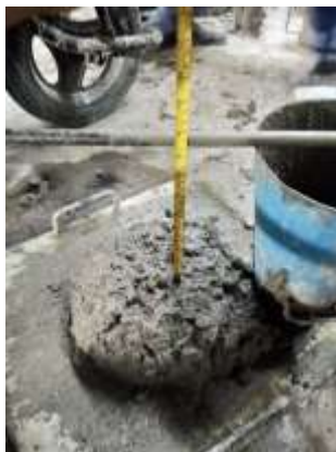
Ilustración 46. Revenimiento de mezcla “Fibra-Aditivo” (Fotografía Joana Enríquez).
