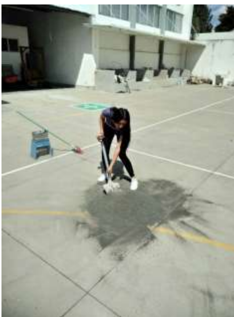
Ilustración 8. Colocación del agregado en una superficie limpia (Fotografía Joana Enríquez).
