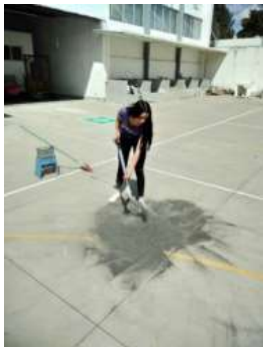
Ilustración 9. Homogenización del material (Joana Enríquez).
