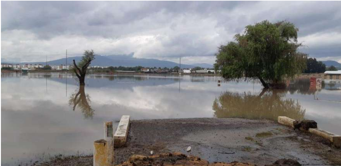
Imagen 4. Afectación a las canchas de la Unidad Deportiva Cuauhtémoc en noviembre de 2018 (Herrera, 2018).
