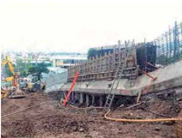
Fig. 41. Cimbra en muro. Fuente: foto tomada por autor. 14 de julio de 2016.
