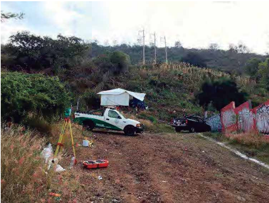
Fig. 15. Trazo y nivelación de la superficie de terreno natural, vista noroeste. Fuente: foto tomada por autor.
