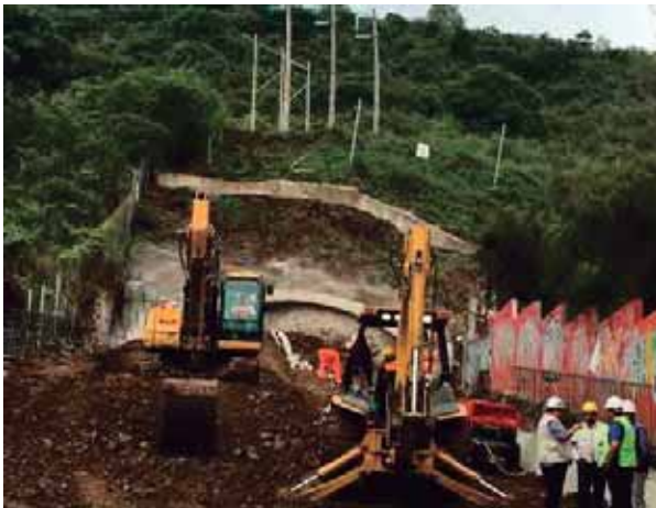
Fig. 35. Excavación en túnel. Fuente: foto tomada por autor. 21 de junio de 2016.
