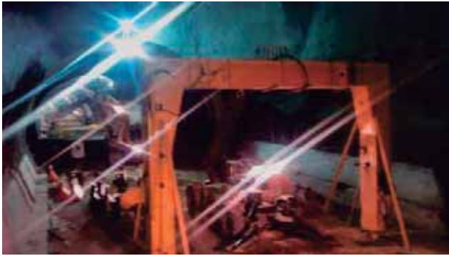
Fig. 74. Carro en túnel. Fuente: foto tomada por autor.
