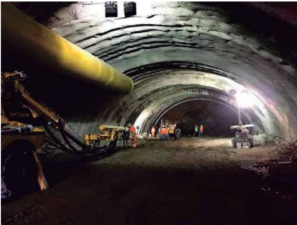
Fig. 57. Excavación de túnel. Fuente: foto tomada por autor. 23 de septiembre de 2016.
