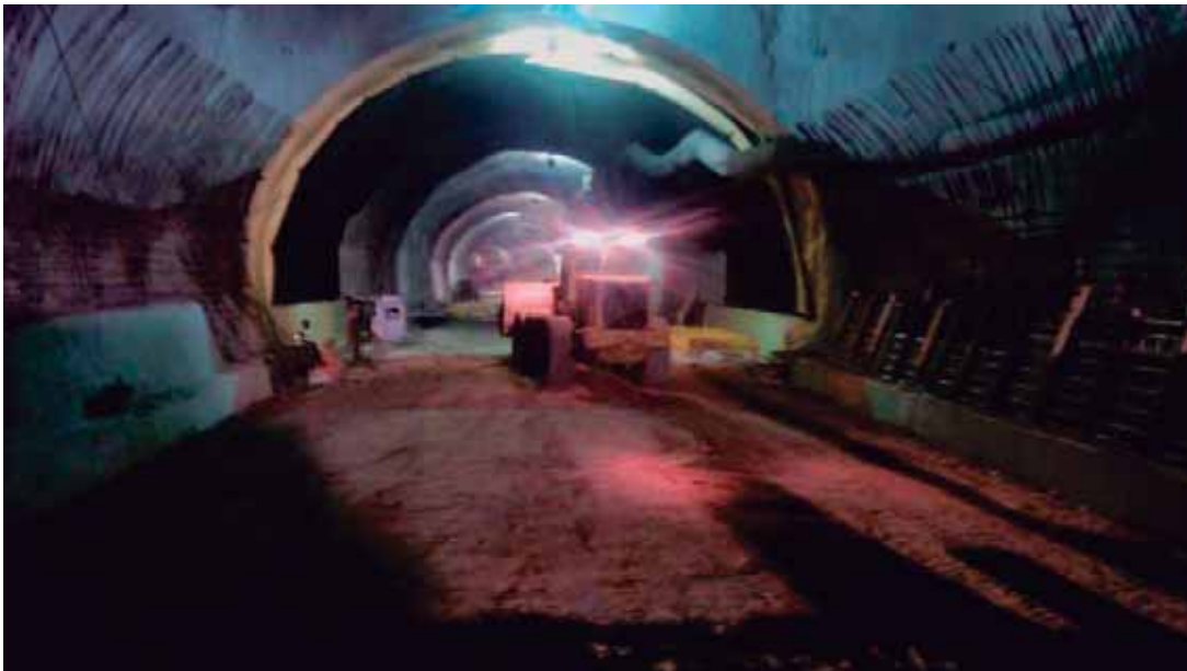
Fig. 73. Cimbra en muro. Fuente: foto tomada por autor.
