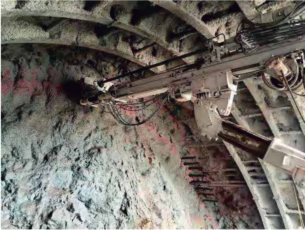
Fig. 40. Excavación de túnel. Fuente: foto tomada por autor. 12 de julio de 2016.
