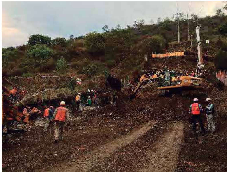
Fig. 17. Excavación superficie de terreno natural, vista noroeste. Fuente: foto tomada por autor.
