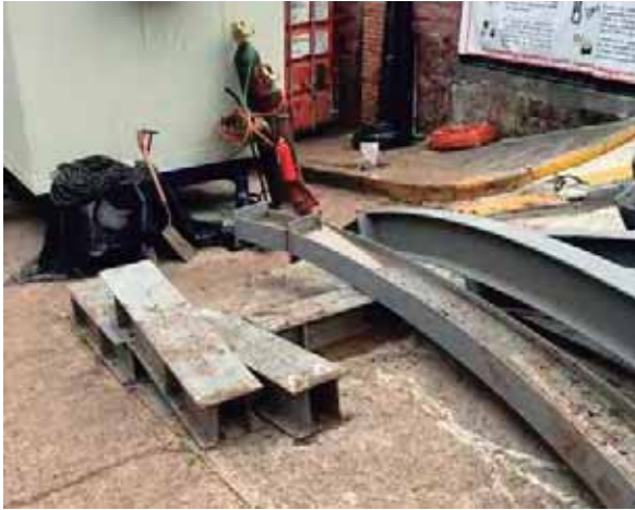
Fig. 46. Perfiles metálicos. Fuente: foto tomada por autor. 18 de julio de 2016.
