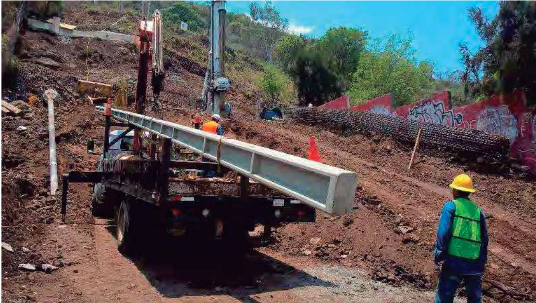
Fig. 26. Colocación de malla electrosoldada para terreno natural y armado de acero reforzado para perforación. Fuente: foto tomada por autor.
