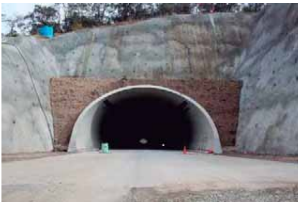
Fig. 79. Instalaciones en túnel. Fuente: foto tomada por autor.
