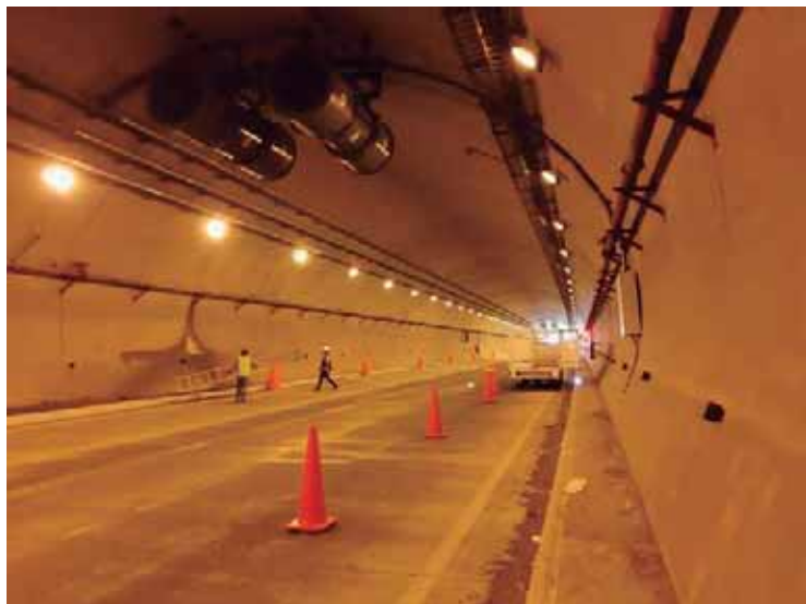
Fig. 89. Ventiladores en túnel. Fuente: foto tomada por autor. 23 de enero de 2019.
