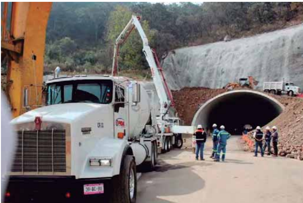
Fig. 84. Colocación de concreto en losa de cuarto de máquinas. Fuente: foto tomada por autor. 27 de octubre de 2018.
