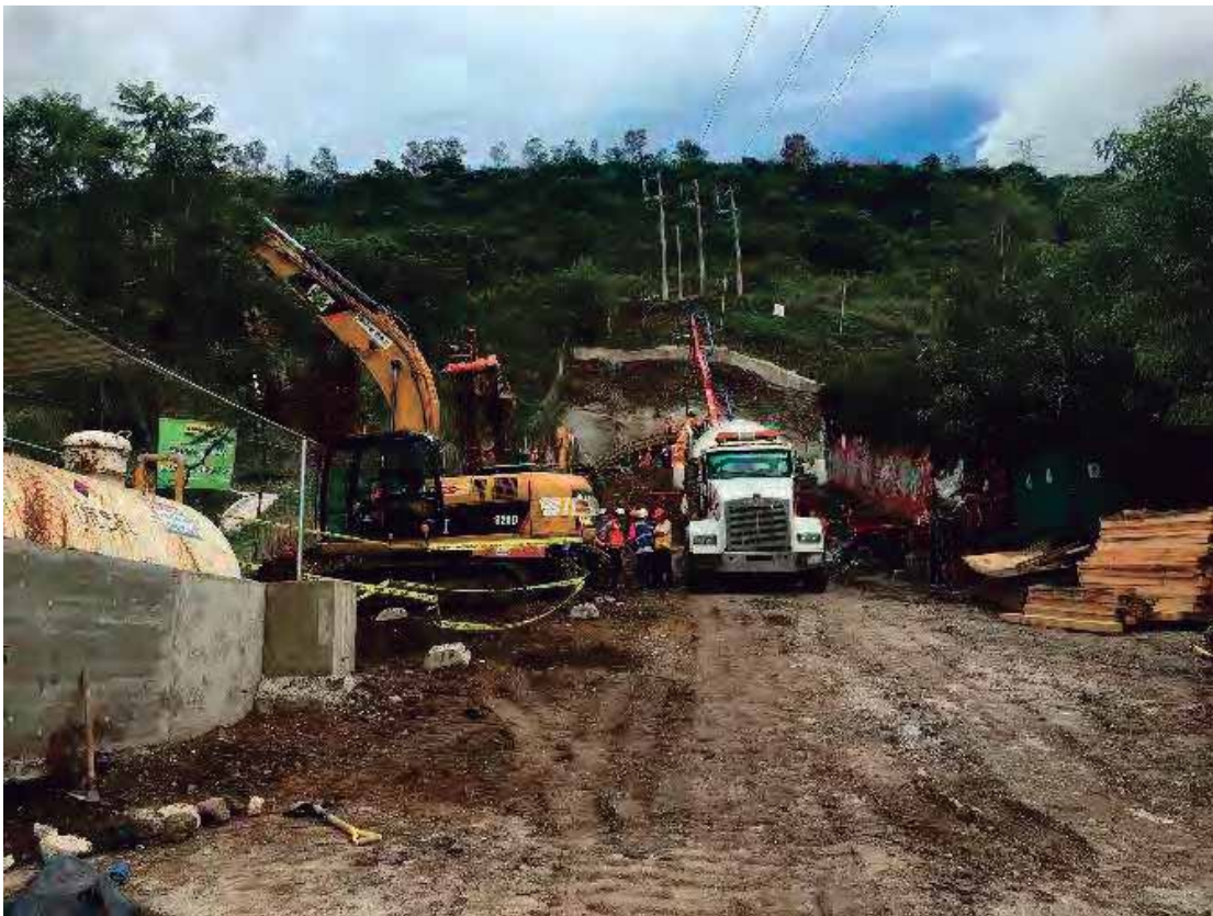
Fig. 27. Colocación de concreto lanzado. Fuente: foto tomada por autor.
