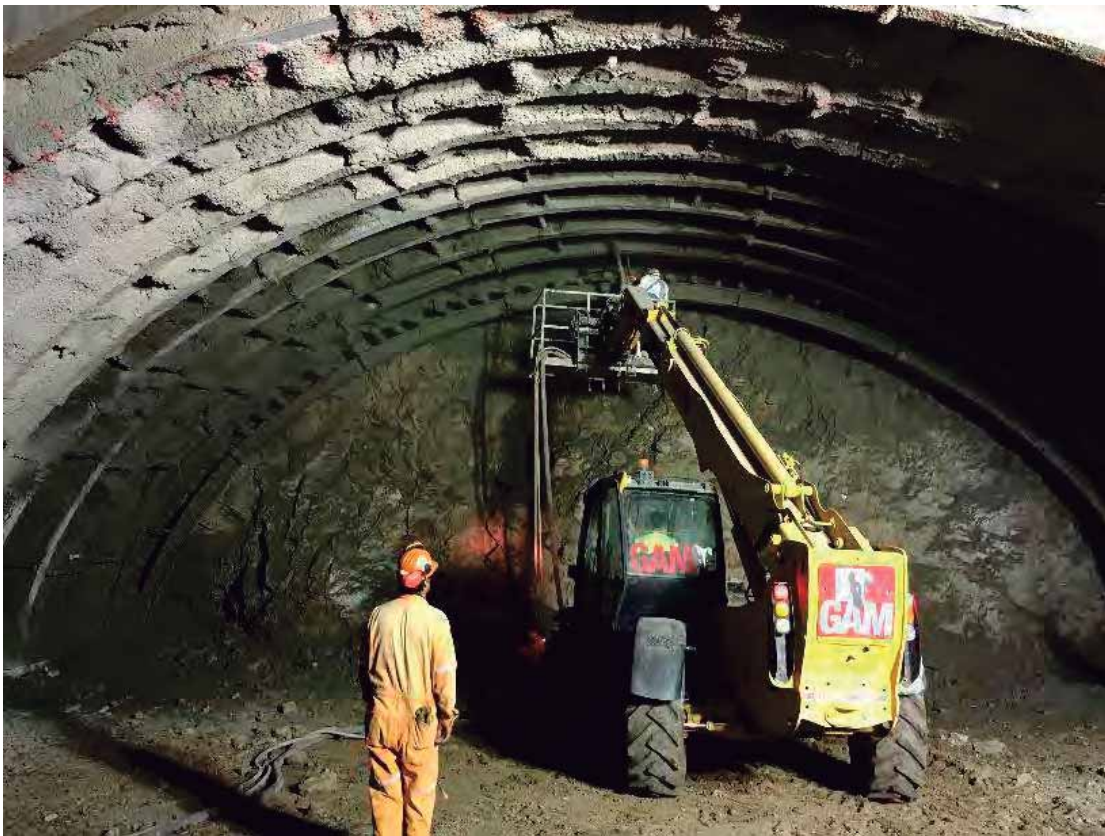
Fig. 45. Concreto lanzado en marcos metálicos. Fuente: foto tomada por autor. 19 de julio de 2016.
