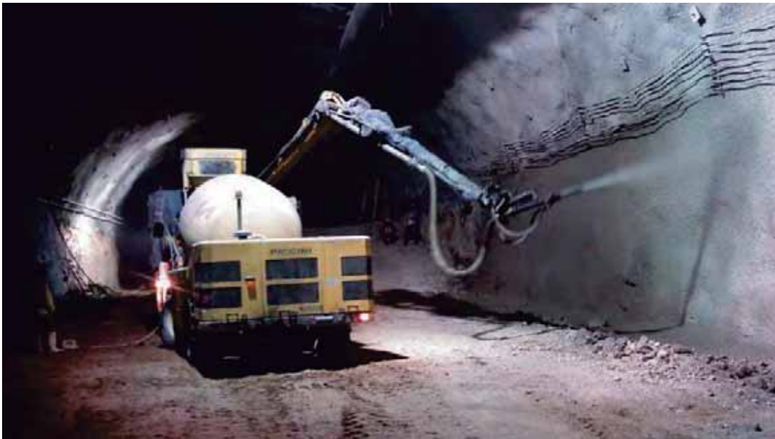
Fig. 65. Concreto lanzado. Fuente: foto tomada por autor. 09 de abril de 2017.
