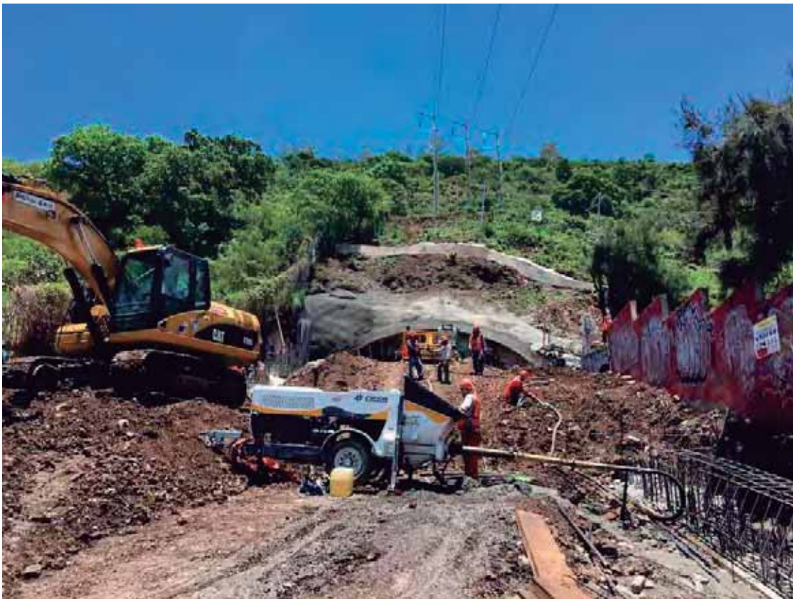
Fig. 11. Trabajos de lanzamiento de concreto con bomba estacionaria. Fuente: foto tomada por autor. 16 de junio del 2016.
