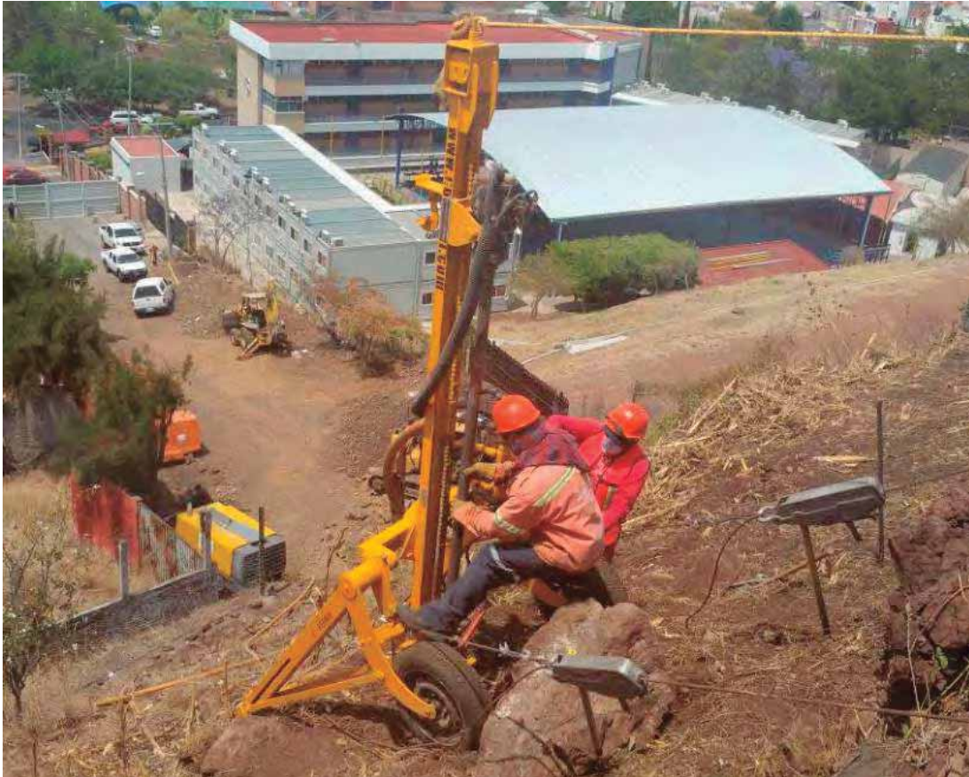
Fig. 90. Perforación para instalación de barrera dinámica. Fuente: foto tomada por autor. 05 de abril de 2016.
