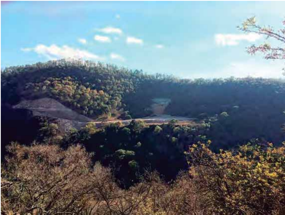
Fig. 05. Terreno natural en área de túnel. Fuente: foto tomada por autor. 26 de enero del 2016.
