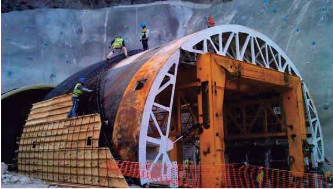
Fig. 59. Armado de acero y cimbra en túnel. Fuente: foto tomada por autor. 08 de abril de 2017.
