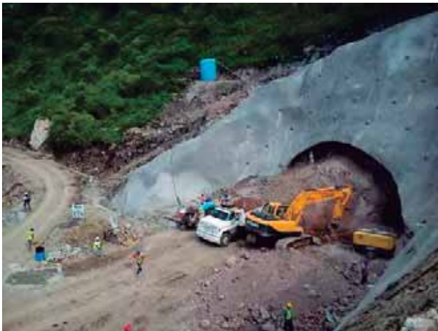
Fig. 68. Excavación túnel. Fuente: foto tomada por autor.
