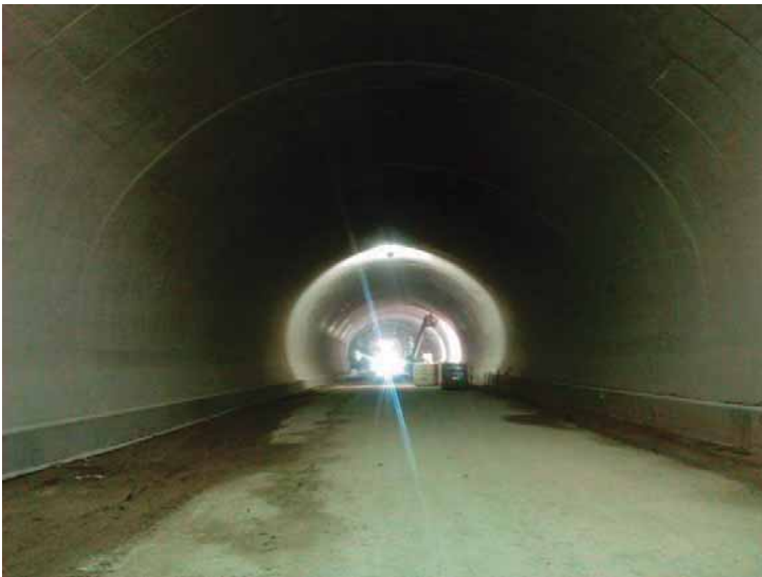
Fig. 75. Terminación de concreto en bóveda, muro y zapata en túnel. Fuente: foto tomada por autor. 10 de junio de 2017.
