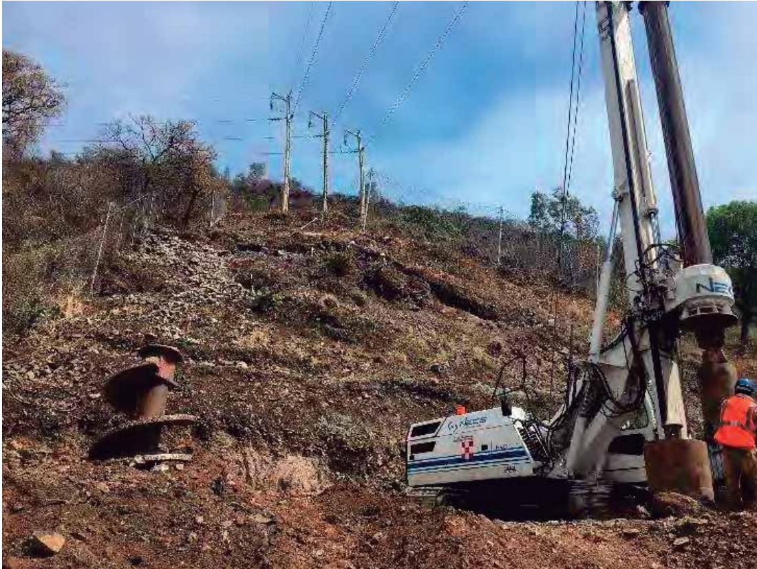
Fig. 22. Perforación de terreno natural a base de maquinaria, vista noroeste. Fuente: foto tomada por autor.
