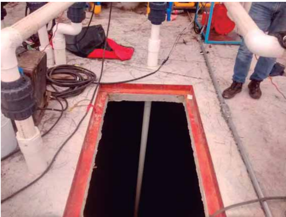
Fig. 87. Colocación de instalaciones en cuarto de máquinas. Fuente: foto tomada por autor. 07 de septiembre de 2017.
