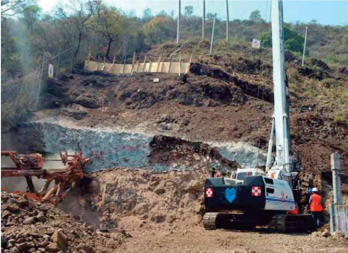
Fig. 33. Trabajos en enfilaje y pilotes. Fuente: foto tomada por autor. 23 de mayo de 2016.
