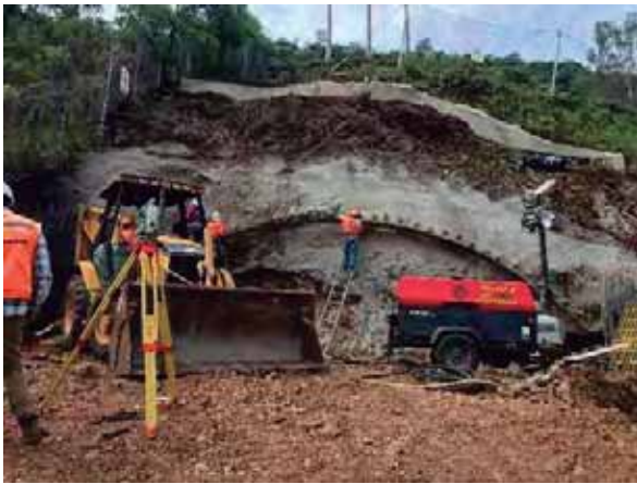
Fig. 29. Terminación de micropilotes. Fuente: foto tomada por autor. 10 de junio del 2016.
