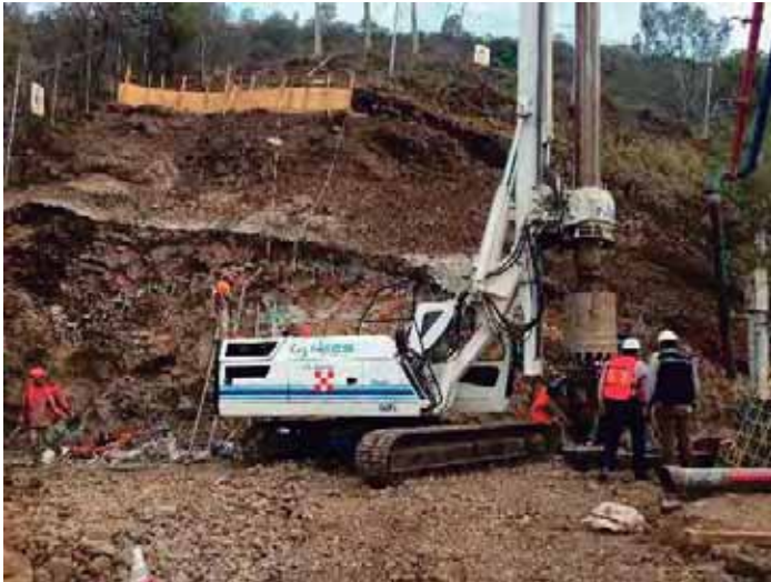
Fig. 18. Perforación de micropilotes. Fuente: foto tomada por autor. 25 de mayo del 2016.
