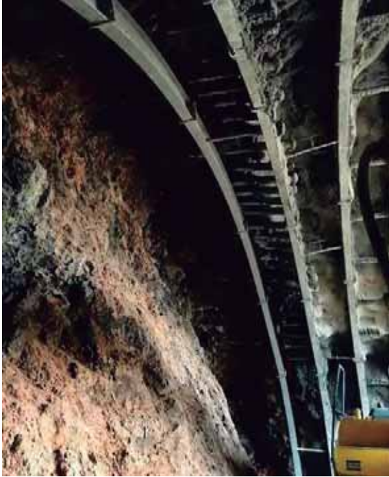
Fig. 50. Colocación de perfiles metálicos. Fuente: foto tomada por autor. 19 de julio de 2016.
