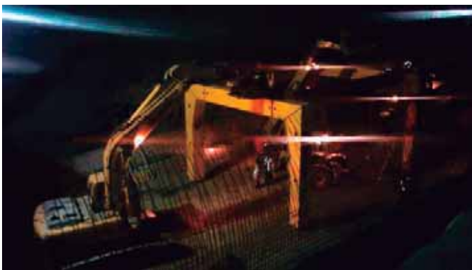
Fig. 64. Carro para armado de acero. Fuente: foto tomada por autor.
