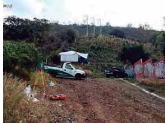
Fig. 04. Ramal Camelinas, vista noroeste. Fuente: foto tomada por autor.
