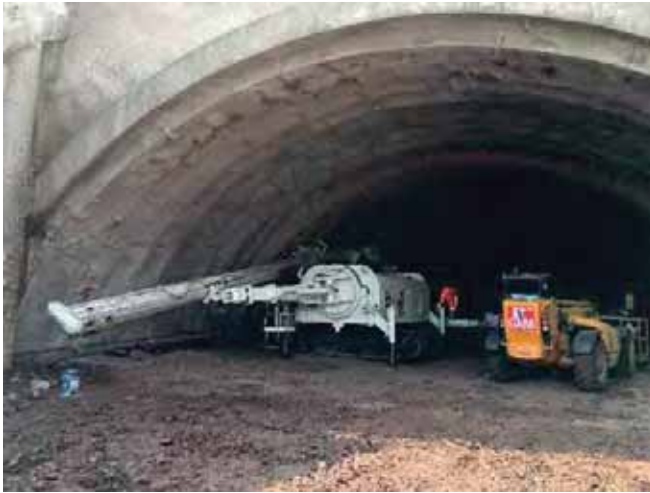
Fig. 52. Excavación de túnel. Fuente: foto tomada por autor. 01 de agosto de 2016.
