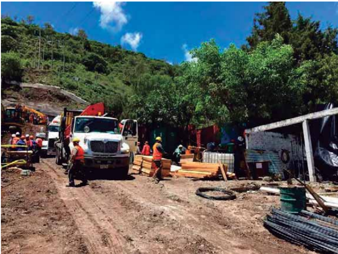
Fig. 12. Almacenaje de acero, cimbra y concreto. Fuente: foto tomada por autor. 16 de junio del 2016.
