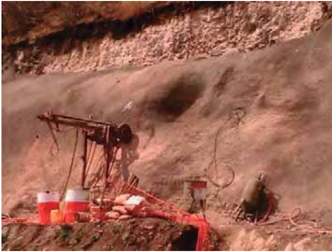
Fig. 72. Concreto lanzado en muro. Fuente: foto tomada por autor.
