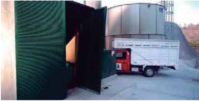
Fig. 85. Cuarto de máquinas. Fuente: foto tomada por autor. 10 de enero de 2019.
