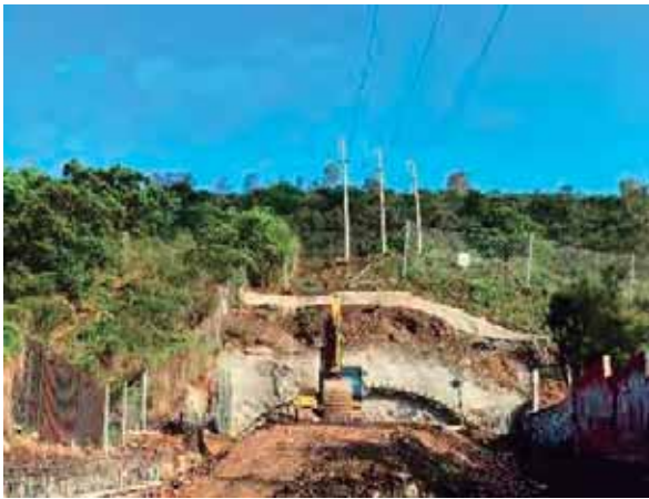
Fig. 28. Terminación de micropilotes y concreto lanzado. Fuente: foto tomada por autor. 03 de junio del 2016.
