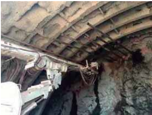
Fig. 39. Excavación de túnel. Fuente: foto tomada por autor. 12 de julio de 2016.
