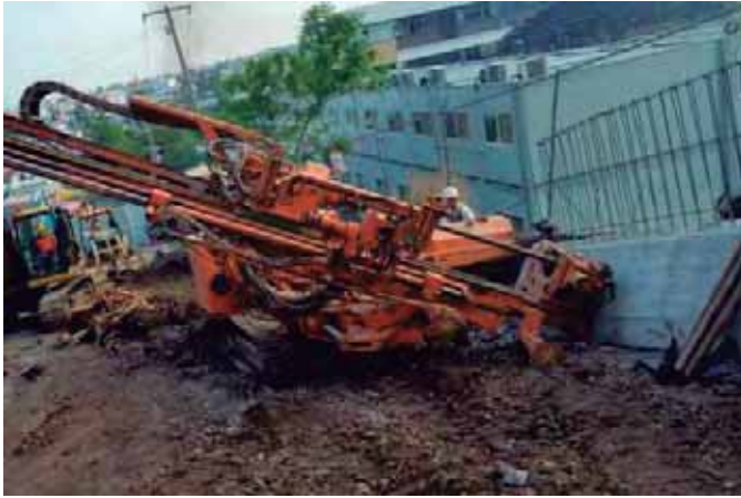
Fig. 36. Anclaje activo. Fuente: foto tomada por autor. 21 de junio de 2016.
