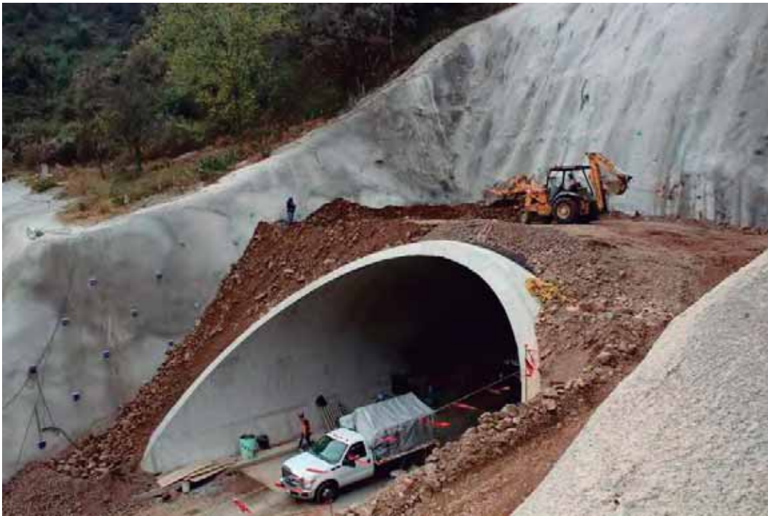
Fig. 82. Distribución de tierra del túnel superior. Fuente: foto tomada por autor. 27 de octubre de 2018.
