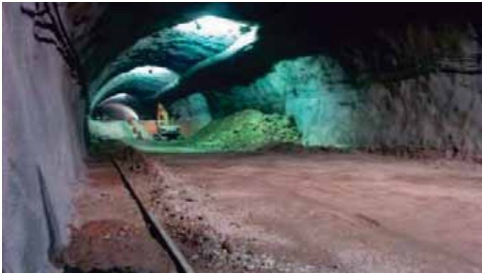
Fig. 70. Retiro de tierra producto de excavación. Fuente: foto tomada por autor.
