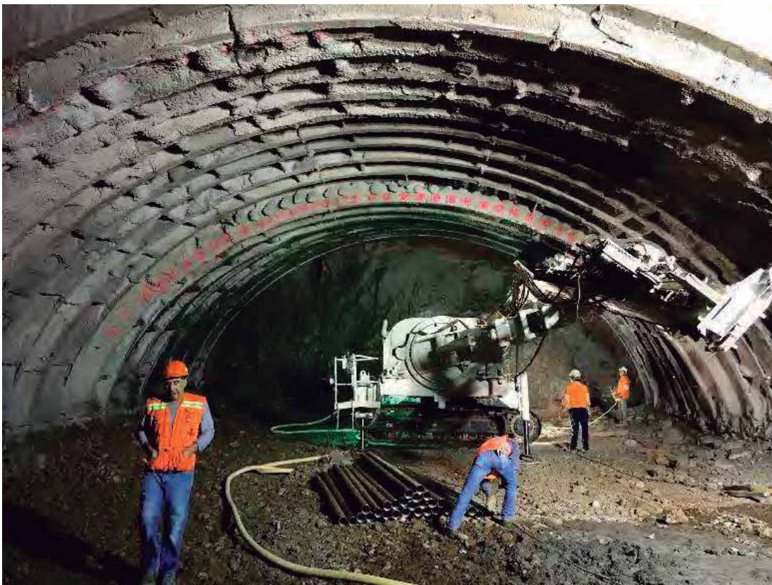
Fig. 47. Excavación de túnel. Fuente: foto tomada por autor. 25 de julio de 2016.
