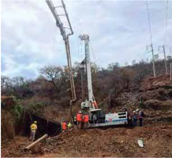
Fig. 16. Excavación del terreno natural. Fuente: foto tomada por autor.
