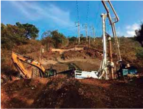
Fig. 24. Concreto lanzado. Fuente: foto tomada por autor. 01 de junio del 2016.
