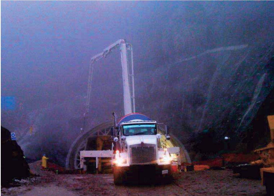
Fig. 66. Concreto lanzado en túnel. Fuente: foto tomada por autor.
