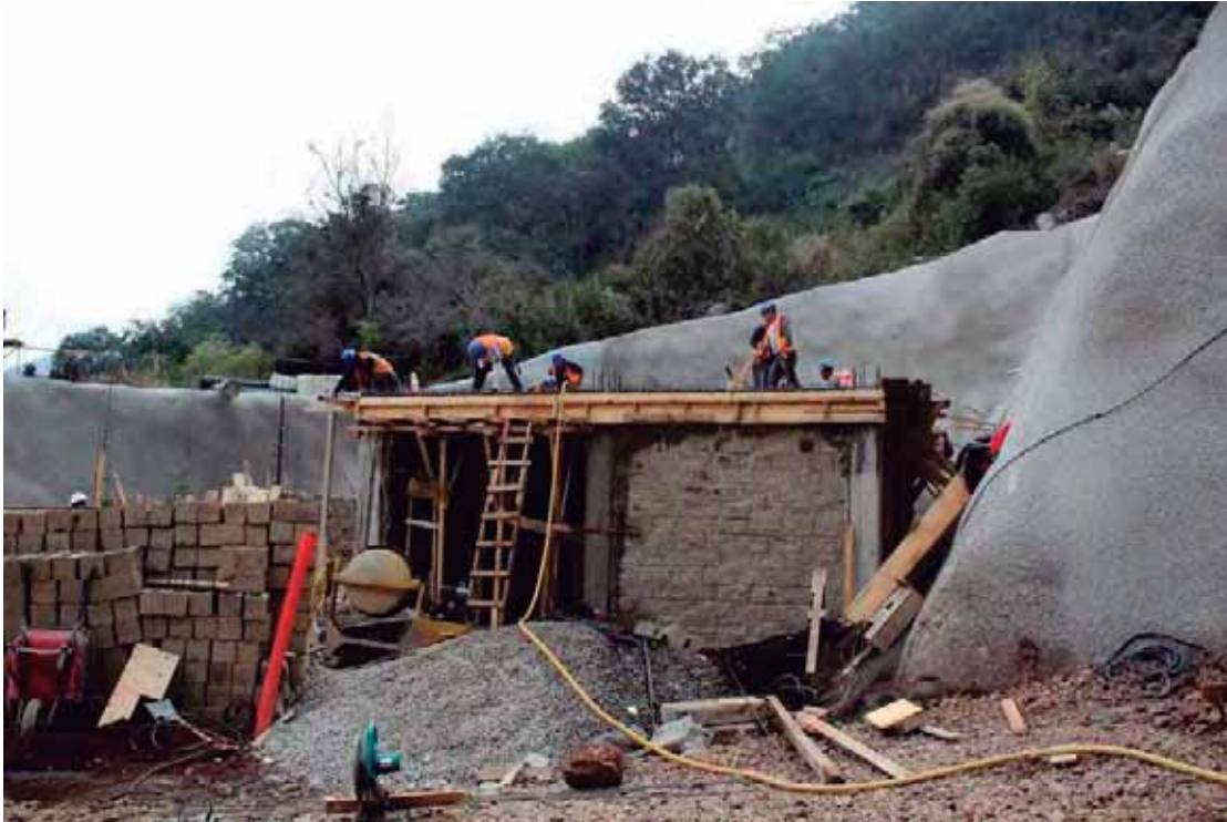
Fig. 78. Construcción de cuarto de máquinas. Fuente: foto tomada por autor. 27 de octubre de 2018.
