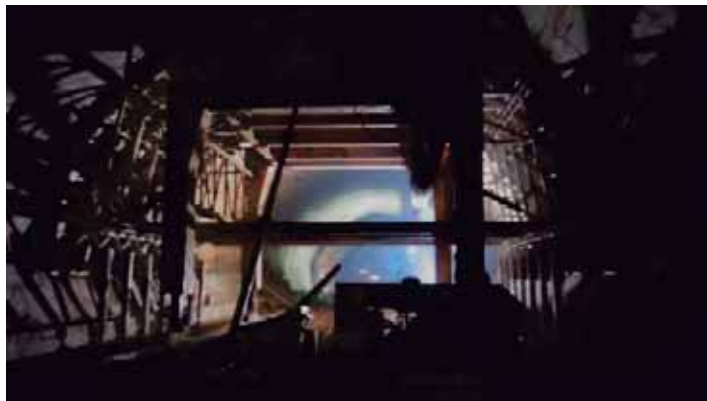
Fig. 77. Terminación de bóveda en túnel. Fuente: foto tomada por autor.
