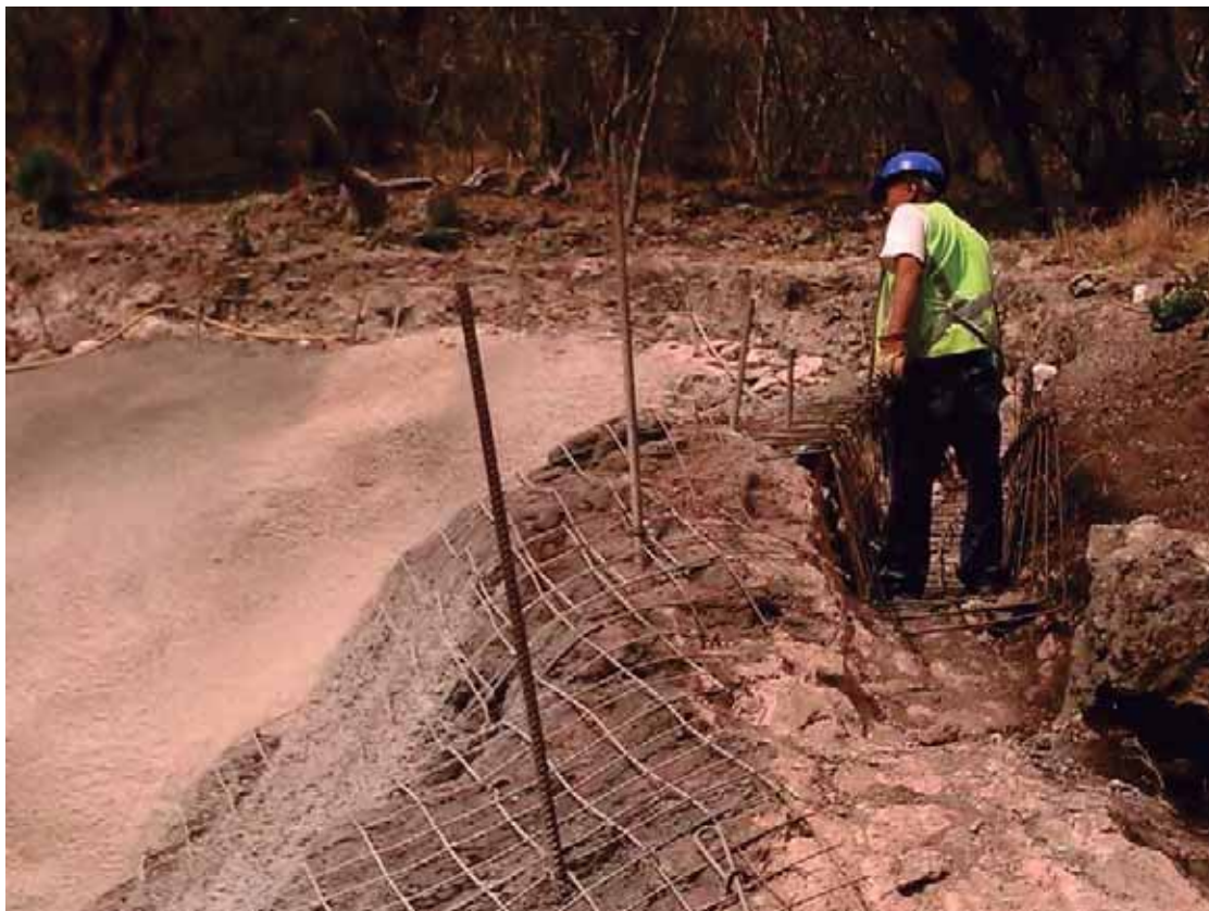
Fig. 71. Malla electrosoldada en muro. Fuente: foto tomada por autor.
