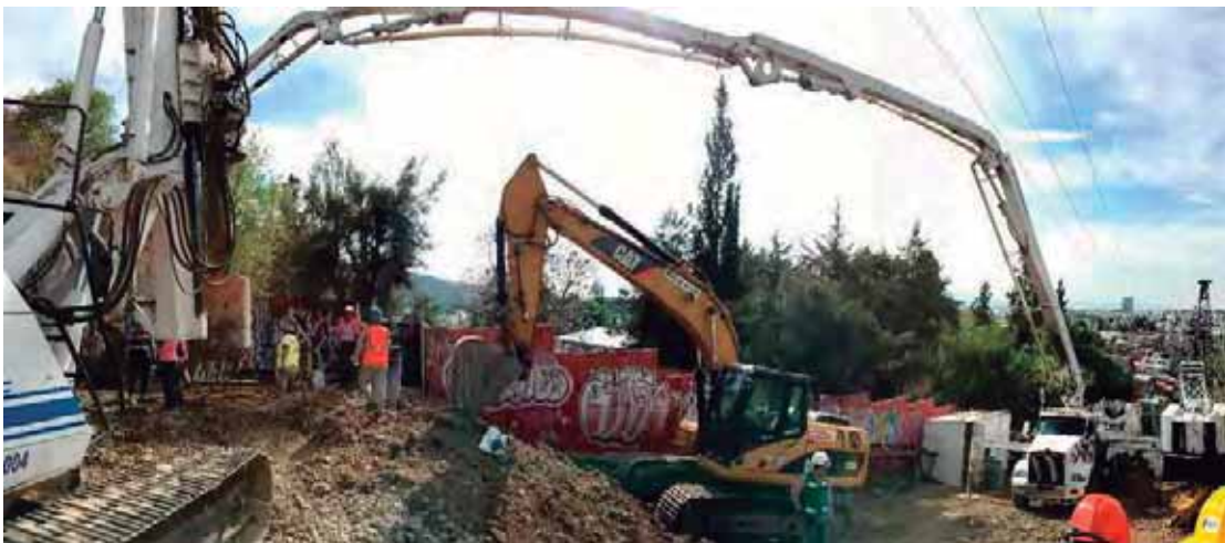
Fig. 25. Perforación de terreno natural a base de maquinaria. Fuente: foto tomada por autor.
