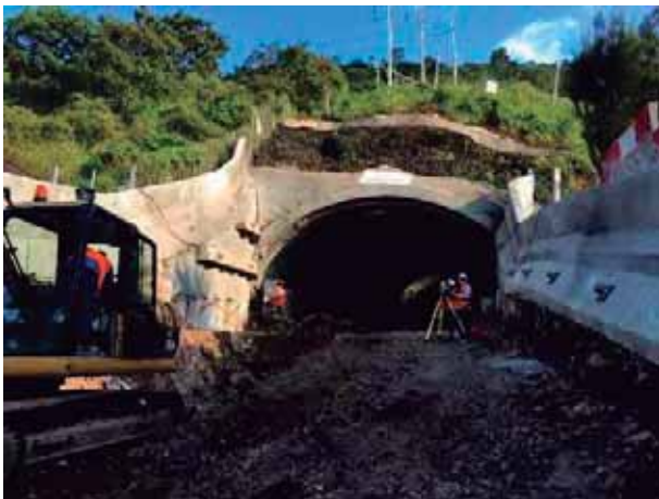
Fig. 56. Excavación y lanzamiento de concreto. Fuente: foto tomada por autor. 31 de agosto de 2016.
