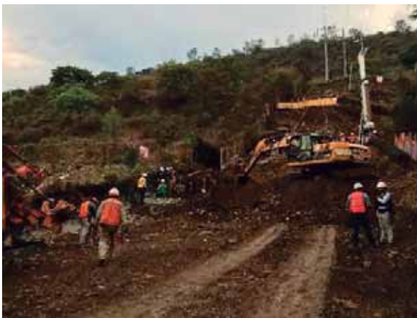
Fig. 21. Excavación de terreno natural. Fuente: foto tomada por autor. 27 de mayo del 2016.
