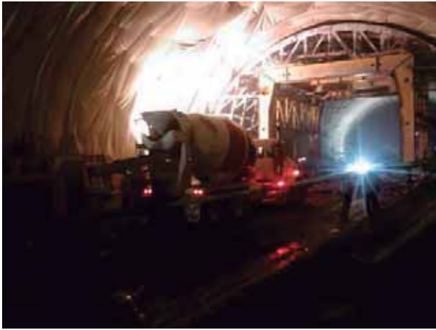
Fig. 76. Concreto en túnel. Fuente: foto tomada por autor.
