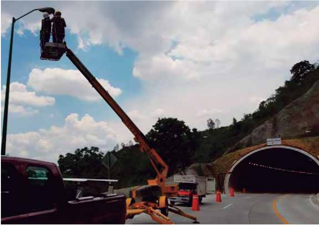
Fig. 93. Instalación de luminaria y señalamientos en túnel. Fuente: foto tomada por autor. 23 de abril de 2019.
