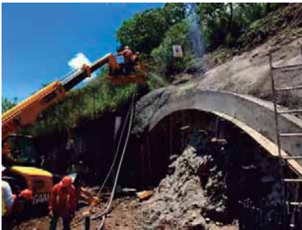
Fig. 31. Arco para excavación del túnel. Fuente: foto tomada por autor. 16 de junio del 2016.
