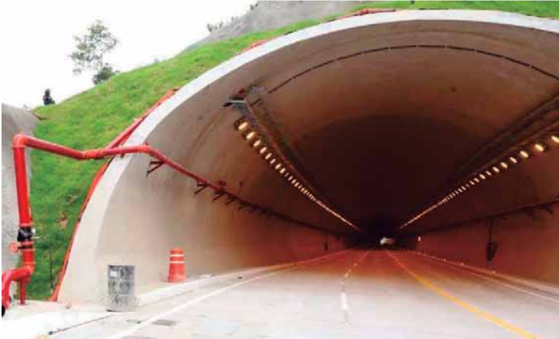
Fig. 94. Instalación de luminaria y señalamientos en túnel. Fuente: Quadrafin Michoacán. 16 de abril de 2019.
