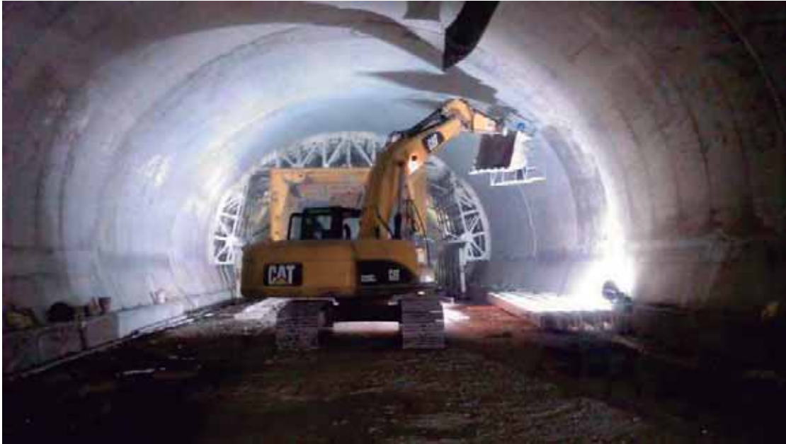
Fig. 69. Armado de acero. Fuente: foto tomada por autor.
