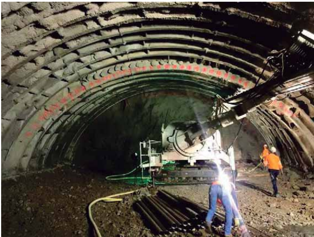
Fig. 51. Colocación de perfiles metálicos. Fuente: foto tomada por autor. 19 de julio de 2016.
