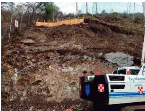
Fig. 23. Enfilaje de micropilotes y tapial de protección. Fuente: foto tomada por autor. 30 de mayo del 2016.
