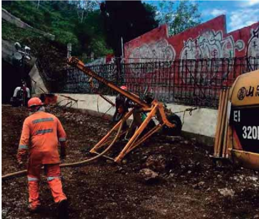
Fig. 42. Anclaje activo a 15 m y excavación de túnel. Fuente: foto tomada por autor. 14 de julio de 2016.
