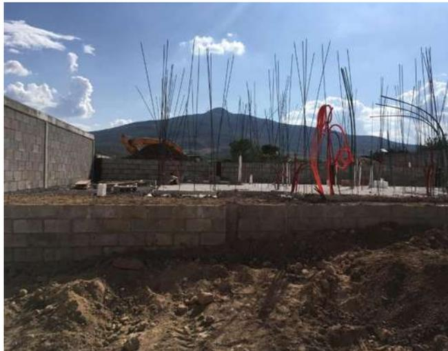
*Fotografía No. 2.17. Losa de cimentación terminada y lista para la construcción de un edificio departamental.*
