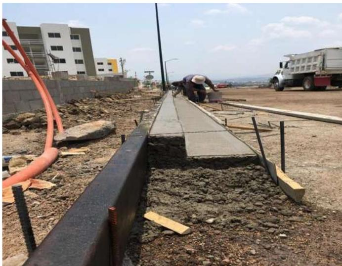
*Fotografía No. 2.11. Fotografía de construcción de guarniciones.*
