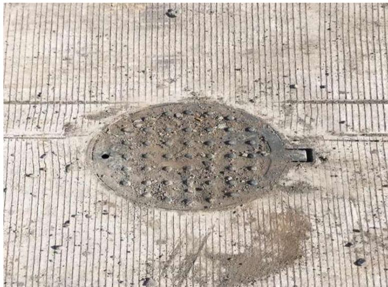
*Fotografía No. 2.6. Fotografía de pozo de visita terminado (tapadera para pozo de visita).*
