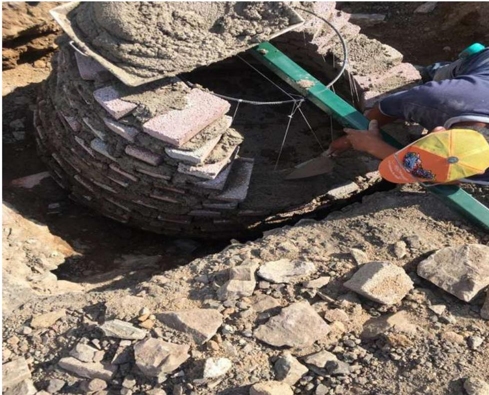
*Fotografía No. 2.5. Fotografía de construcción de pozo de visita.*
