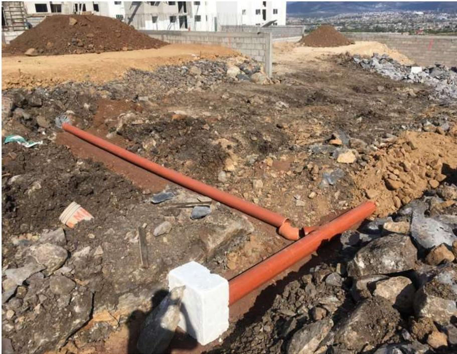
*Fotografía No. 2.4. Fotografía de tuberías de abastecimiento de agua potable colocadas en terreno natural.*
