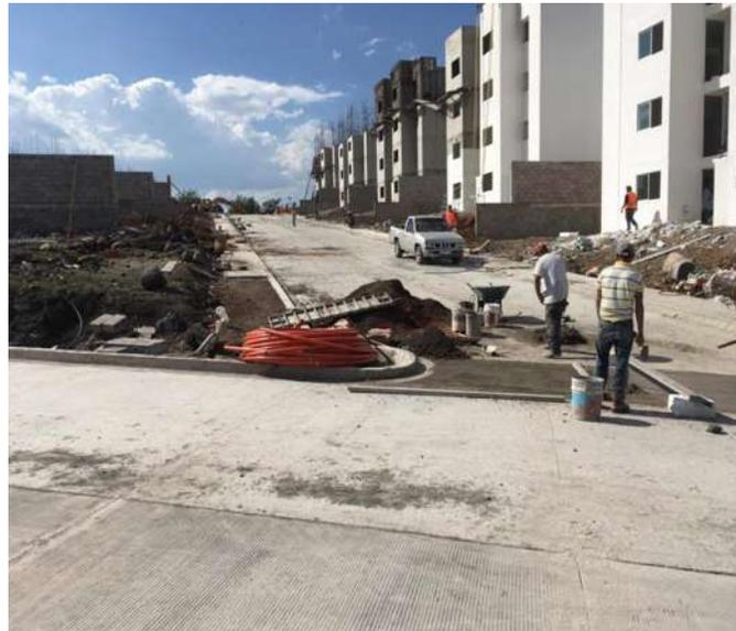
*Fotografía No. 2.13. Fotografía de vialidades con concreto hidráulico.*
