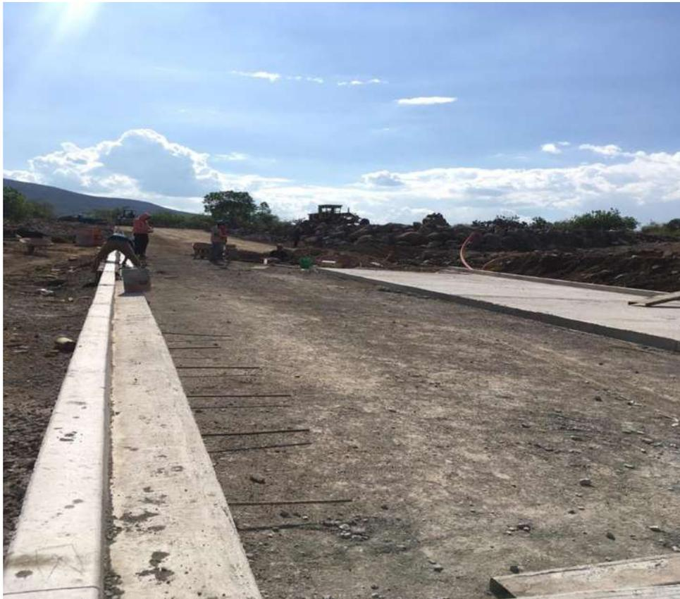
*Fotografía No. 2.12. Fotografía de construcción de vialidades con concreto hidráulico.*
