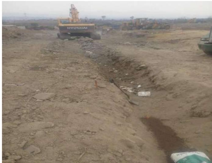
*Fotografía No. 2.3. Fotografía de la excavación en terreno natural para tuberías.*
