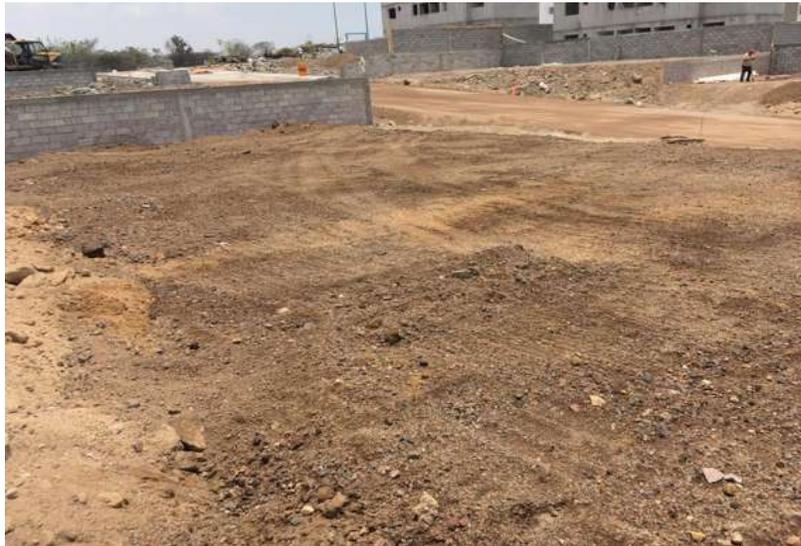
*Fotografía No. 2.15. Sub rasante de losas de cimentación para edificación.*
