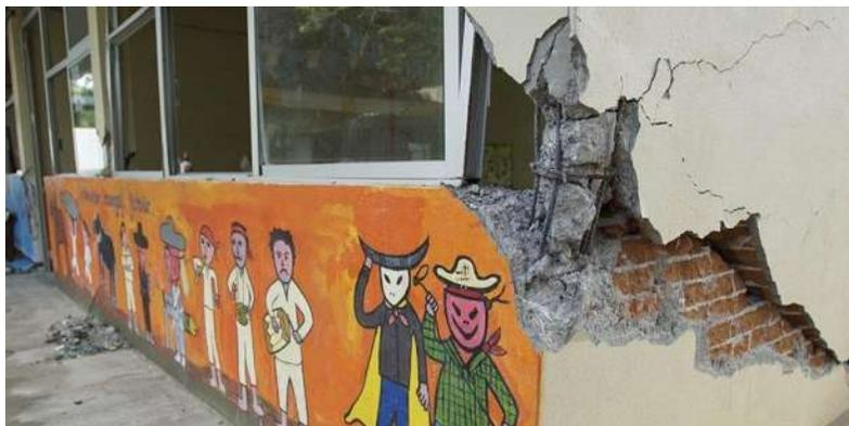
Figura 1.5 Escuela con daño estructural debido a columna “corta” a consecuencia del sismo del 23 de junio de 2020 en Oaxaca (La Verdad, 2020)
