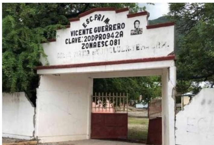
Figura 1.6 Daño en los muros perimetrales de la escuela primaria "Vicente Guerrero" a consecuencia del sismo del 23 de junio de 2020 en Oaxaca (Salinas, 2020)
